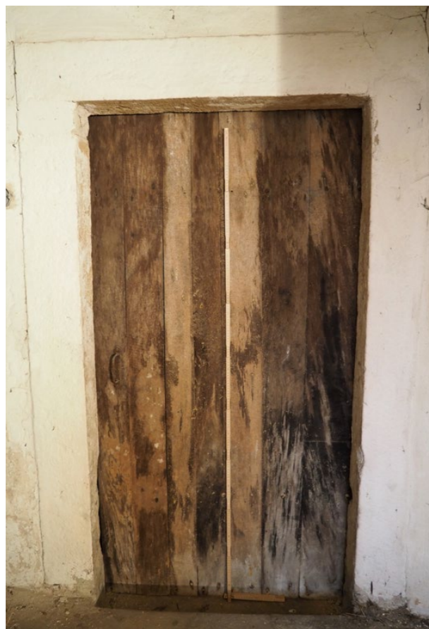
líc dveřního křídla chodba 1.2
