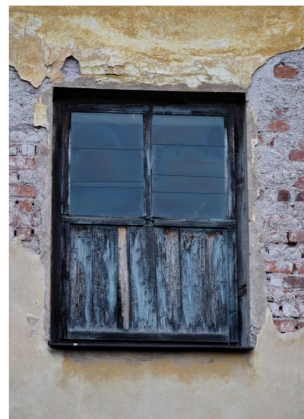
vnější strana, východní fasáda
