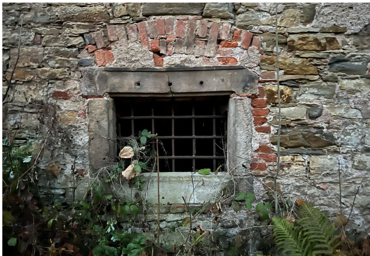
kusy kamenného ostění se zamřížovaným otvorem východní fasáda
