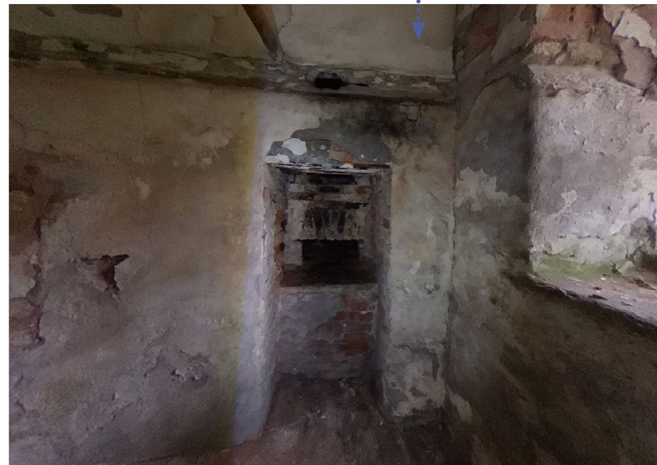
kuchyň: pohled na tlamu pece, nad pecí dřevěný trámový překlad
