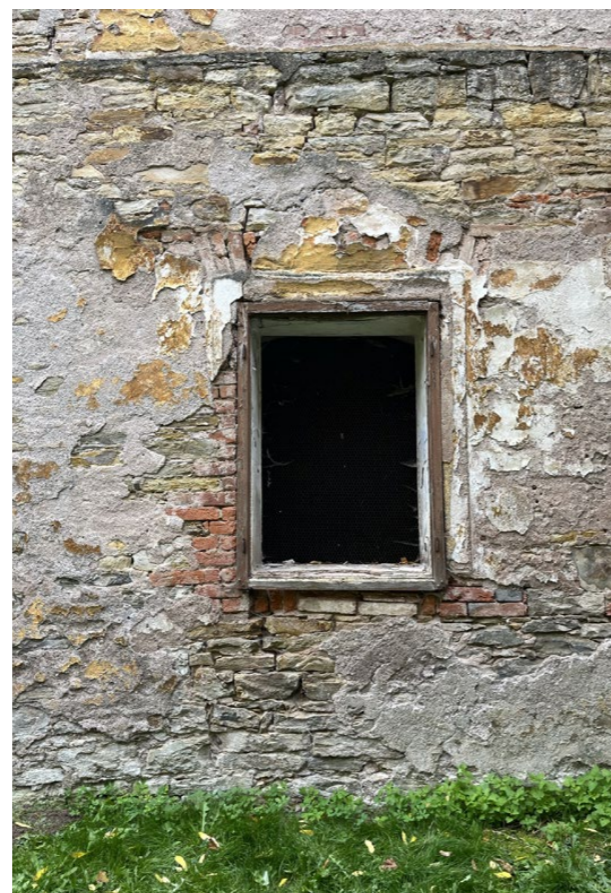
vnější rovina severní fasáda
