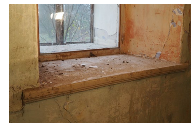
dřevěná deska parapetu vnitřní rovina
