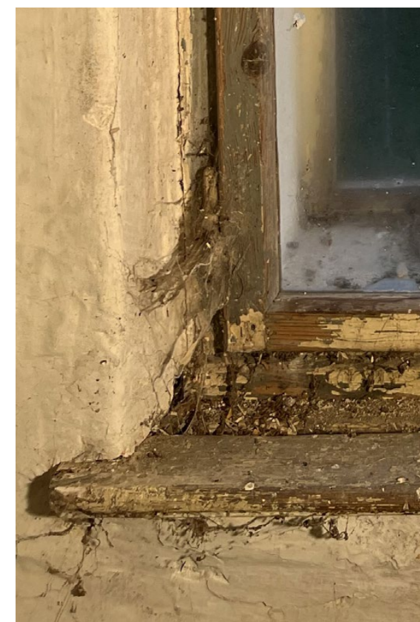
dřevěné parapetní prkno vnitřní rovina
