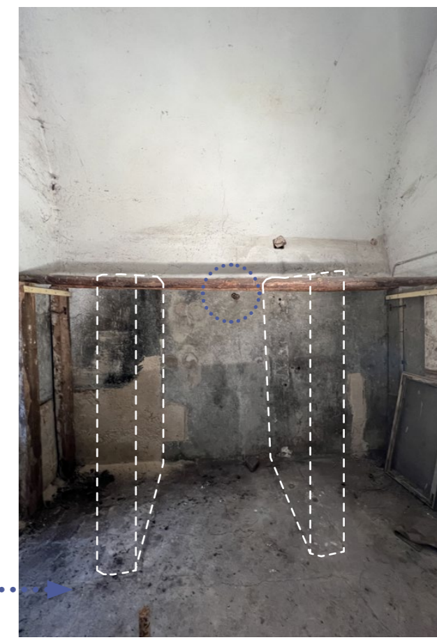
pohled na severní stěnu, otisky po příčkách, kovový kohoutek, otvory ve zdi
