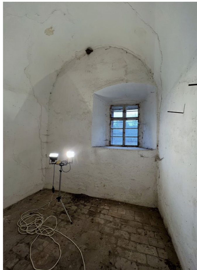
kuchyň 1.5: pohled východní na okno O.08
