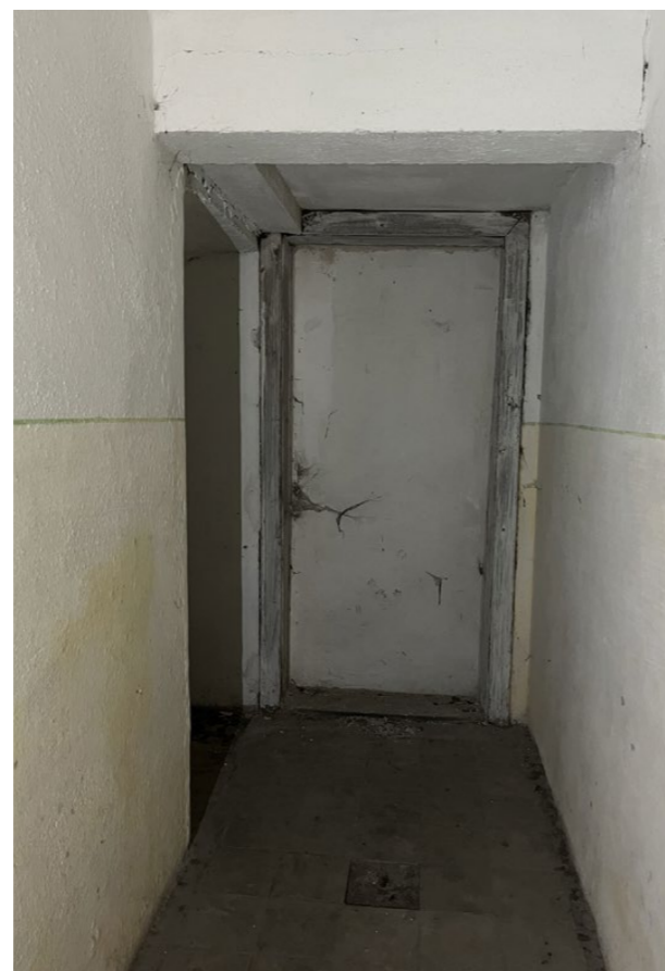
chodba s výmálbou
