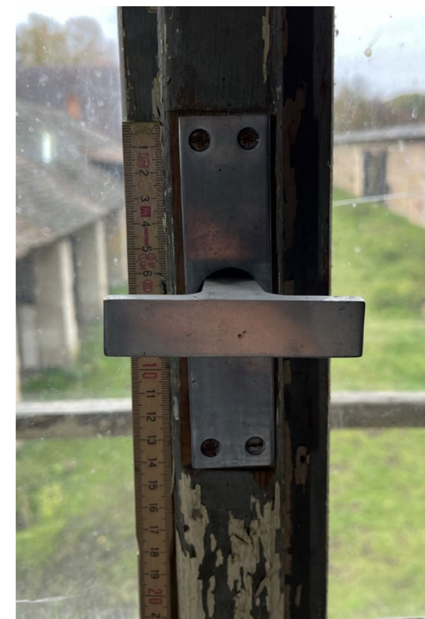
detail hliníkové rozvory vnitřní rovina
