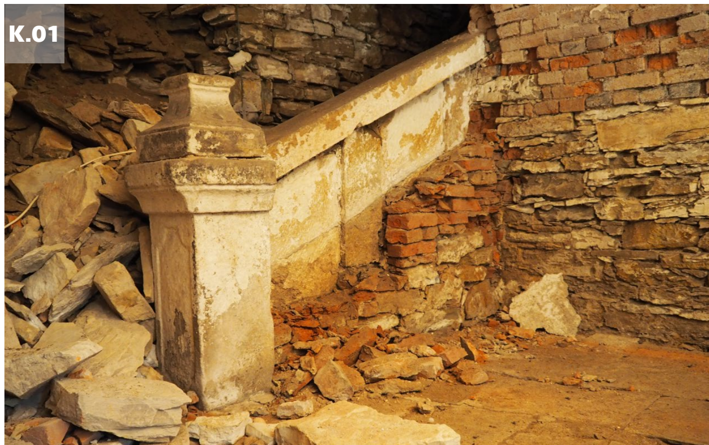
mléčný sklep: K.01 kamenný sloupek zábradlí viz. zaměření prvku K.01 barokní sloupek
