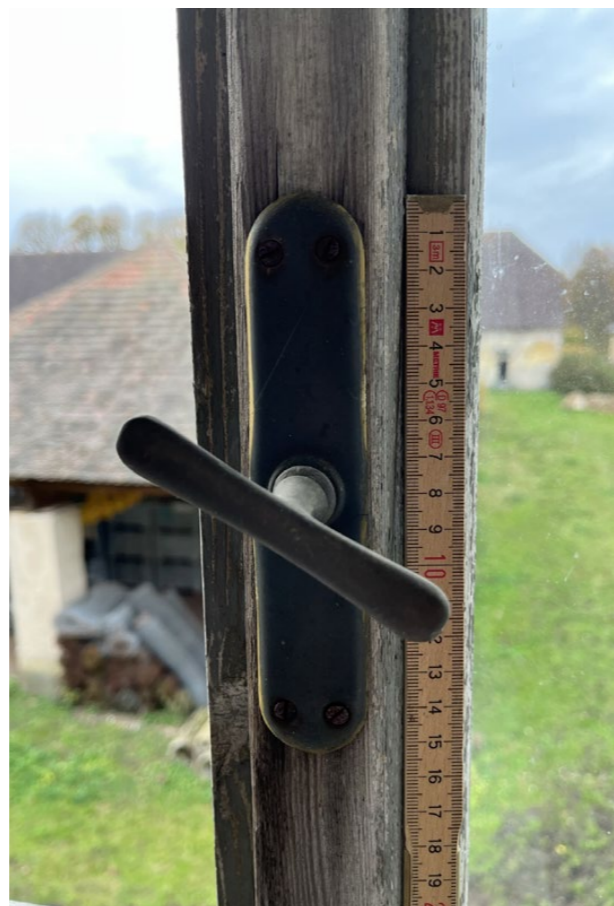
hranatá hliníková rozvora vnější rovina, pohled z interiéru
