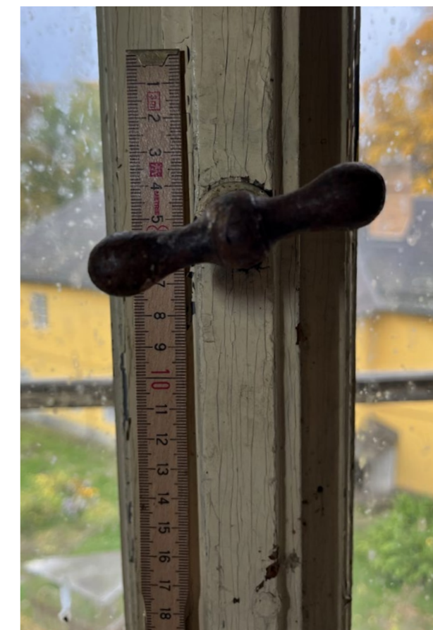
detail hliníkové rozvory vnitřní rovina
