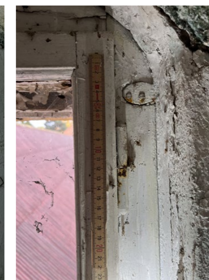
detail závěsu a osazení rámu vnitřní rovina
