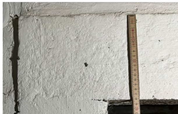
detail nadpraží kamenného ostění lícová strana z chodby 1.2
