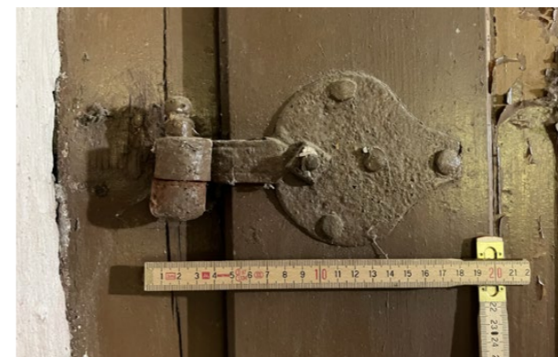
detail trnu a horní lopatkový závěs rubová strana dveřního křídla
