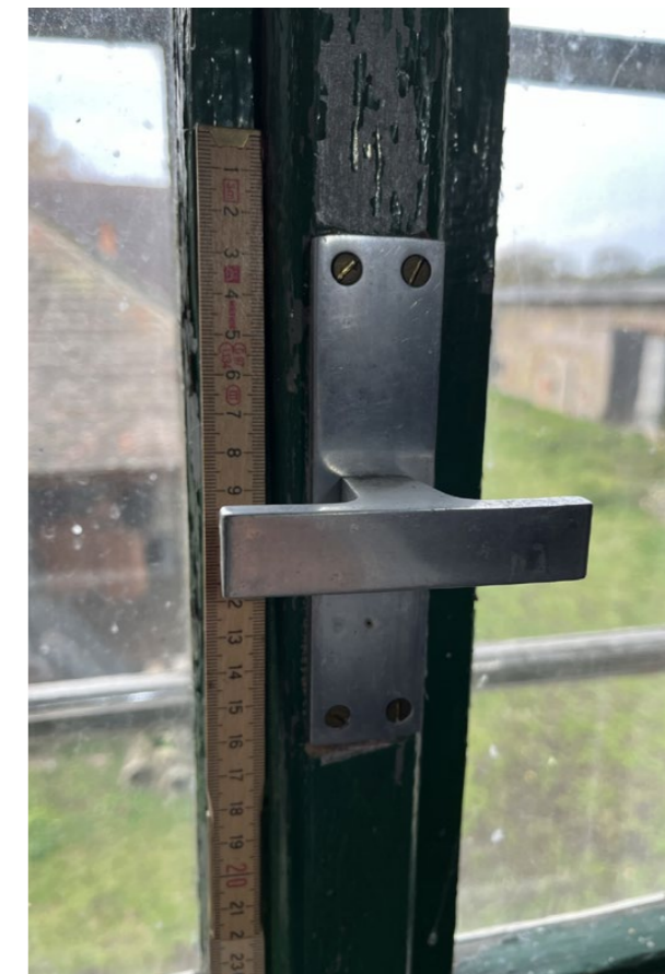
detail hliníkové rozvory vnitřní rovina
