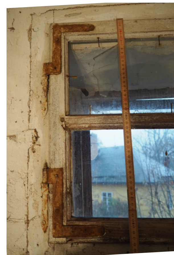
detail rohovníkových závěsů nadsvětlík, vnitřní rovina
