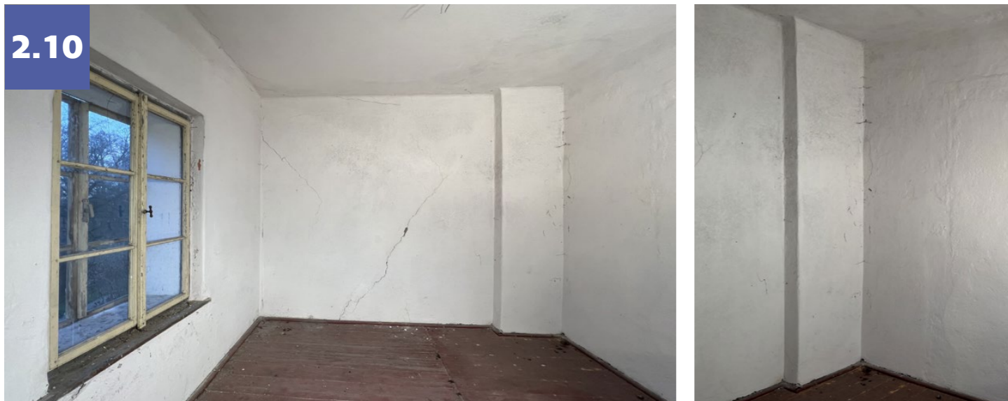
místnost 2.10: pohled jižná, komínové těleso, okno O.16, záběr na komínové těleso bez známky osazení kouřového tahu, změna v podlaze pravděpodobně jako příprava
