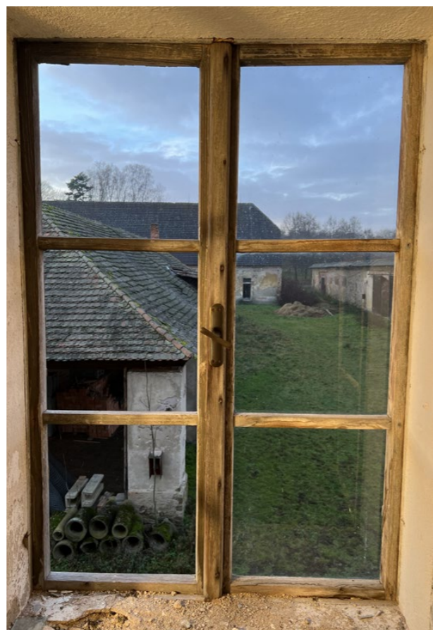
vnější rovina pohled z interiéru
