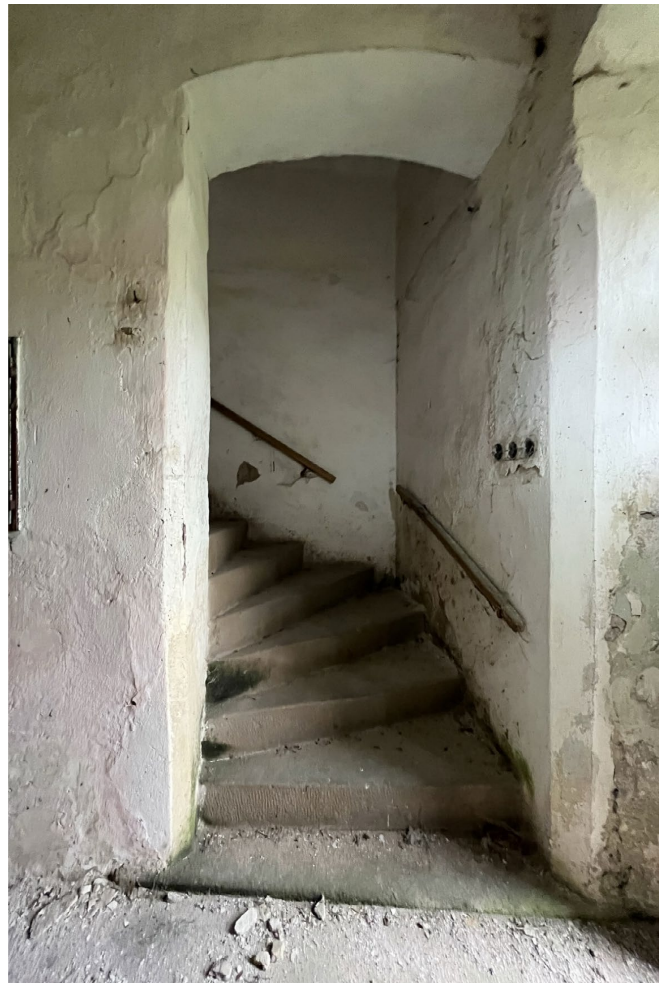
síň 1.4 pohled jižní, vstup na schodiště hned při hlavním vstupu do objektu upravovaný nástup schodiště
