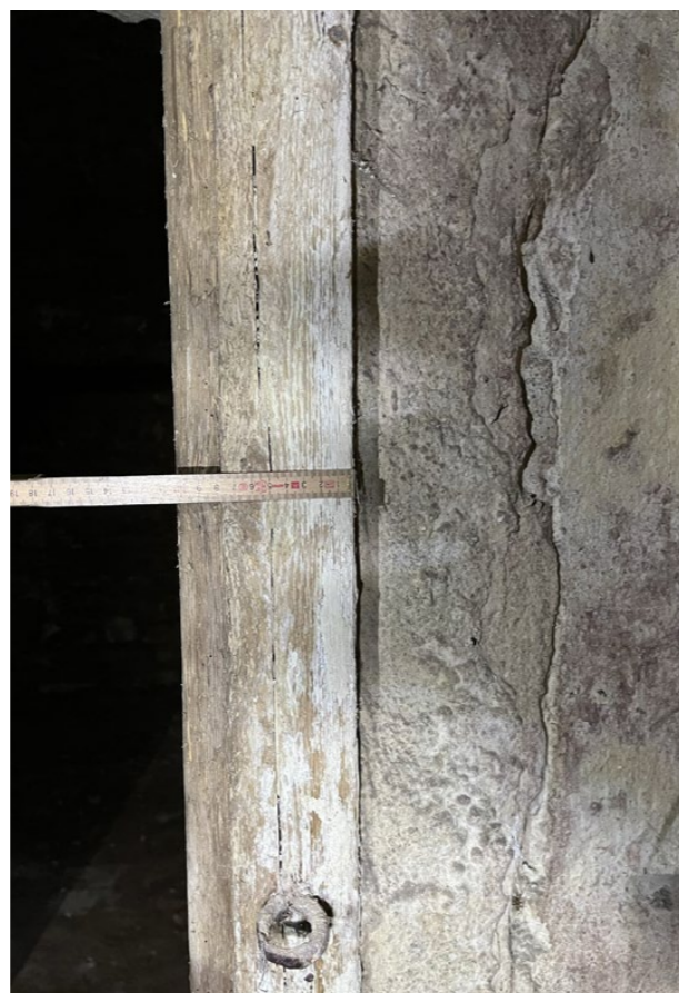
detail severní stojky a omítkové opravy pohled z kuchyně 0.2
