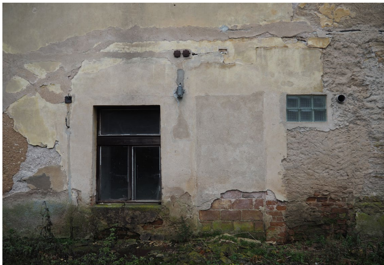
situace na fasádě kolem okna O.14 západní fasáda
