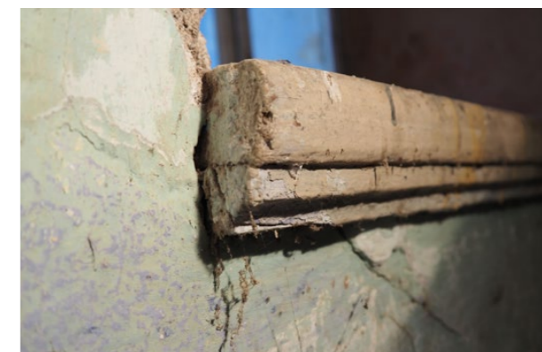
dřevěná deska vnitřní parapet
