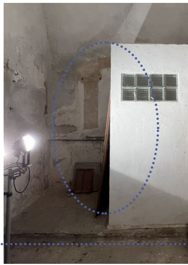
zazdívka po původním otvoru propojující komoru na žrádlo a kravín
