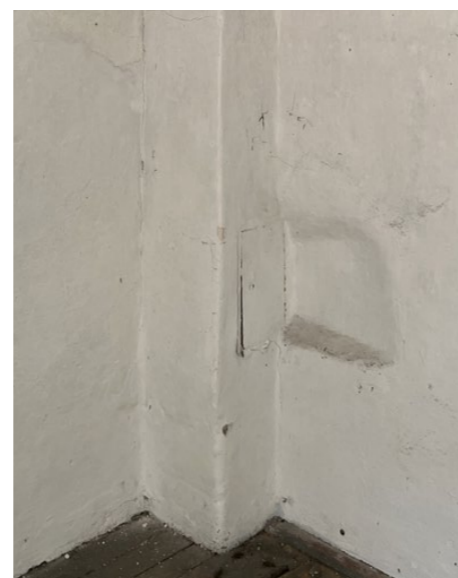
místnost 2.8: pohled východní, vstupní dveře D.25 komínové těleso s vymetacími dvířky a obroušenou zdí po osazení sporáku
