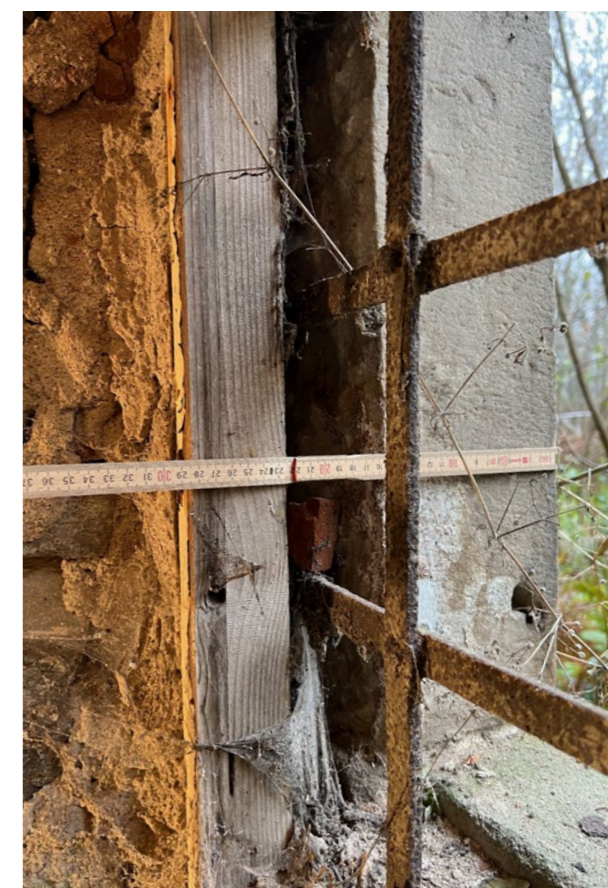
dřevěný rám, mříž, kamenné ostění detail severního ostění
