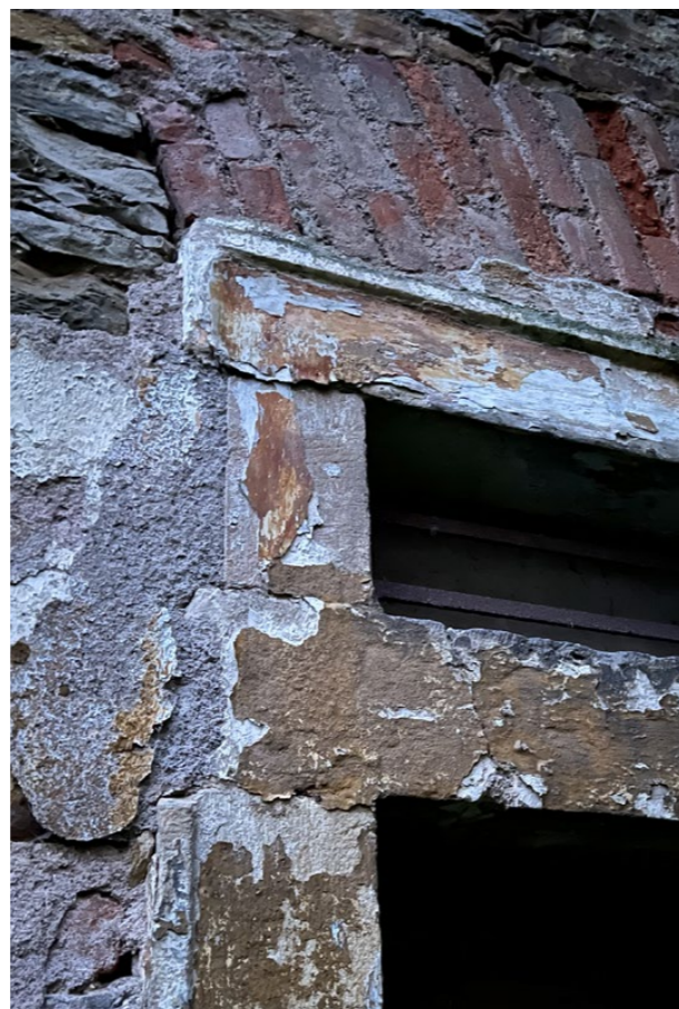
detail kamenného ostění v nadpraží
