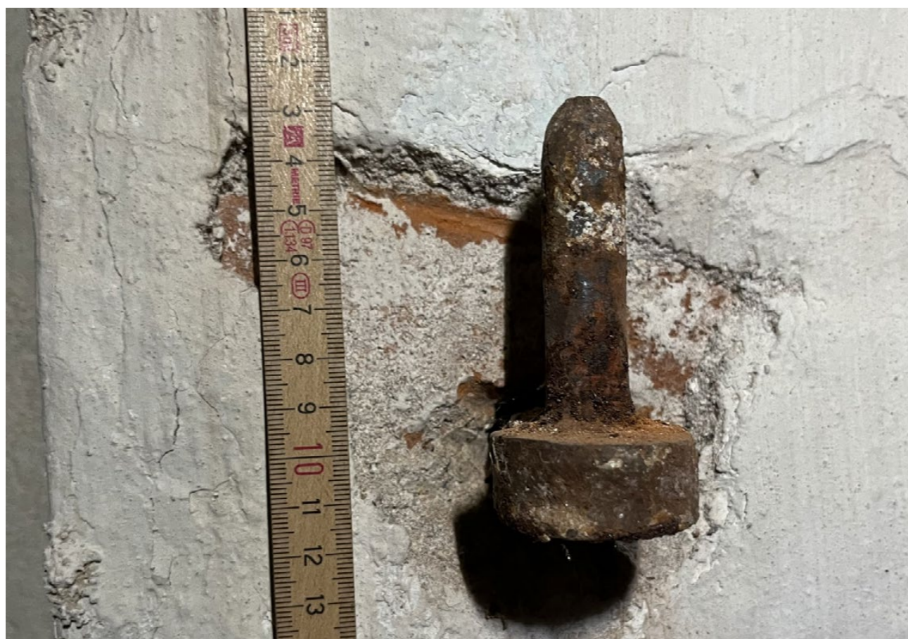
detail horního trnu chodba 1.2 severní ostění
