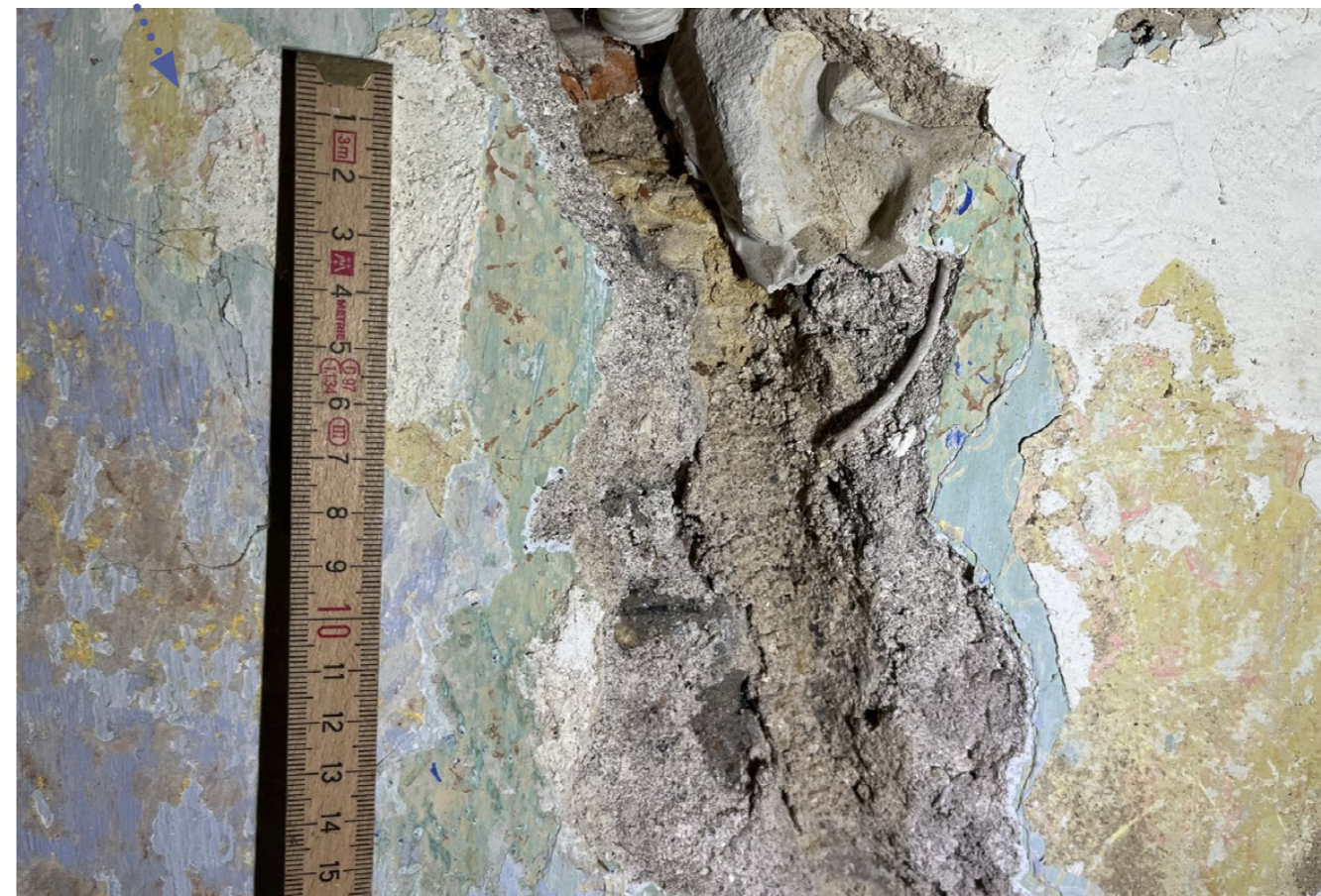
místnost 1.9: omítková a nátěrová situace sondy elektroinstalace na západní fasádě
