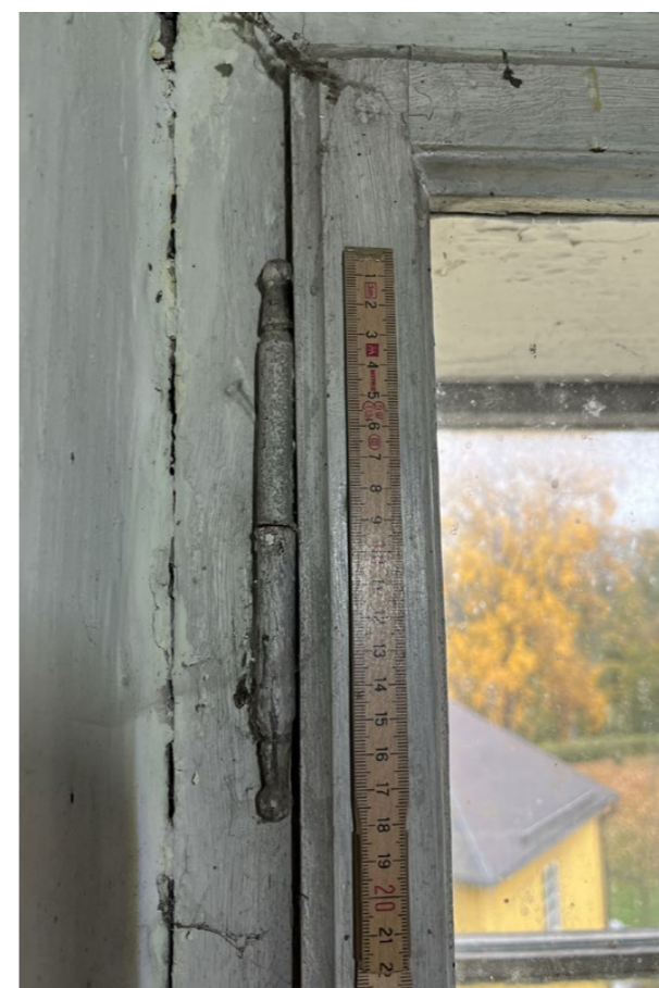
detail závěsů - pastrany vnitřní rovina
