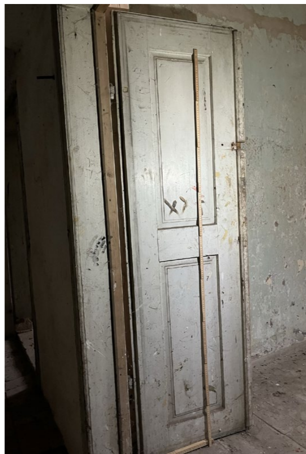
severní pravé křídlo, líc pohled z chodby 1.2
