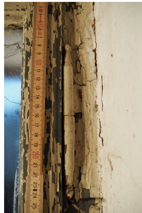
detail závěsů - pastrany vnitřní rovina
