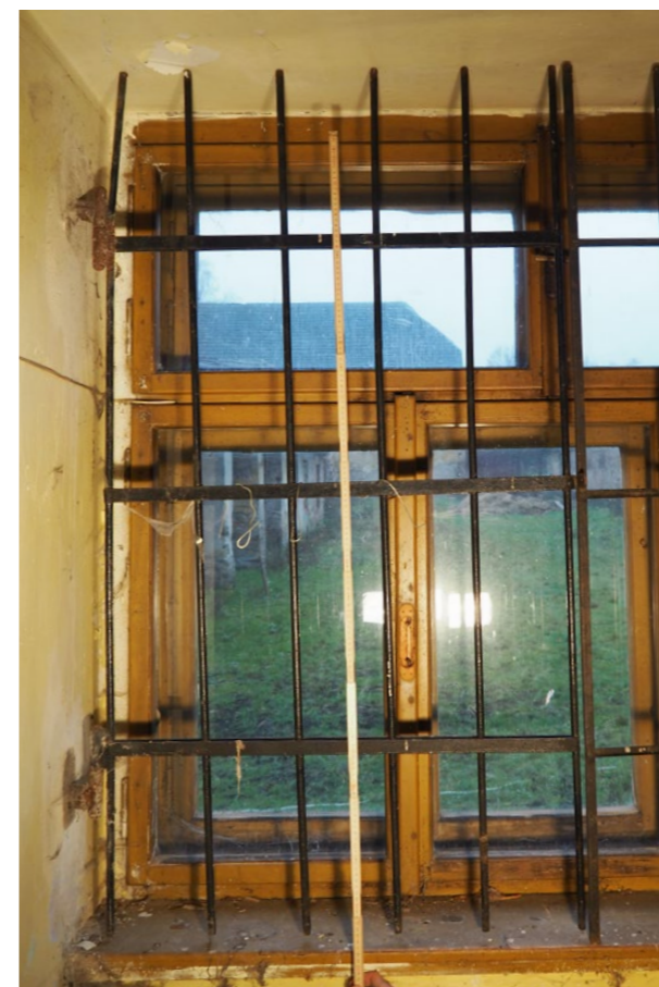
jižní křídlo mříže vnitřní rovina
