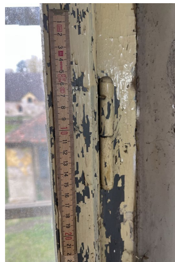
detail závěsů vnitřní rovina
