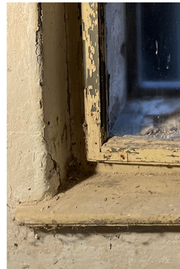
dřevěné parapetní prkno vnitřní rovina
