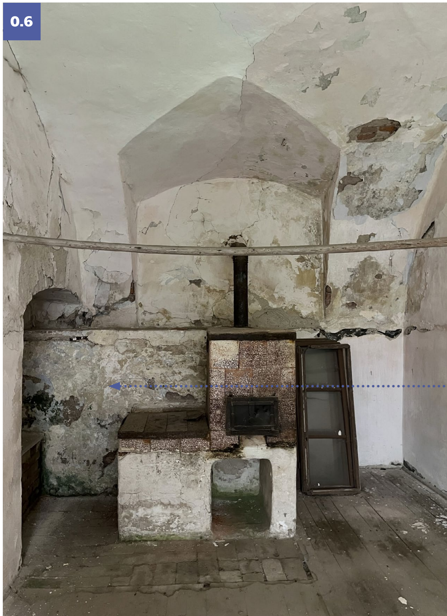
světnice 0.6: pohled jižní na část místnosti, kde se vždy nacházelo topeniště
