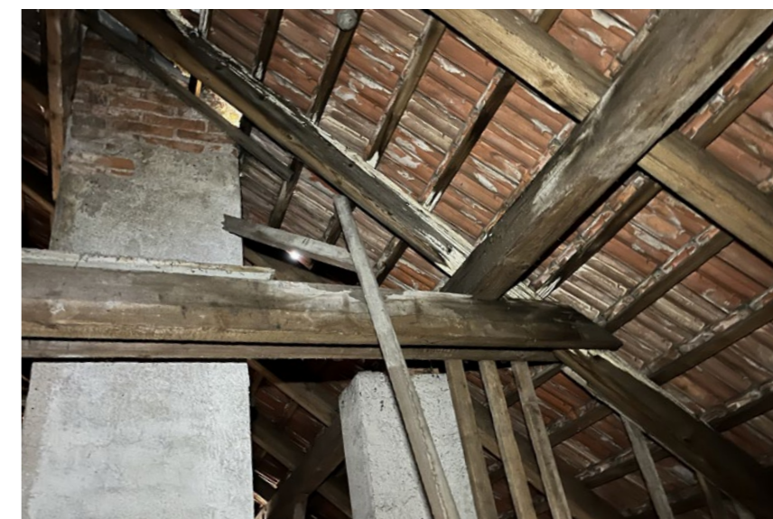
krov 3.5: jižní průhled podkrovím původní komínové těleso dodatečně nastavované s nástavbami pater
