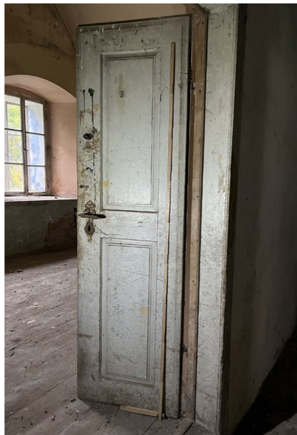
jižní levé křídlo, líc pohled z chodby 1.2
