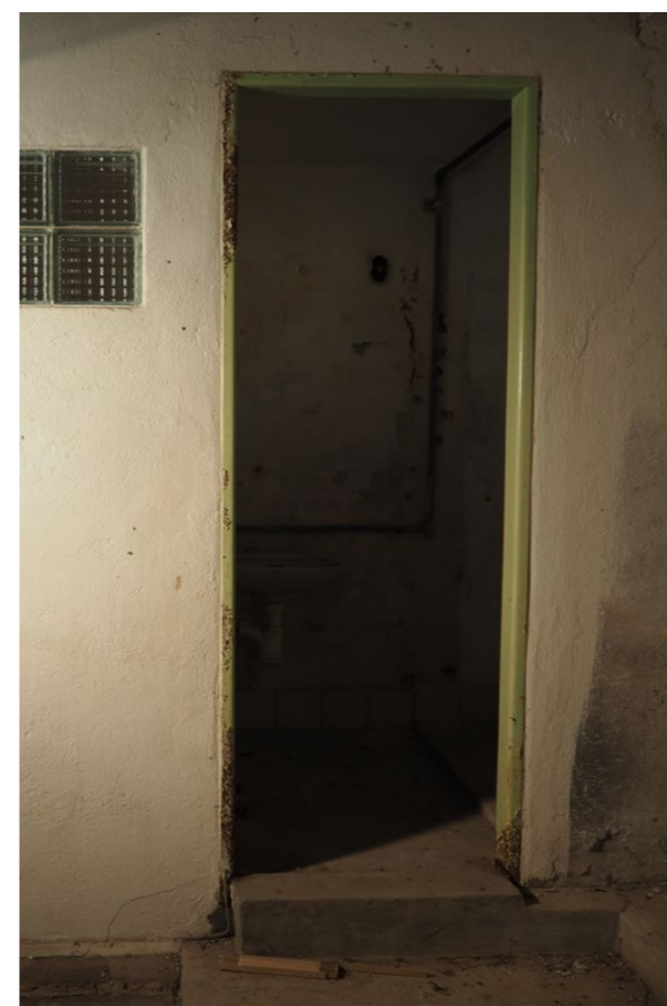
dveřní otvor pohled z komory 1.1a
