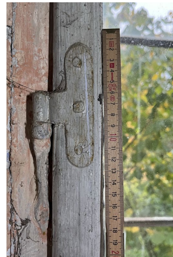
svislý závěs na trnu s opěrkou vnitřní rovina
