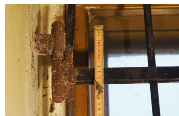
detail závěsu - jižní křídlo mříže vnitřní rovina
