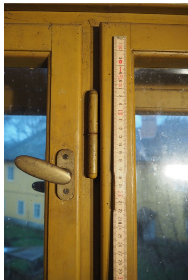
detail klíčky se štítkem jednokřídlo
