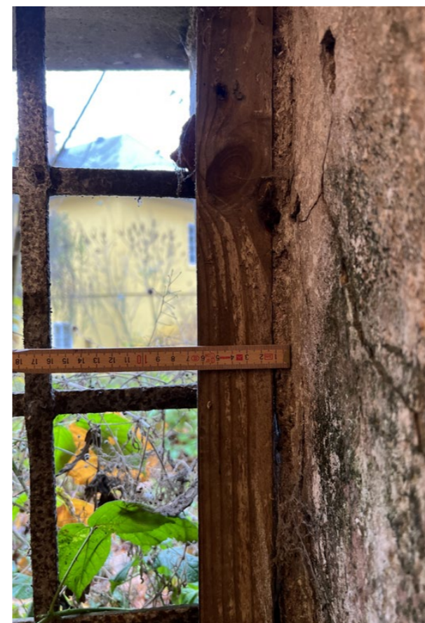
jižní stojka dřevěného rámu vnitřní rovina
