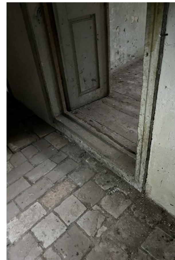
práh dveří a část obložkové zárubně pohled z chodby 1.2
