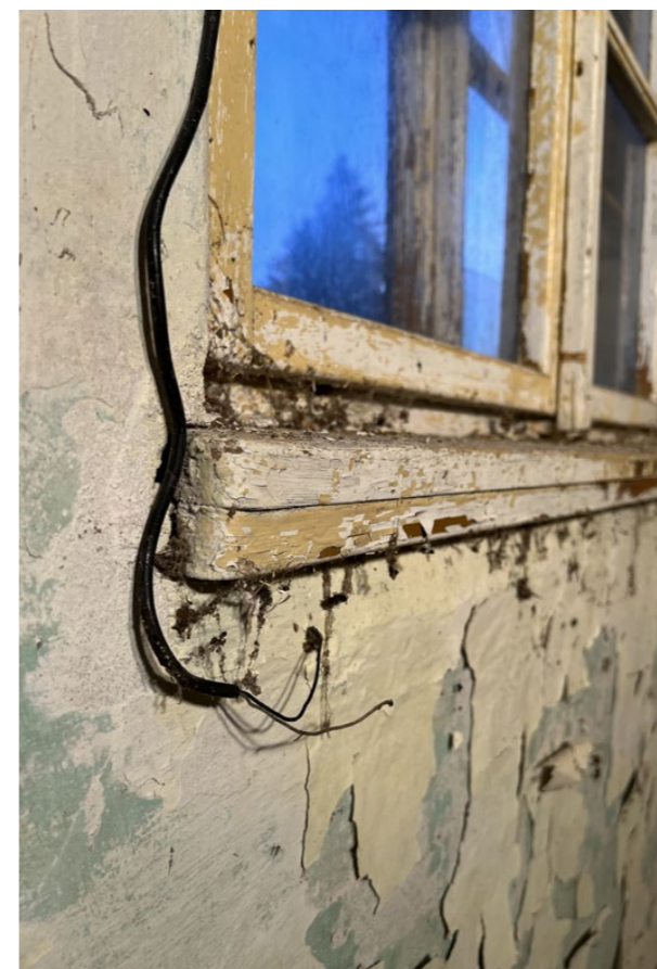
detail dřevěné parapetní desky
