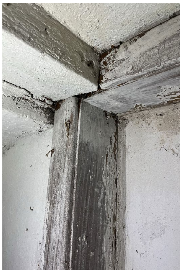
detail východního horního rohu se stupněm schodiště do 2. patra
