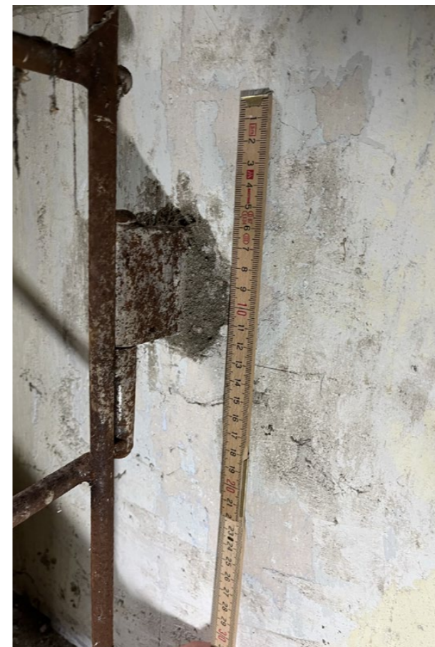
detail závěsu mříže vnitřní rovina
