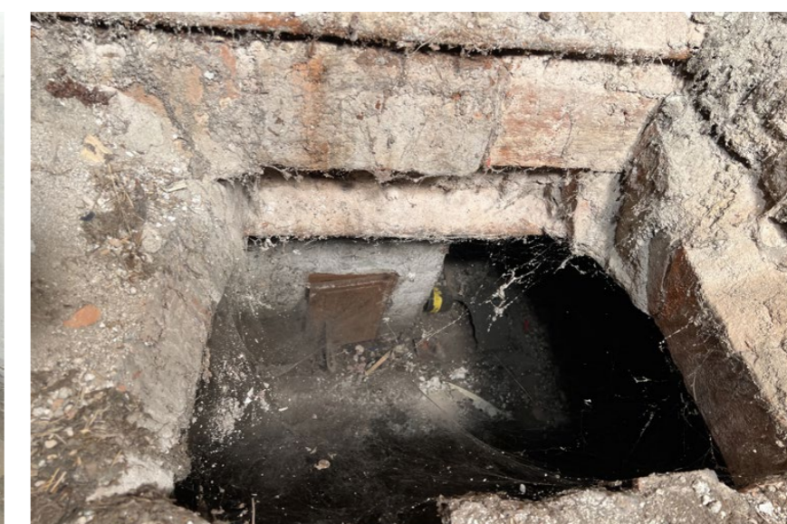
chodba 2.9: otvor do prostoru nosného podhledu vymetací dvířka pro komín místností 2.8 a 2.11
