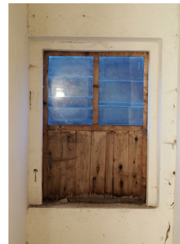
vnitřní strana, prostor schodiště
