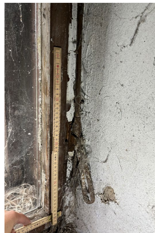
spodní část s pákou sklápěcí mechanismus nadsvětlíku
