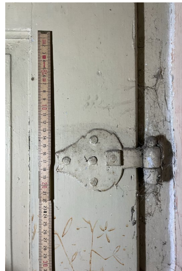
detail lopatkového závěsu s trnem rub dveří, místnost 1.3
