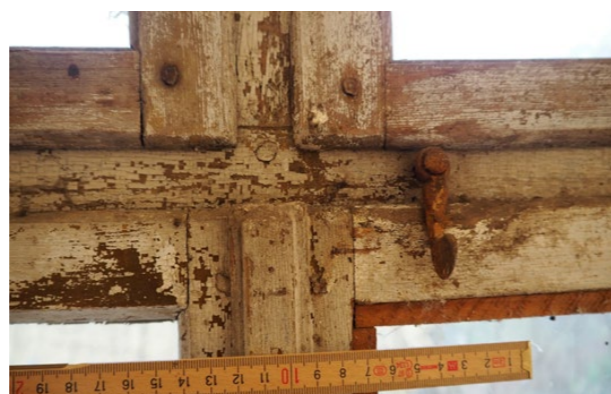
detail poutce s obrtlíkem vnitřní rovina
