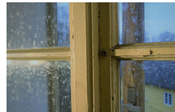
detail profilace křídla vnitřní rovina
