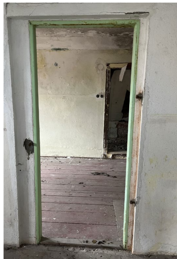
ocelová zárubeň s relikty po mříži lícová strana dveřního křídla
