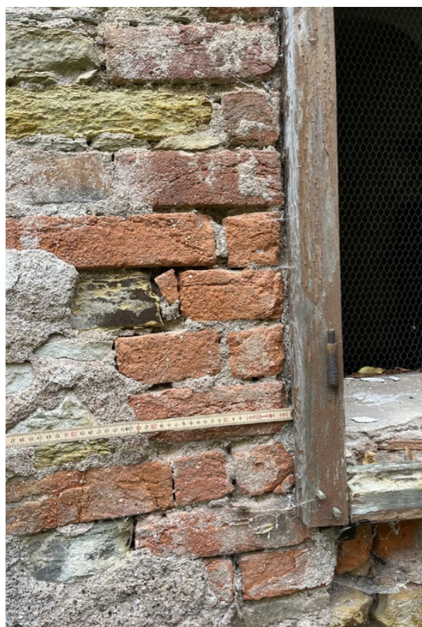
cihelná přezdívka ostění, vnější rovina severní fasáda
