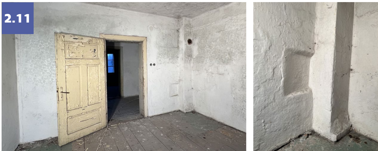
místnost 2.11: pohled východní, vstupní dveře D.27, komínové těleso komínové těleso s obroušenou zdí po osazení sporáku, u podlahy rozšíření v místech, kde se komín vyhybá ocelové traverze (nosná konstrukce klenbiček do traverz)
