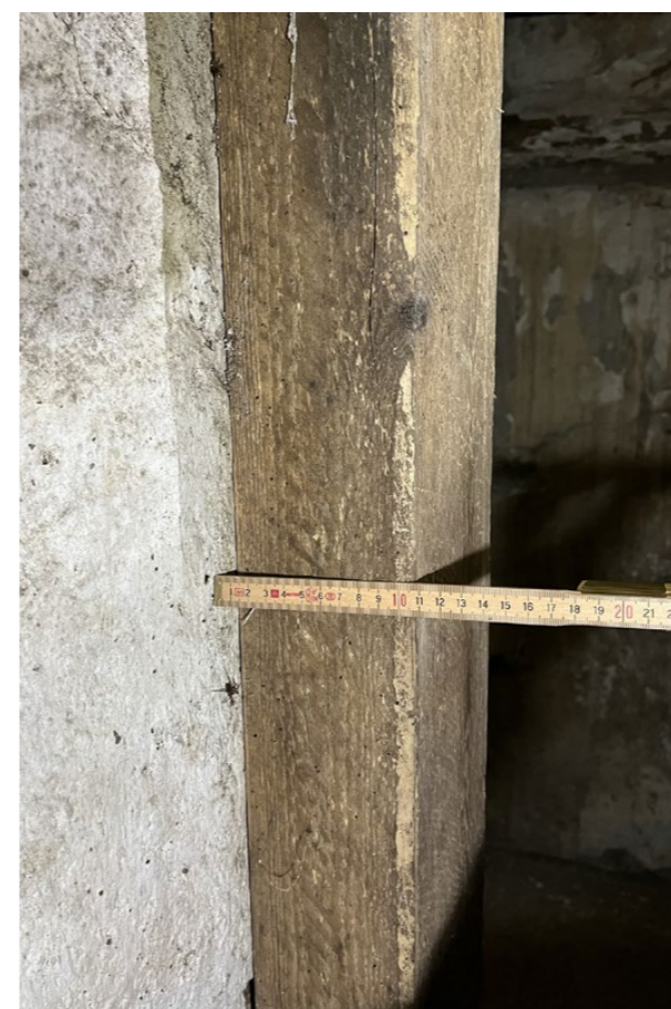
šířka zárubně ve dveřním otvoru pohled ze spíže 0.3
