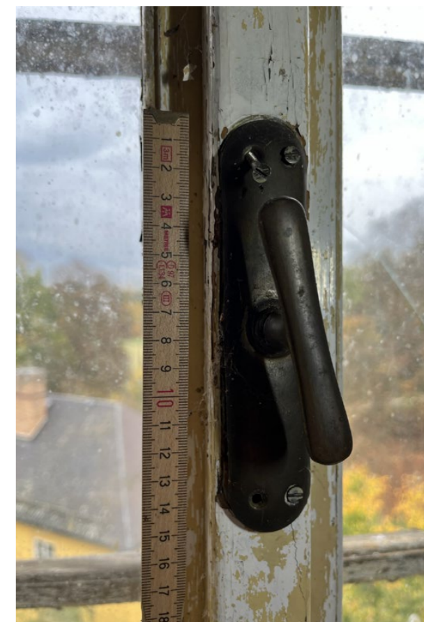
detail mosazné rozvory vnitřní rovina, dvoukřídlo
