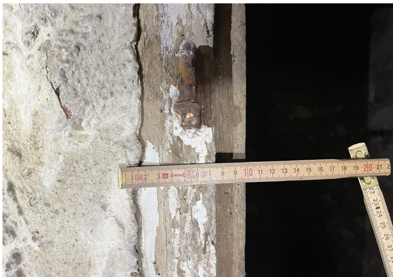
detail trnu a dochované bílé nátěry na jižní stojce zárubně pohled z kuchyně 0.2
