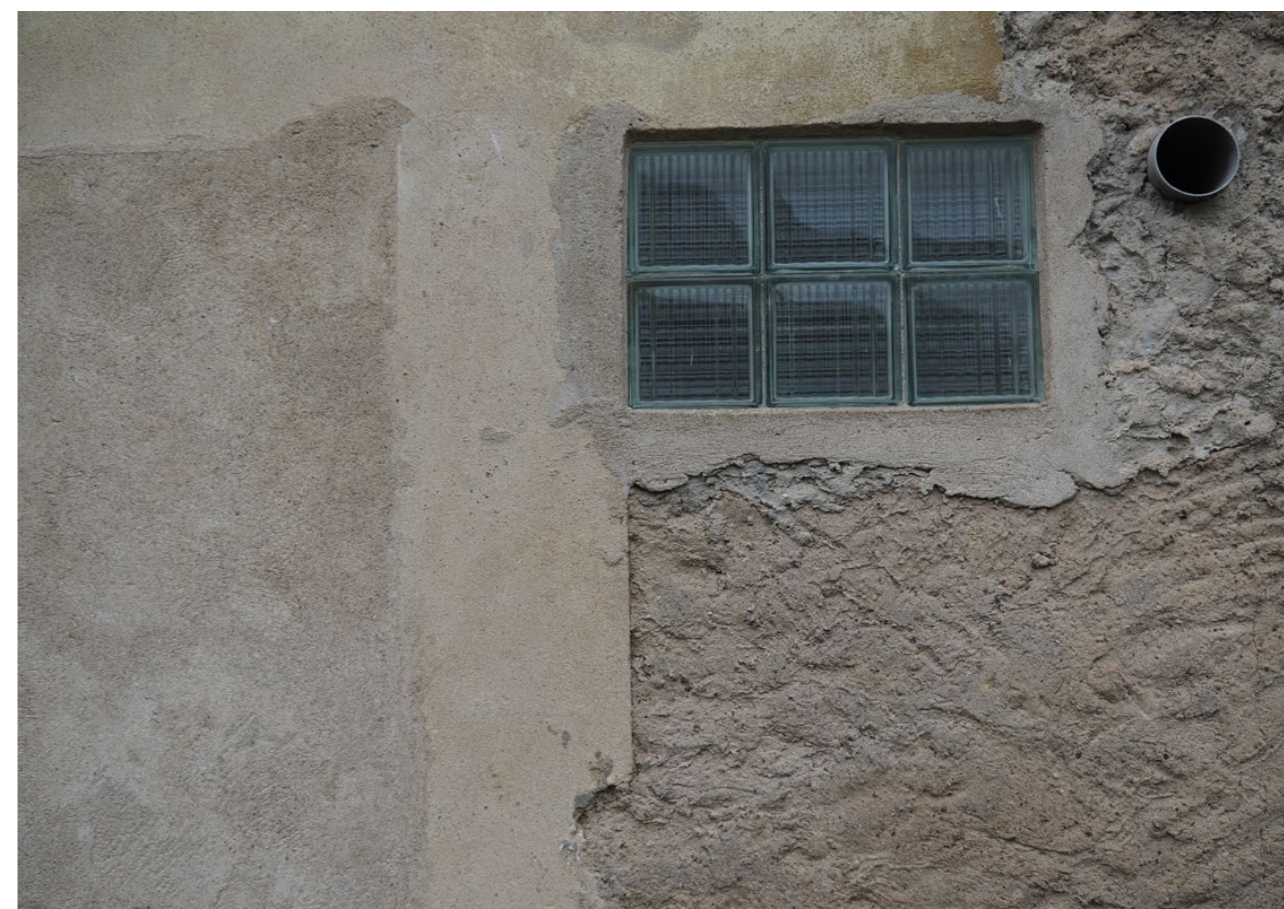
luxfery, omítkové opravy kolem okna, pod oknem, severně od okna detail západní fasády
