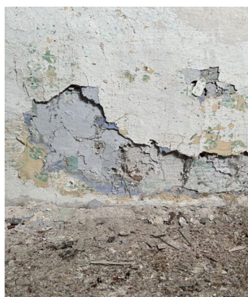
místnost 2.8: pohled západní, okenní otvor O.22 omítková a nátěrová situace v parapetu pod oknem
