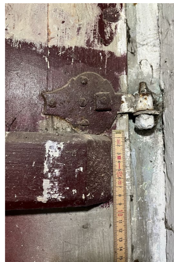
detail lopatkového závěsu s trnem rubová strana dveřního křídla
