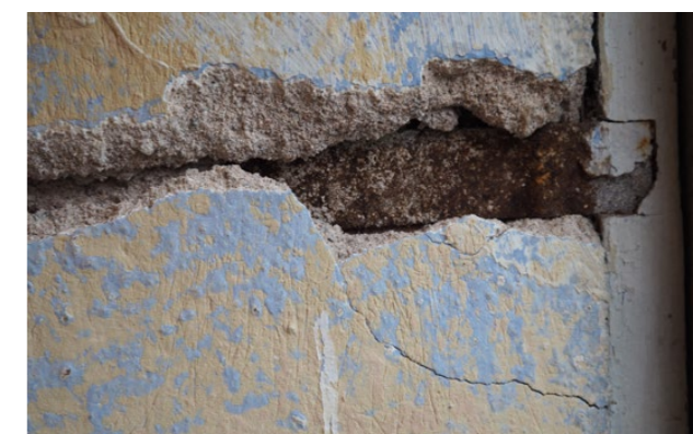
omítková sonda ve špaletě okna 0.6
