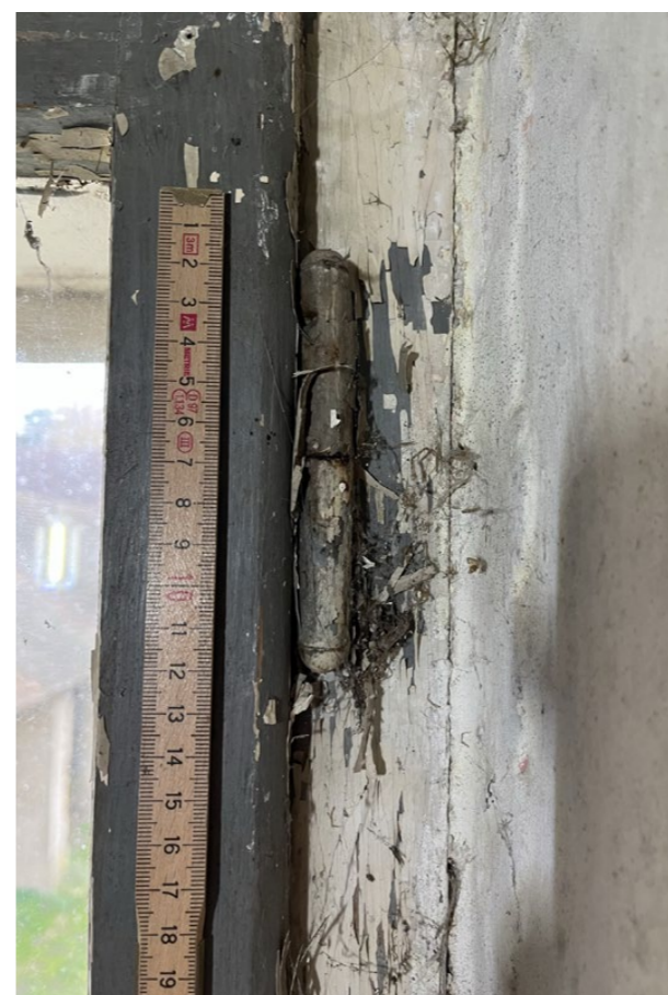
detail závěsů - pastrany vnitřní rovina
