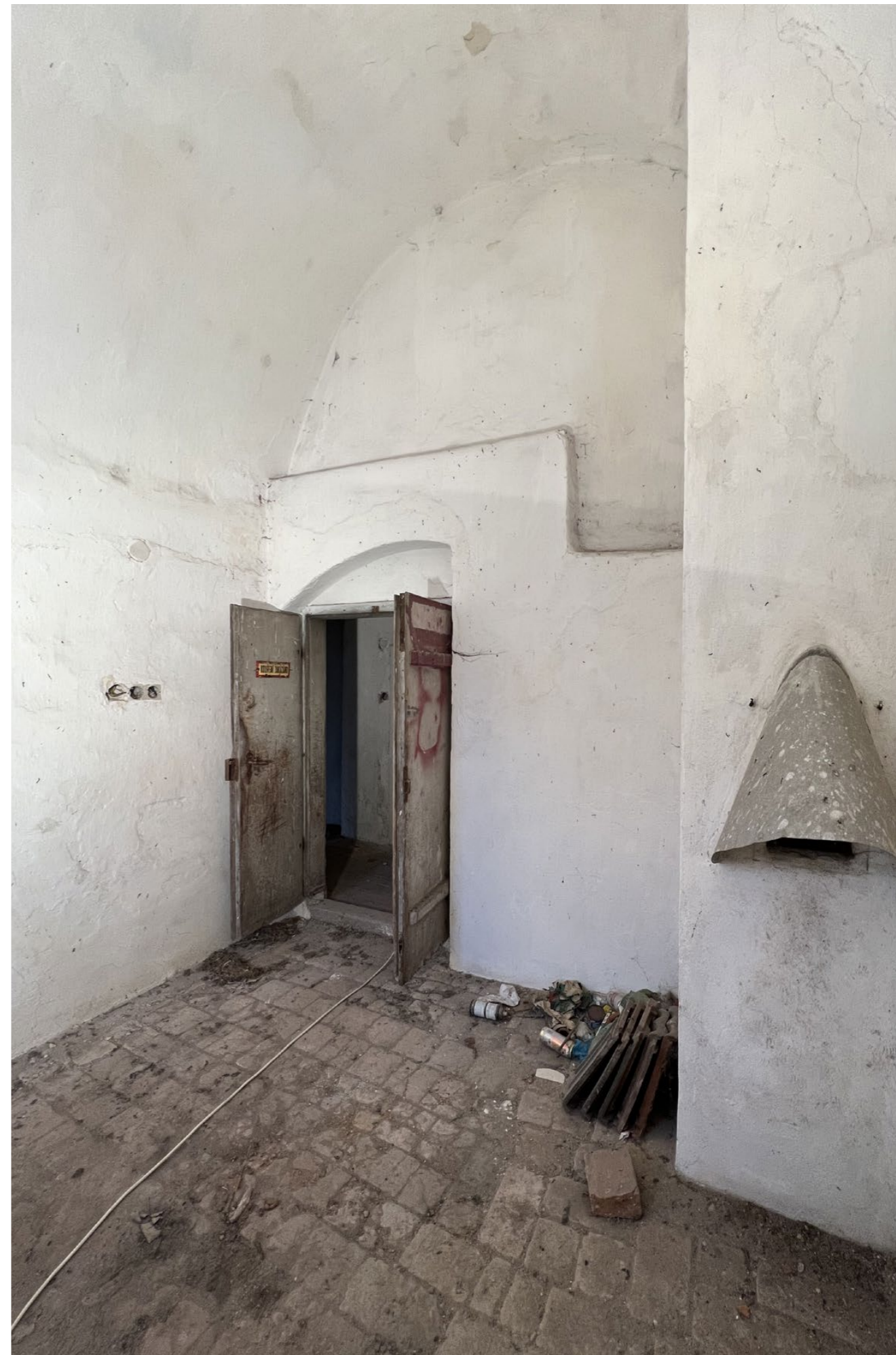
kuchyň 1.5: bývalá černá kuchyně, pohled jihozápadní na dveře D.14, nade dveřmi kouřový tah z dodatečně osazených kamen v místnosti 1.3
