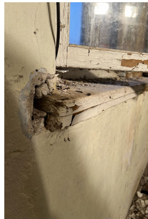
detail dřevěné desky parapetu
