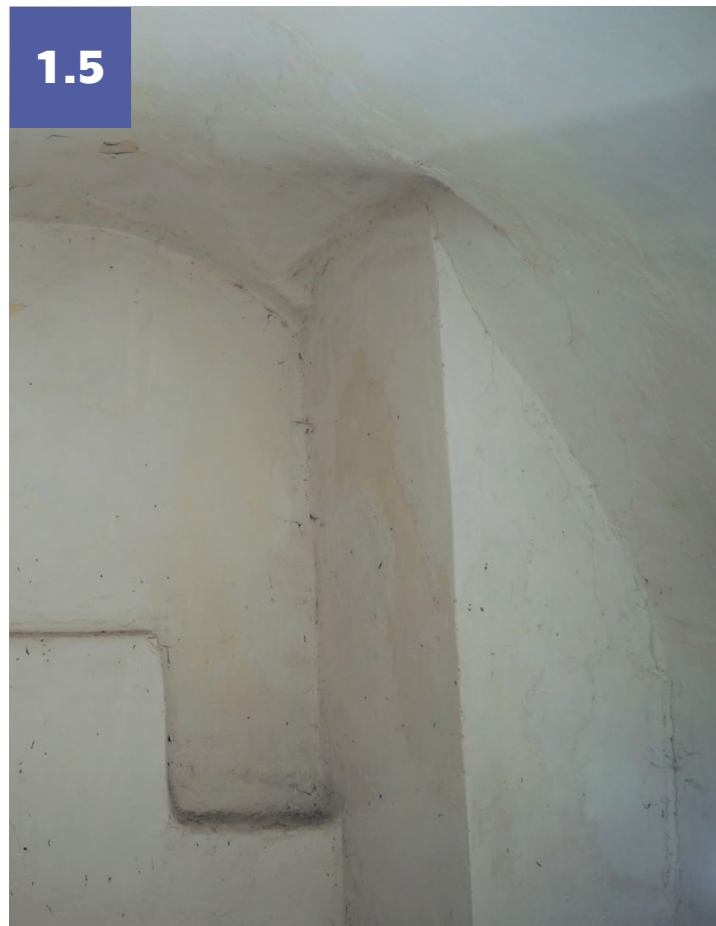
kuchyň 1.5: pohled severozápadní horní část komínového tělesa, u stropu pětiboká výseč
