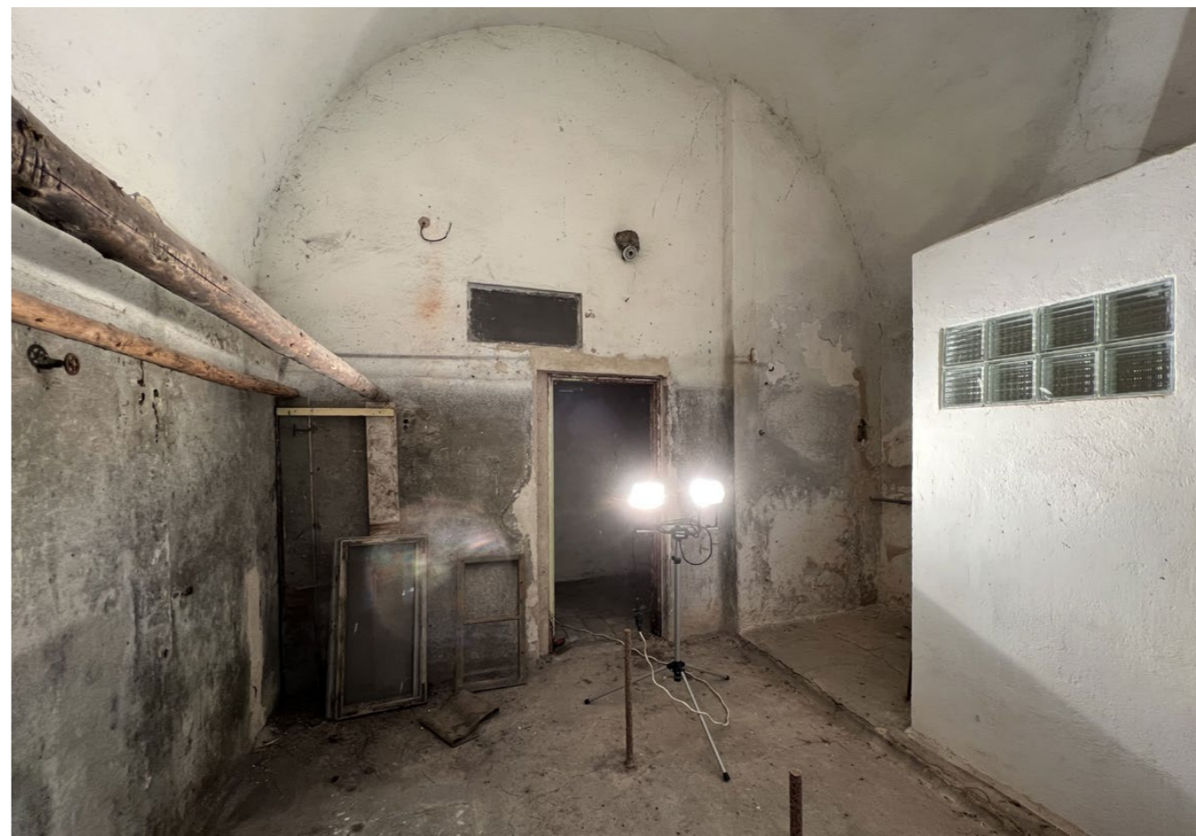
místnost 1.1a: pohled východní na vstup do místnosti
