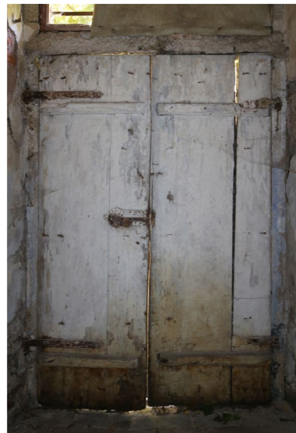
svlaková konstrukce rubové strany dveří
