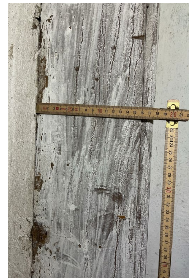
tloušťka zárubně až po přízdívku
