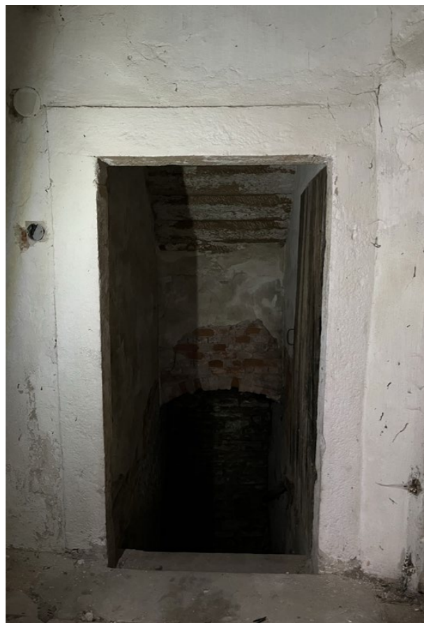
kamenné ostění, lícová strana chodba 1.2
