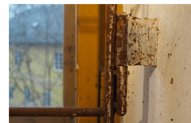
detail závěsu mříže vnitřní rovina
