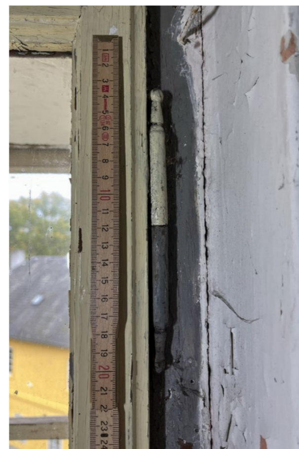
detail závěsů - pastrany vnitřní rovina
