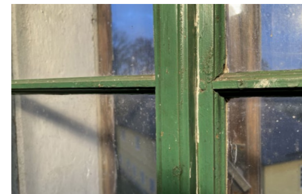
detail profilace křídla vnitřní rovina
