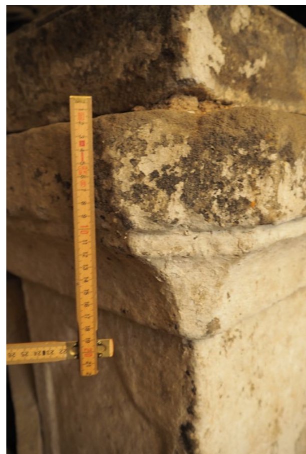
detail okosené hlavice sloupku
