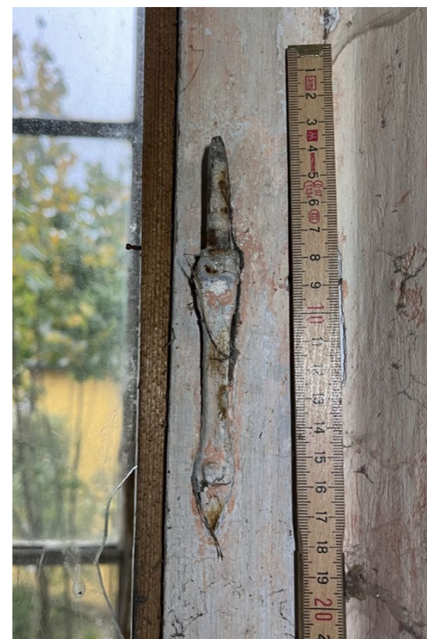
detail trnu s opěrkou vnitřní rovina
