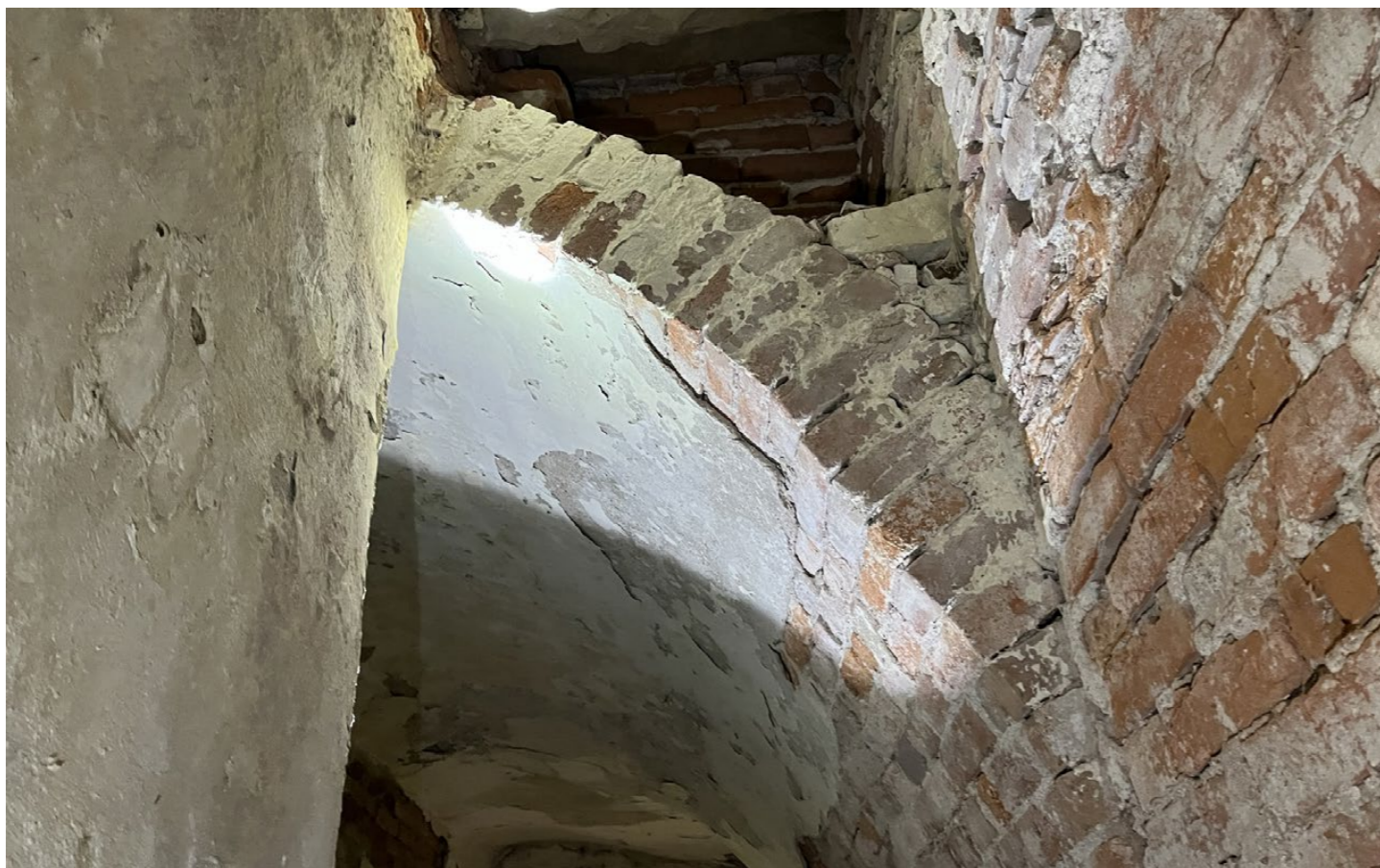
kuchyň: pohled na ubouranou část valené klenby kuchyně v souvislosti s přestavbou nástupní části schodiště z přízemí do 1. patra
