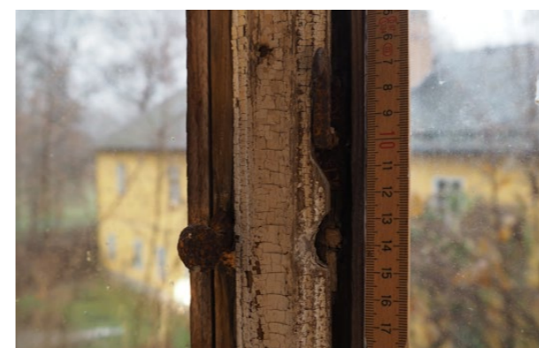
detail knoflíků pro manipulaci s křídly pevný sloupek, vnější rovina
