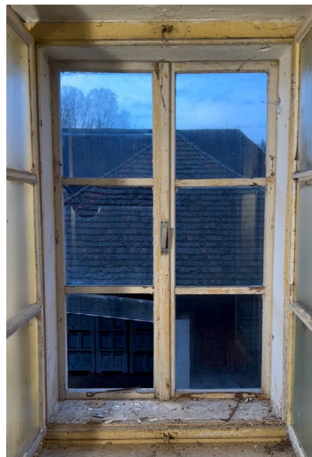
vnější rovina pohled z interiéru
