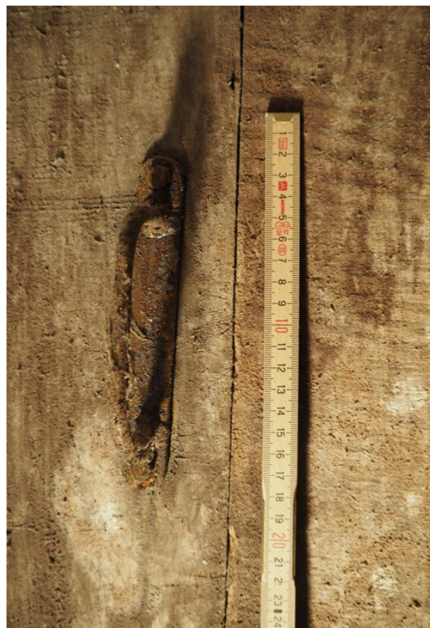
detail madla pro otevírání dveří líc dveřního křídla
