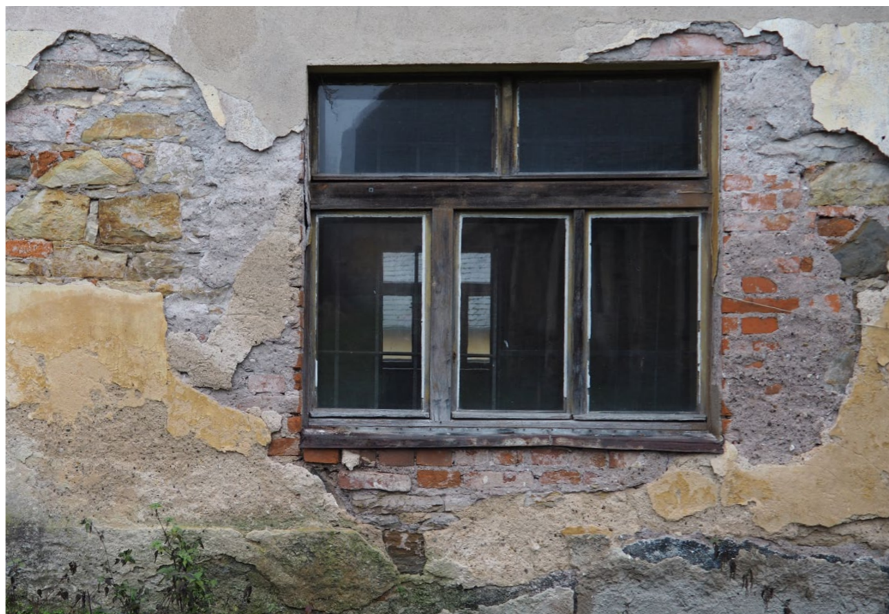
situace na fasádě kolem okna O.12 západní fasáda
