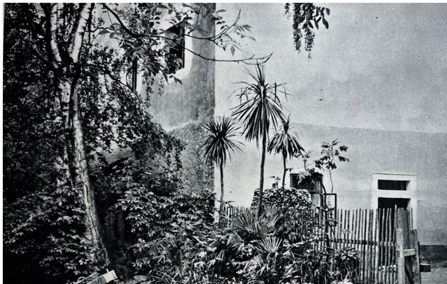
Dům pod dvorem, proražena okna O.09, O.10, zadržena 2 okna na severní fasádě, rok 1941 Zdroj: (Kubka, Novotný, 1941)
