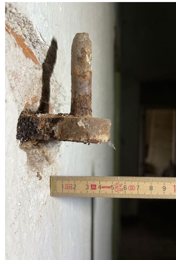
detail horního trnu chodba 1.2 severní ostění
