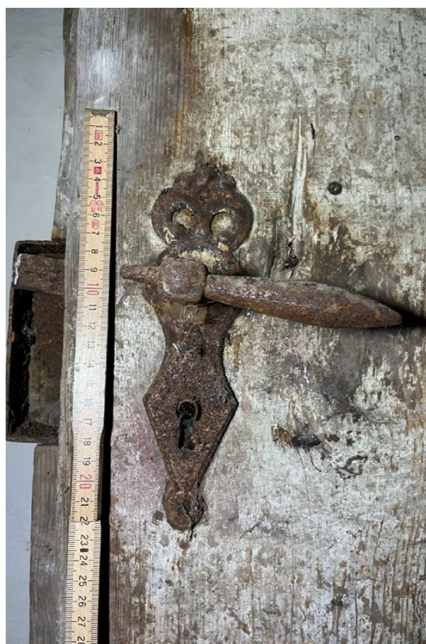
detail kliky se štítkem levé křídlo, lícová strana
