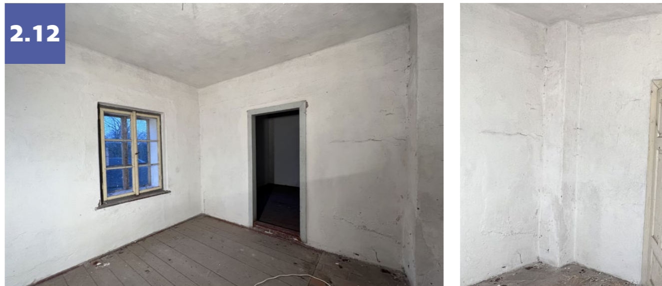
místnost 2.12: pohled jihovýchodní, okno O.19, proražené dveře D.26 záběr komínového tělesa s omítkovou opravou na přilehlé jižní zdi
