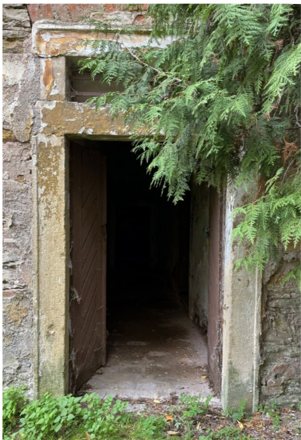
kamenné ostění dveří a nadsvětlíku
