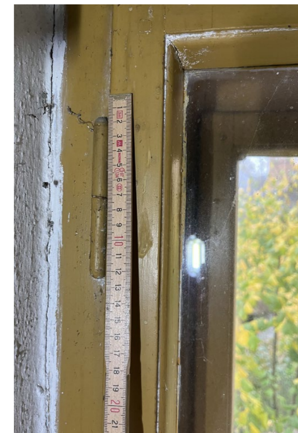
detail závěsu vnitřní rovina
