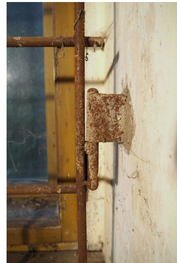
detail závěsu mříže vnitřní rovina
