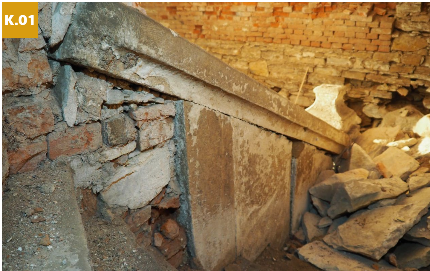
detail ukončovacího profilu desky kamenného zábradlí
