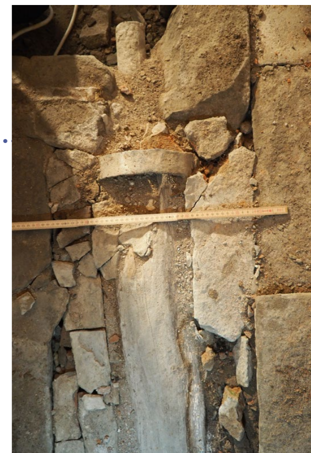
mléčný sklep detail trubky v kamenné podlaze
