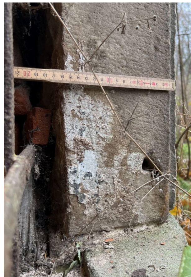
tloušťka severní stojky ostění
