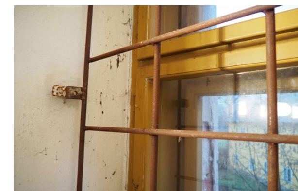
detail mříže vnitřní rovina
