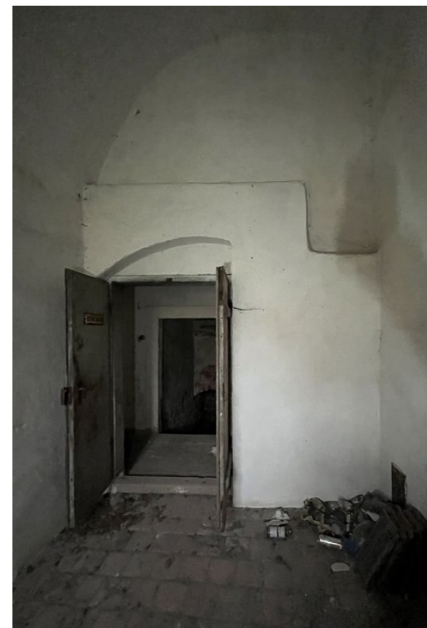
pohled na přízdívku tahu do komína kuchyň 1.5
