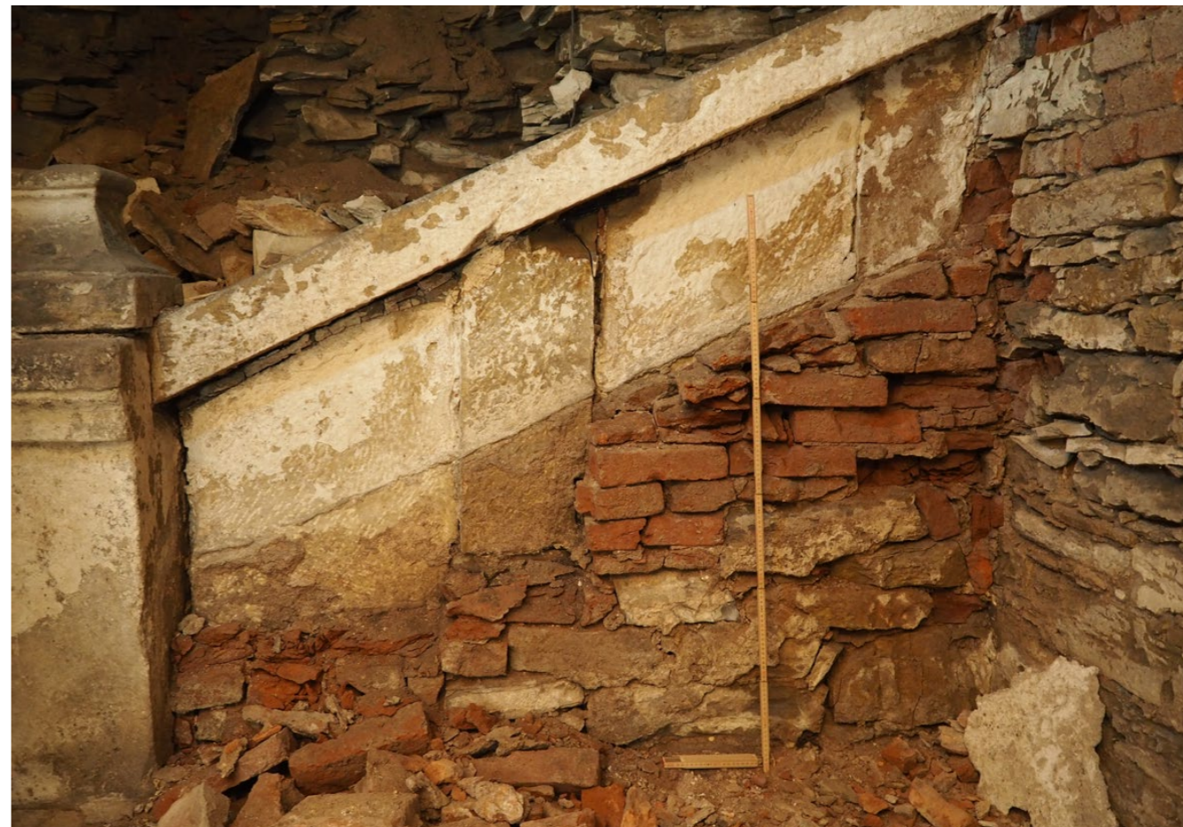
boční pohled na kamenné zábradlí s přizdívkou
