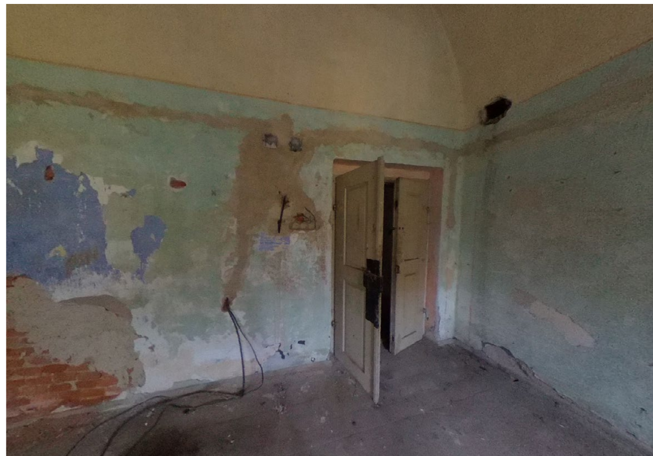
místnost 1.3: pohled severozápadní na vstupní dveře do místnosti na severní zdi v rohu otvor po kouřovém tahu z kamen osazených při zobytnění
