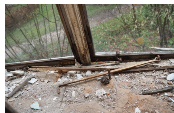
detail pevného sloupku s křídly vnější rovina
