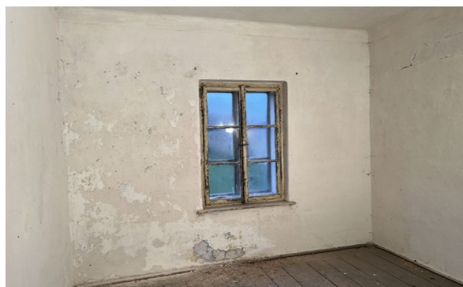
místnost 2.8: pohled západní, okenní otvor O.22 omítková a nátěrová situace v parapetu pod oknem
