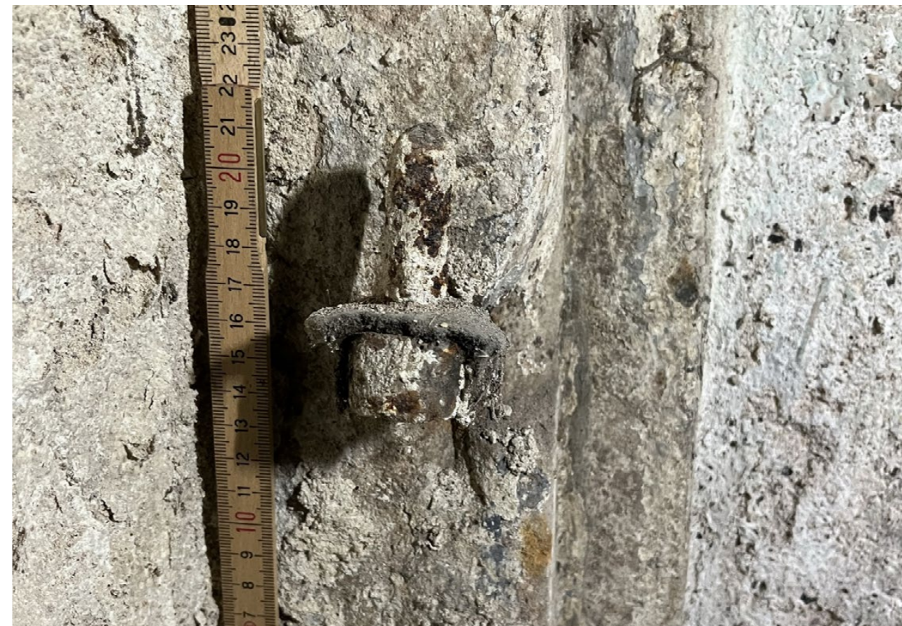
detail horního trnu východní stojka kamenného ostění
