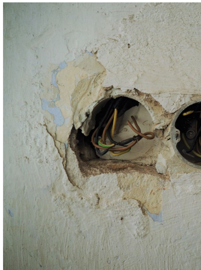
omítková sonda kolem elektroinstalace 3 omítkové vrstvy, vícero nátěrů
