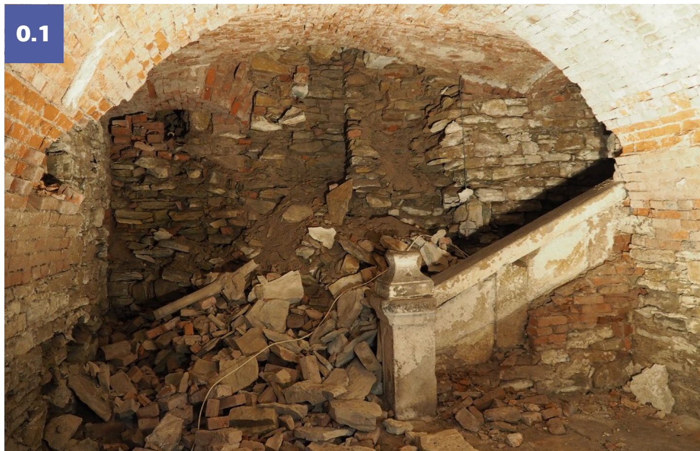
mléčný sklep: K.01 kamenný sloupek zábradlí pozice sloupku v místnosti
