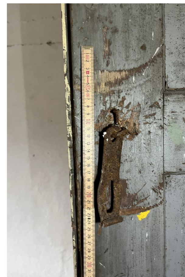
detail štítu petlice lícová strana dveřního křídla
