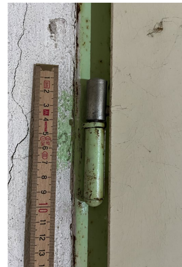
detail horního závěsu rubová strana dveřního křídla
