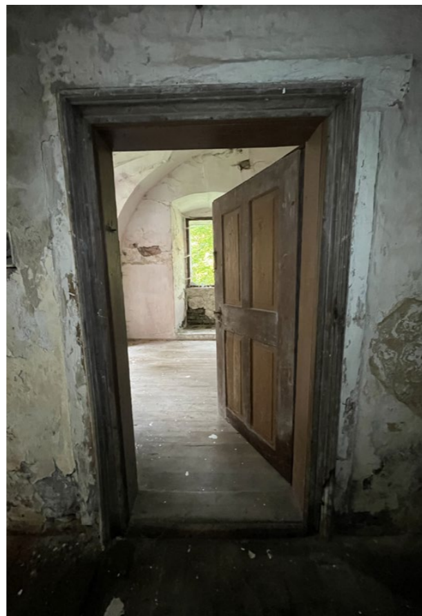
obložková zárubeň osazena na dřevěné trámkové zárubni
