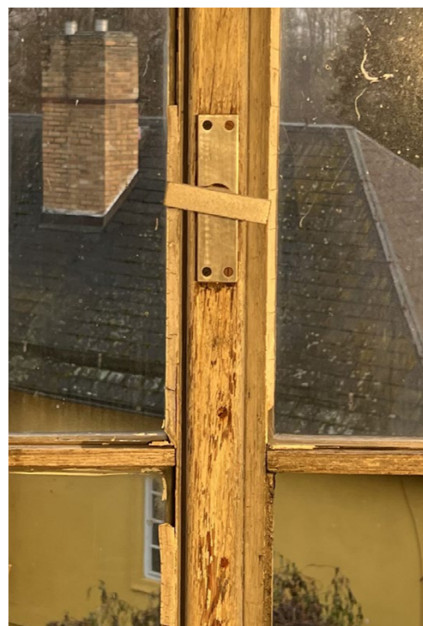
detail hliníkové rozvory lícová strana, vnější rovina
