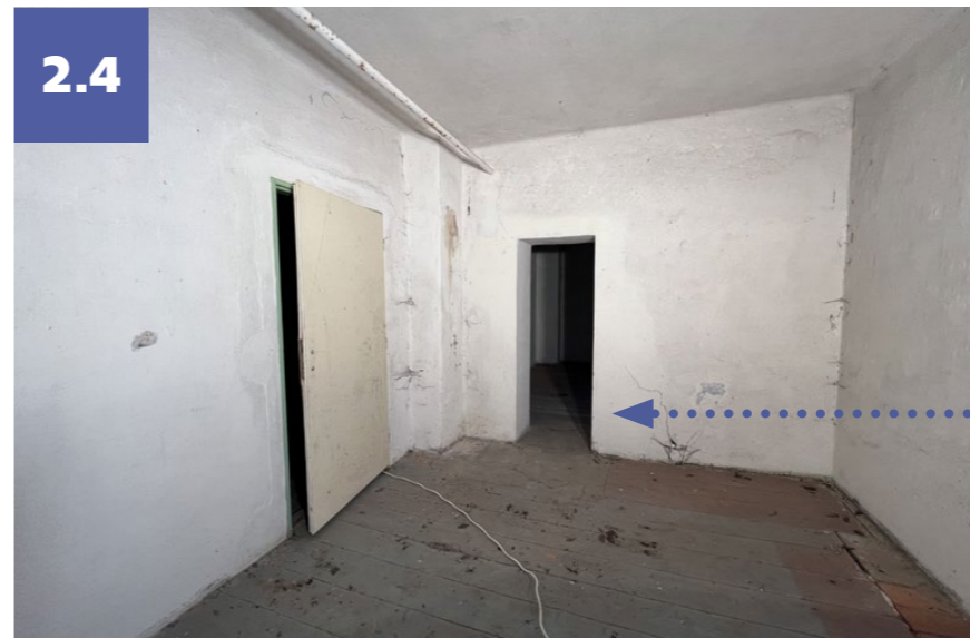
místnost 2.4: pohled severní, dodatečný průřez otvoru do místnosti 2.7
