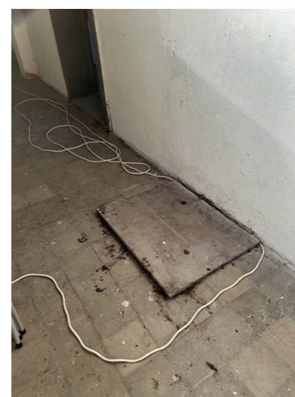
chodba 2.9: otvor do prostoru nosného podhledu vymetací dvířka pro komín místností 2.8 a 2.11
