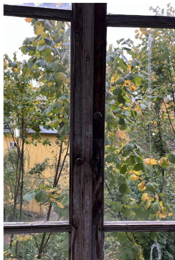
detail knoflíku pro manipulaci s křídlem vnější rovina, líc
