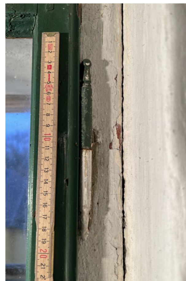
detail závěsů - pastrany vnitřní rovina
