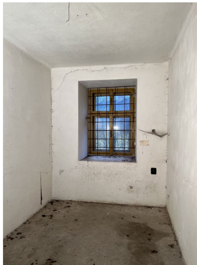
místnost 1.8: pohled východní na okno O.09 jihovýchodní část bývalé čelední ratejny
