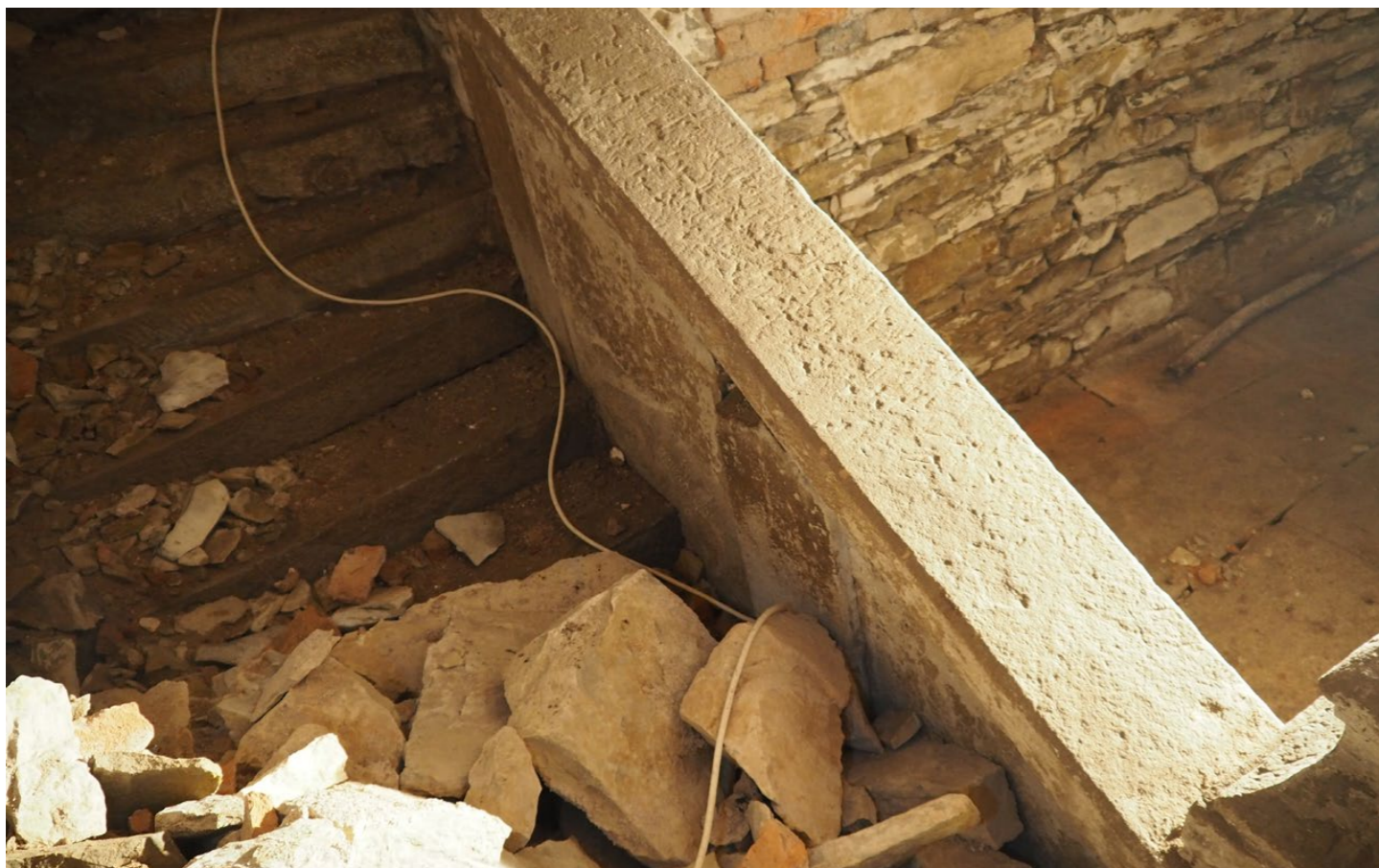
pohled shora na kamennou desku zábradlí
