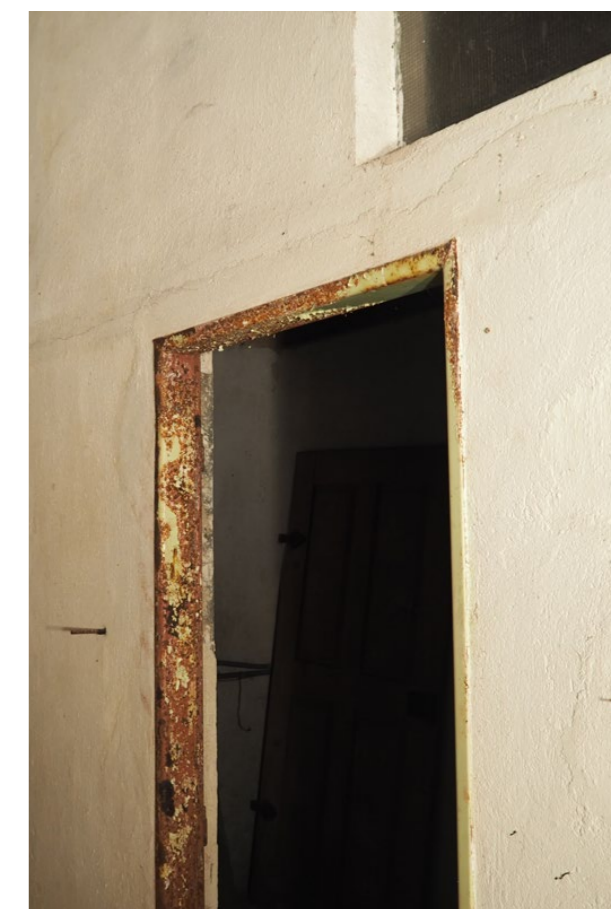
část nadsvětlíku a dveřního otvoru pohled z chodby 1.6
