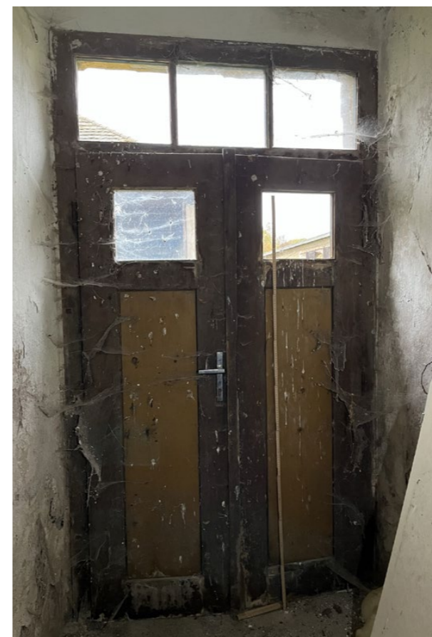
rub dveřního křídla se svlaky a vzpěrou prostor schodiště
