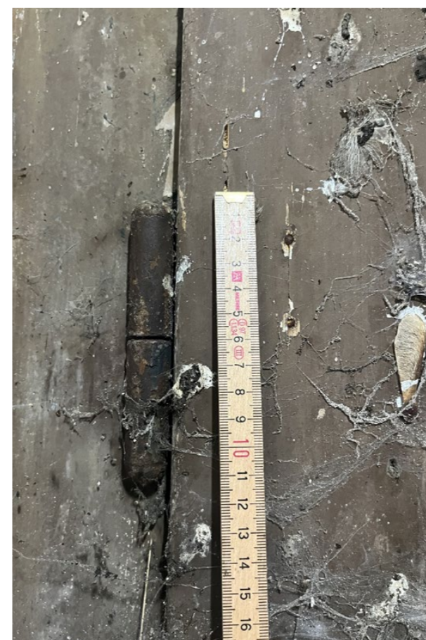
detail vnitřního závěsu rubová strana dveří (síně 1.4)
