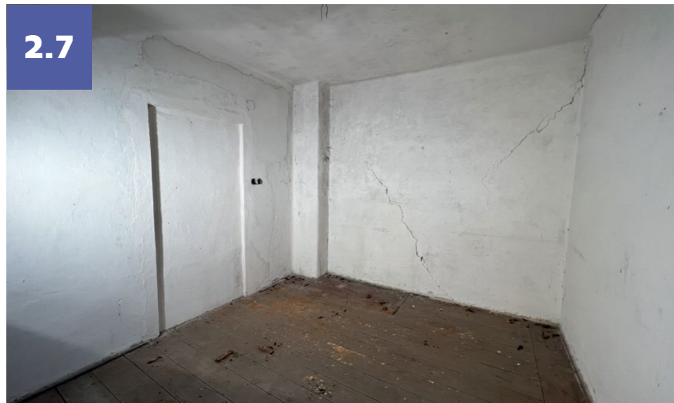
místnost 2.7: pohled severní, komínové těleso, nika v místech zazděných dveří z chodby 2.6
