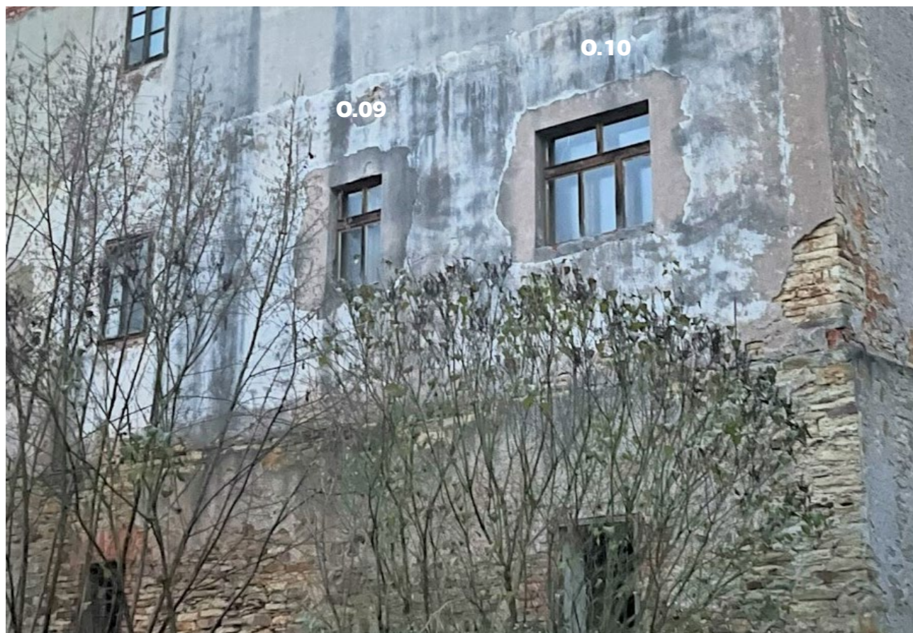
situace kolem oken 0.09 a 0.10, omítkové opravy, vnější rovina přízemí, východní fasáda
