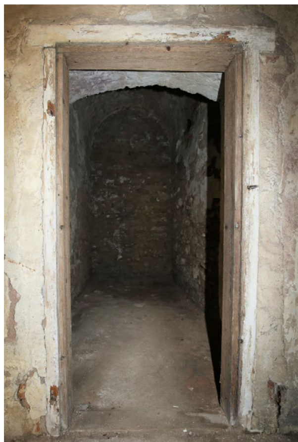
omítkové opravy kolem stojek trámková zárubeň pohled z kuchyně 0.2
