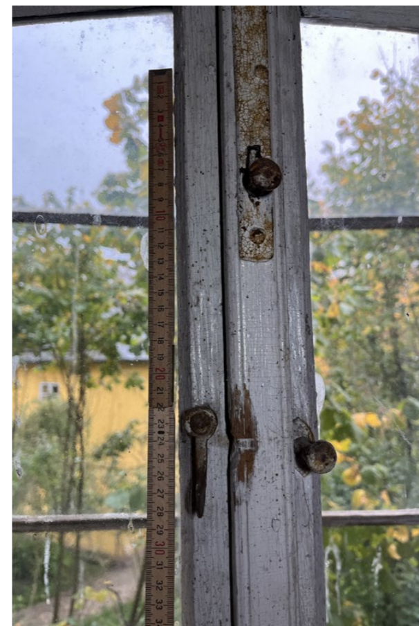
obrtlík, knoflík a část horní zástrče vnitřní rovina
