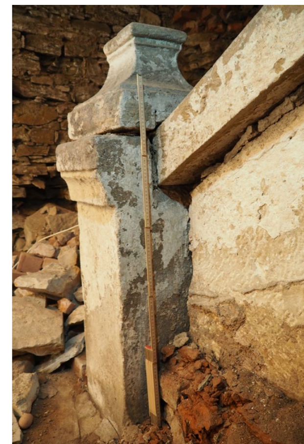
zadní část sloupku ná vaznost sloupku na zábradlí
