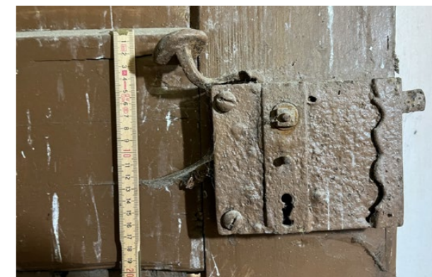
detail krabicového zámku rubová strana dveřního křídla
