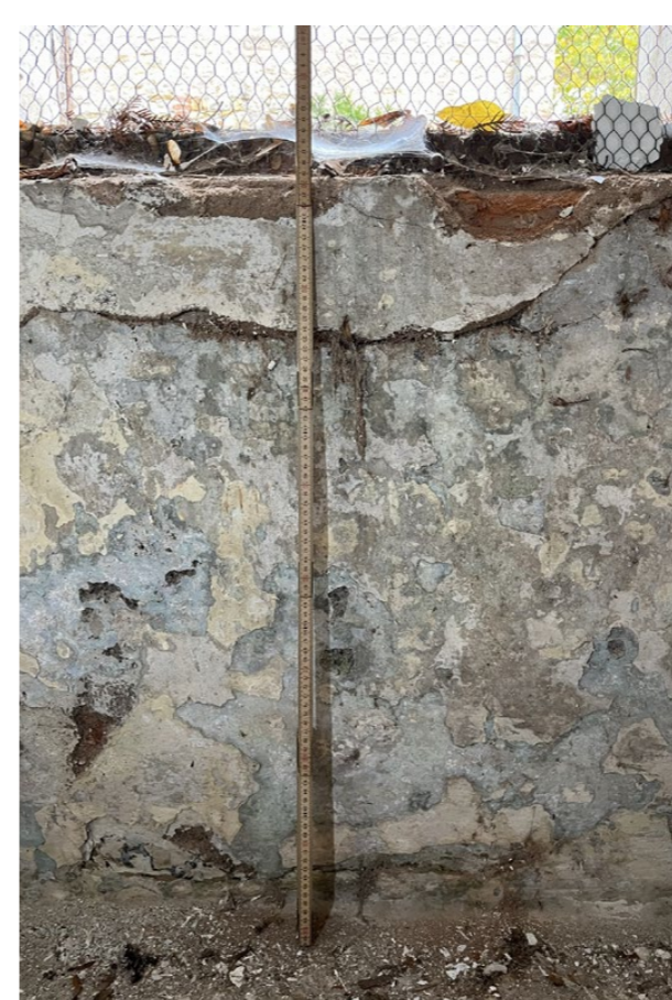
omítkové souvrství okenního parapetu vnitřní rovina
