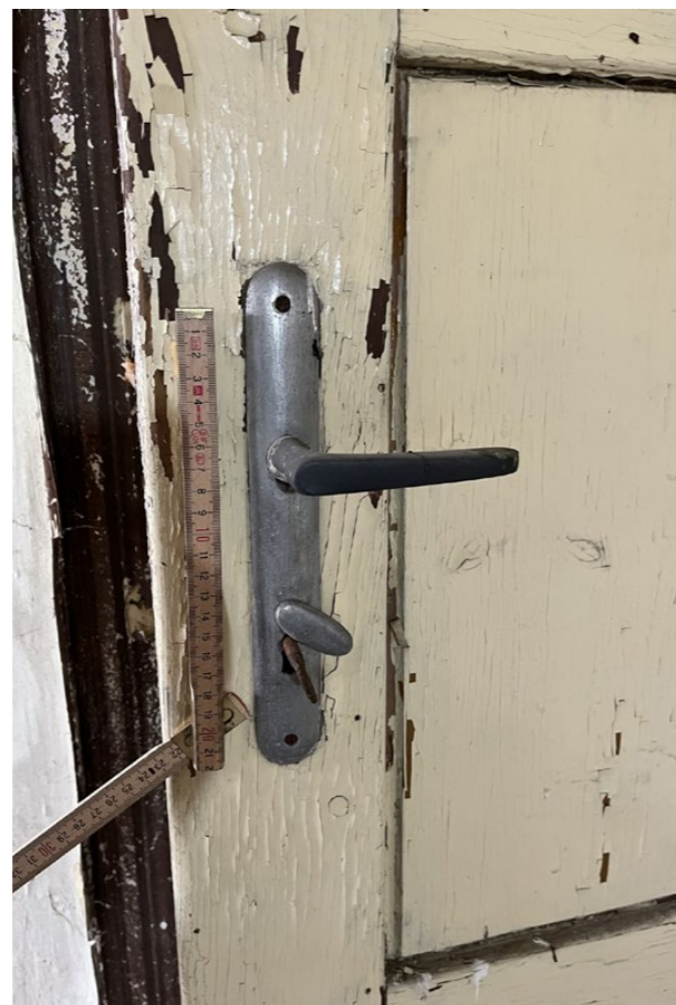
detail kliky se štítkem rubová strana dveřního křídla
