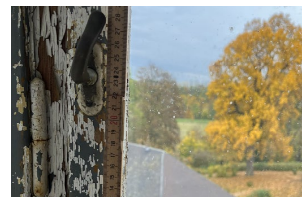
detail hliníkové kličky se štítkem vnější rovina, jednokřídlo
