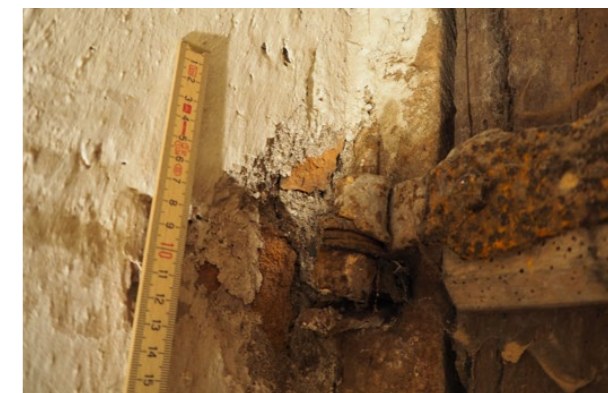
detail horního trnu rub dveří, prostor schodiště
