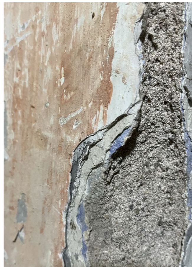
nátěry na rohu v soklové partii dveří D.10
