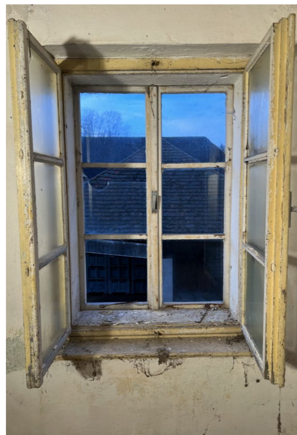
vnější rovina pohled z interiéru
