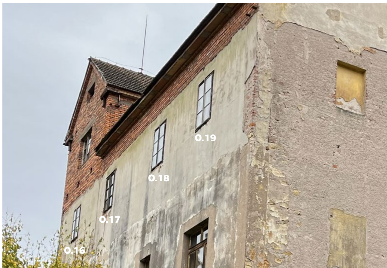
okna v patře východní fasáda
