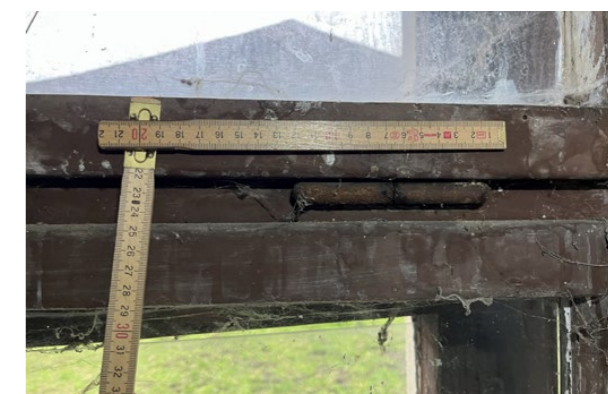
detail vodorovného závěsu sklopný nadsvětlík, vnitřní rovina
