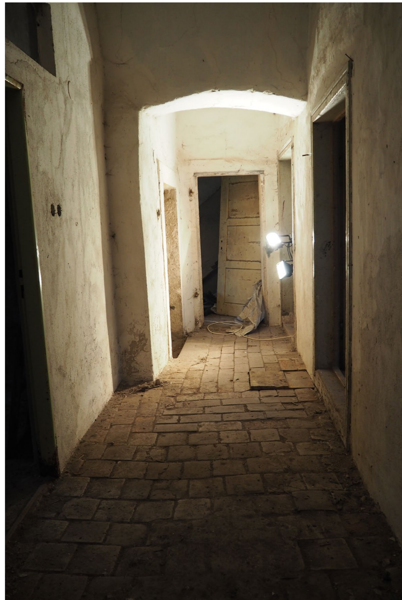
chodba 1.2: pohled severní, v místech původních dveří změna dláždění v podlaze
