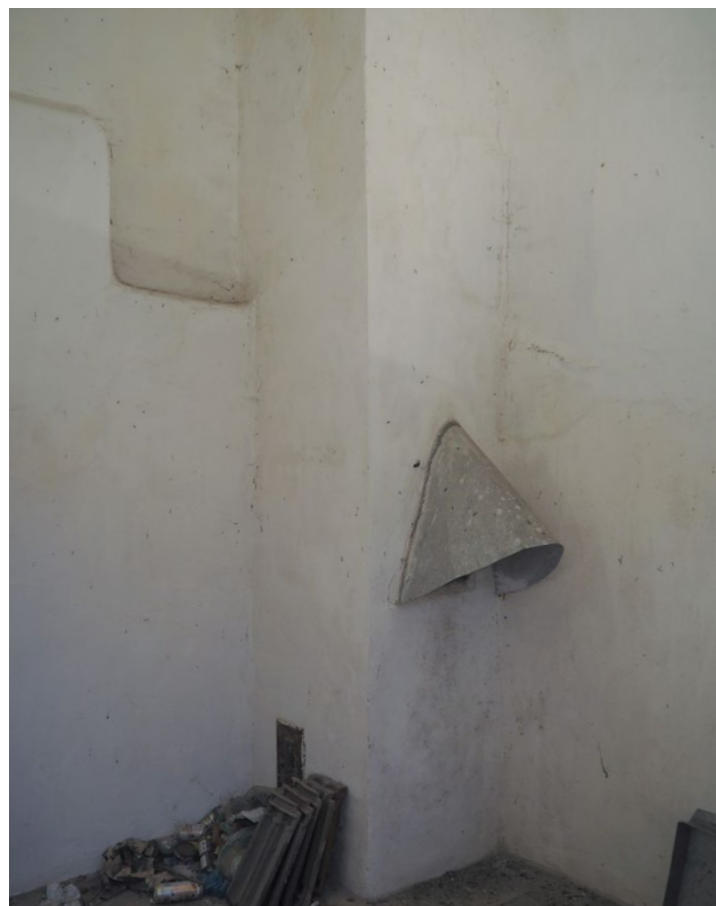
kuchyň 1.5: pohled severozápadní spodní část komínového tělesa
