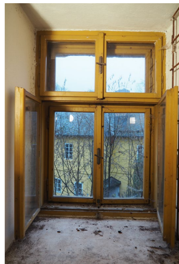
okno s otevřenou vnitřní rovinou pohled na vnější rovinu
