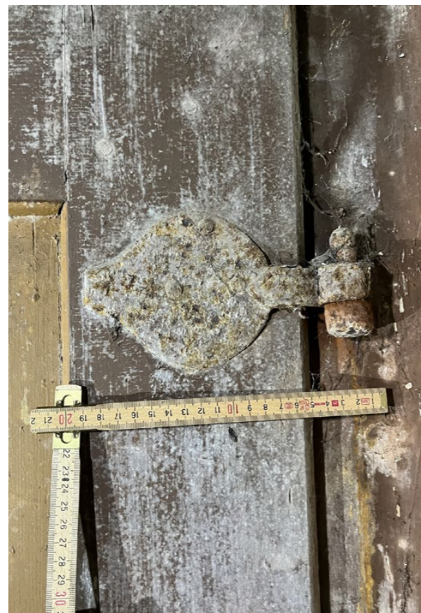
detail trnu a horní lopatkový závěs rubová strana dveřního křídla
