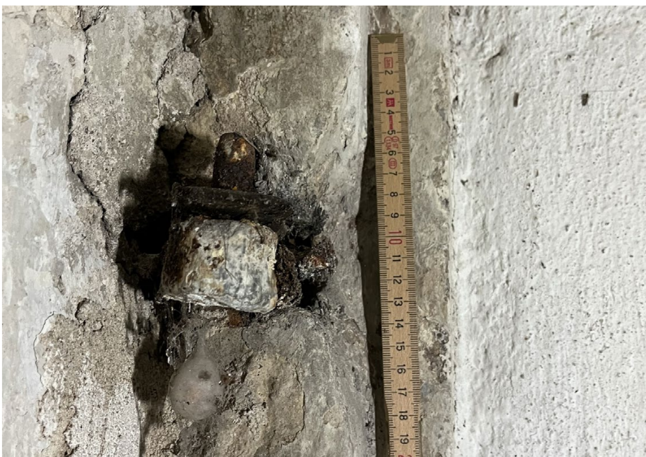
detail horního trnu východní stojka kamenného ostění
