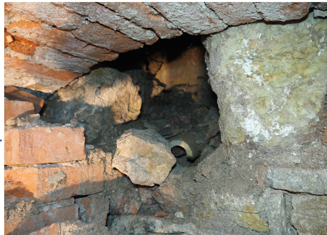
mléčný sklep: vodorovná trubka v nice vyvaleného zdiva
