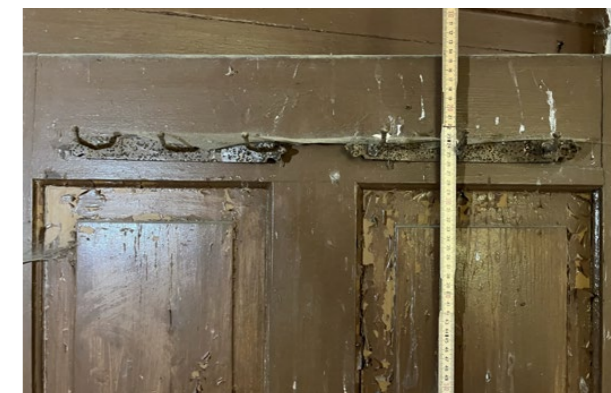
detail kovových háčků rubová strana dveřního křídla
