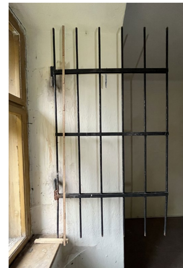
jižní křídlo mříže vnitřní rovina
