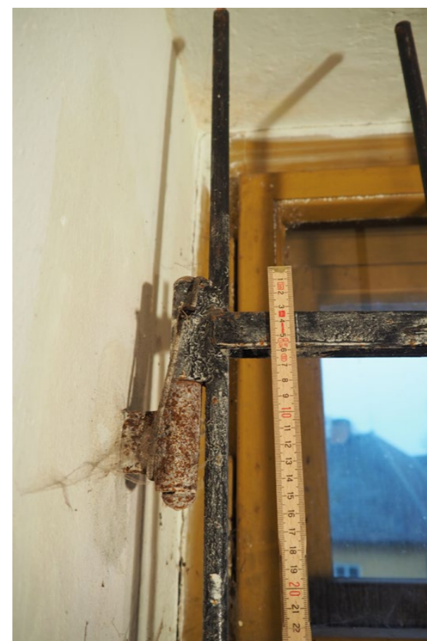
detail závěsu severní křídlo, vnitřní rovina
