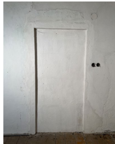
místnost 2.7: pohled severní, komínové těleso, nika v místech zazděných dveří z chodby 2.6
