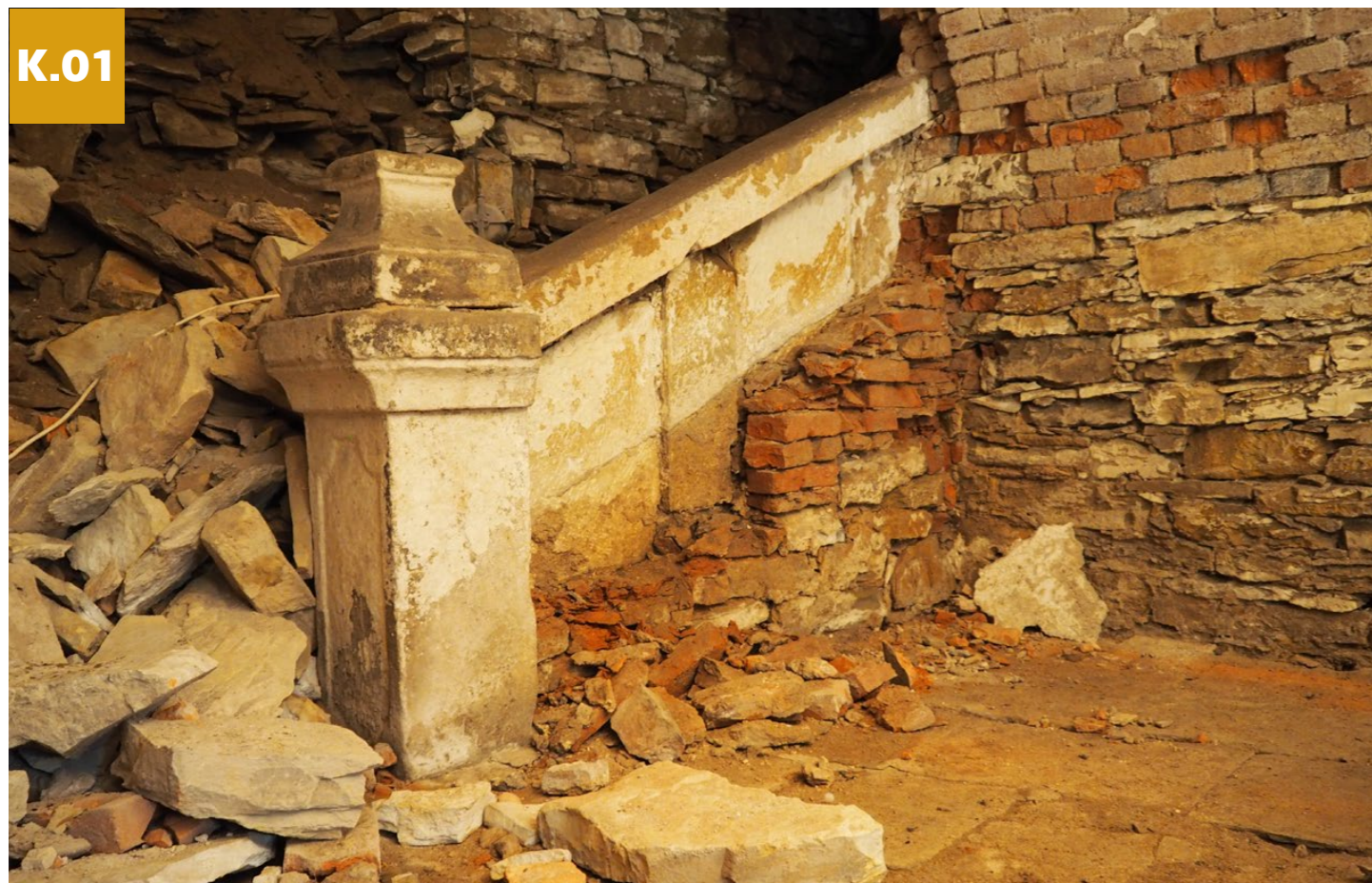
mléčný sklep 01: kamenný sloupek se zábradlím K.01
