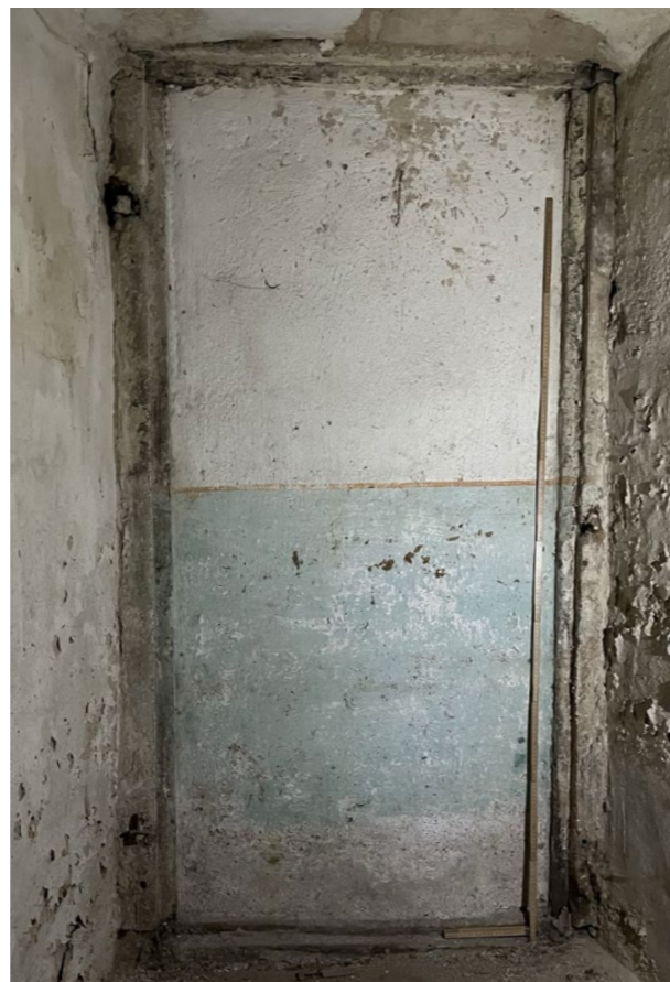
kamenné ostění zadržného otvoru chodba 1.2
