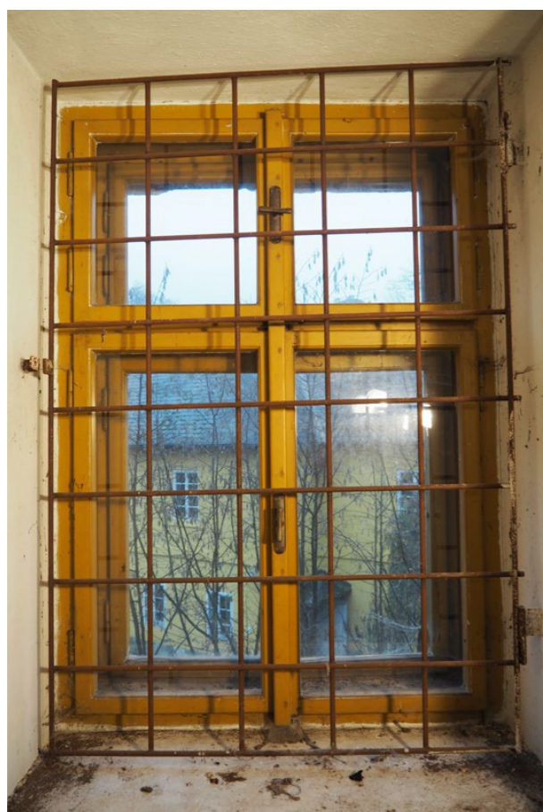
okno s mříží rub, vnitřní rovina
