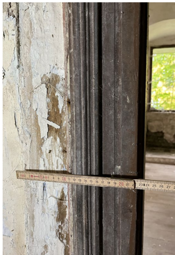
detail profilace obložkové zárubně
