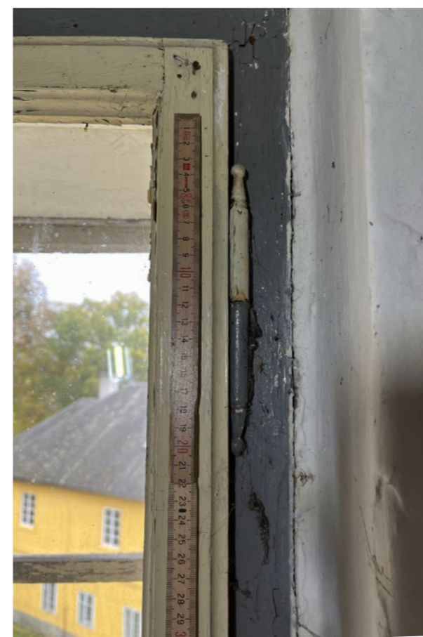
detail závěsů - pastrany vnitřní rovina
