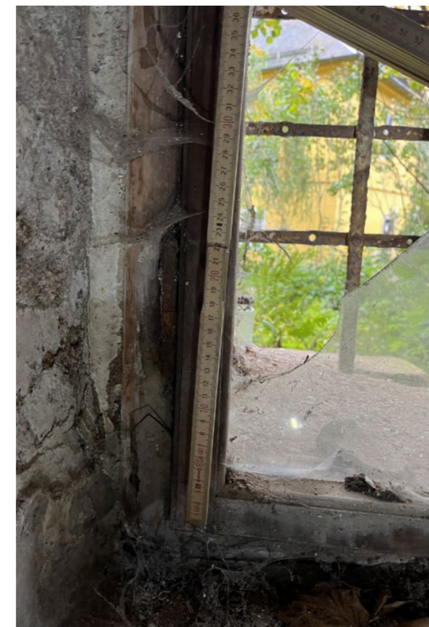
detail dřevěného rámu nadpraží detail vytesané polodrážky ostění
