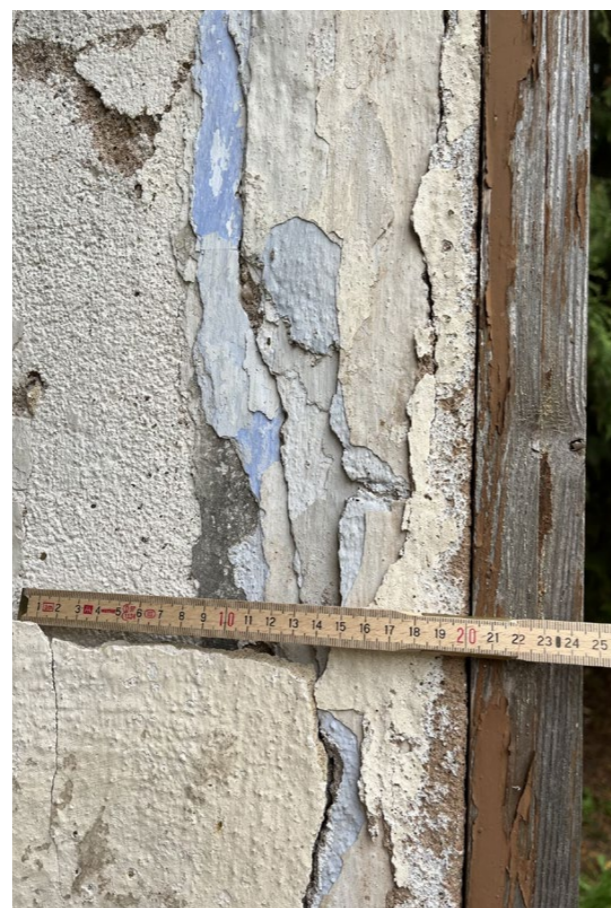
detail omítkových souvrství špalety vnitřní rovina - vnější rovina
