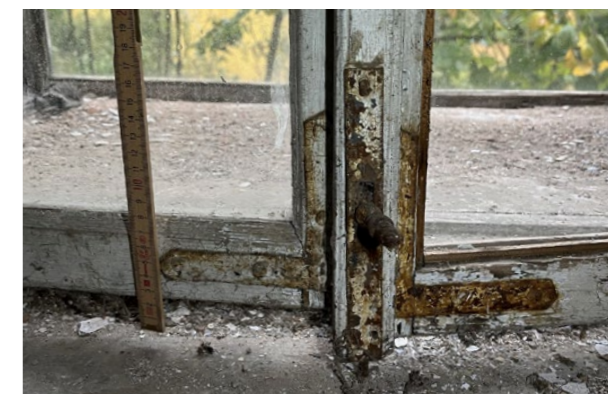
spodní zástrč, úhelníky okenního křídla vnitřní rovina
