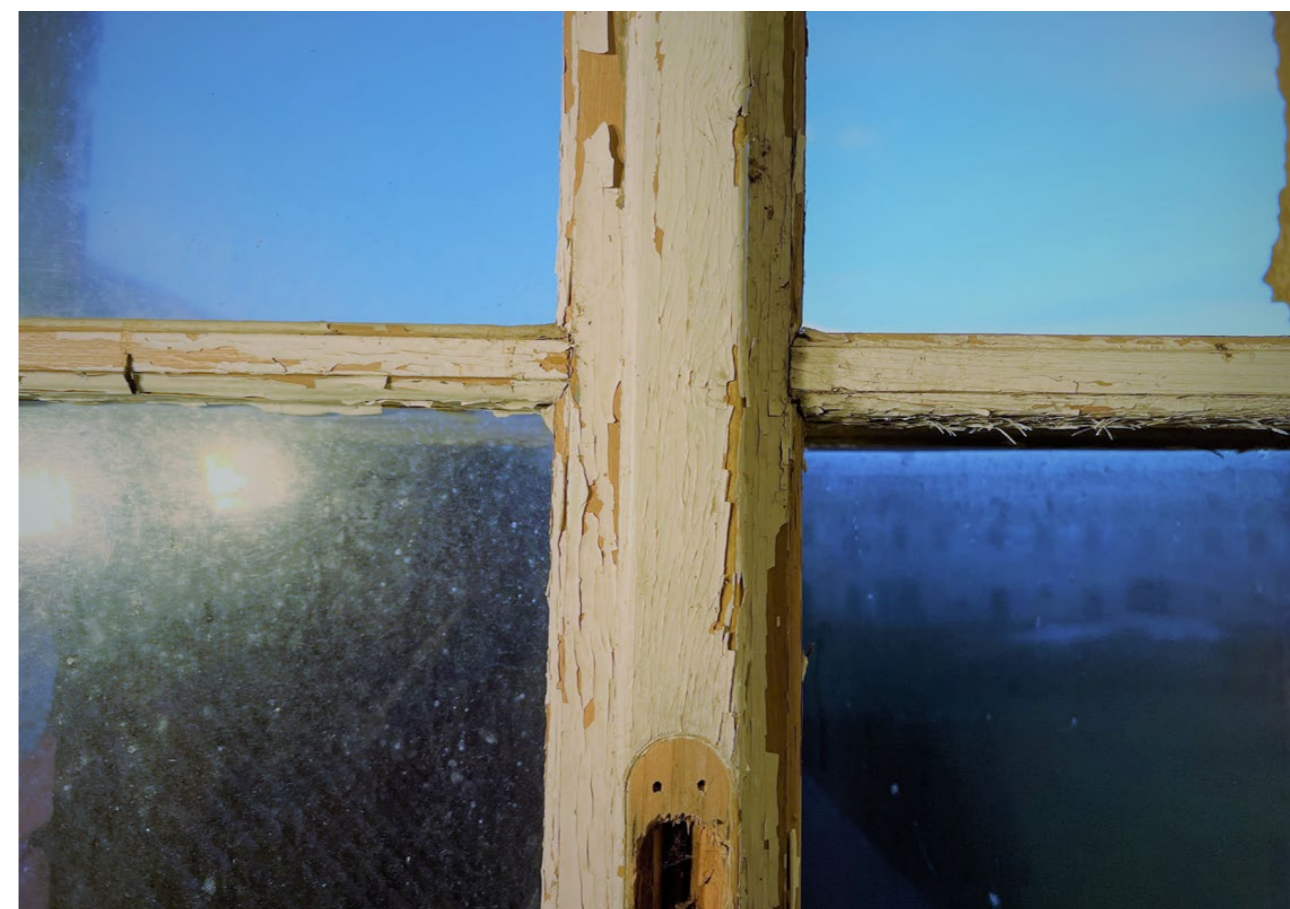
detail profilace okenních křídel, část otisku po nedochovaném štítku rozvory elegant vnitřní rovina
