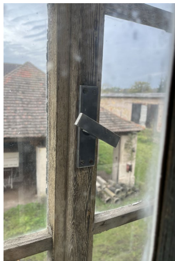
hrnatá hliníková rozvora vnější rovina, pohled z interiéru
