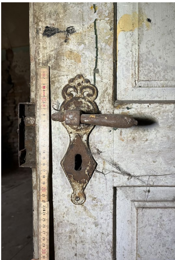
detail kliky se štítkem, líc dveří jižní levé křídlo
