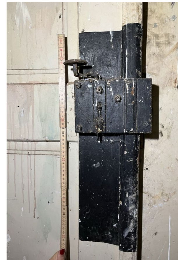
detail krabicového zámku rub dveří, místnost 1.3
