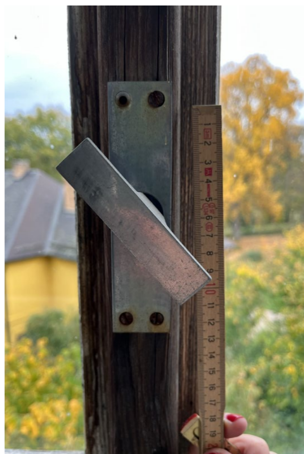
detail hliníkové rozvory lícová strana, vnější rovina
