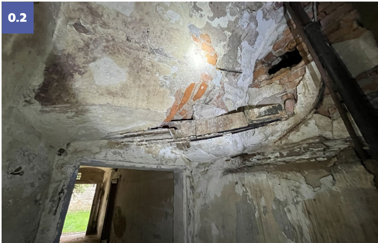
kuchyň: pohled na bývalé vedení kouřového tahu ze světnice 0.4 do komína
