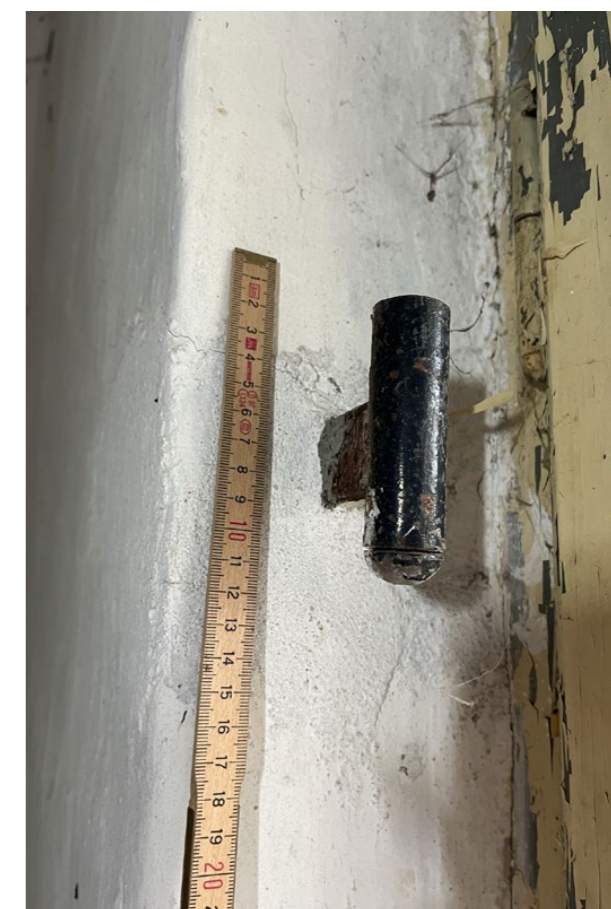
trny po mříži jižní ostění, vnitřní rovina
