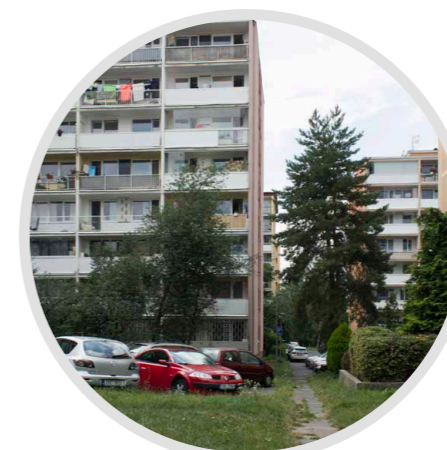
PANELOVÉ DOMY MEZI MASARYKOVÝM NÁMĚSTÍM A NÁDRAŽÍM
