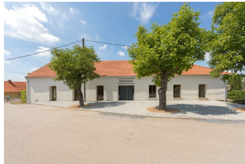
Vojtěch Sosna: Rekonstrukce bývalé hospody se sálem v Máslovicích 2018 (AKX)
