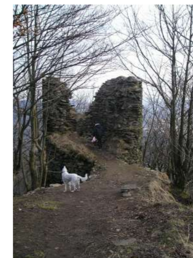
foto torza věže (2009)
