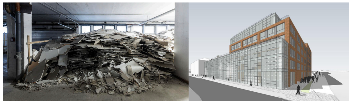
Obr. 80-81: Recyklovaný sádrokarton z projektu Skanska Mercury
