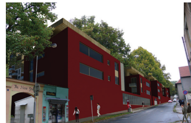
OBYTNÝ KOMPLEX_DOLNÍ ROZTOKY studie: 2009 plocha: 11 500 m 2 autor: luis marques, robert hofman vizualizace: hmarchitekti
