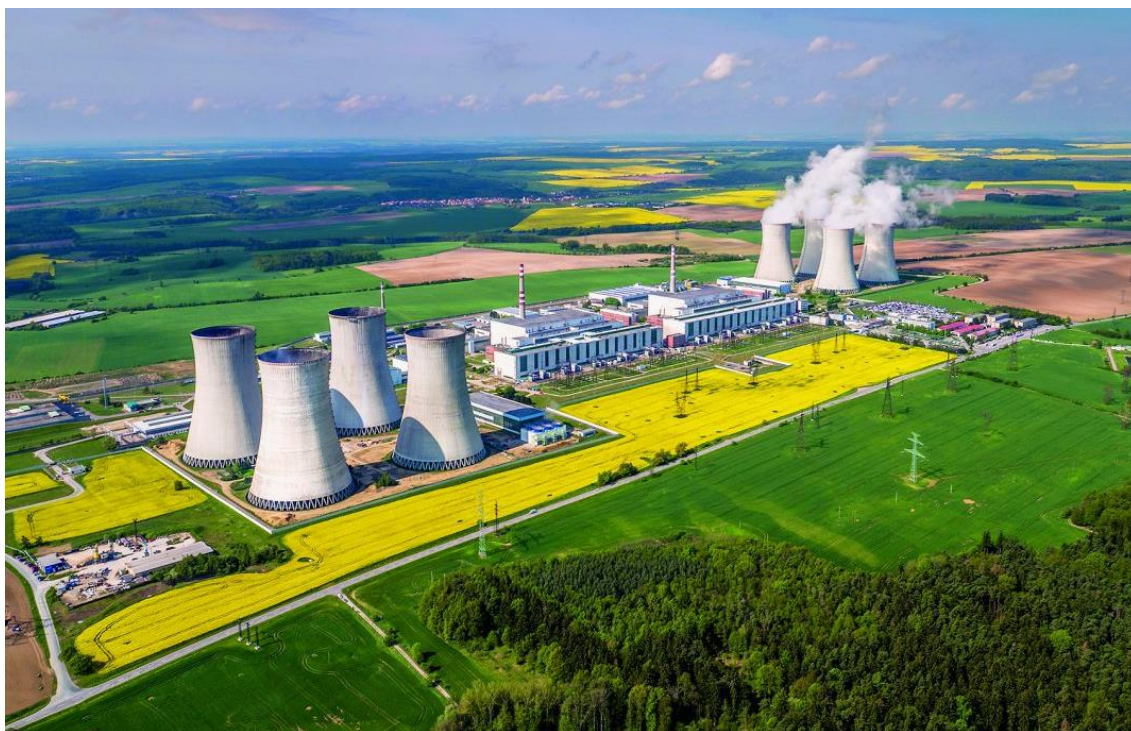
Obrázek 4: Jaderná elektrárna Dukovany [21]
