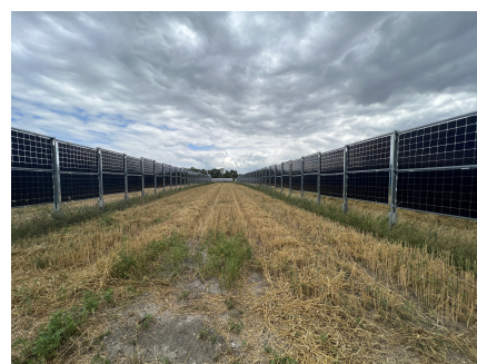
■ Obrázek 1.7 Vertikální konstrukce. Foto: Ing. Jiří Bím
