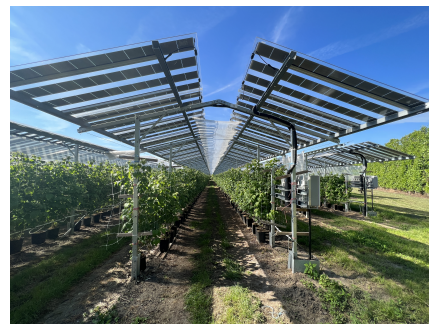
■ Obrázek 1.5 Konstrukce připomínající střechu. Foto: Ing. Jiří Bím
