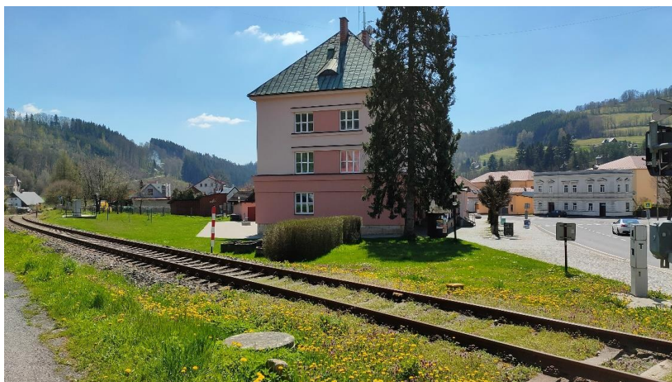
Obrázek 85 – Místo prověřované zastávky Jablonec nad Jizerou náměstí V budově za kolejištěm sídlí městský úřad, ale také pošta nebo obchody. Od ní vpravo se poté nachází zmíněná stejnojmenná autobusová zastávka.
