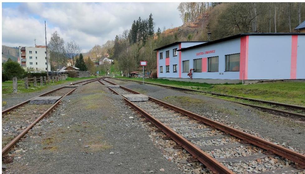
Obrázek 63 – Prostor čela nového poloostrovního nástupiště Centrální přechod bude umístěn přibližně v místech stávajícího přechodu.
