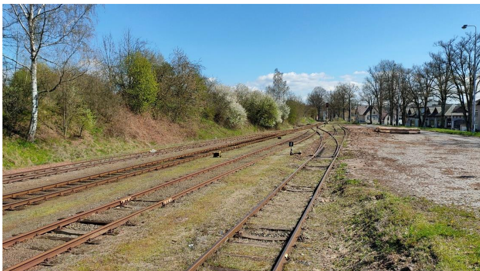
Obrázek 50 – Část stanice Jilemnice určená k přestavbě
