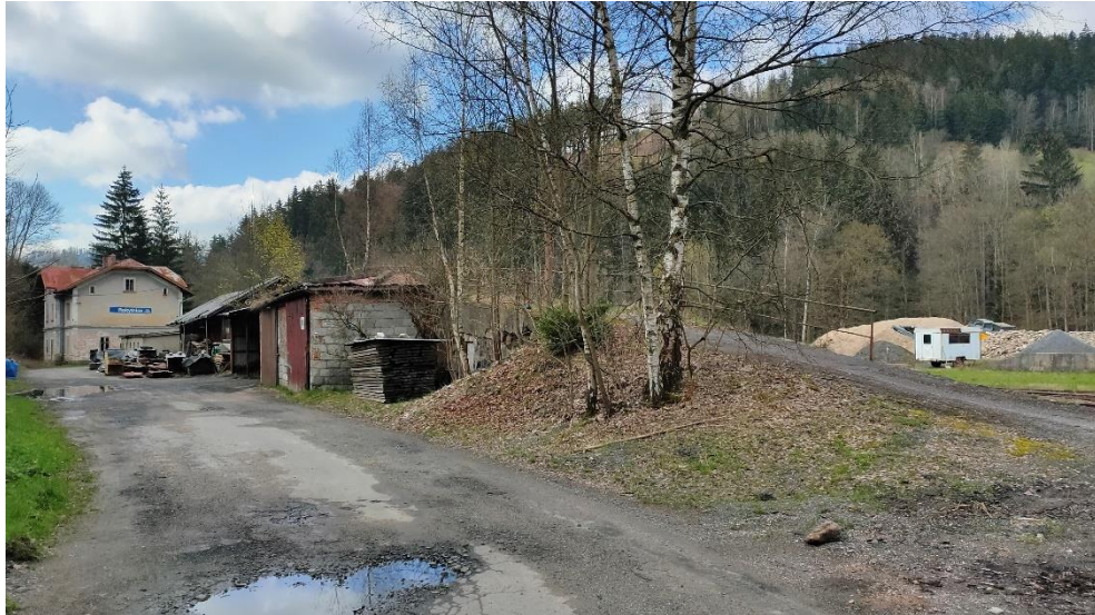
Obrázek 69 – Objekt bývalých skladovacích prostor určený k demolici Na jeho místě bude vystavěna točna pro autobusy a nákladní automobily
