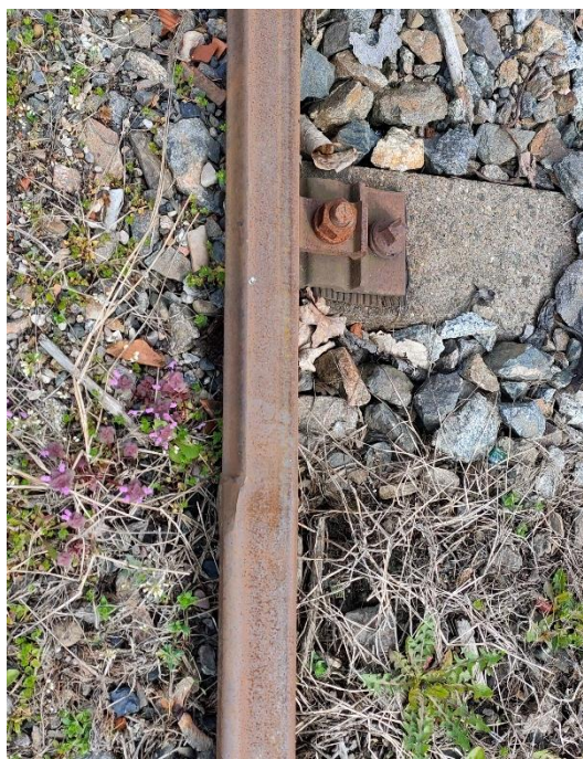
Obrázek 2 – Mechanické vady kolejnic
