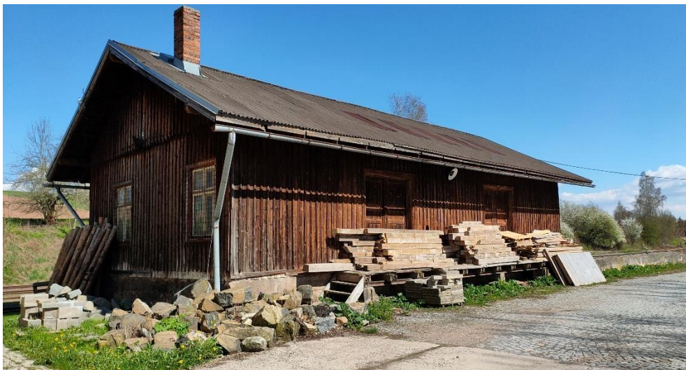
Obrázek 90 – Nevyužívané skladiště ve stanici Jilemnice
