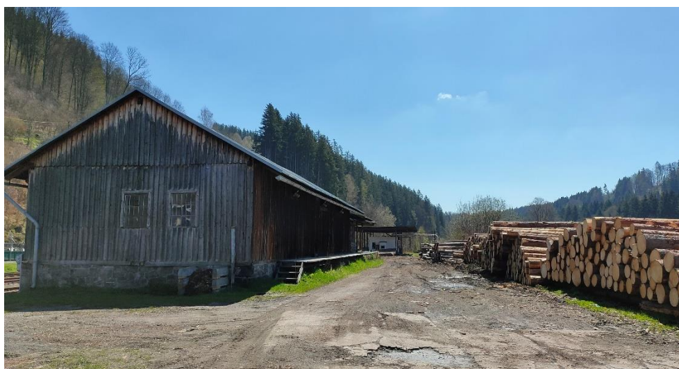
Obrázek 23 – Dřevo určené k naložce složené v dopravě Jablonec nad Jizerou
