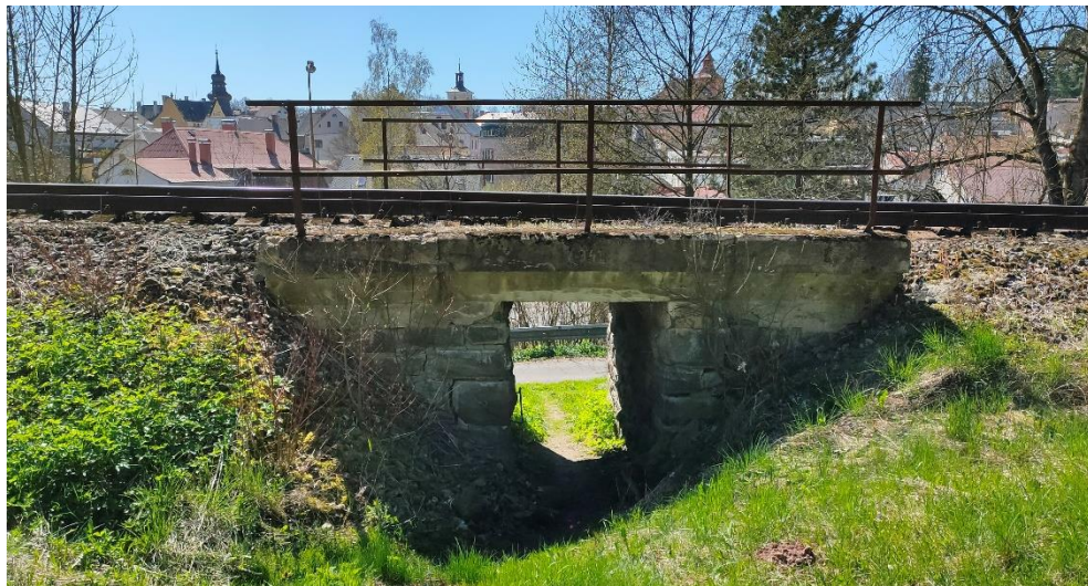
Obrázek 77 – Propustek v km 4,317 V pozadí centrum Jilemnice, viditelná je zprava věž kostela sv. Vavřince, věž radnice a věž bývalé spořitelny.
