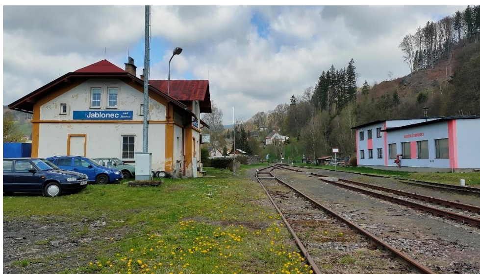
Obrázek 17 – Dopravna D3 Jablonec nad Jizerou, část sloužící osobní přepravě Lze si povšimnout, že skutečná délka konstrukce obou nástupišť je kratší než udávané hodnoty.
