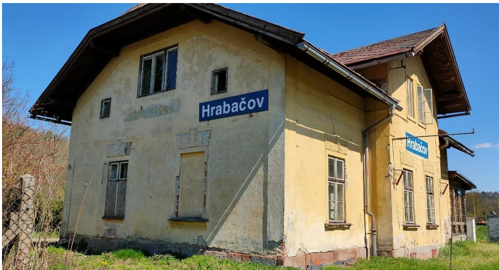
Obrázek 89 – Výpravní budova stanice Hraňčov
