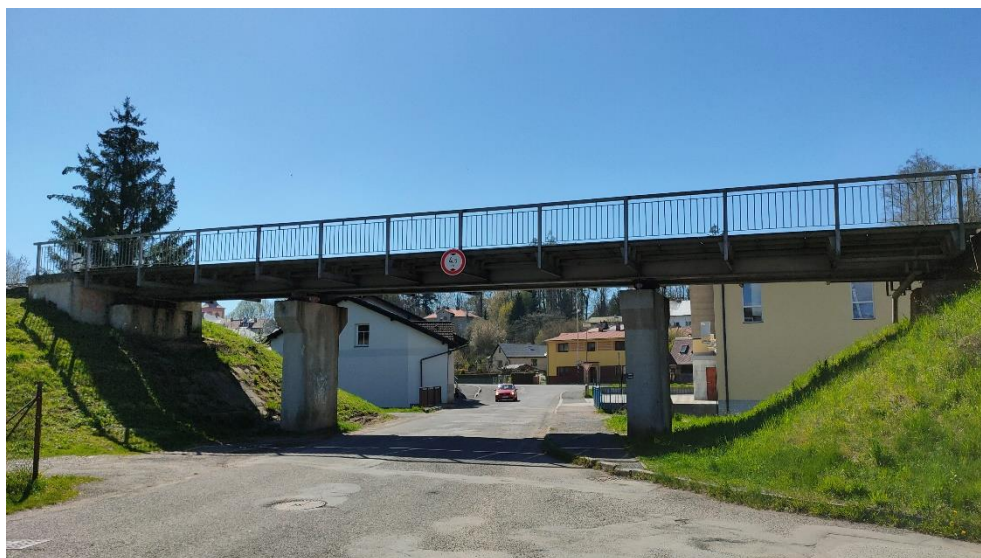
Obrázek 91 – Ocelový most přes ulici Do Žlábků v Jilemnici
