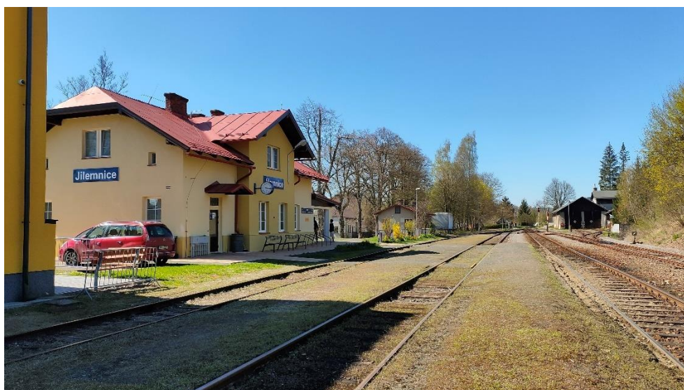
Obrázek 9 – Severní část stanice Jilemnice
