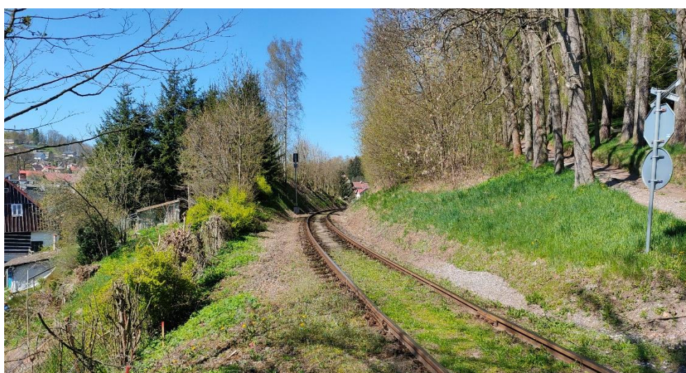
Obrázek 41 – Složený směrový oblouk v úseku Jilemnice – Hrabačov Přibližně v těchto místech dochází ke změně poloměru složeného oblouku, v pozadí je viditelná předvěst vjezdového návěstidla stanice Jilemnice
