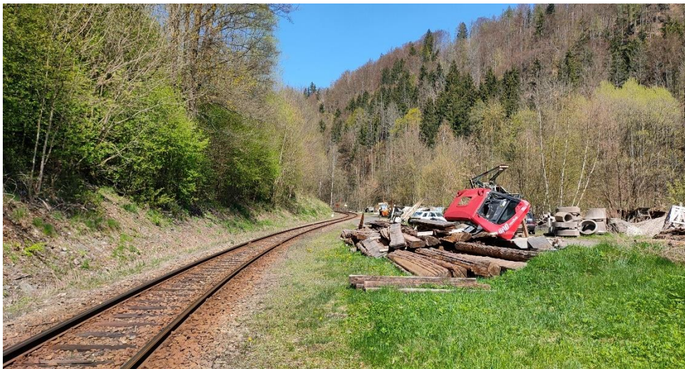
Obrázek 43 – Vedení trati v prostoru u zastávky Horní Sytová
