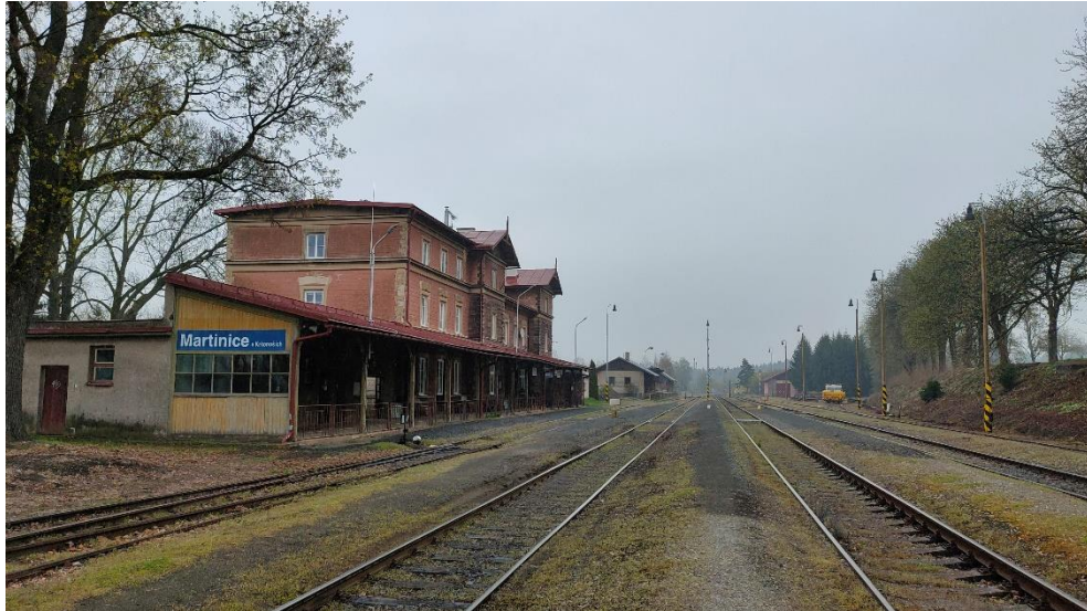
Obrázek 7 – Celkový pohled na stanici Martinice v Krkonoších Osobní vlaky od Jilemnice zastavují při pohledu zleva na druhé koleji.
