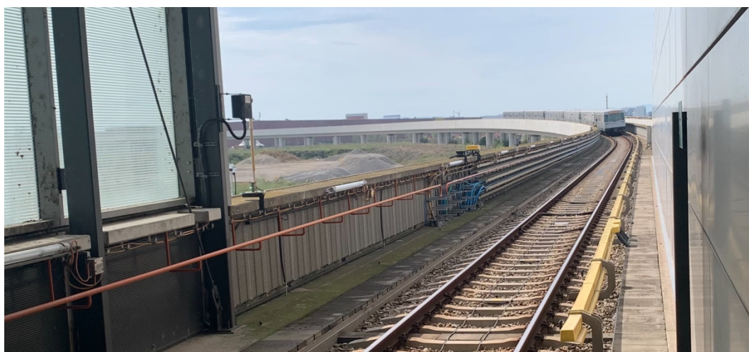
Obrázek 11 - Estakáda u stanice Hausfeldstraße vídeňské linky U2.
