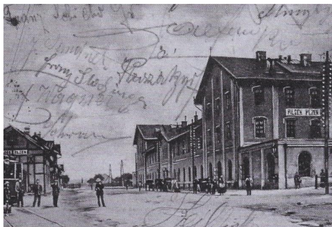
Obrázek 15 – Původní nádražní budova v Plzni
