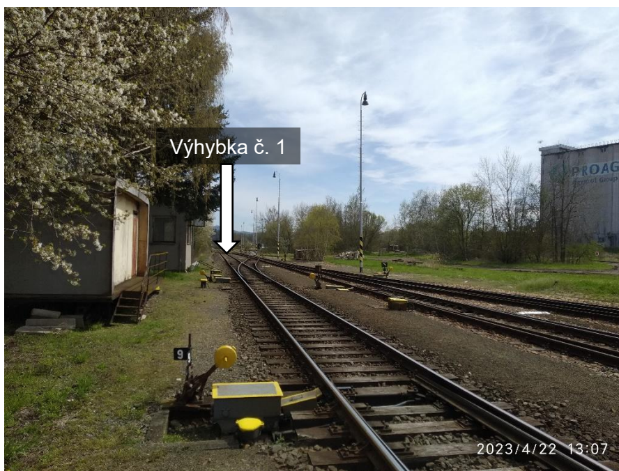
Obrázek 28 – Plzeňské/klatovské zhlaví (foceno proti směru staničení)
