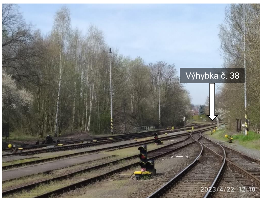
Obrázek 27 – Českokubické zhlaví (foceno ve směru staničení)
