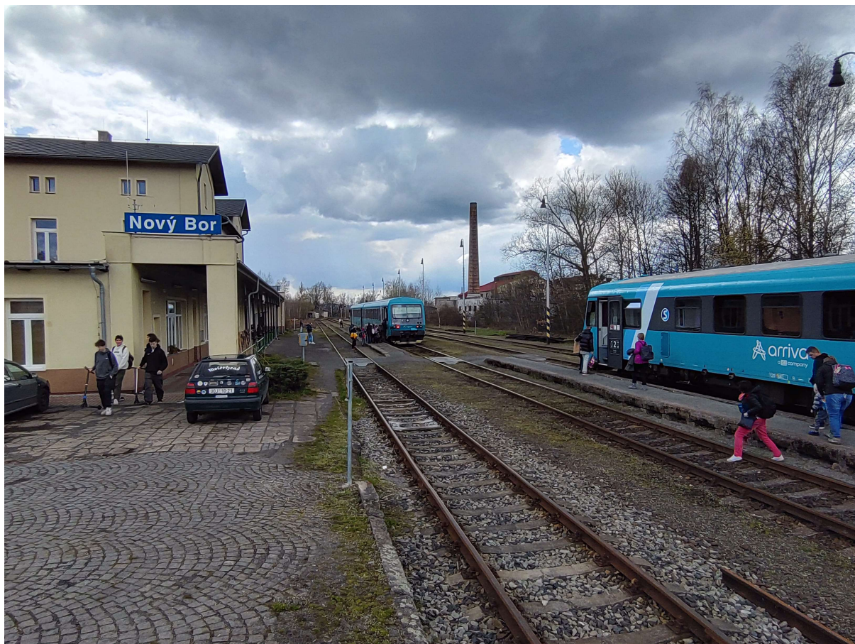
Obrázek 24: Celkový pohled na kolejiště žst. Nový Bor
