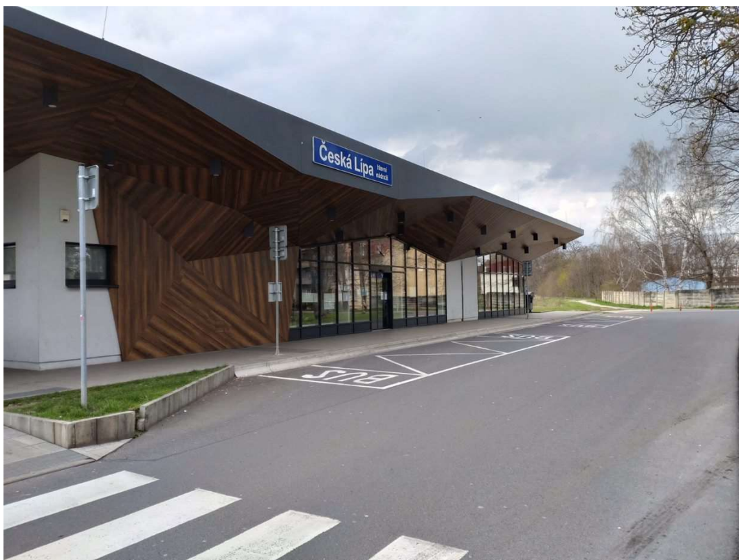
Obrázek 8: Stanoviště autobusů před výpravní budovou zst. Česká Lípa hlavní nádraží
