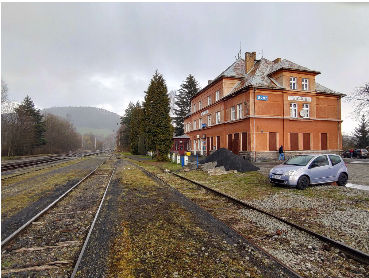
Obrázek 25: Kolejiště a výpravní budova žst. Svoboda nad Teplou
