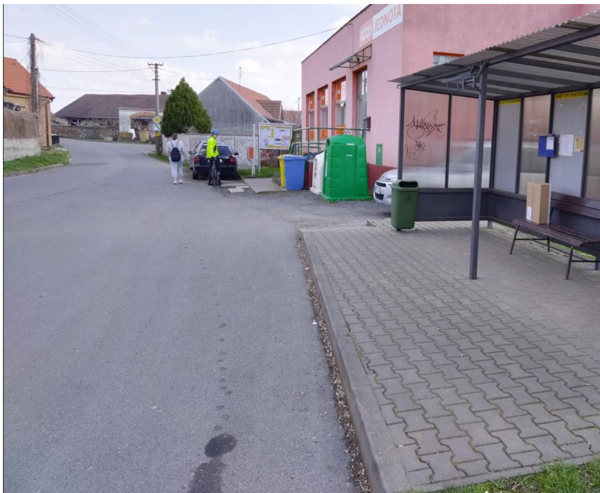
Obrázek 46: Zastávka Veltruby, Hradištko I směr Kolín s chybějícím označníkem, která kromě standardů PID neodpovídá ani normě ČSN 73 6425-1, zdroj: vlastní fotografie
