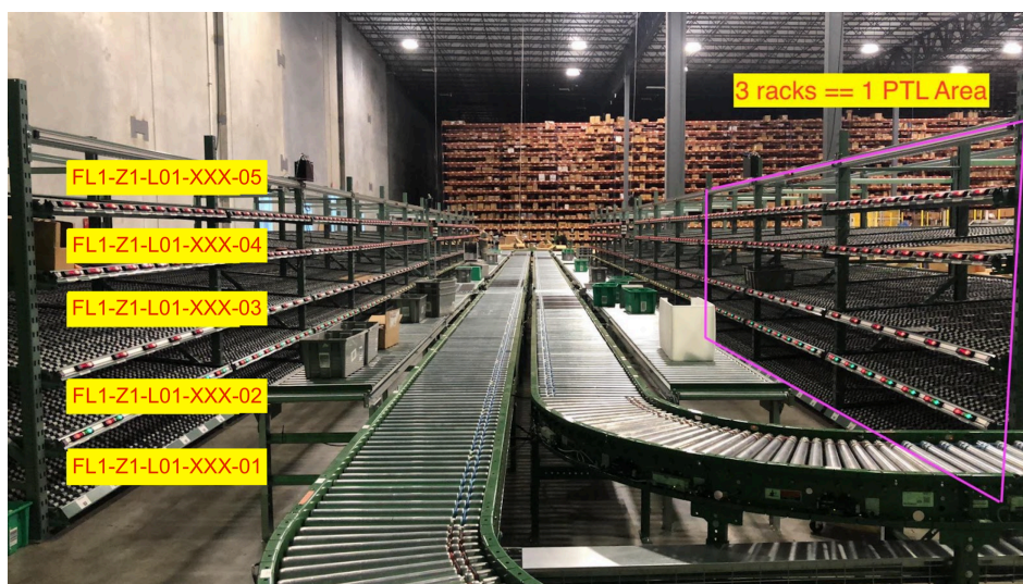
■ Obrázek 4.8 Ukázka PTL instalace v jednom ze skladů zadavatele
