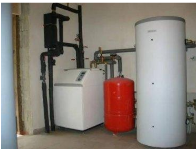
Obrázek 9: Tepelné čerpadlo země/voda
