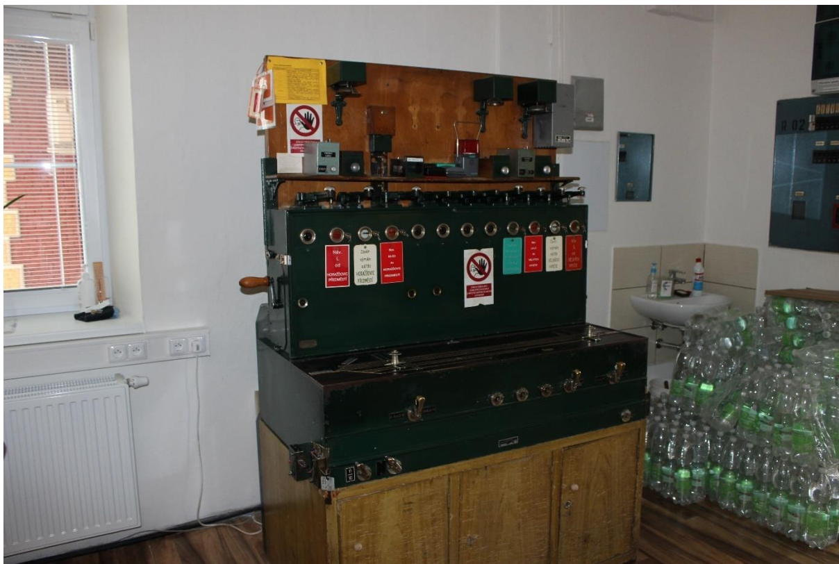
Obrázek 23: Řídící přístroj v ŽST Horaždovice
