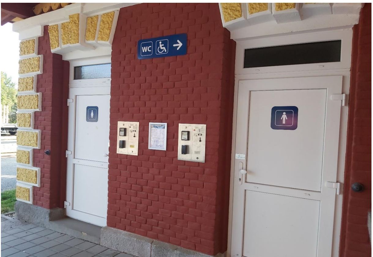
Obrázek 14: Vchody do sociálních zařízení pro cestující v ŽST Sušice
