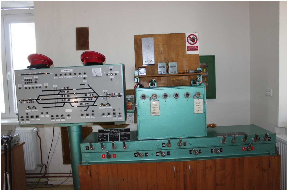
Obrázek 30: Ústřední přístroj ŽST Sušice
