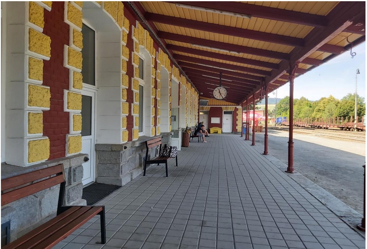
Obrázek 13: Prostor výpravní budovy ŽST Sušice
