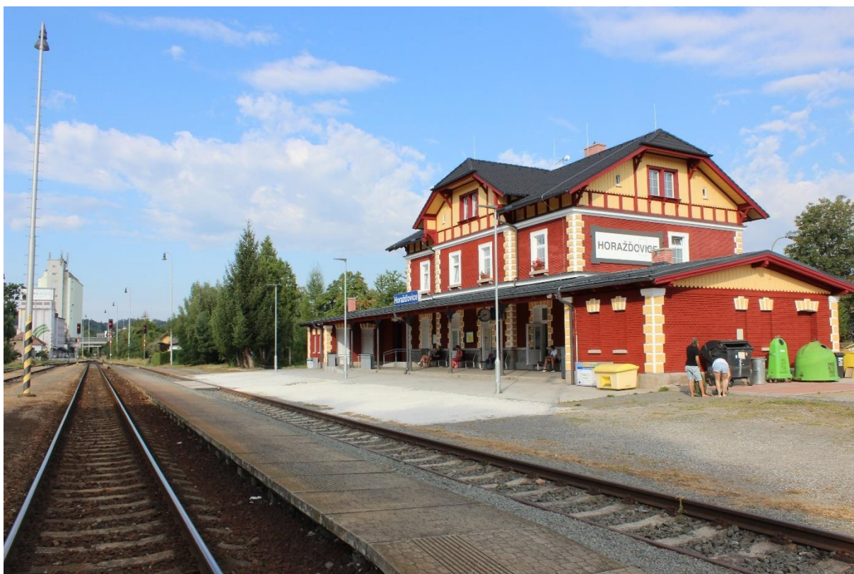
Obrázek 22: Pohled z nástupiště na výpravní budovu v ŽST Horažďovice
