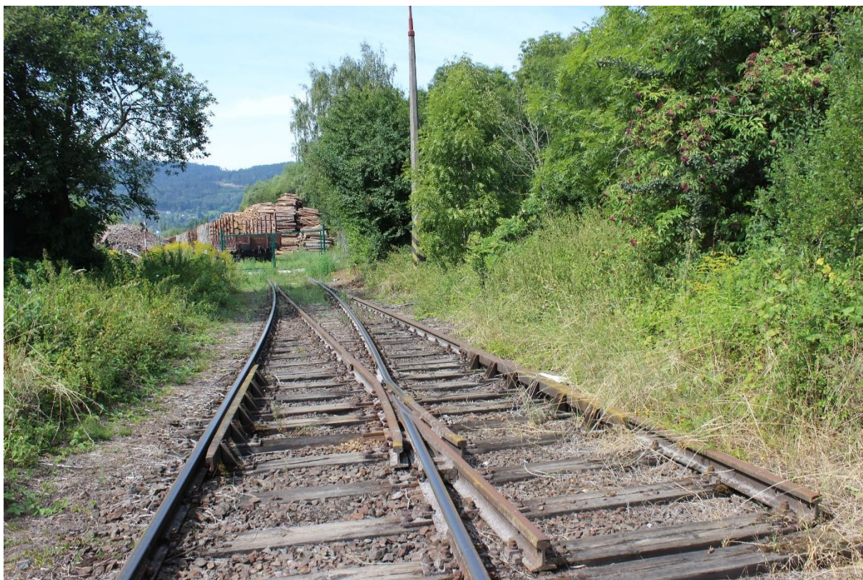
Obrázek 38: Vlečka Jihozápadní dřevařská Sušice – pohled na oplocenou část
