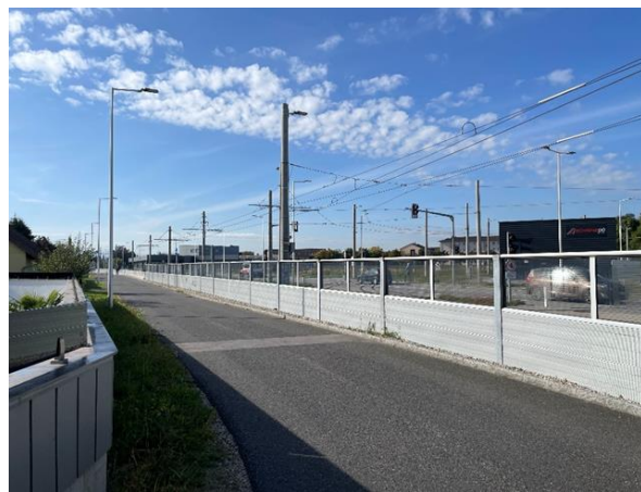
Obrázek 58 Příklad užití nízkých protihlukových stěn na tramvajové trati v Traunu (foto: autor, říjen 2022)
