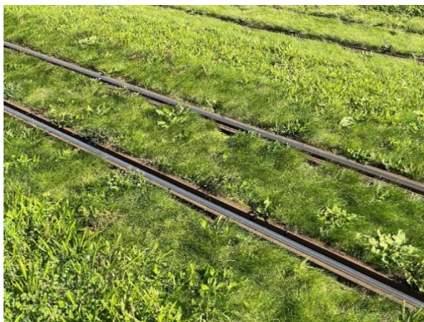
Obrázek 57 Příklad využití bokovnice a zatravněné svršku na tramvajové trati z Lince do Traunu (foto: autor, říjen 2022)
