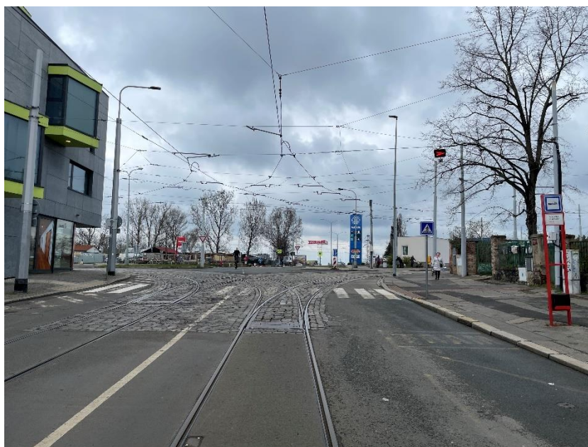
Obrázek 59 Kolejový trojúhelník poblíž zastávky Vozovna Kobylisy. Koleje vlevo směřují do tramvajové vozovny, vpravo do obratiště. Tramvajová trať do Zdib bude vedena přímo. (foto: autor, březen 2023)
