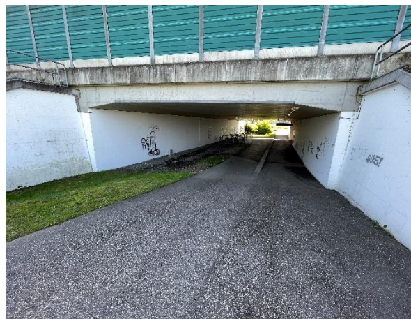
Obrázek 36 Prostor budoucí zastávky pod železniční tratí jako součást přestupního bodu Linz Pichling (foto: autor, říjen 2022)
