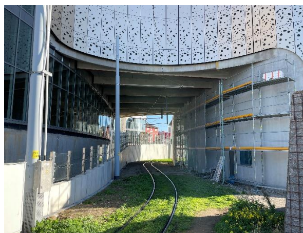
Obrázek 42 (vpravo) Umístění tramvajové smyčky v prostoru pod budovou nákupního centra (foto: autor, říjen 2022)
