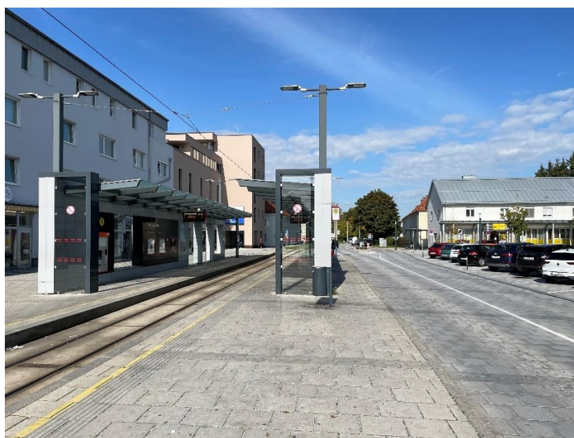
Obrázek 25 Zastávka na náměstí v Traunu umožňující přestup „hrana – hrana“ mezi tramvajovou a autobusovou dopravou. (foto: autor, říjen 2022)
