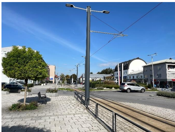
Obrázek 26 Jednokolejný úsek tramvajové trať v centru Traunu (foto: autor, říjen 2022)
