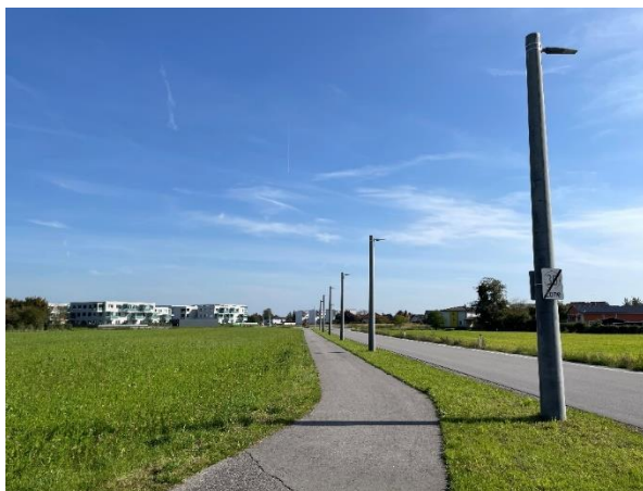
Obrázek 31 (vlevo) Pohled na budoucí trasu tramvajové tratě s již instalovanými sloupy trakčního vedení na jedné straně (foto: autor, říjen 2022)
