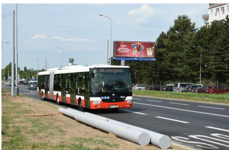
Obrázek 18 Autobus linky č. 136 projíždí úsekem budoucí trolejbusové tratě (foto: Libor Hinčica, zdroj: [29])
