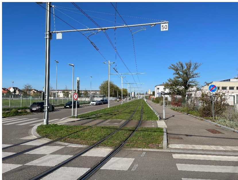
Obrázek 44 Vedení tramvajové tratě v ulici Rue Saint-Exupéry (foto: autor, říjen 2022)
