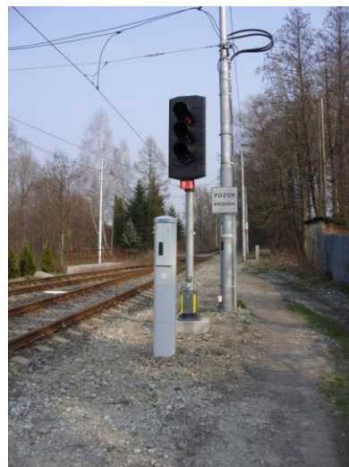
Obrázek 20 Ukázka zabezpečovacího zařízení s návěstidlem ve výhybně Vřesina (foto: autor neuveden, zdroj: [34])
