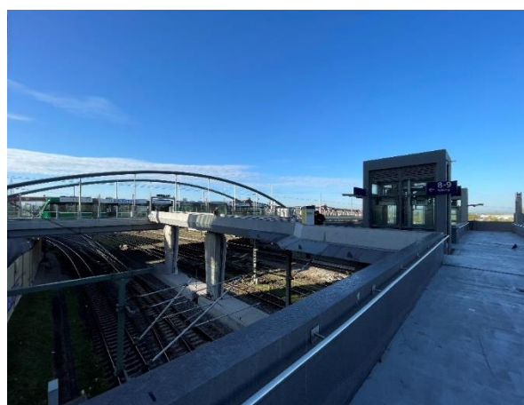
Obrázek 40 Pohled na tarifní bod včetně přístupových ramp na tramvajová nástupiště umístěná na mostě (foto: autor, říjen 2022)
