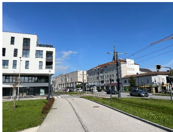
Obrázek 27 Vedení tramvajové tratě poblíž traunského zámku (foto: autor, říjen 2022)
