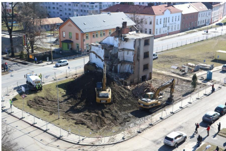
Obrázek 17 Demolice bytového domu z důvodu výstavby tramvajové tratě v Olomouci (foto: Blanka Martinovská, zdroj: [28])
