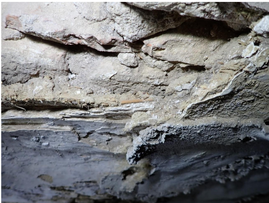
Obr. 87: Kuchyně 3. Hliněné omítky v interiéru kuchyně, pod oknem, detail.
