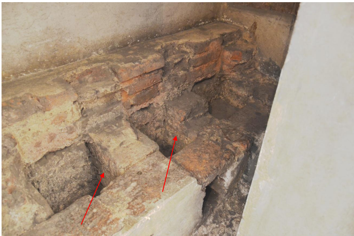
Obr. 24: NP4, topeniště. V šachtách je viditelná omítka. Šipky označují polohu roštů. Foto M. Biedermanová.
