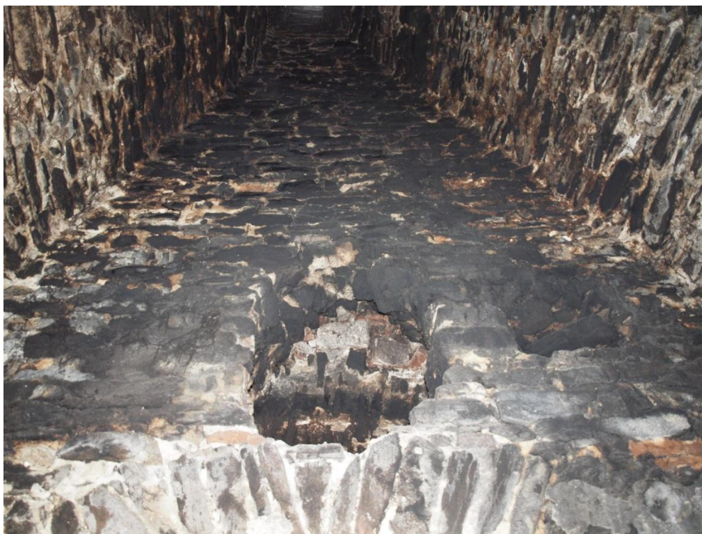
Obr. 2: Otvor ve stěně DČK pro odkouření pece.
