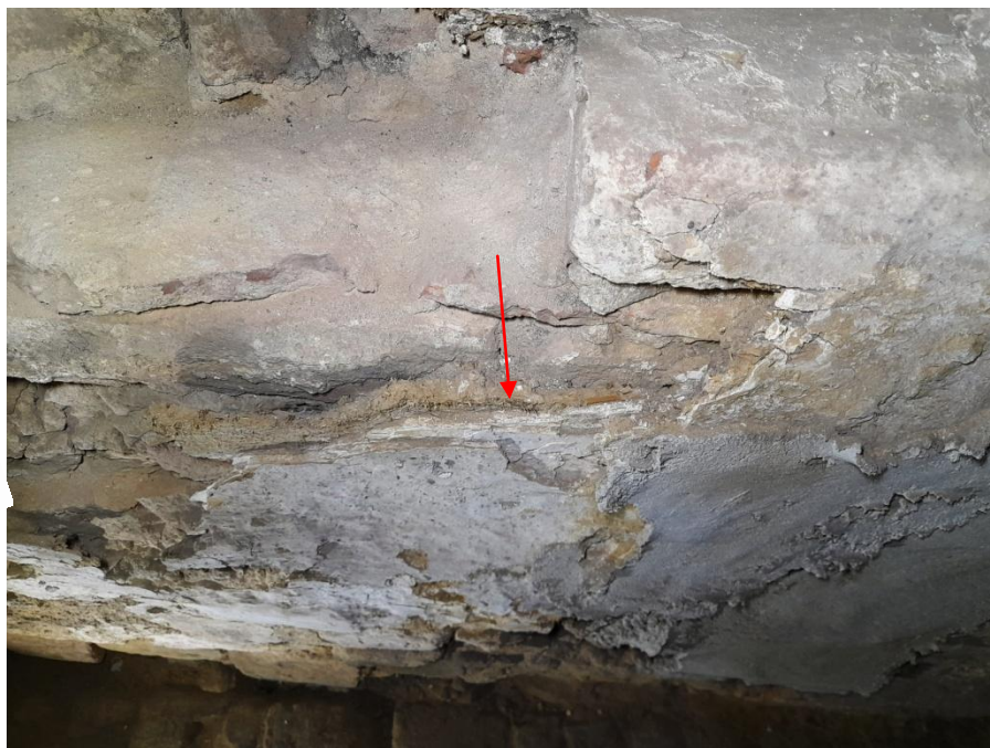
Obr. 72: Kuchyně 3. Hliněné omítky v interiéru kuchyně, na boku podesty před příkládacím otvorem do kamen.
