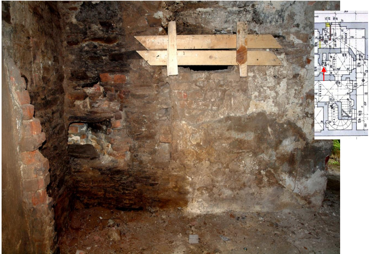
Obr. 4: Kuchyně 1, pohled do odbourané části mladšího kominového tělesa.
