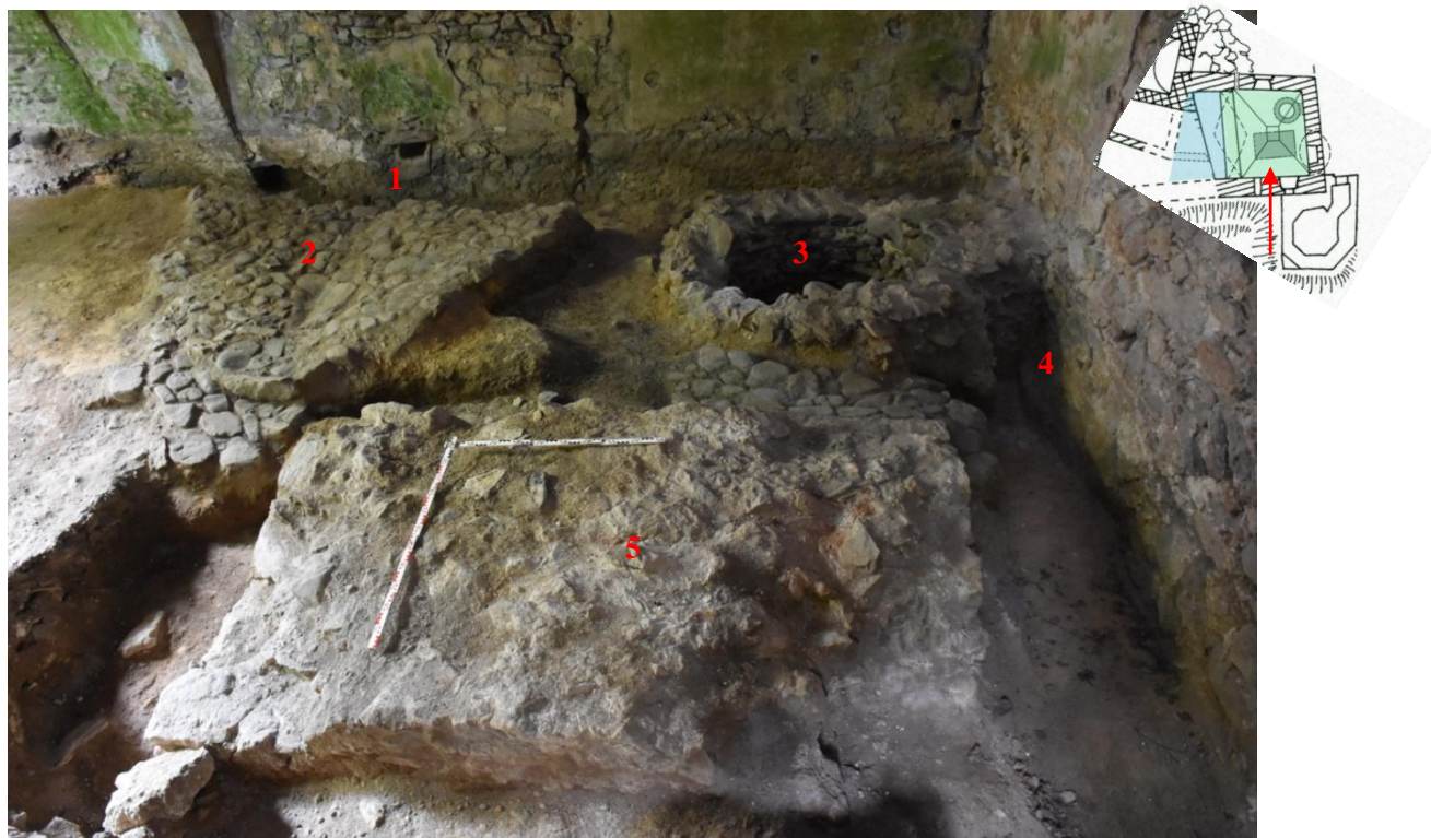
Obr. 24: Interiér kuchyně, foto F. Kolář 23/7 2018. 1 - výlevka, 2 - snížení dlažby směřující k výlevce, 3 - studna, 4 - "krček", 5 - podesta.
