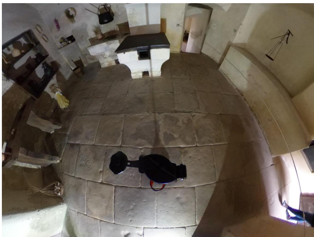
Obr. 21: Kuchyně 1. Dlažba v místnosti č. 17. Výřez ze snímku sférické foto-kamery.
