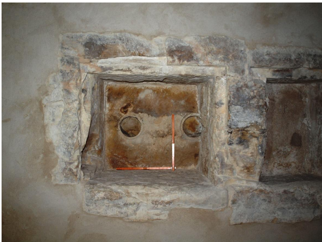
Obr. 9: Blok s výdechy teplotvzdušného vytápění druhotně použitý v zadní stěně západní niky.
