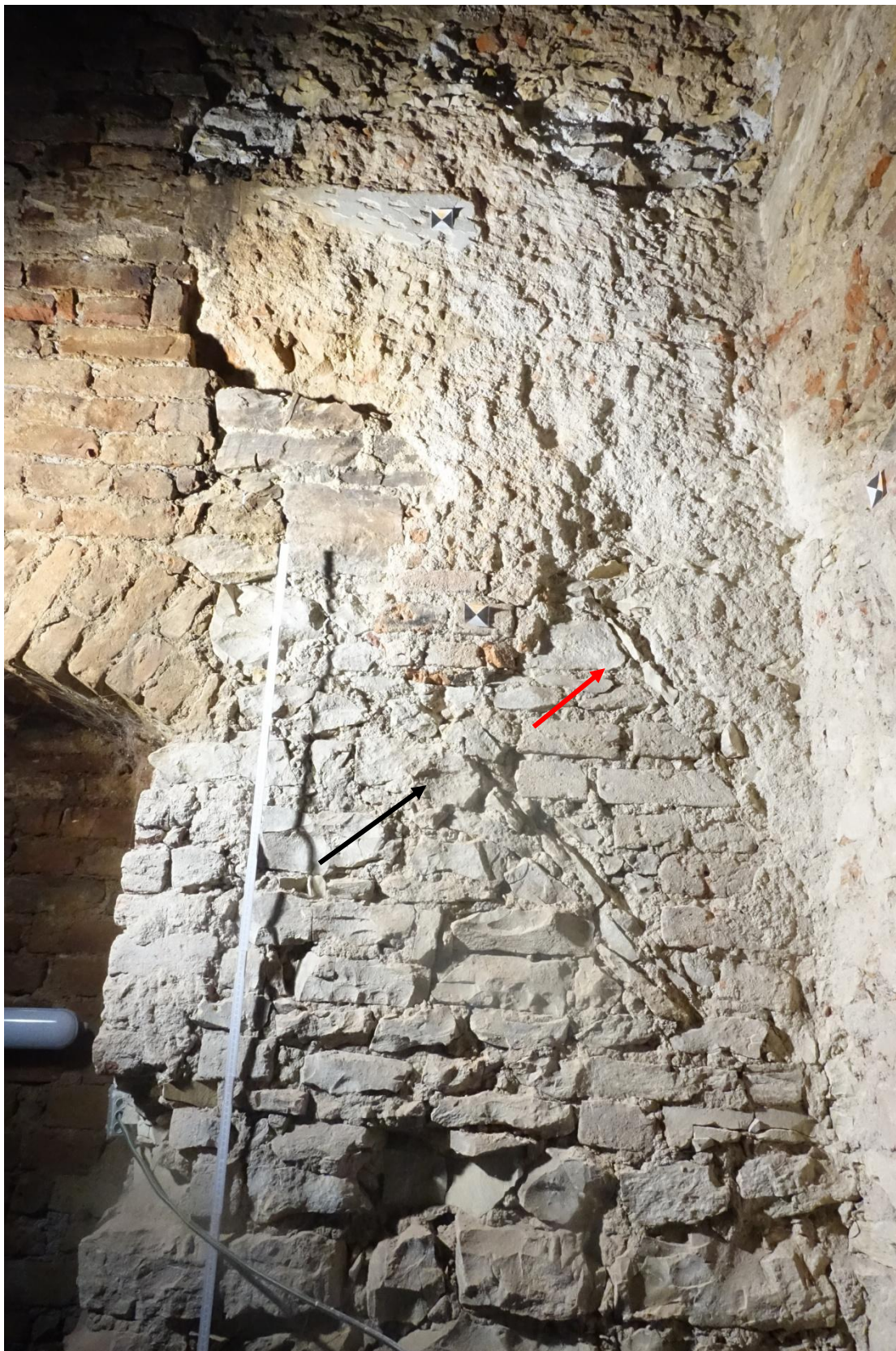
Obr. 4: SV kout kuchyně. Černá šipka označuje první, neúspěšné založení klenbičky, červená šipka ukazuje na založení klenbičky, které bylo posunuté do správné výše.
