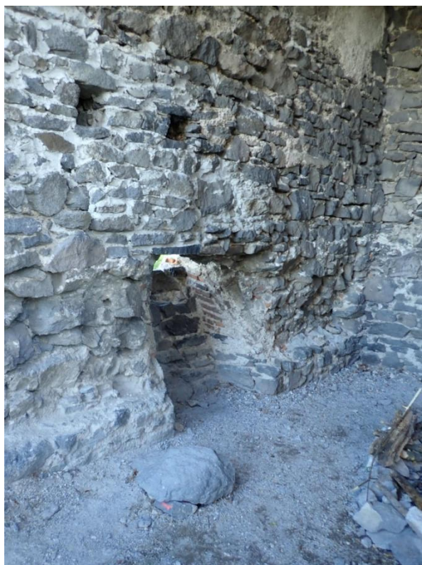
Obr. 13: Větrací okno sklepa pod kuchyní.
