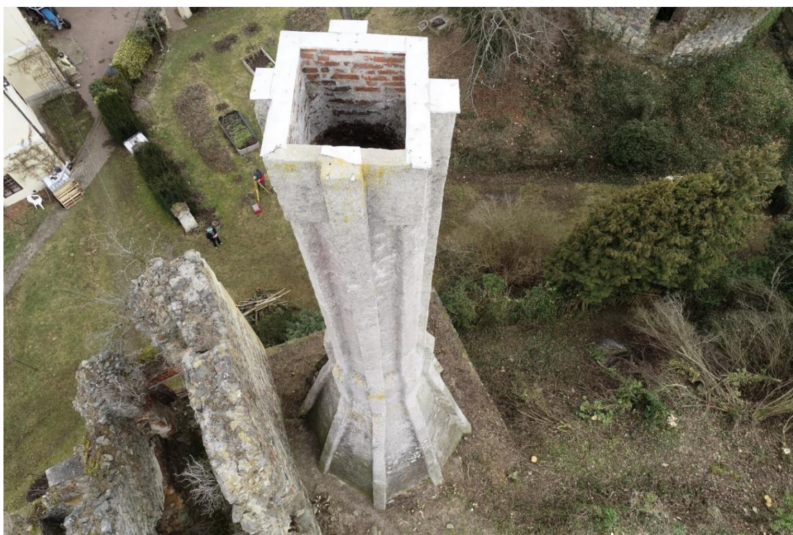
Obr. 16: Ústí komína, dnešní stav. Světlé, neočazené cihly pochází z poslední opravy komína. Foto J. Železný.
