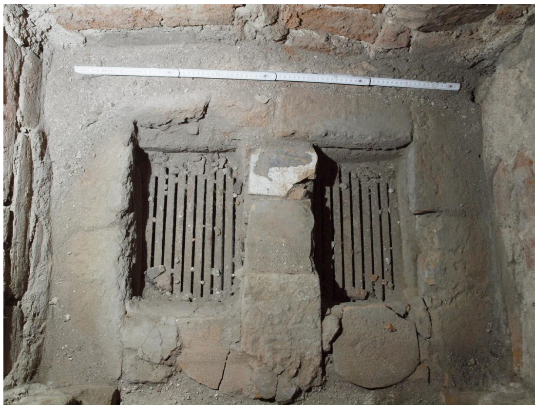
Obr. 21: Konstrukce se šachtovými topeništi, šachty s rošty.
