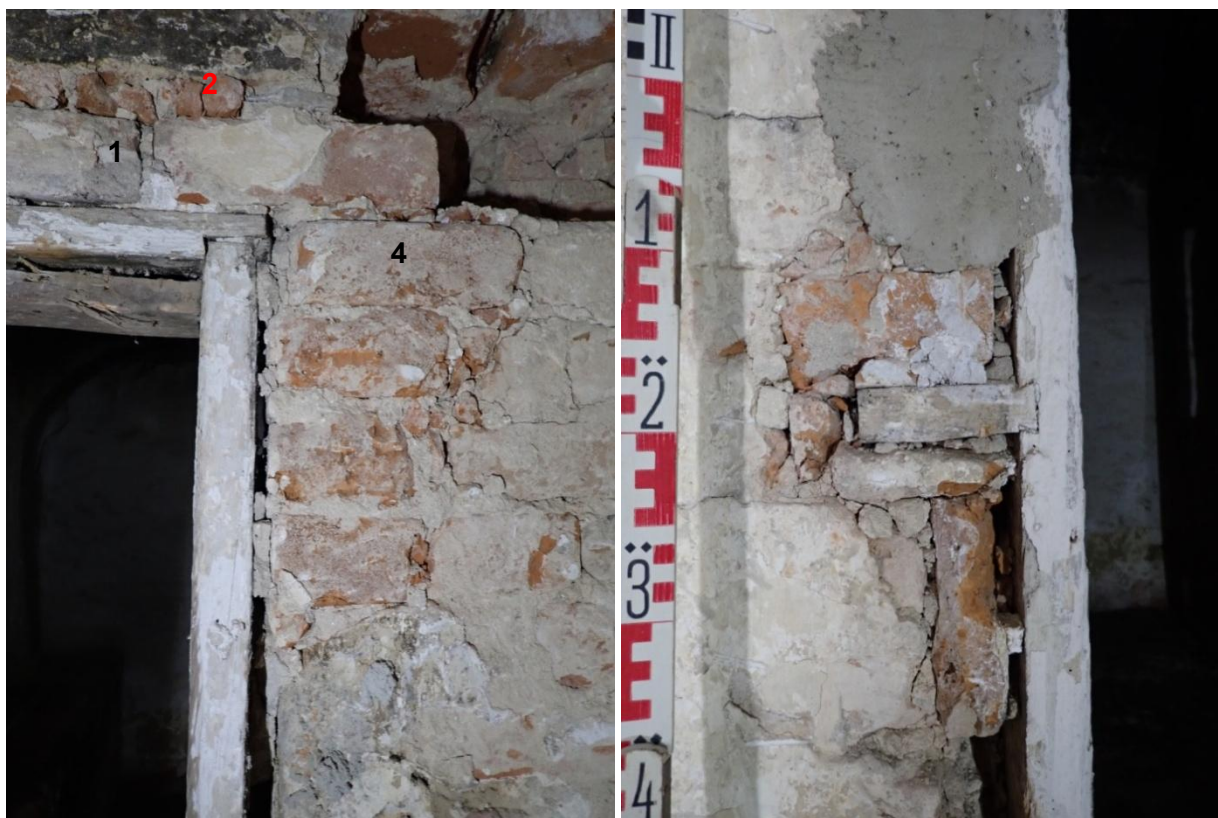
Obr. 57: Kuchyně 3. Způsob uchycení veřejí do zdi. Vpravo je viditelná špaleta starších dveří s nátěry.
