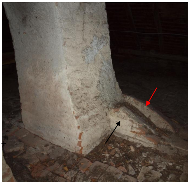
Obr. 128: Prostor napojený na komín 1. Horní část jižního čela valené klenby v prostoru půdy (černá šipka). Pas na valené klenbě kuchyně (červená šipka).
