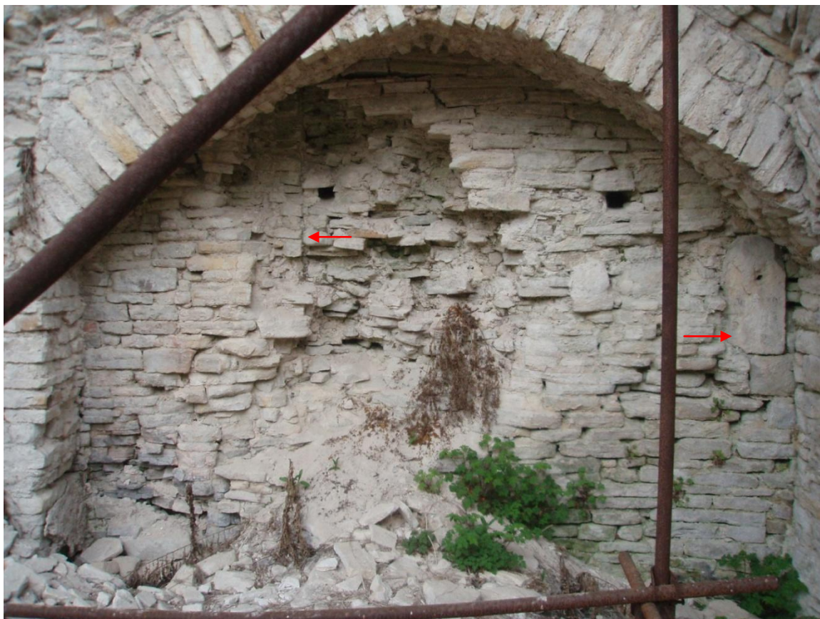
Obr. 3: Tzv. kovárna, severní hradba z interiéru kuchyně 3. Šipky označují lícový úsek zdiva a pozůstatek portálu.
