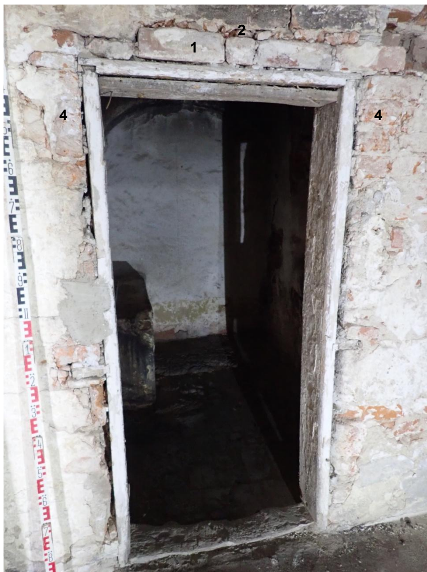
Obr.56: Kuchyně 3. Jižní stěna kuchyně, vstup, celkový záběr a detail
