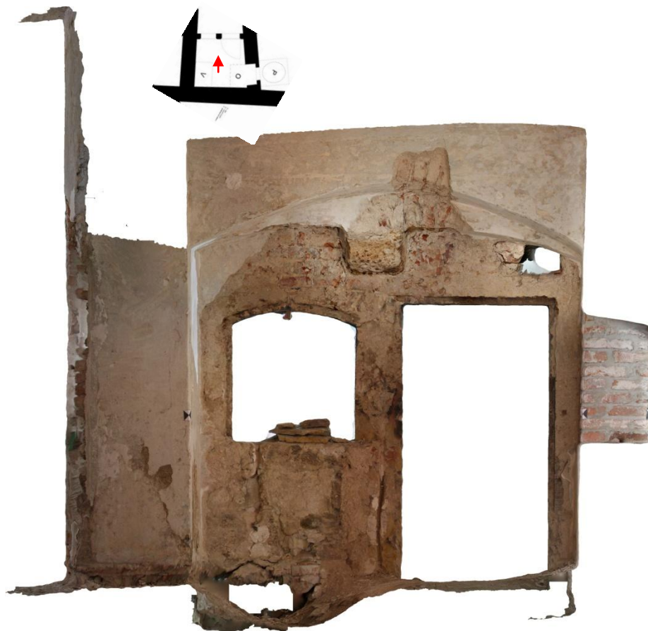
Obr. 4: Ortofoto jiho-západní stěny kuchyně 1, interiér kuchyně, Z. Poloprutský 2019.
