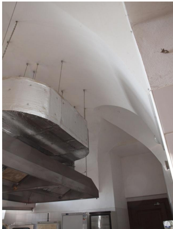
Obr. 10: Stav kuchyně v únoru 2018.
