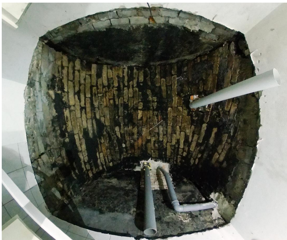
Obr. 122: Prostor napojený na komín 1. Klenba prostoru, výřez ze snímku sférické foto-kamery
