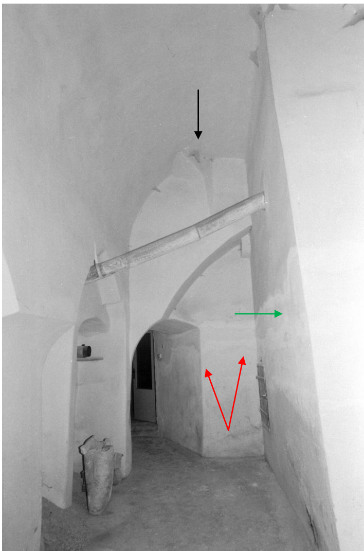
Obr. 7: Červené šipky - pas při hradbě, která tvoří nádvorní zeď kuchyně a konzola, která pas podpírá. Černá šipka - pozůstatek krakorce. Zelená šipka - pseudodýmný prostor, v němž se našlo záclonové okno. Stav 1984.
