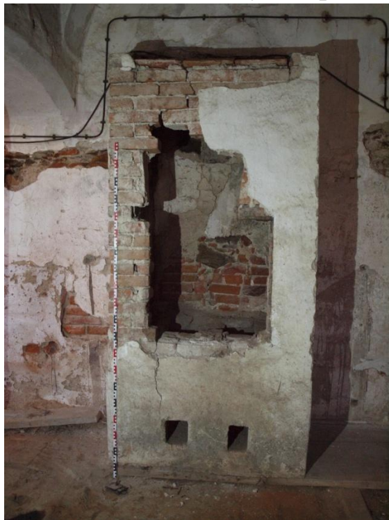
Obr. 19: Konstrukce se šachtovými topeništi, čelní pohled
