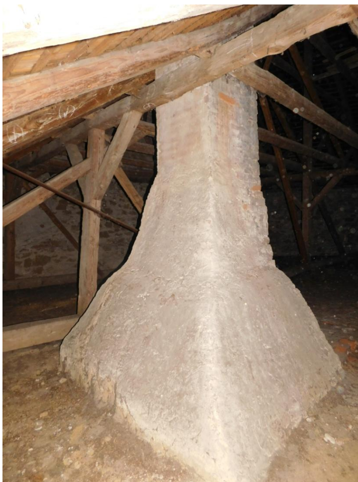
Obr. 115: DČK kuchyně 7 v podkroví. Převzato z Vrla 2020, foto č. 896, 897.
