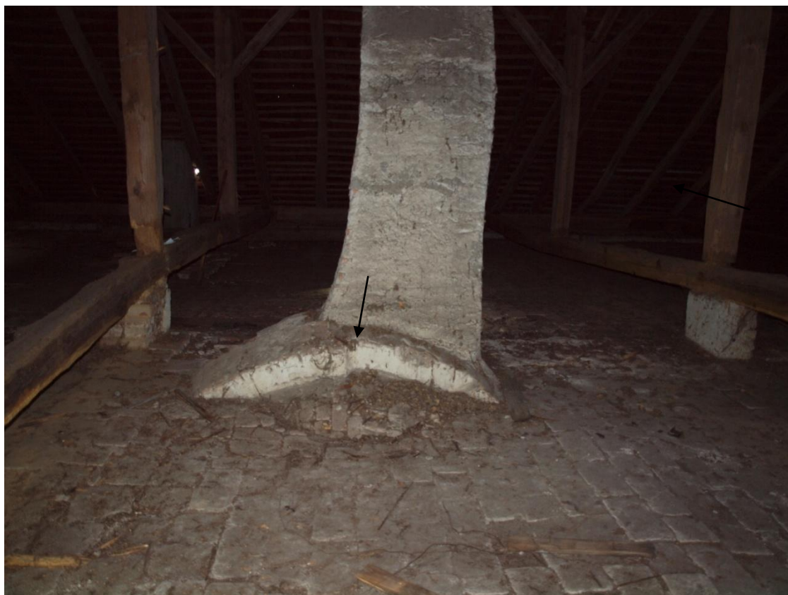
Obr. 126: Prostor napojený na komín 1. Komín a část klenby s pasem v prostoru půdy, šipka označuje posunutí pasu.
