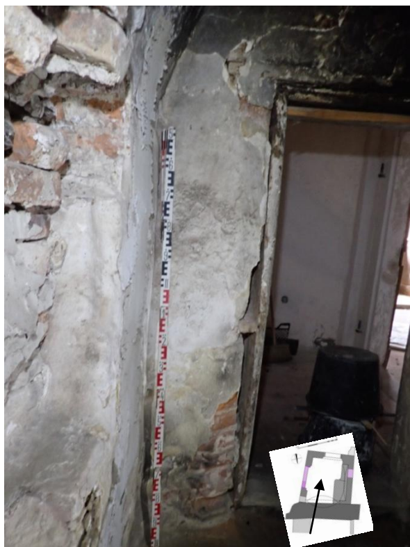
Obr. 83: Kuchyně 3. Jižní špaleta oken.
