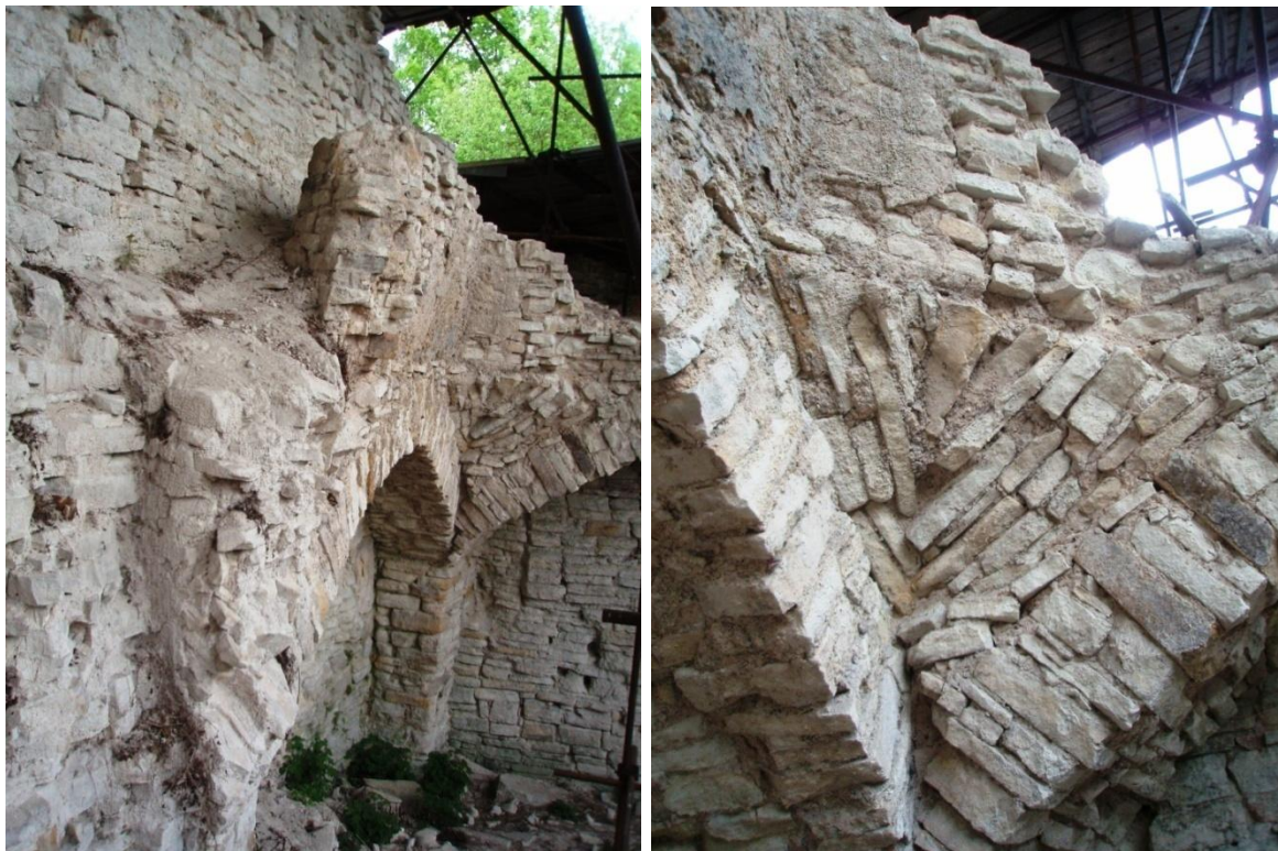
Obr. 11: Kuchyně 3, pendentiv v severovýchodním koutě kuchyně.
