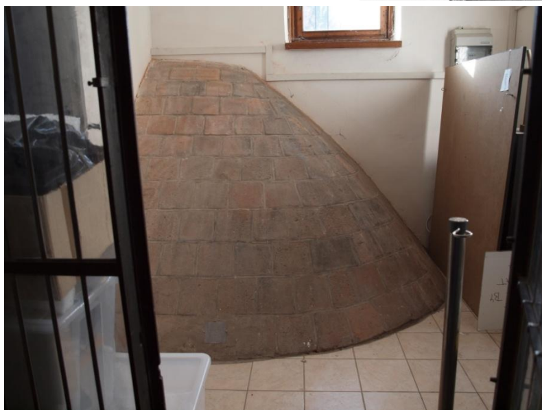
Obr. 6: Severovýchodní část rubu klenby kuchyně v patře nad kuchyní.
