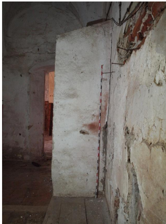
Obr. 20: Konstrukce se šachtovými topeništi, boční pohled
