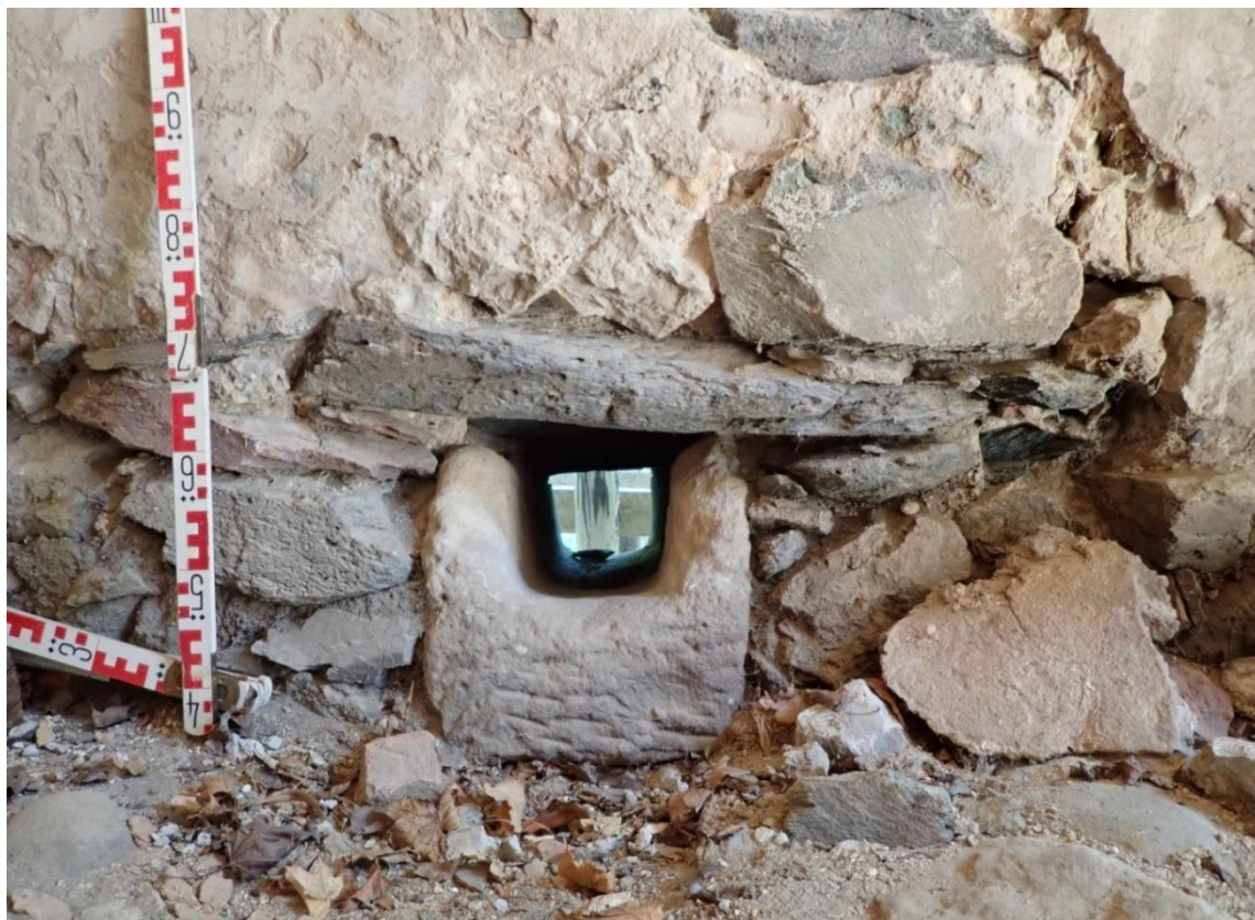
Obr. 26: Výlevka v jihovýchodní stěně, interiér kuchyně, stav květen 2022
