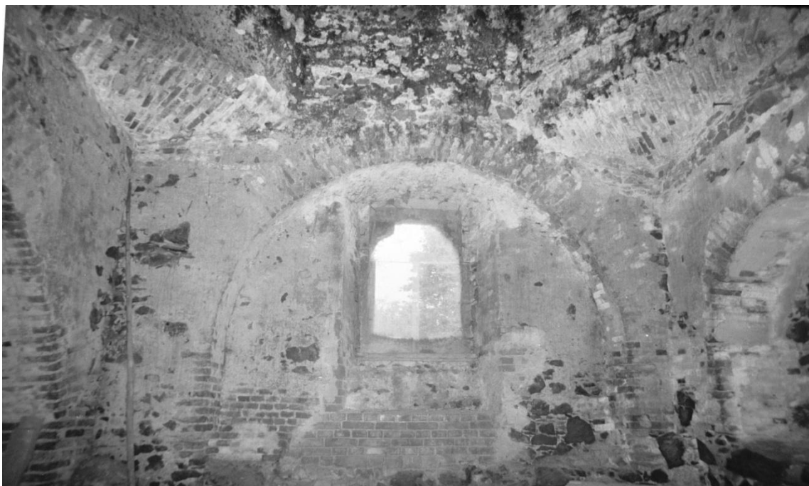
Obr. 28: okno v severovýchodní stěně kuchyně. Stav v r. 1984.
