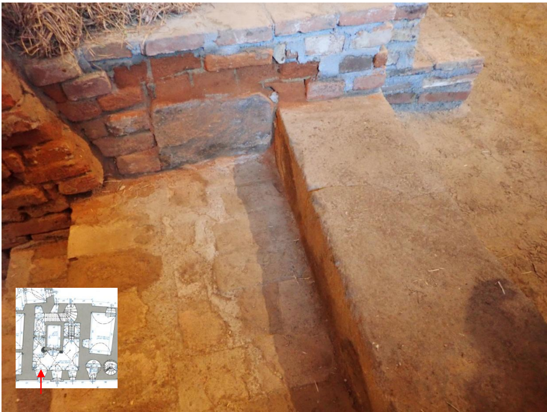
Obr. 18: Kuchyně 2. Vybouraný překlad ze vstupní strany DČK (mezi sloupy 1-6) použitý v mladší konstrukci.
