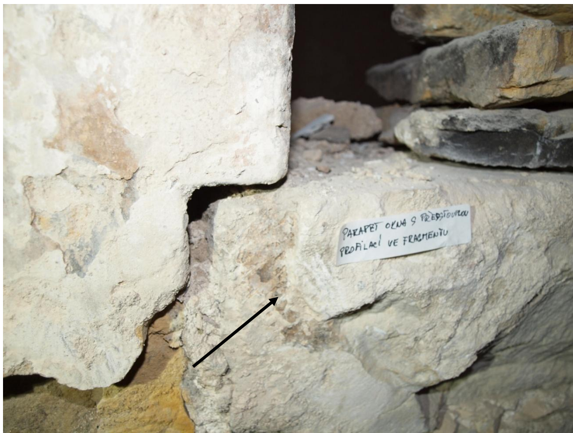
Obr. 8: Kuchyně 1, tzv. podávací okno, odsekaná představená část parapetu
