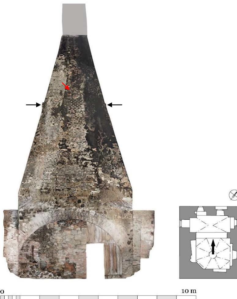
Obr. 36: Ortofoto severozápadní stěny kuchyně. Červená šipka označuje polohu zazděného otvoru. Na obr. je vidět odlišnou výši založení západního (vlevo) a severního trompu (vpravo). Černé čipky označují zazdivky na jihozápadní stěně (vlevo) a severovýchodní (vpravo). Hlavenka, Sýkora 2018.
