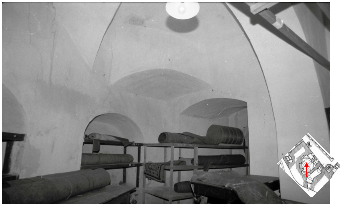
Obr. 3: Kuchyně, jeden ze 3 dochovaných trompů nad stěnou, která je otiskem zbořené okrouhlé věže. Ve stěně jsou slepé arkády. Stav v roce 1984.
