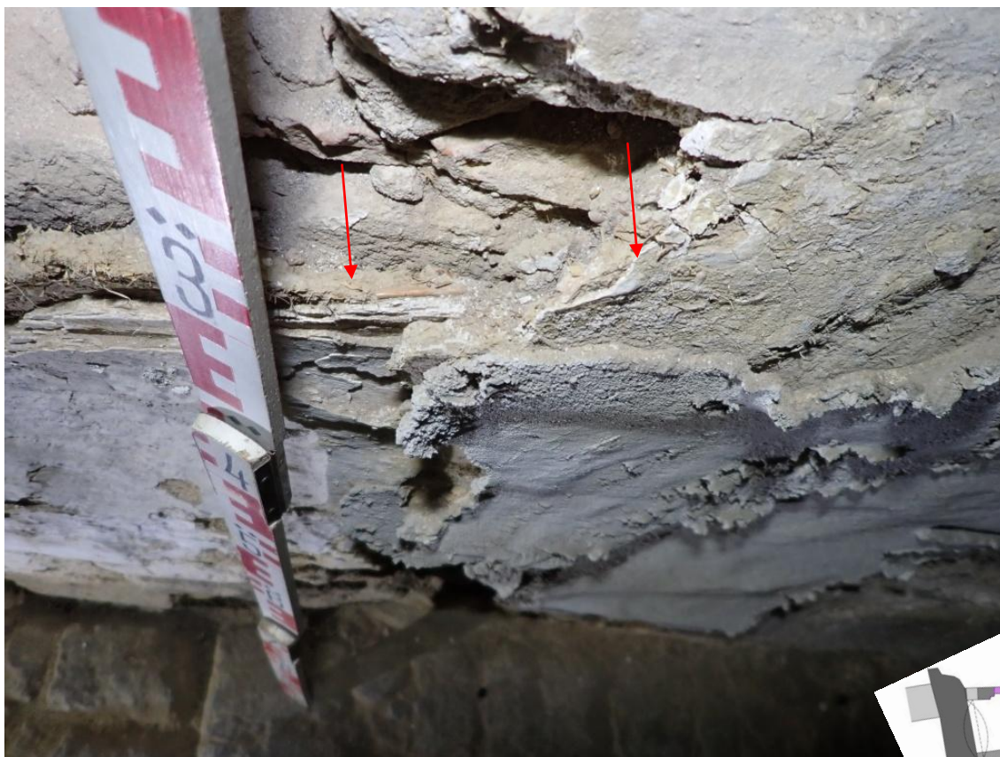
Obr. 86: Kuchyně 3. Hliněné omítky v interiéru kuchyně, pod oknem.
