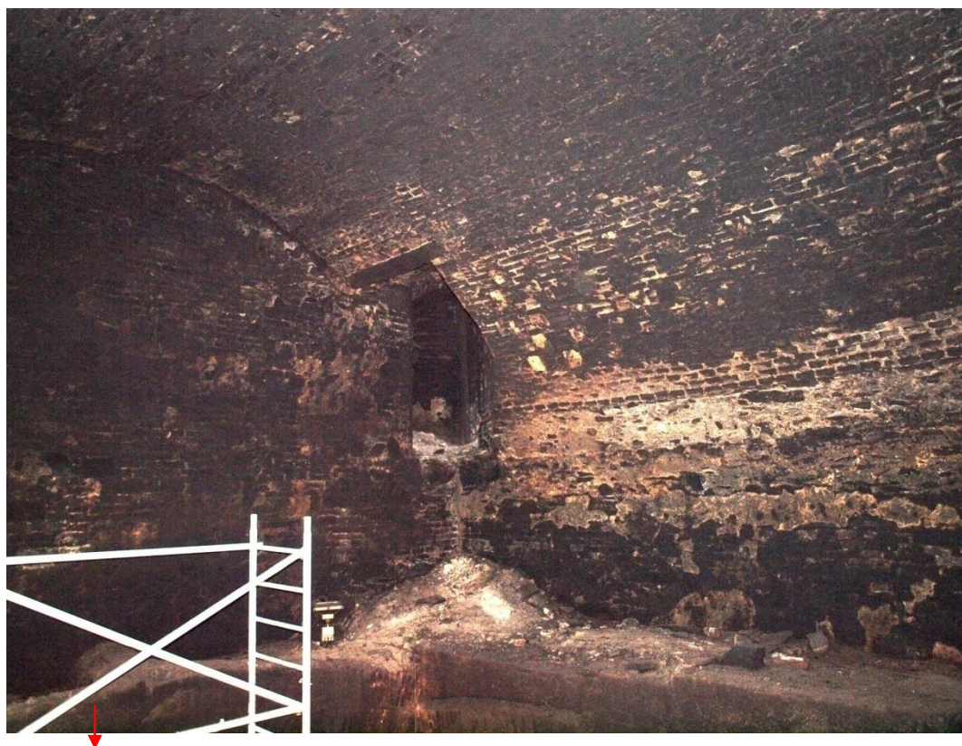
Obr. 28: Kuchyně 2. Východní kout kuchyně, povrch ochozu se sutí a východní komín. Šipka označuje zídku mezi pasem a obvodovou zdí kuchyně na nižším SV ochozu.
