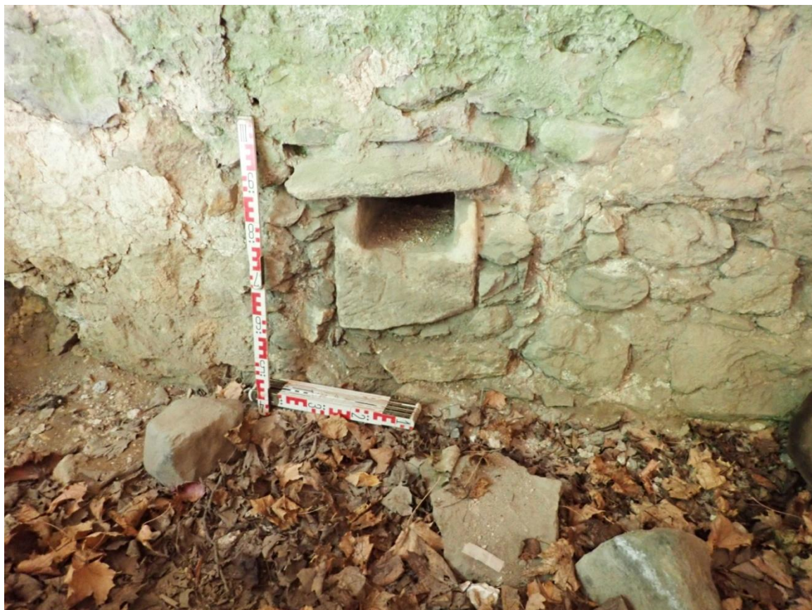
Obr. 29: Výlevka v severozápadní stěně, stav květen 2022
