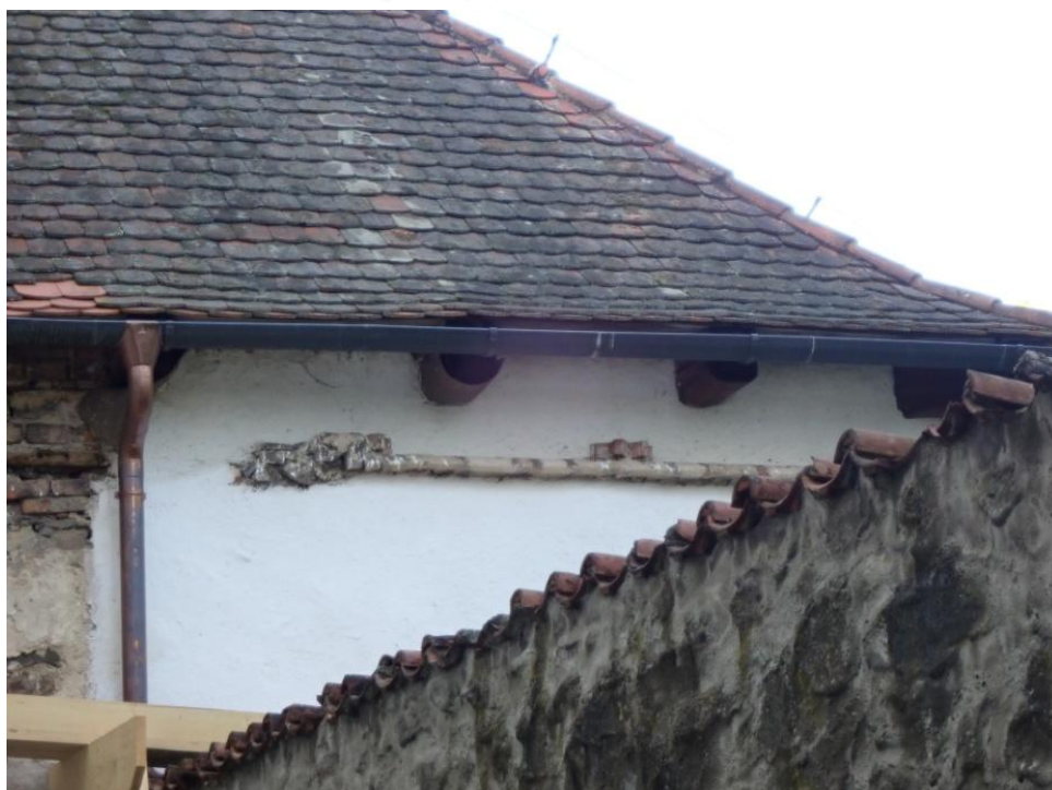
Obr. 14: Barevné snímky: Východní strana kuchyně. Kamenná římsa vystupující z fasády, nad ní část sloupku, snímek a výřez. Foto dochovaného sloupku na půdě.
