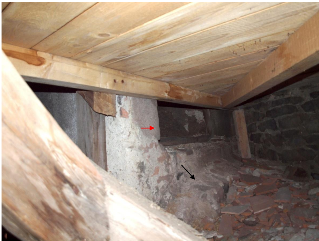
Obr.13: Kuchyně 1A: Půdní prostor nad kuchyní. Červená šipka označuje novodobý osvětlovací otvor, černá šipka označuje záklenek o něco staršího otvoru, který se nachází pod ním .
