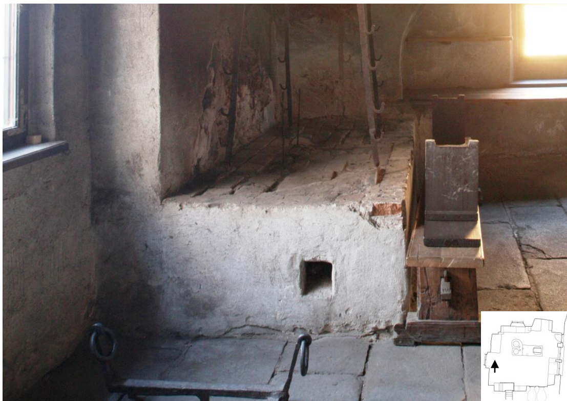
Obr. 43: Vybavení kuchyně 2, podesta na vaření v severozápadní části kuchyně 2. Foto Z. Poloprutský.
