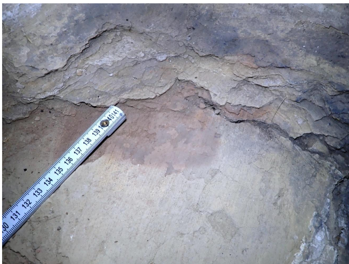
Obr. 77: Kuchyně 3. Podesta na vaření, detail.
