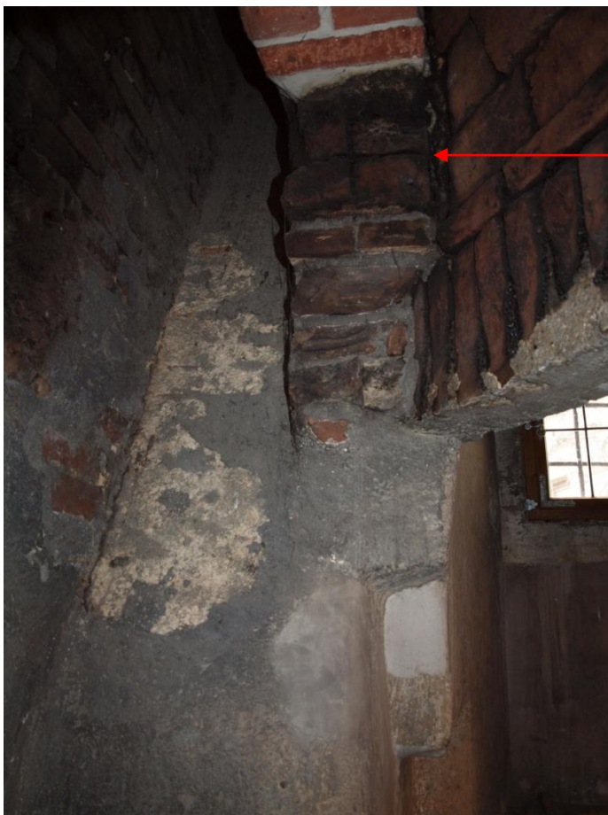
Obr. 14: NP3. Pozůstatek pasu odbouraného pravděpodobně již při stavbě prvního dýmníku.
