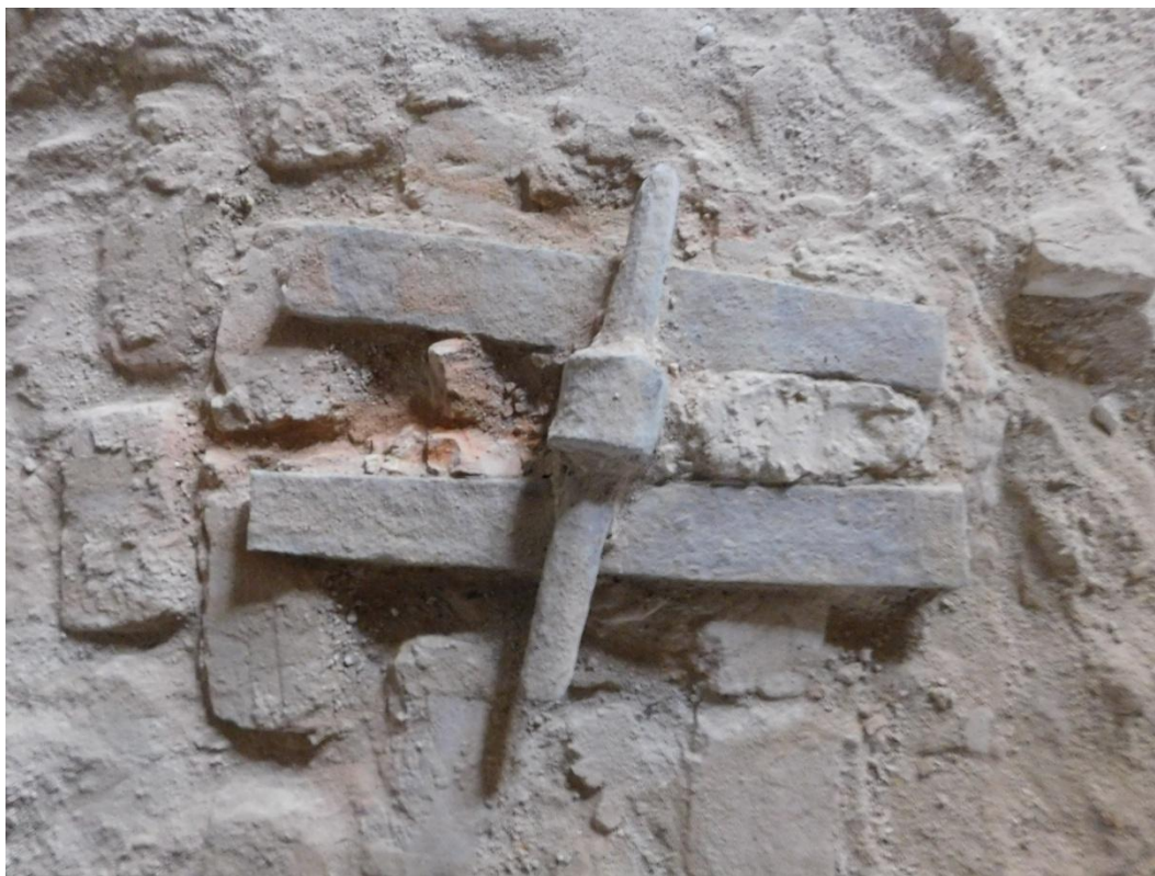
Obr. 13: Kovaná závlač ve valené klenbě kuchyně 2. Podle Štětina 2018, 97.
