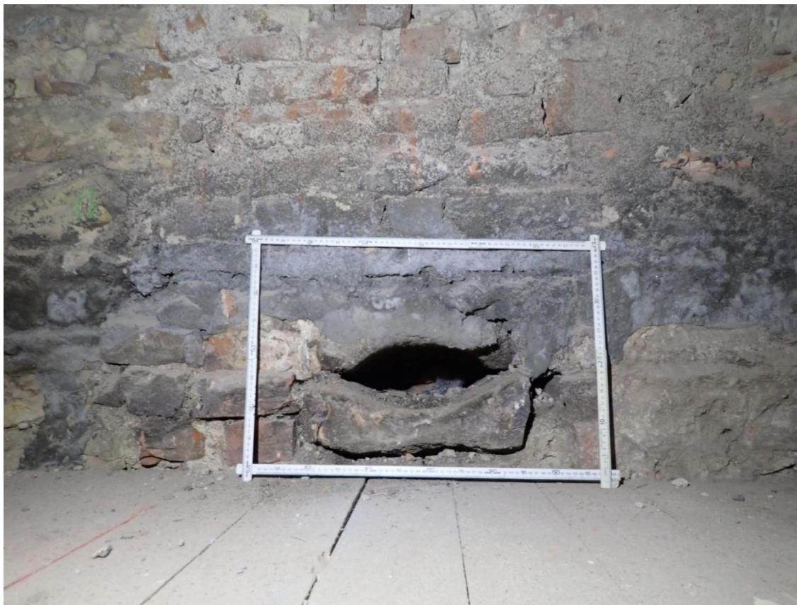
Obr. 5: Žlábek z ve východní části severní zdi. Žlábek mírně vystupuje ze zdi, v místnosti na něj navazovala kamenná nádržka, do které se vylévala odpadní voda.
