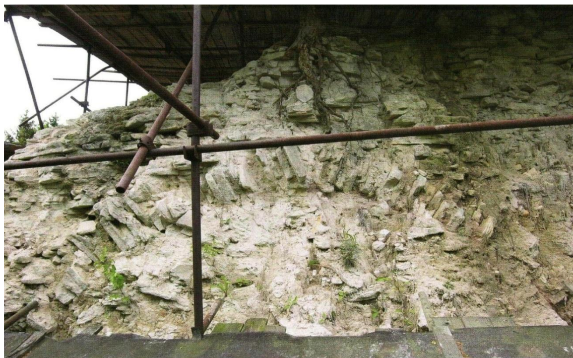
Obr. 2: Interiér tzv. kovárny od severu, horní část zbytku klenby v severní hradbě. Podle V. Razíma (2012, 105).
