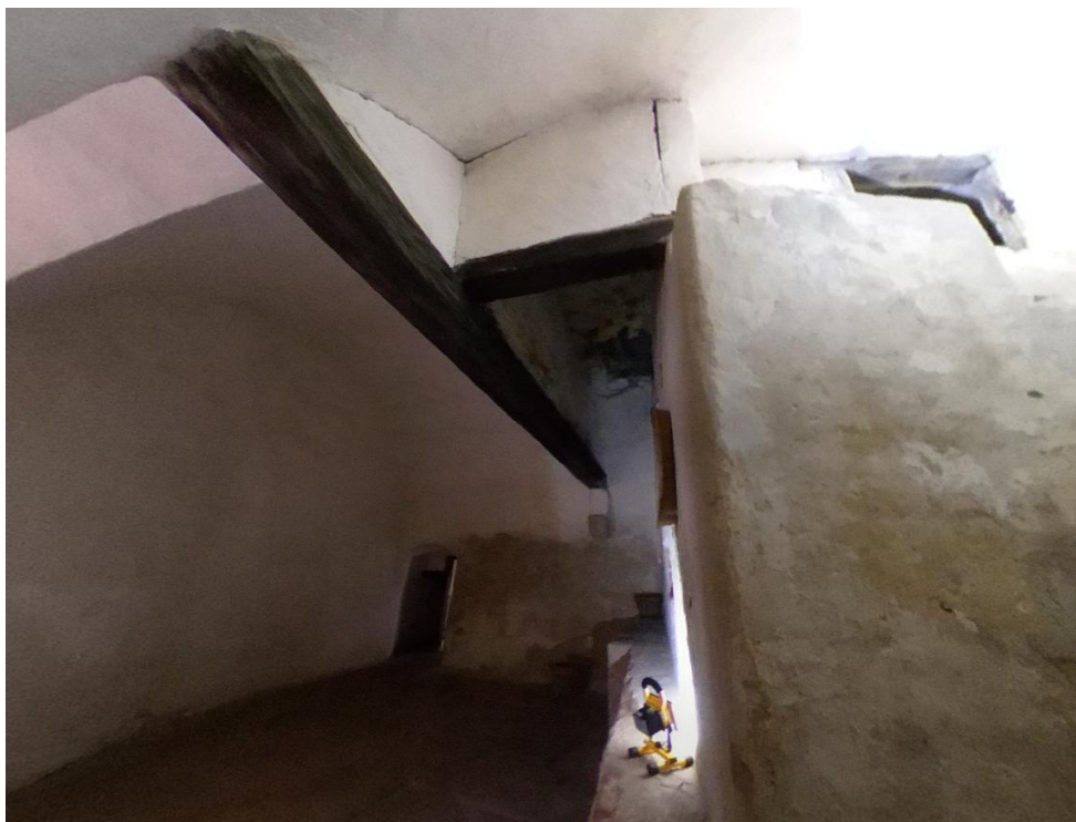
Obr. 16: Kuchyně 1. Odvod kouře z pecí. Výřez ze snímku sférické foto-kamery.
