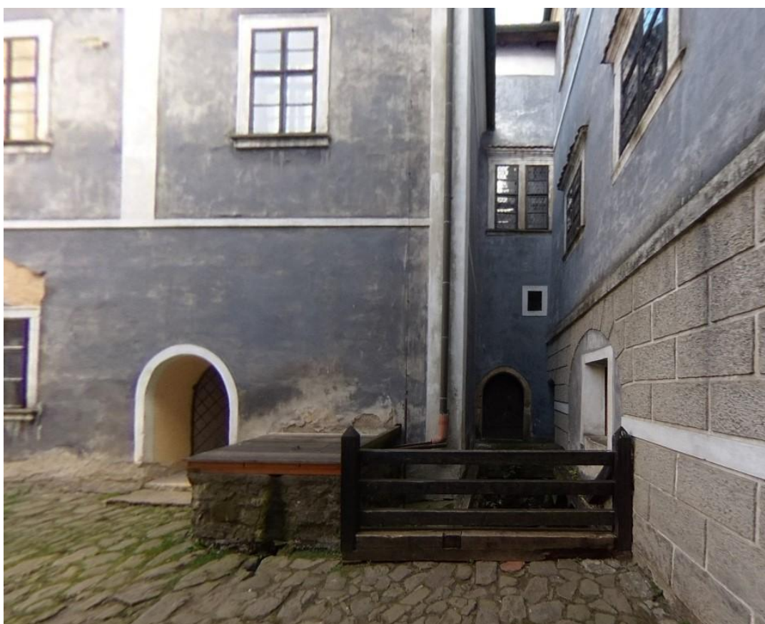
Obr. 140: Zásobování vodou. Cisterna (vlevo) a studna (vpravo). Výtěž ze snímku sférické foto-kamery.
