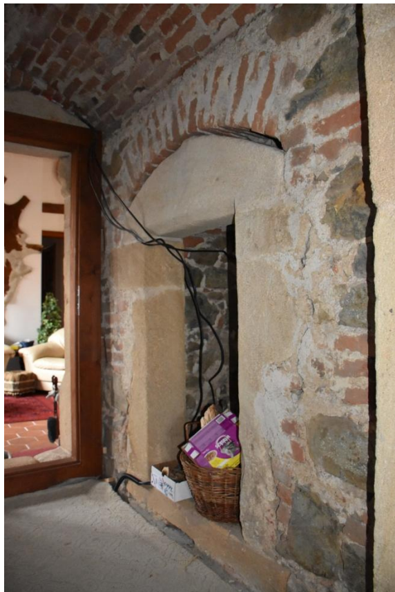
Obr. 54: Příkládací prostor v 1. patře polygonální bašty. Foto F. Kolář.
