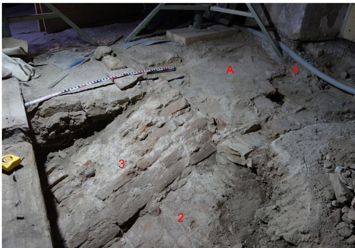
Obr. 7: Kuchyně 2, odhalená klenba kuchyně 1. A - zazdívka prostoru mezi klenbou 3 a 4, 2, 3, 4 - čísla kleneb (viz text). Foto A. Piskáčková.
