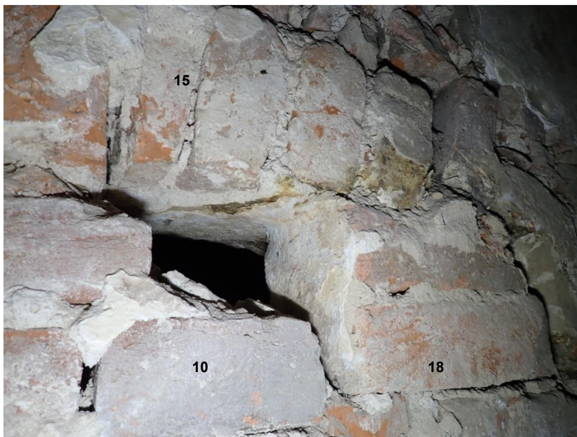
Obr. 63: Kuchyně 3. Omítka na rozhraní severní špalety a záklenku mladšího okna.
