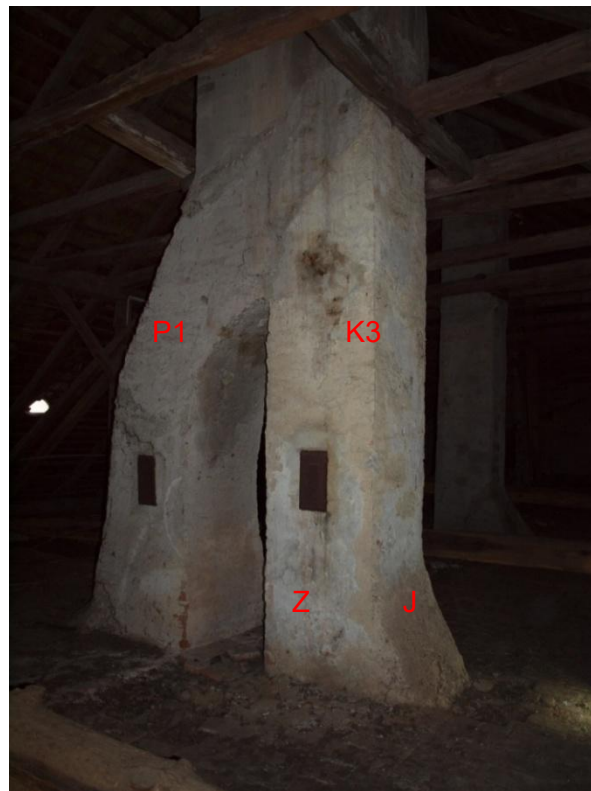
Obr. 52: Kuchyně 3. Komín kuchyně 3(K3) v prostoru půdy v r. 2019. P1 - prostor s topeništěm č. 1, J, V, Z - světové strany.
