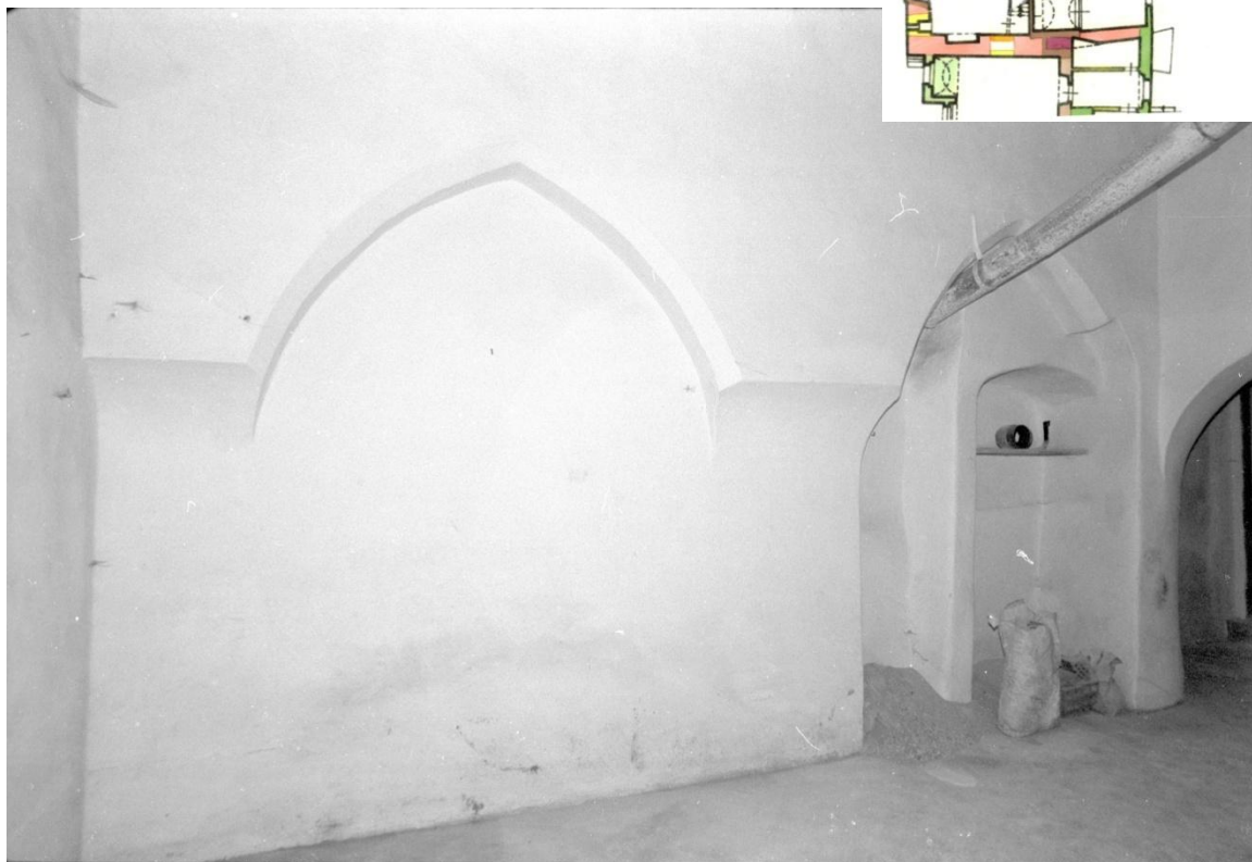
Obr. 10: Zazděné arkády, které propojovaly dýmnou část kuchyně s přípravnou
