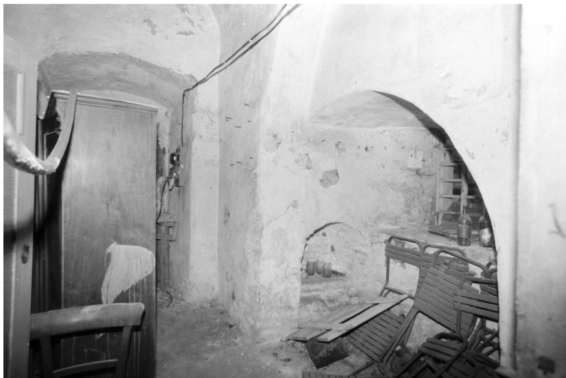
Obr. 22: Přípravna, severovýchodní část se zalděným vstupním portálem a lunetou nad ním. Foto F. Kolář.
