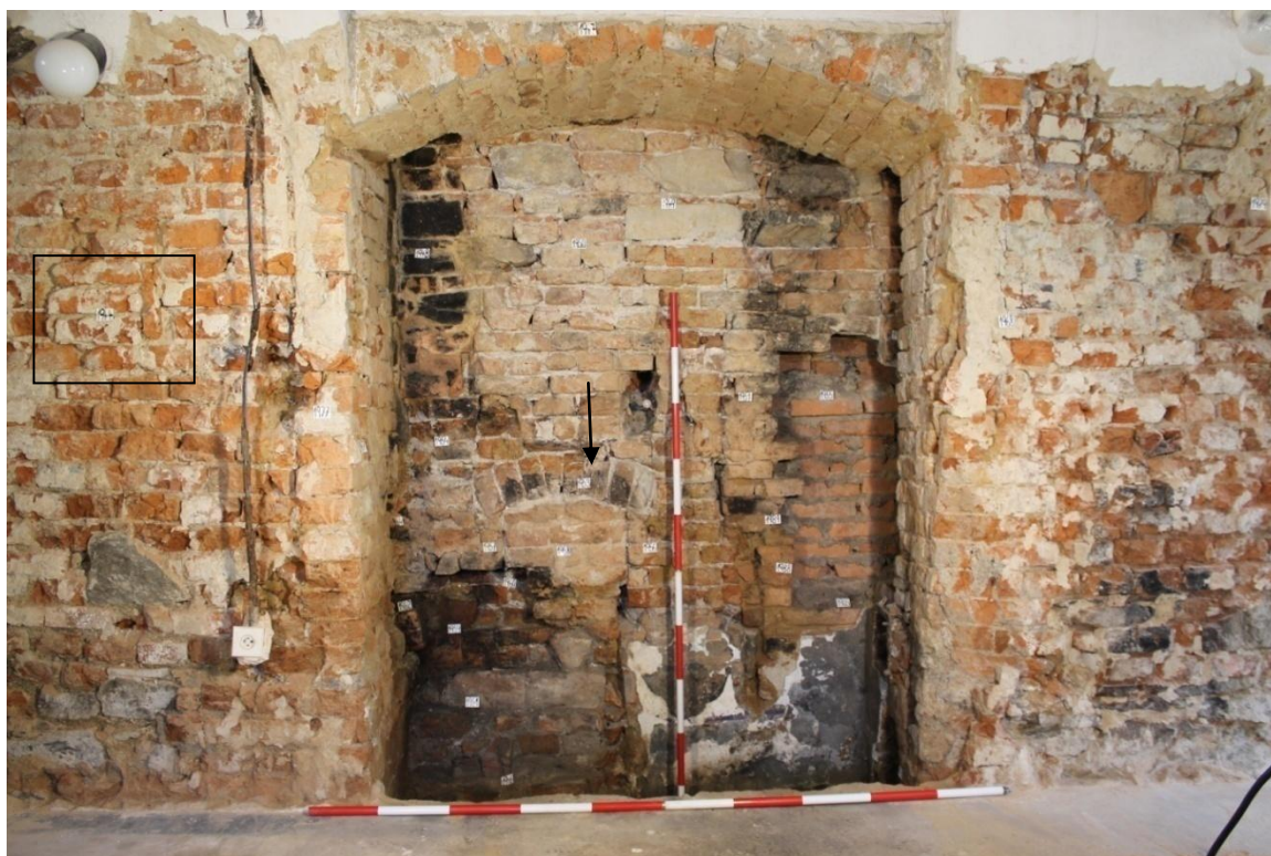
Obr. 9: Nika pod komínem. Šipka označuje zazděný příkladací otvor. Obdélník označuje místo možné zazdivky otvoru po trámu, který nesl příčku zabráňující úniku kouře do čisté části kuchyně. Stav kuchyně v době výzkumu a průzkumu v r. 2015. Foto F. Kolář.
