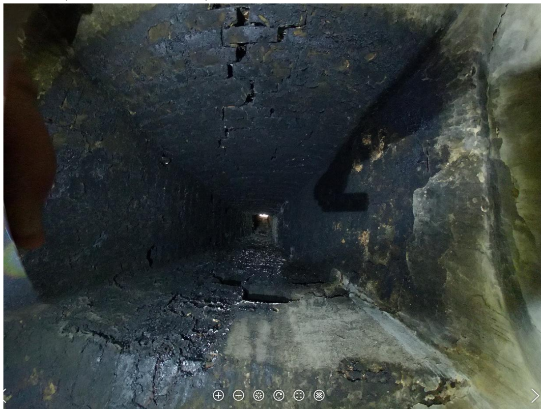
Obr. 53: Kuchyně 3. Pohled do DČK, celý záběr.
