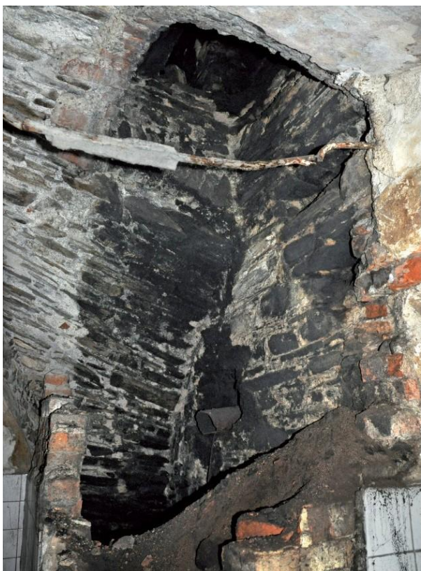
Obr. 3: Ústí DČK v kuchyni 1. Podle Zeman, Kratochvílová 2014.
