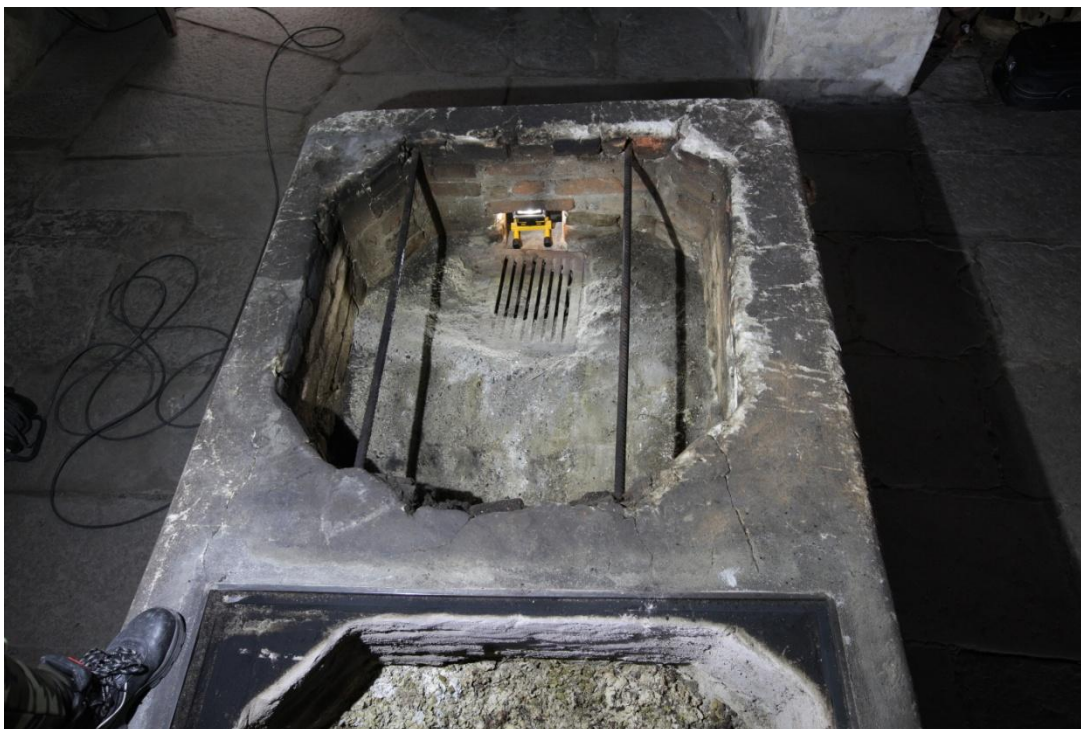
Obr. 37: Vybavení kuchyně 2, kamna umístěná umístěné ve středu kuchyně, topeniště 1. Foto Z. Poloprutský.
