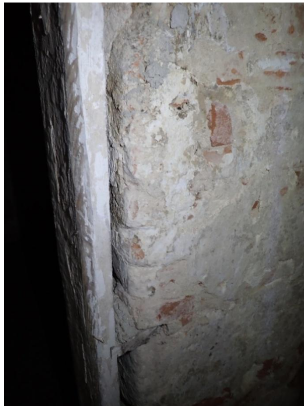
Obr. 59: Pravá špaleta starších dveří s viditelnými nátěry.
