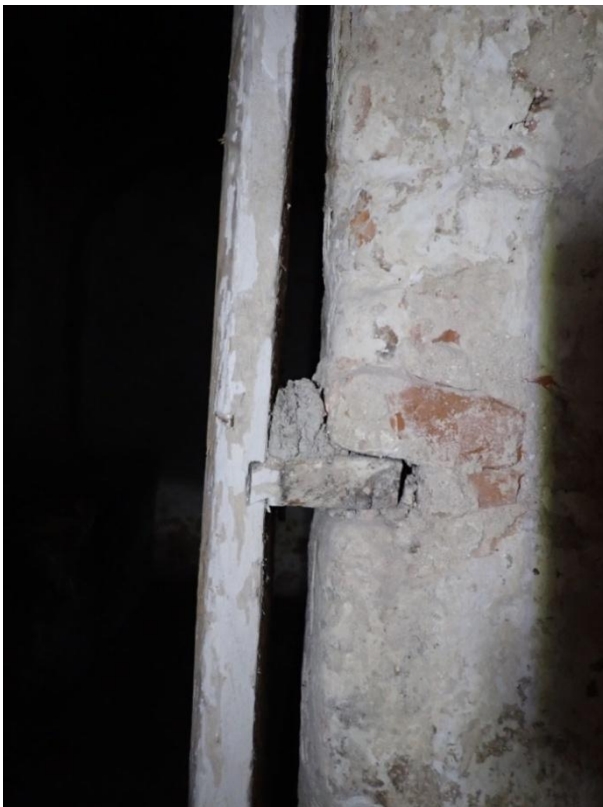
Obr. 58: Kuchyně 3. Způsob uchycení veřejí do zdi.
