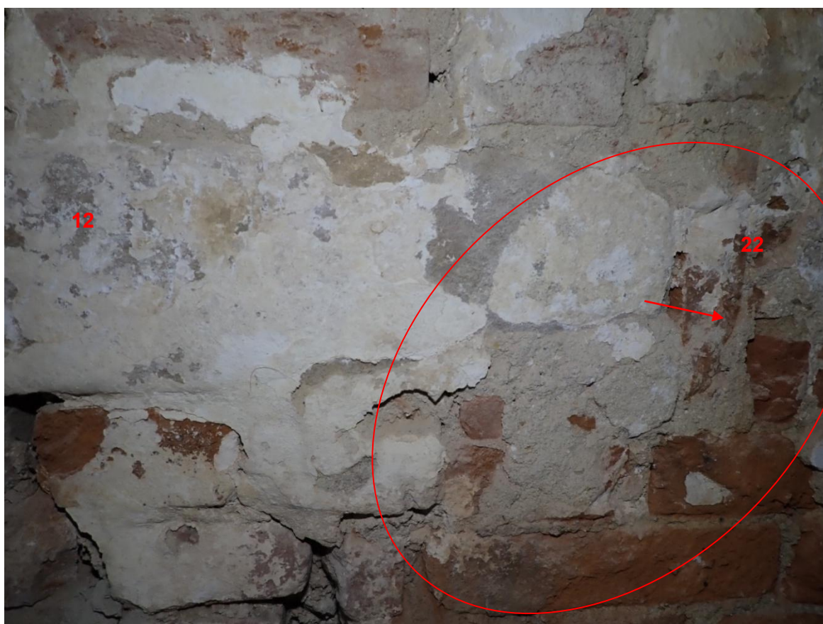
Obr. 66: Kuchyně 3. Úlomky cihel a cihla vedle pískovcového parapetu, označená cihla nastojato.
