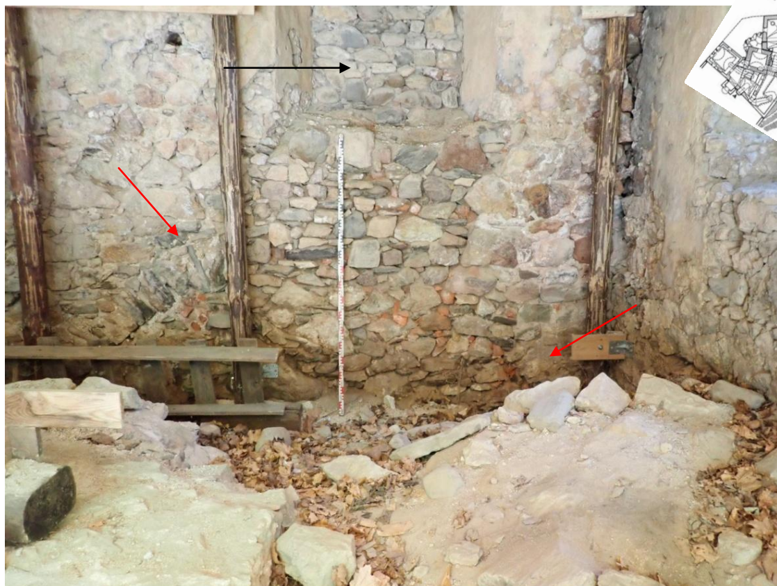
Obr. 20: Jihovýchodní stěna kuchyně, vylehčovací oblouk (červené šipky) a zazdívky (černá šipka - zazdívka okna), pohled z interiéru, stav květen 2022
