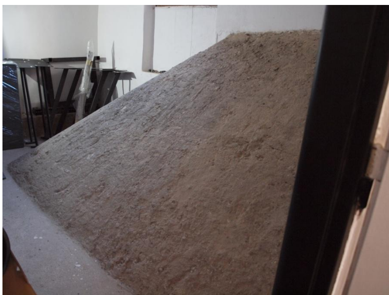
Obr. 7: Jihovýchodní část rubu klenby kuchyně v patře nad kuchyní.
