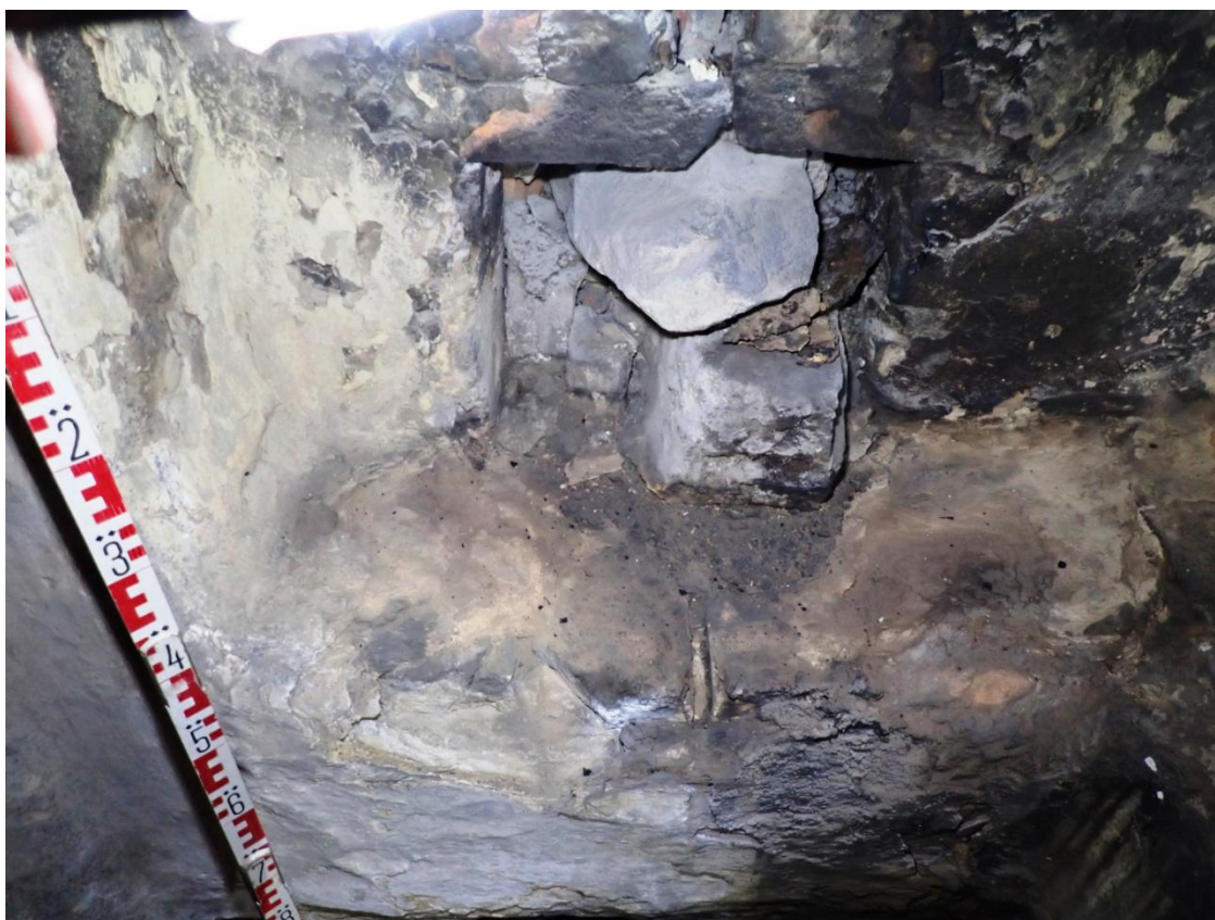
Obr. 71: Kuchyně 3. Podesta před přikláda-cím otvorem do kamen.
