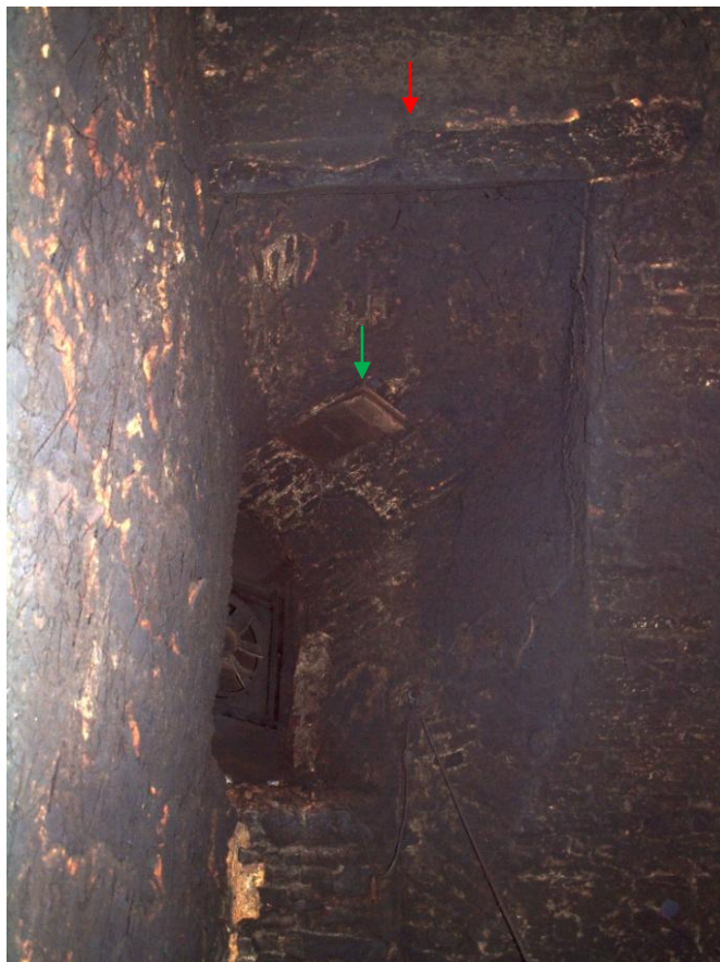
Obr. 29: Jižní kout kuchyně 2, krakorce podírající nižší SV pas a kamenný kvádr s otvorem, v němž je ještě pozůstatek původní konstrukce.
