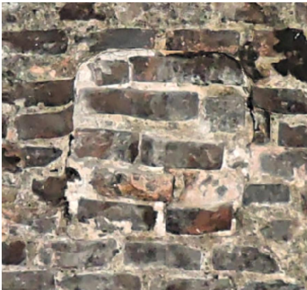
Obr. 34: Zazděný otvor v jihozápadní stěně oktogonu. Výřez z ortofota. Hlavenka, Sýkora 2018.
