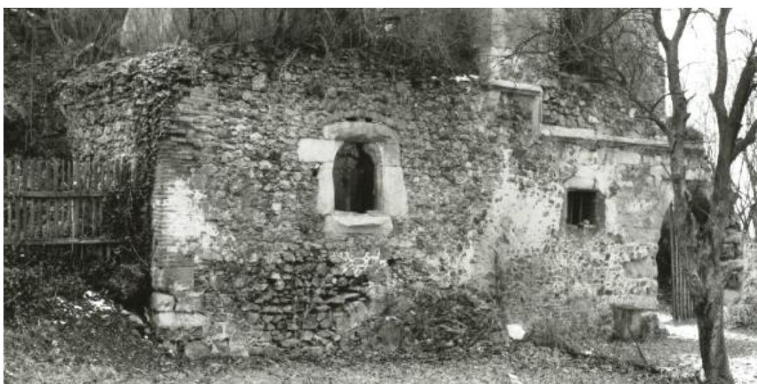
Obr. 11: Zakončení římsy na obytné budově pozdně gotického křídla a navazující zdivo kuchyně. Stav před opravou koruny zdiva kuchyně, viditelné řádkování zdiva beze stop po římsě. Foto dostupné z www.plzensky-kraj.cz/cs/RGlics_ShowPic.asp?strKod=95421384StrID=10430 , stáří snímku nebylo uvedené, 1.4.2018.
