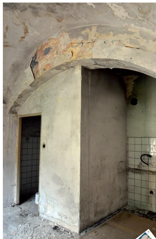
Obr. 8: Kuchyně 2, dělicí pas, za kterým byla dýmná část kuchyně. Podle Zeman, Kratochvílová 2014.
