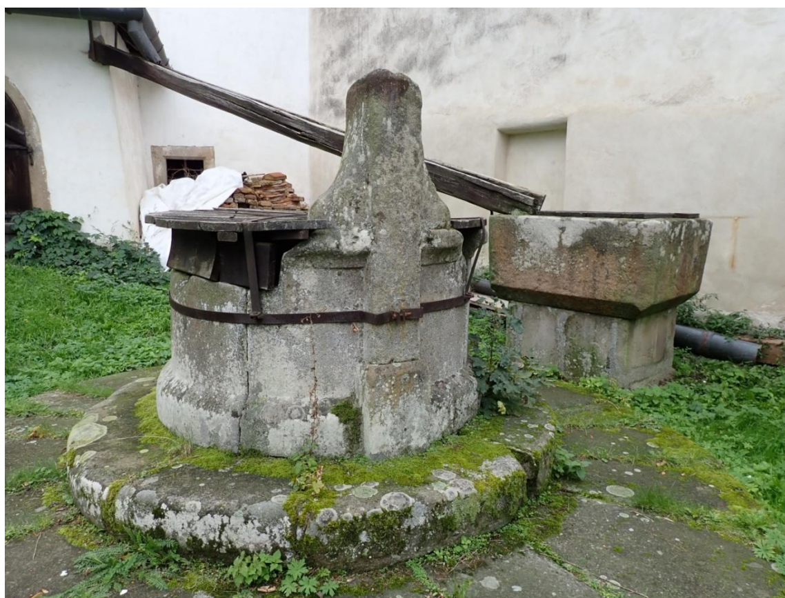
Obr. 138: Zásobování vodou. Vlevo cisterna, vpravo filtrační zařízení.
