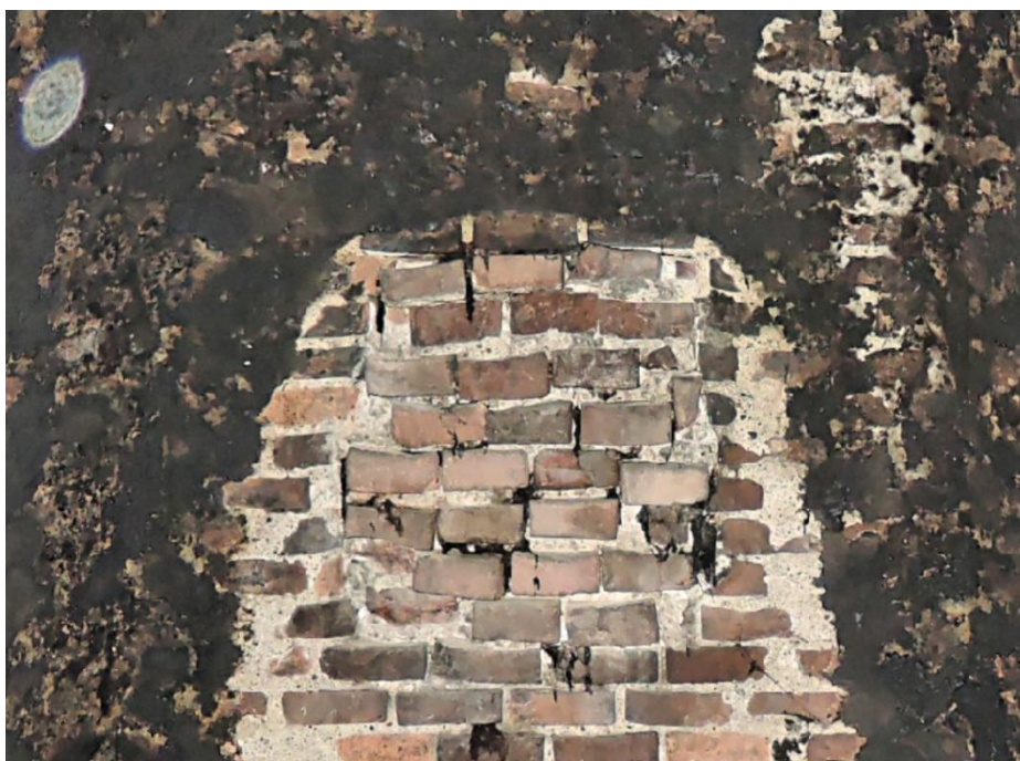
Obr. 39: Zazděný otvor v severovýchodní stěně oktogonu. Výřez z ortofota. Hlavenka, Sýkora 2018.
