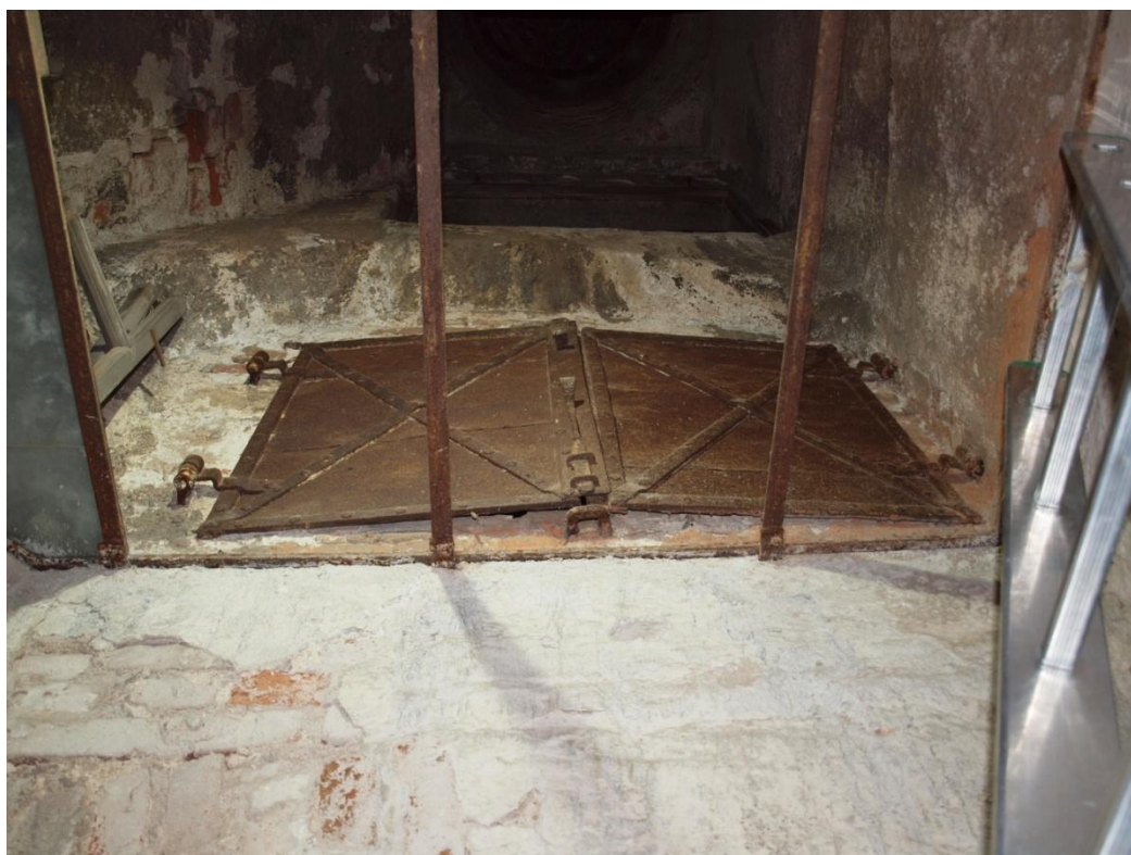
Obr. 14: Kuchyně 1A, otvor v DČK pod ostěním osvětlovacího okna . Železná dvířka se uzavírala zevnitř komína. Otvor za dvířky je dnes zazděný.
