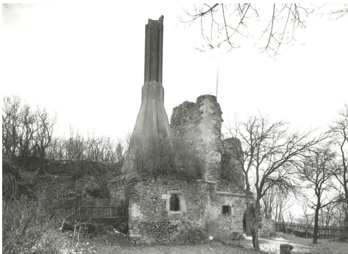
Obr. 8: Zakončení římsy na obytné budově pozdně gotického křídla a navazující zdivo kuchyně. Stav před poslední opravou komína a korun zdiva kuchyně.
