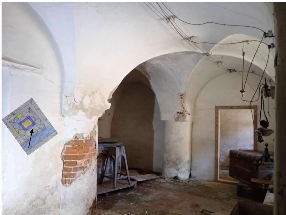
Obr. 6: Foto z interiéru kuchyně. Cihlová topeniště patřila do hradní prádelny, která nahradila kuchyni na začátku 20. století. Šipka označuje stoupající balenou klenbu, která uzavřela dýmny prostor.
