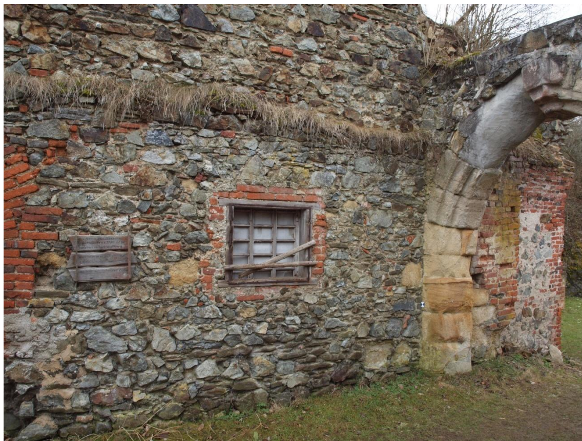
Obr. 19: Okno do přípravný v průjezdu, patrně podávací okno.
