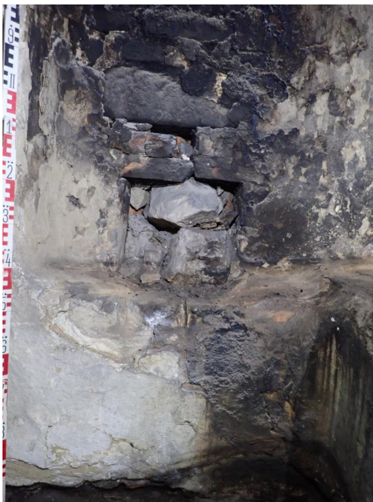
Obr. 71: Kuchyně 3. Podesta před přikláda-cím otvorem do kamen.
