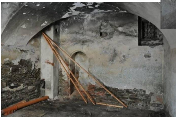
Obr. 6: Kvelb vedle kuchyně 1, zadržný vstup a okno do obytné místnosti v předním traktu. Podle Zeman, Nová 2012, 70.
