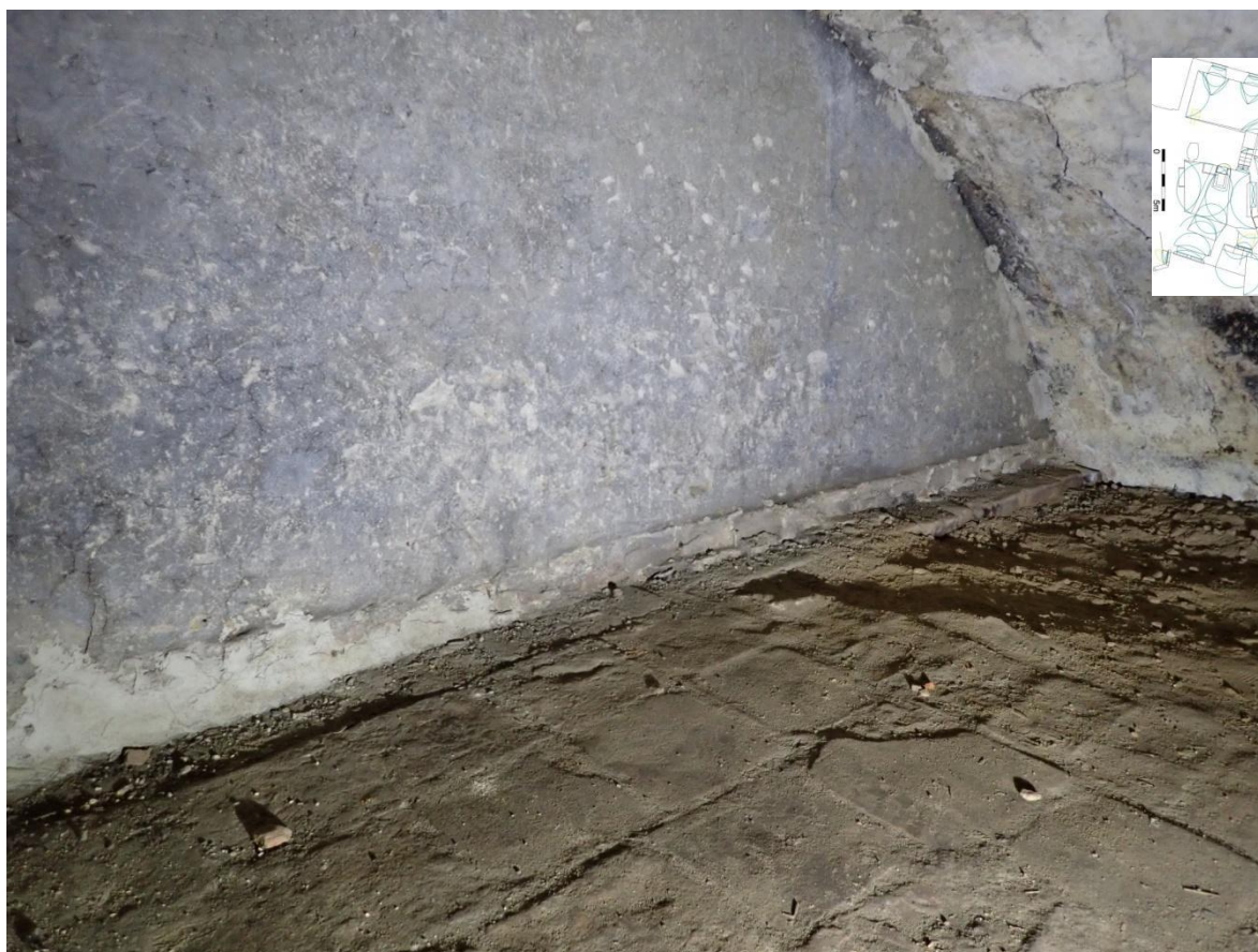
Obr. 18: Kuchyně 1. Otisk odstraněné podlahové vrstvy cihel v sušárně, v popředí dlaždice nad větší pecí a na ně navazující cihly nad menší pecí.
