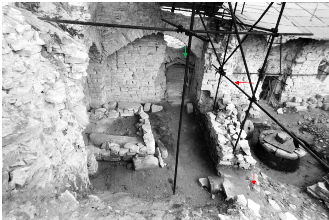
Obr. 5: Pohled do kuchyně 3 od západu, stav 1984. Podesta na vaření je již částečně rozvalená. Vpravo studna. Červené šipky označují východní špaletu okna a místo vstupu do kuchyně, zelená šipka ukazuje ještě dochovaný záklenek vstupu do severní místnosti severovýchodního křídla.
