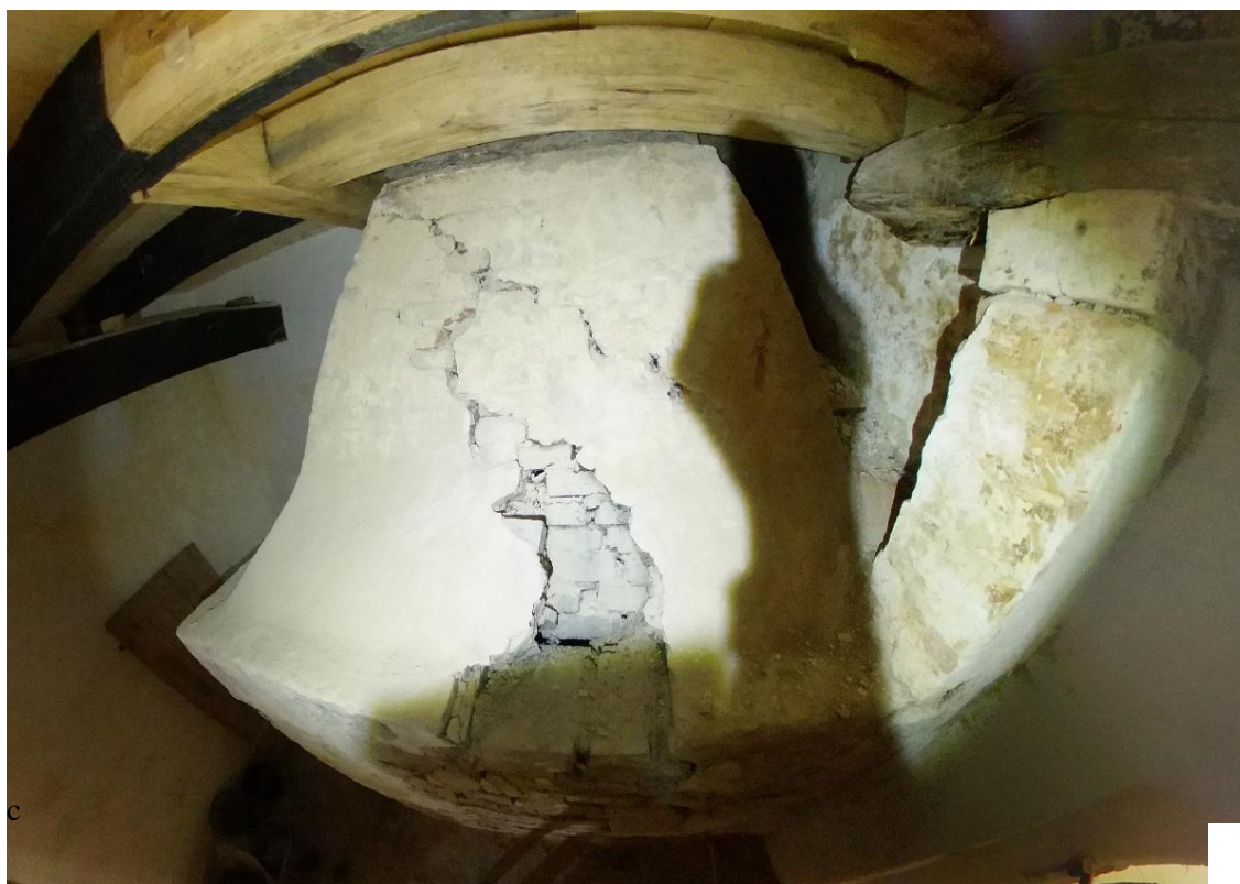
Obr. 47: Kuchyně 3. Pohled na východní stěnu DČK, výřez ze snímku sférické foto-kamery.
