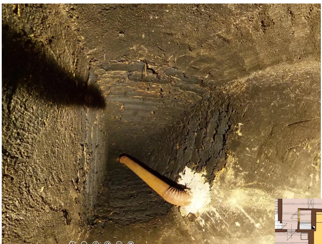
Obr. 106: Kuchyně 5. Pohled do DČK nad podestou na vaření, kouřovod je z kamene z místnosti 208. Výřez ze snímku sférické foto-kamery.
