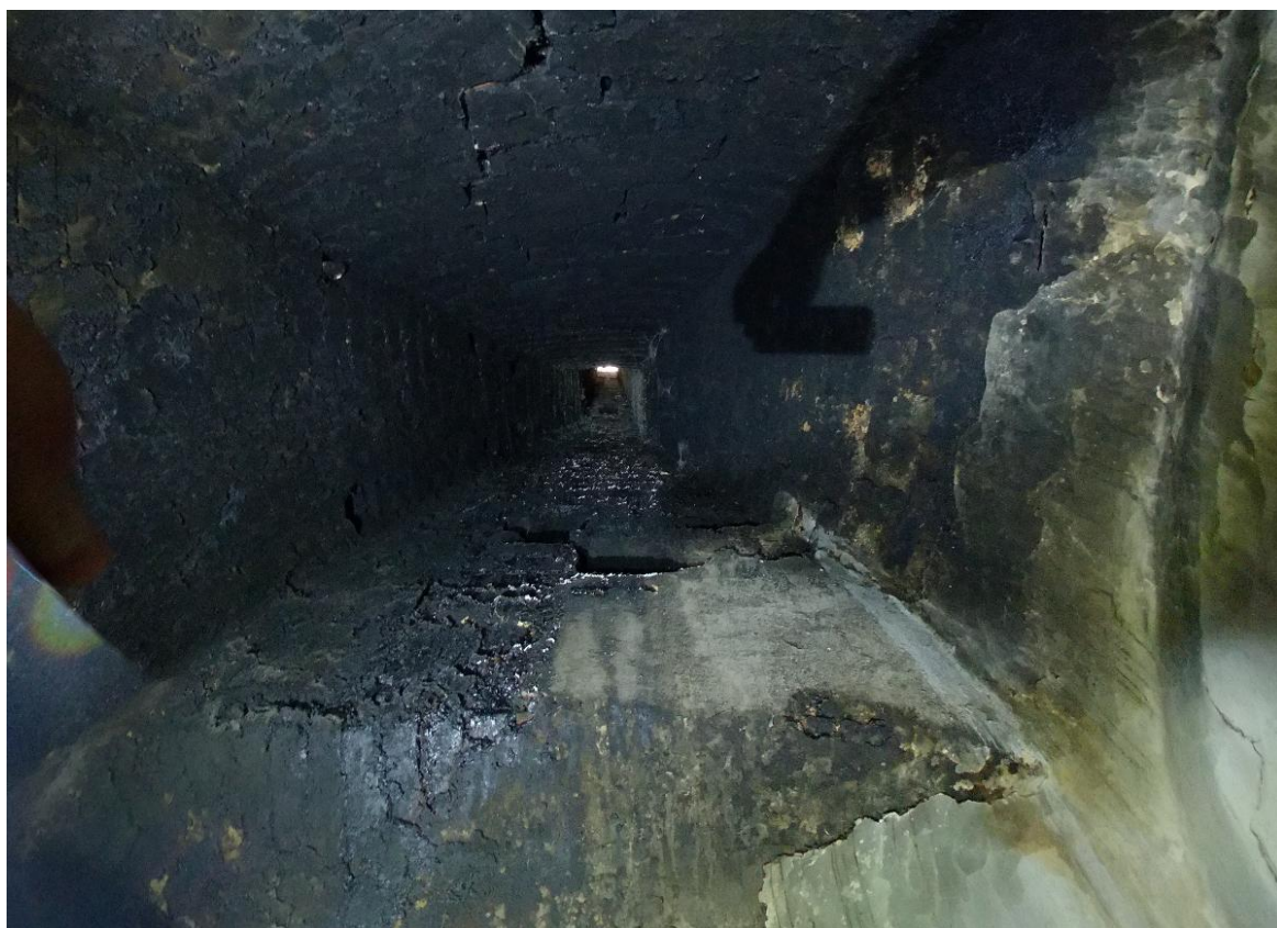
Obr. 49: Kuchyně 3. Pohled do DČK, dole západní stěna, výřez ze snímku sférické foto-kamery
