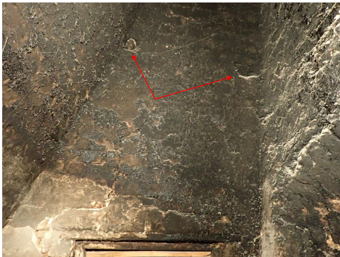
Obr. 91: Kuchyně 3. Otvory pro trámy v jižní stěně. V levém otvoru je dřevo.
