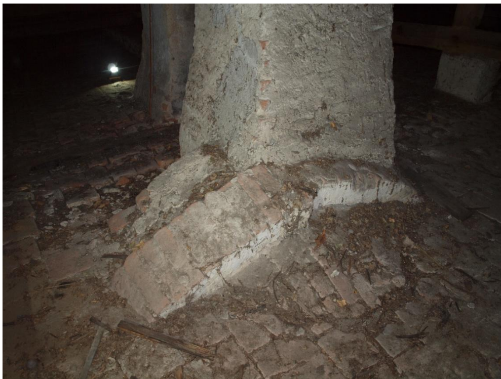
Obr. 123: Prostor napojený na komín 1. Část klenby vystupující do prostoru půdy a komín. Černá šipka označuje pas na klenbě, červená zídka tvořící horní část jižního čela valené klenby kuchyně v prostoru půdy. Výřez ze snímku sférické foto-kamery.
