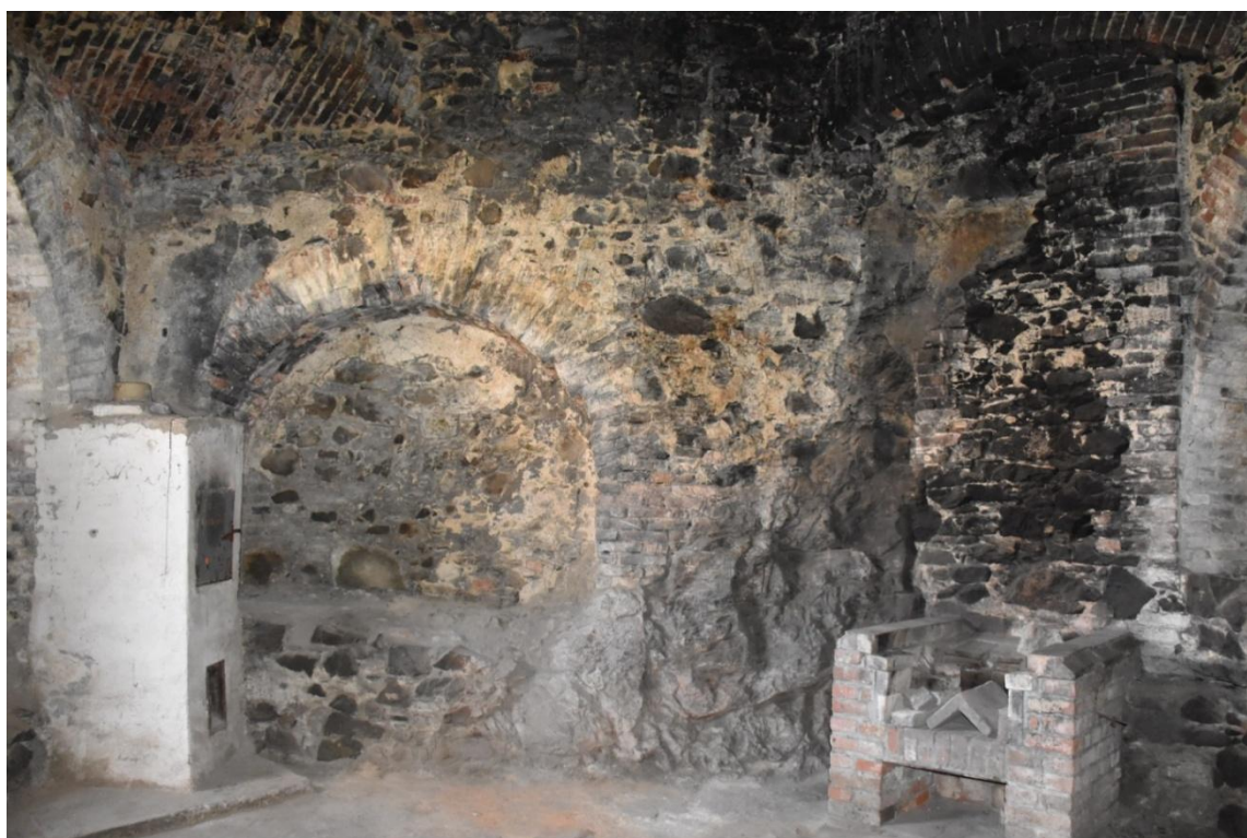
Obr. 29: Výklenek v jihovýchodní stěně místnosti. Foto F. Kolář.
