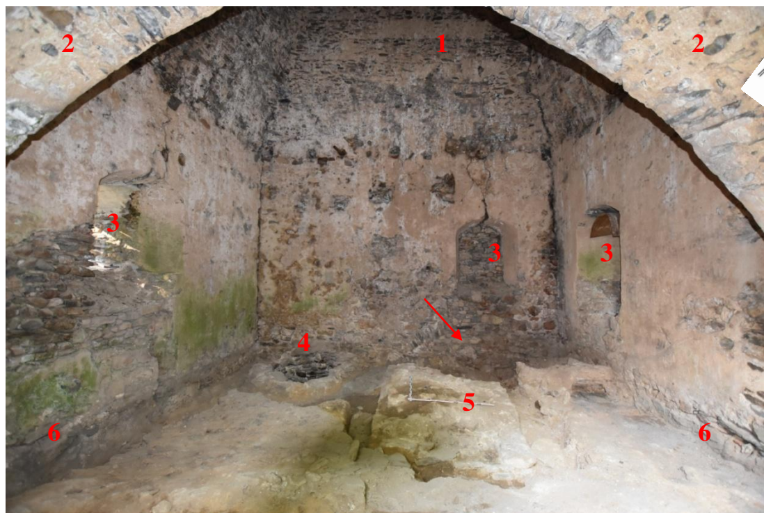
Obr. 21: Pohled do kuchyně od vstupu, foto F. Kolář 23/7 2018.1 - dýmníková část komína, 2 - lomený pas v jihozápadní stěně kuchyně, 3 - okna, 4 - studna, 5 - podesta, 6 - výlevky, šipka označuje vylehčovací pas v severovýchodní stěně kuchyně
