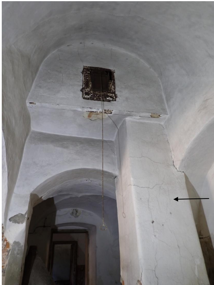
Obr. 7: Uzavření přístupu do komína při přechodu na tahové komíny. Šipka ukazuje mladší komín prádělny.
