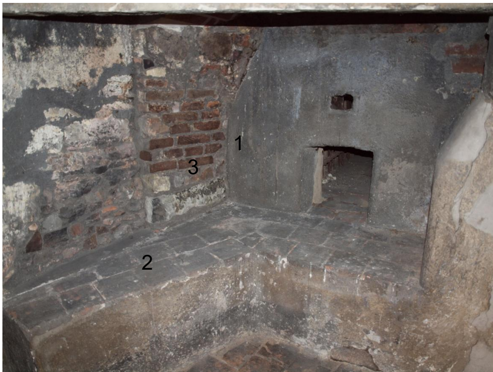
Obr. 13: NP3. Mladší dýmník. Šipka označuje místo, kde se dochoval náběh omítky po starším dýmníku
