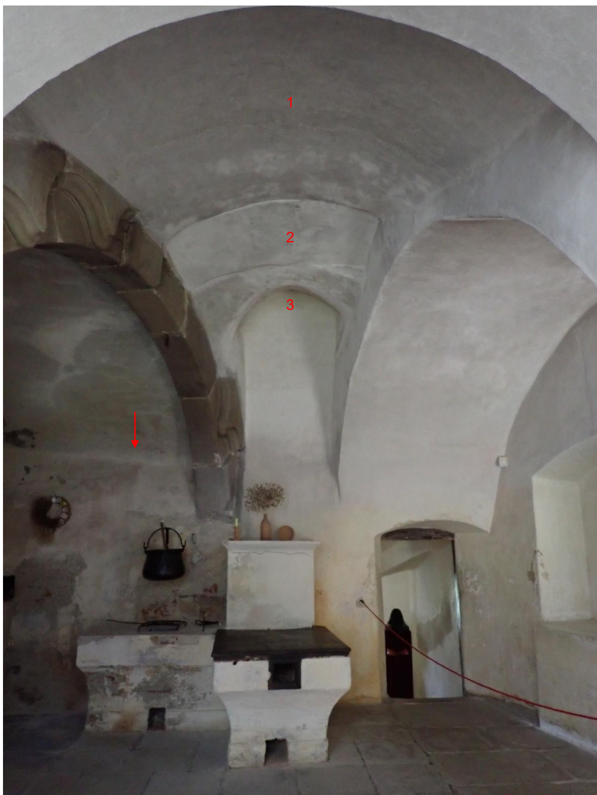
Obr. 22: Kuchyně 1. Pohled na přerušení valené klenby vyplněné 3 klenbičkami. 1 - valená stoupající klenba, 2 - pas, klenba s výsečí. Šipka označuje nasazení segmentové valené klenby.
