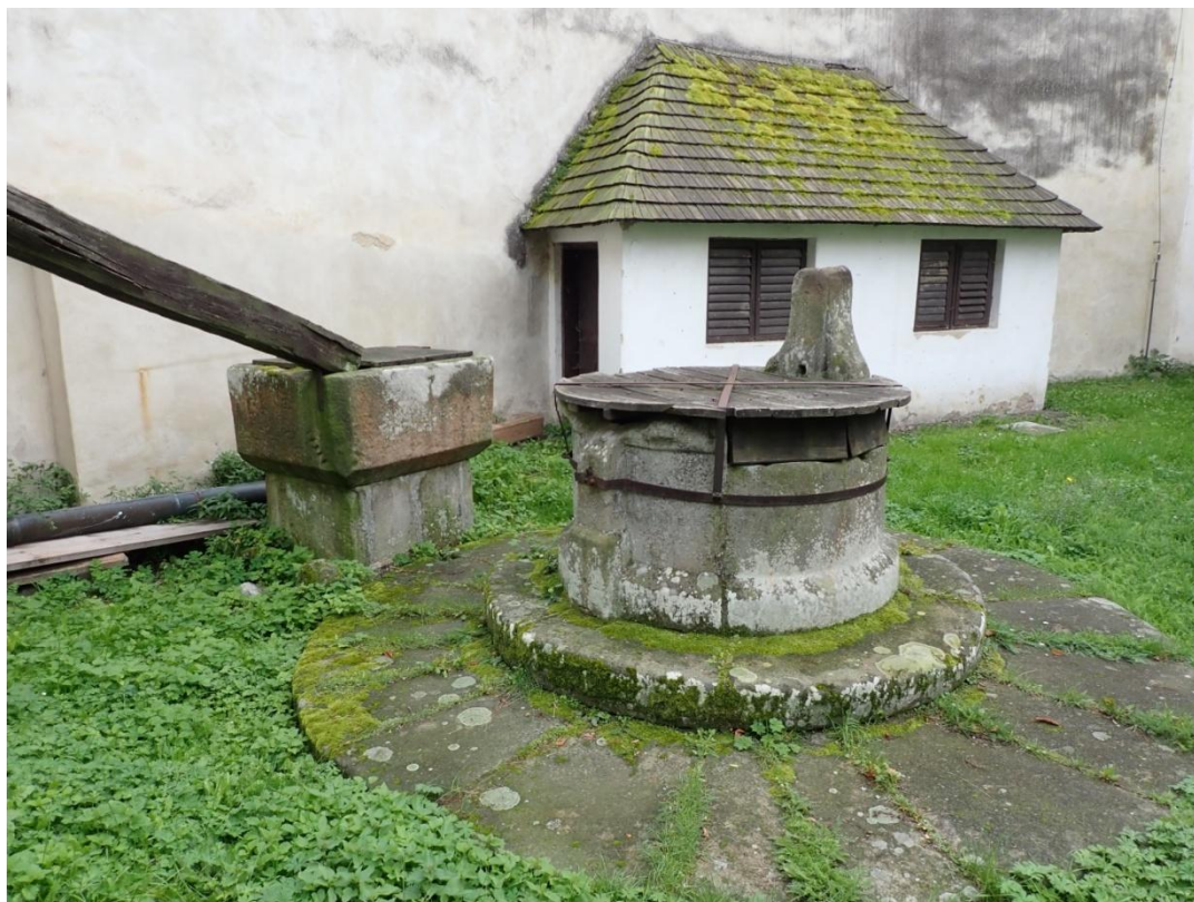
Obr. 139: Zásobování vodou. Vpravo cisterna, vlevo filtrační zařízení.
