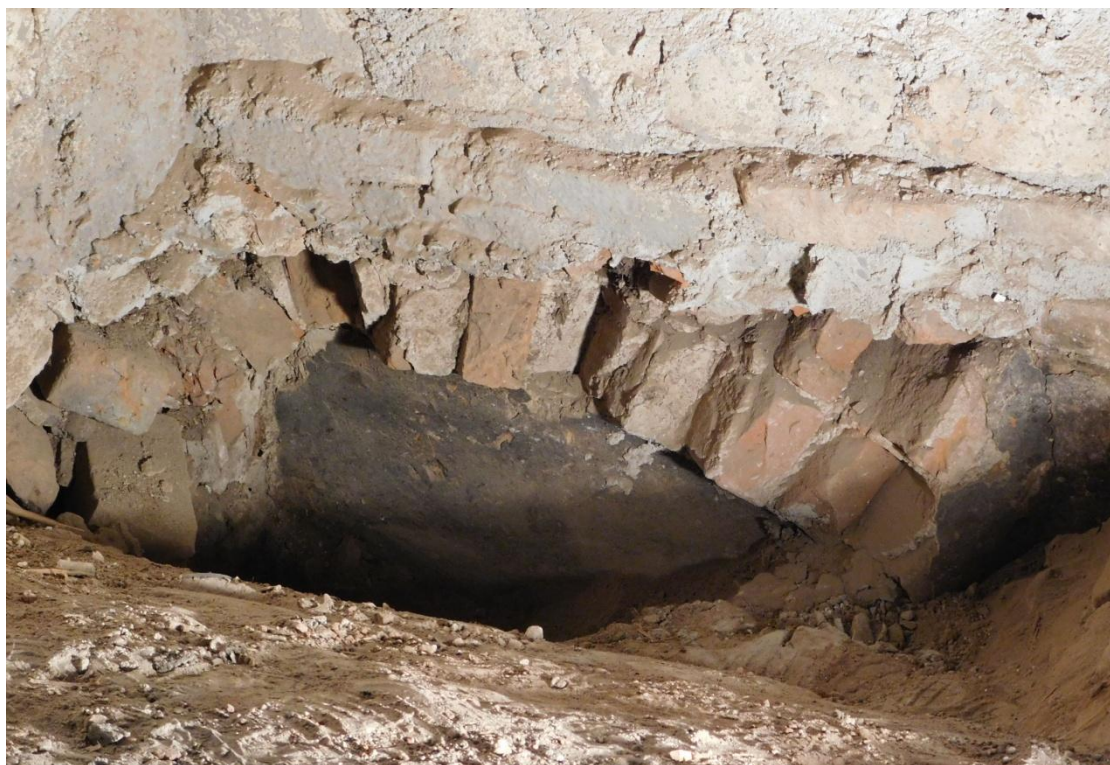
Obr. 9: Pozůstatek trompů v severovýchodním koutu prostoru nad mladší klenbou přízemí. Podle Štětina 2018, 97.
