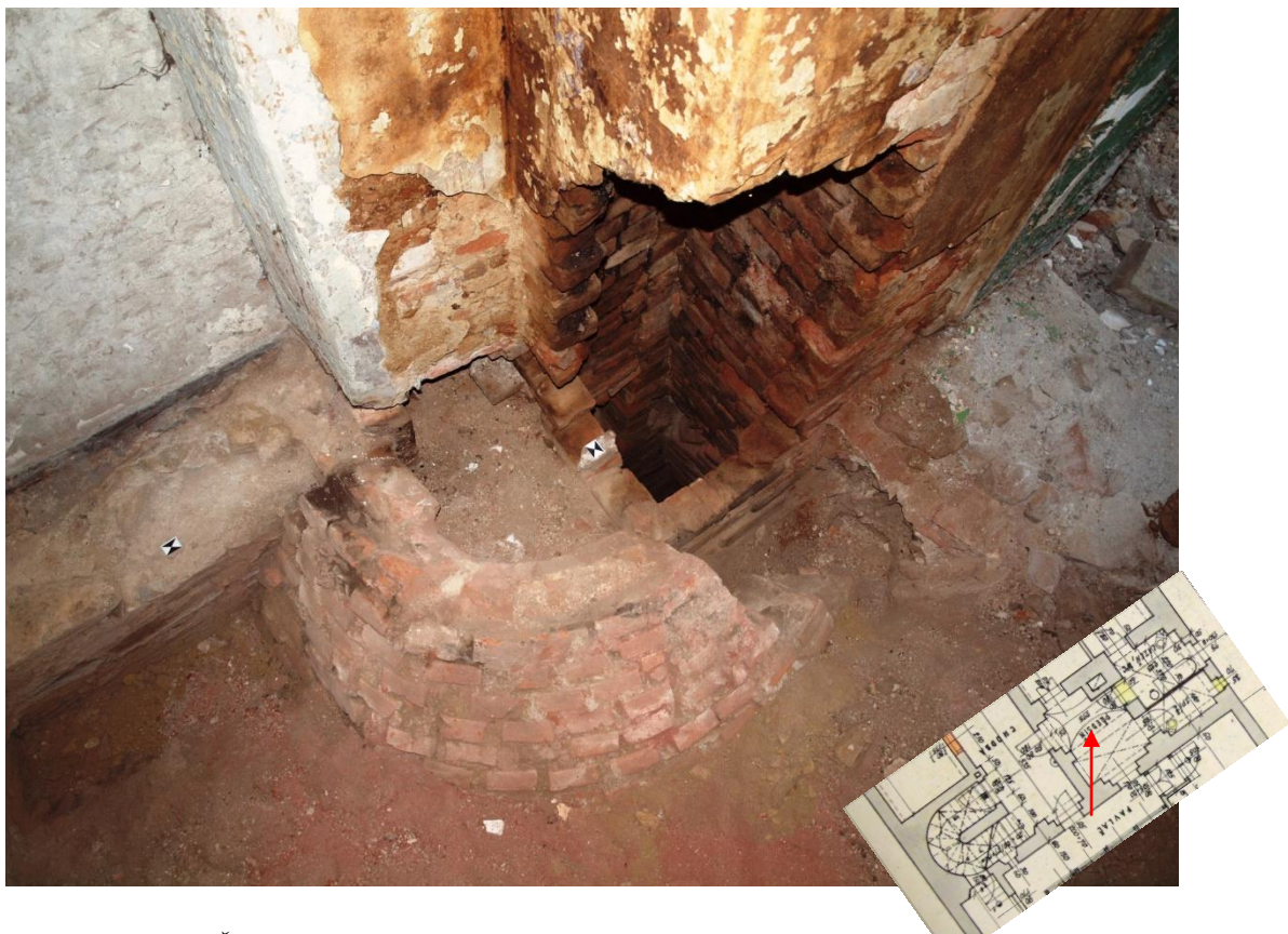
Obr. 7: Kuchyně 2, DČK kuchyně 1 vystupující z podlahy kuchyně 2, odbouraná část mladšího komínového tělesa.
