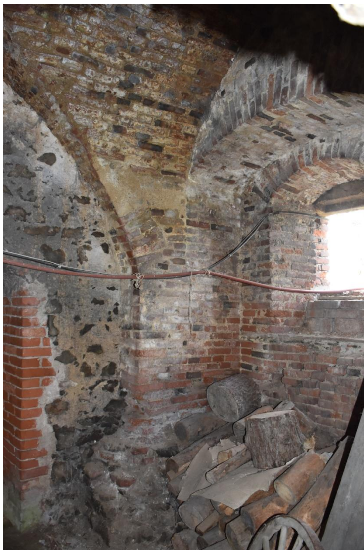
Obr. 25: Přípravna, záklenek otvoru pro výlevku ve zdi pod oknem do předhradí.
