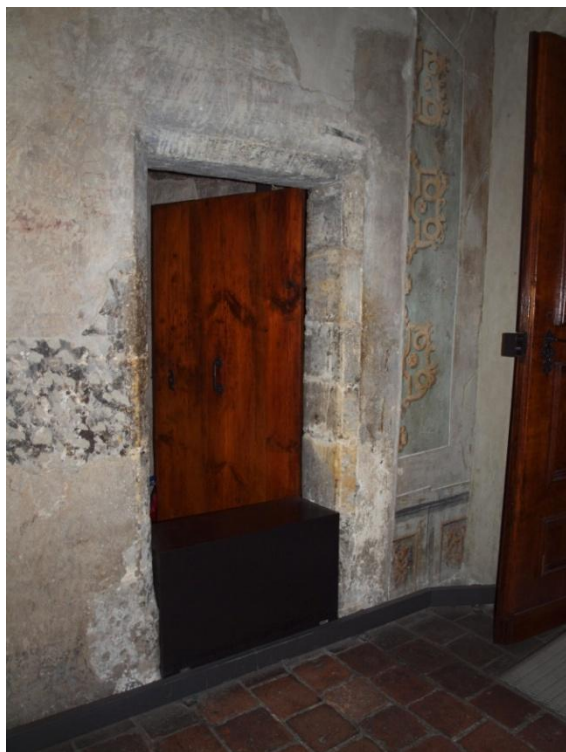
Obr. 8: NP3. Vstup do místnosti, pohled z předsíně.
