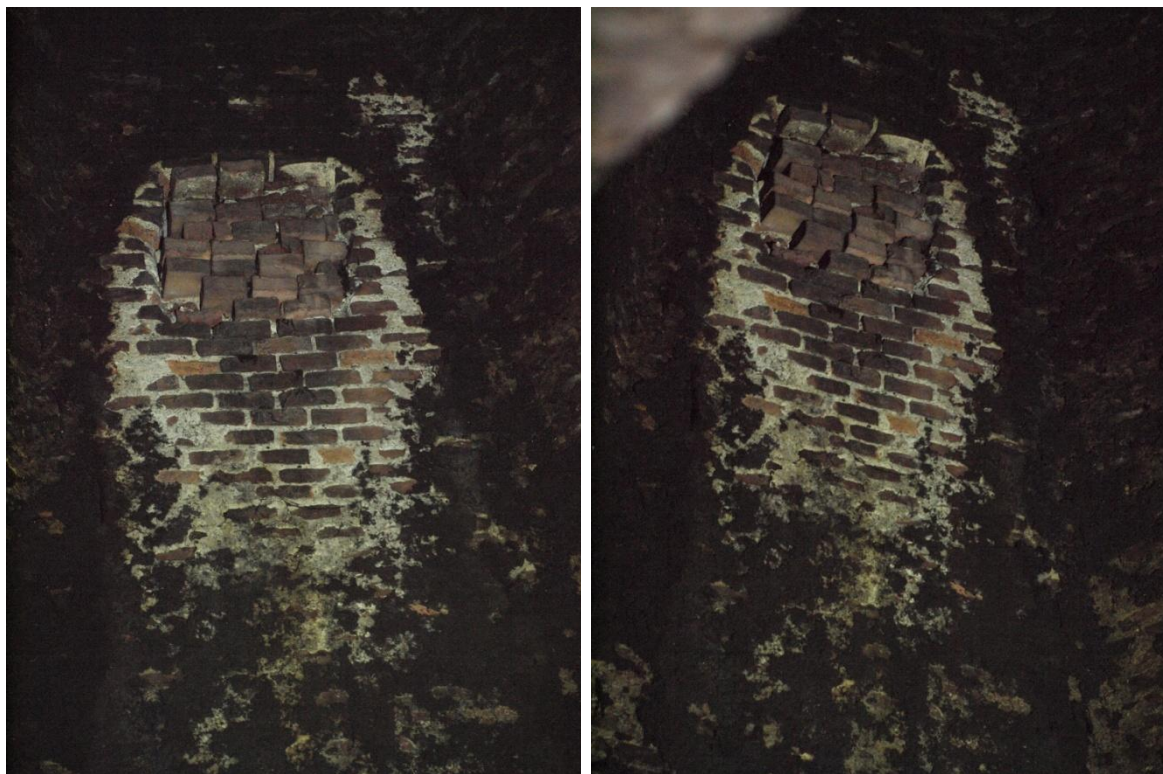
Obr. 40: Zazděný otvor v severovýchodní stěně oktogonu.
