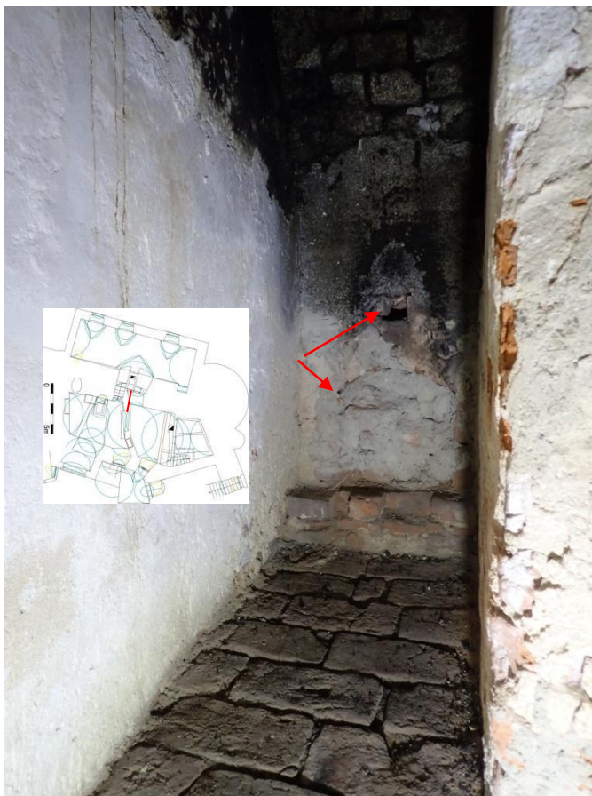
Obr. 20: Kuchyně 1. Příkládací prostor do kamen v místnosti č. 18. Šipky označují otvor pro odvod kouře a zazděný otvor příkládací.
