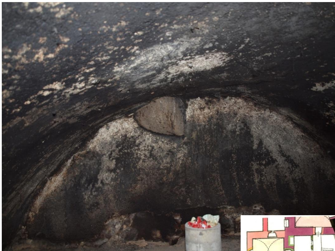
Obr. 9: Krakovec v severním koutě kuchyně, nad stávajícím stropem místnosti.
