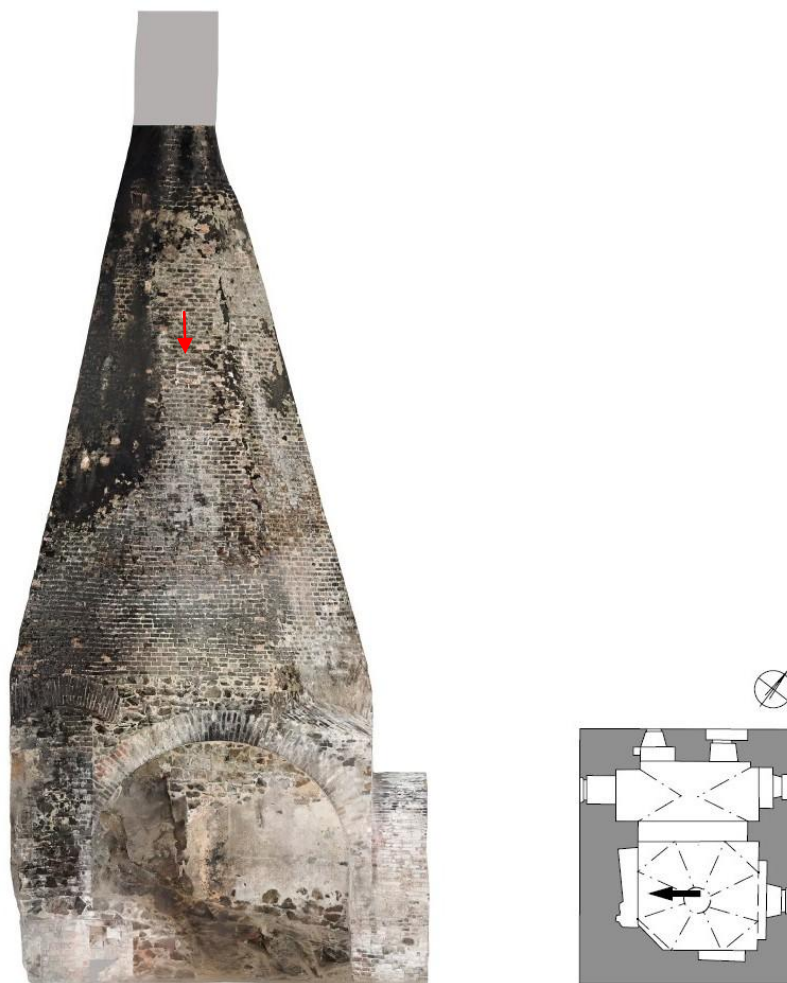
Obr. 32: Ortofoto jihozápadní stěny kuchyně. Šipka označuje polohu zazděného otvoru. Na obr. Je vidět rozdílný sklon stěn oktogonu a odlišnou výši jižního pasu (vlevo) a západního trompu (vpravo). Hlavenka, Sýkora 2018.
