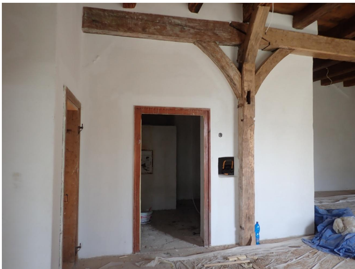
Obr. 96: Kuchyně 4. Vstup do kuchyně 4, vpravo od vstupu osvětlovací okénko.
