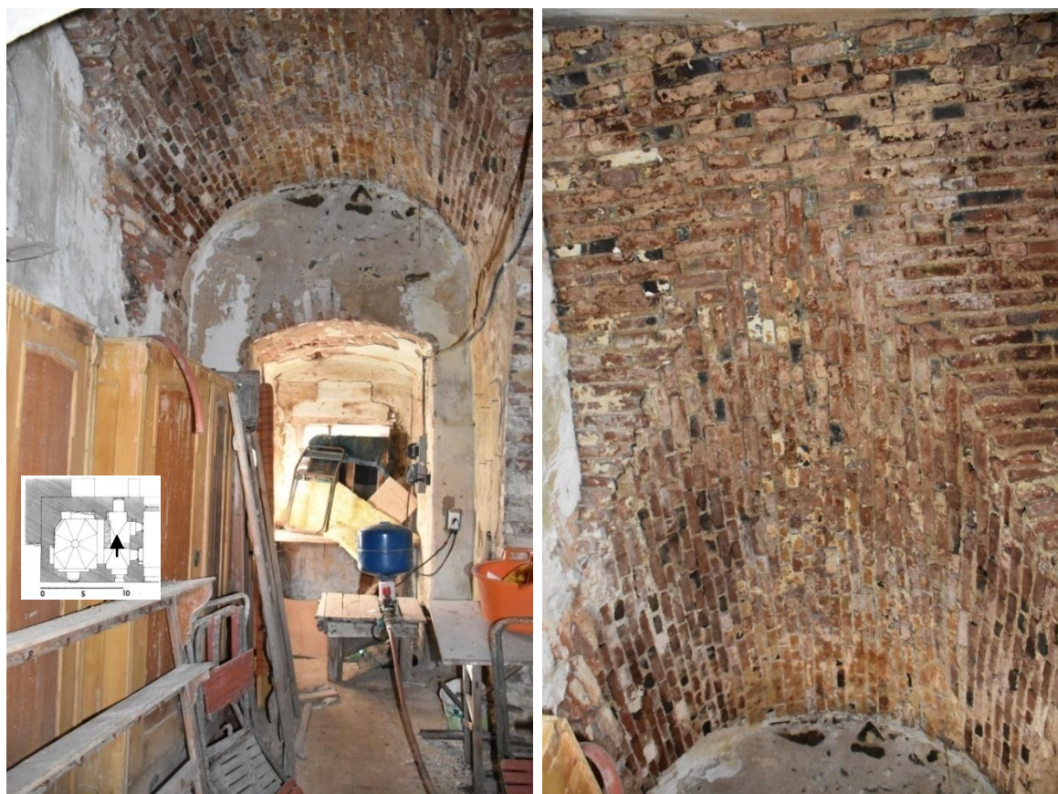
Obr. 22: Přípravna, severovýchodní část se zalděným vstupním portálem a lunetou nad ním. Foto F. Kolář.
