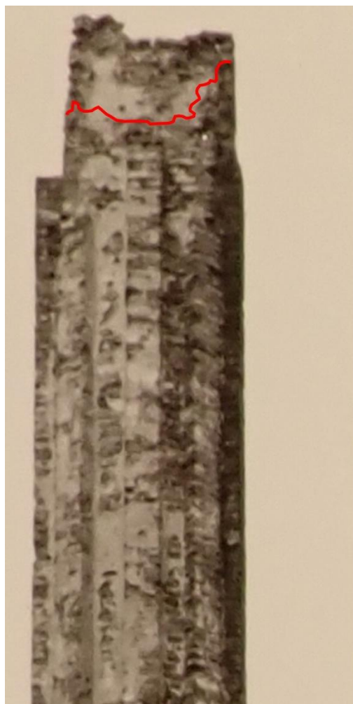
Obr. 43: Ústí komína, srovnání stavu zdiva na fotu v archivu NPÚ-ÚP z let 1920-1940, negativ i.č.
