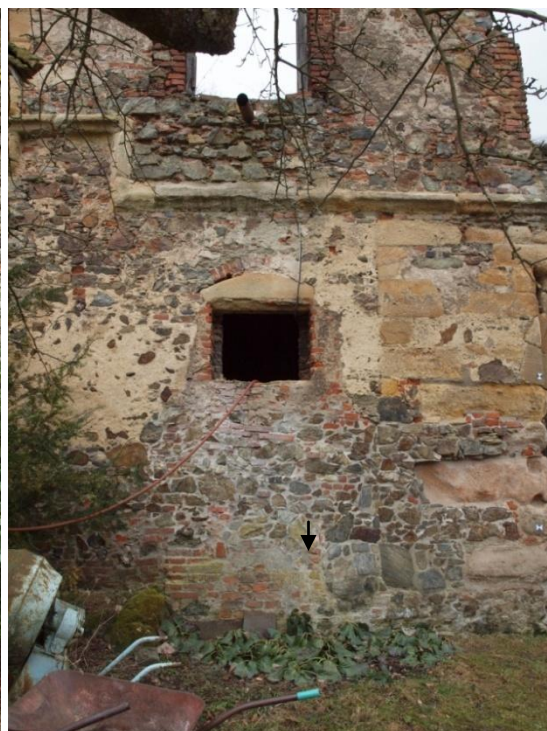
Obr. 12: Okna vedoucí do předhradí, vlevo u kuchyně, vpravo z přípravný. Šipka označuje záklenek nad, dnes již neexistující, výlevkou .
