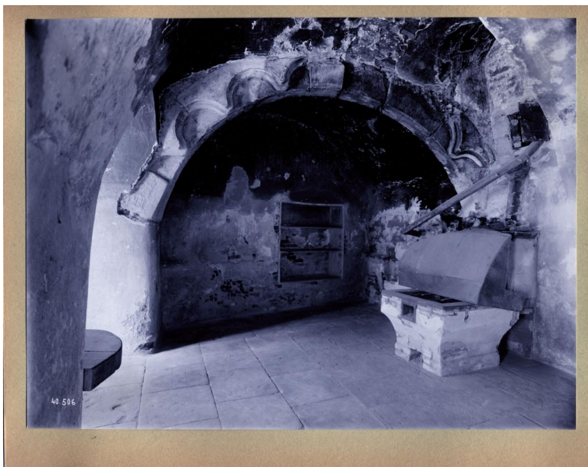
Obr. 24: Kuchyně 1, foto v archivu NPÚ-ÚOP v Kroměříži (údaje k fotu: SÚPPO Praha, inv.č. 45519, neg.č. 40506). Datace neuvedena.
