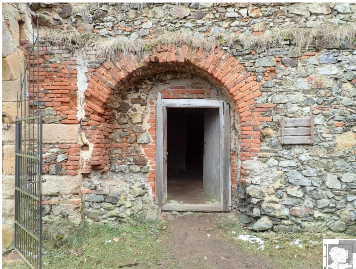
Obr. 18: Mladší vstup do přípravný z průjezdu průrazem skrz někdejší niku sedile. Foto F. Kolář.
