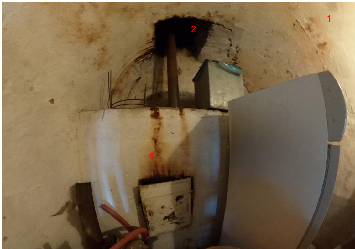
Obr. 99: Kuchyně 4. 1 - otisk příčky dělící kuchyni na část dymnou a část čistou, 6 - osvětlovací otvor vedle vstupu do kuchyně. Stav v r. 2019. Výřezy ze snímků sférické foto-kamery.
