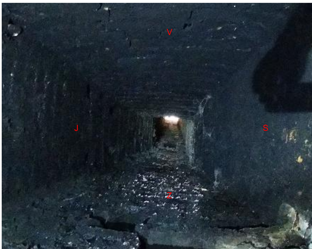
Obr. 54: Kuchyně 3. Pohled do DČK, výřez, na kterém je vidět rozdílný přechod z šikmé stěny DČK do stěny svislé. Písmena označují světové strany.
