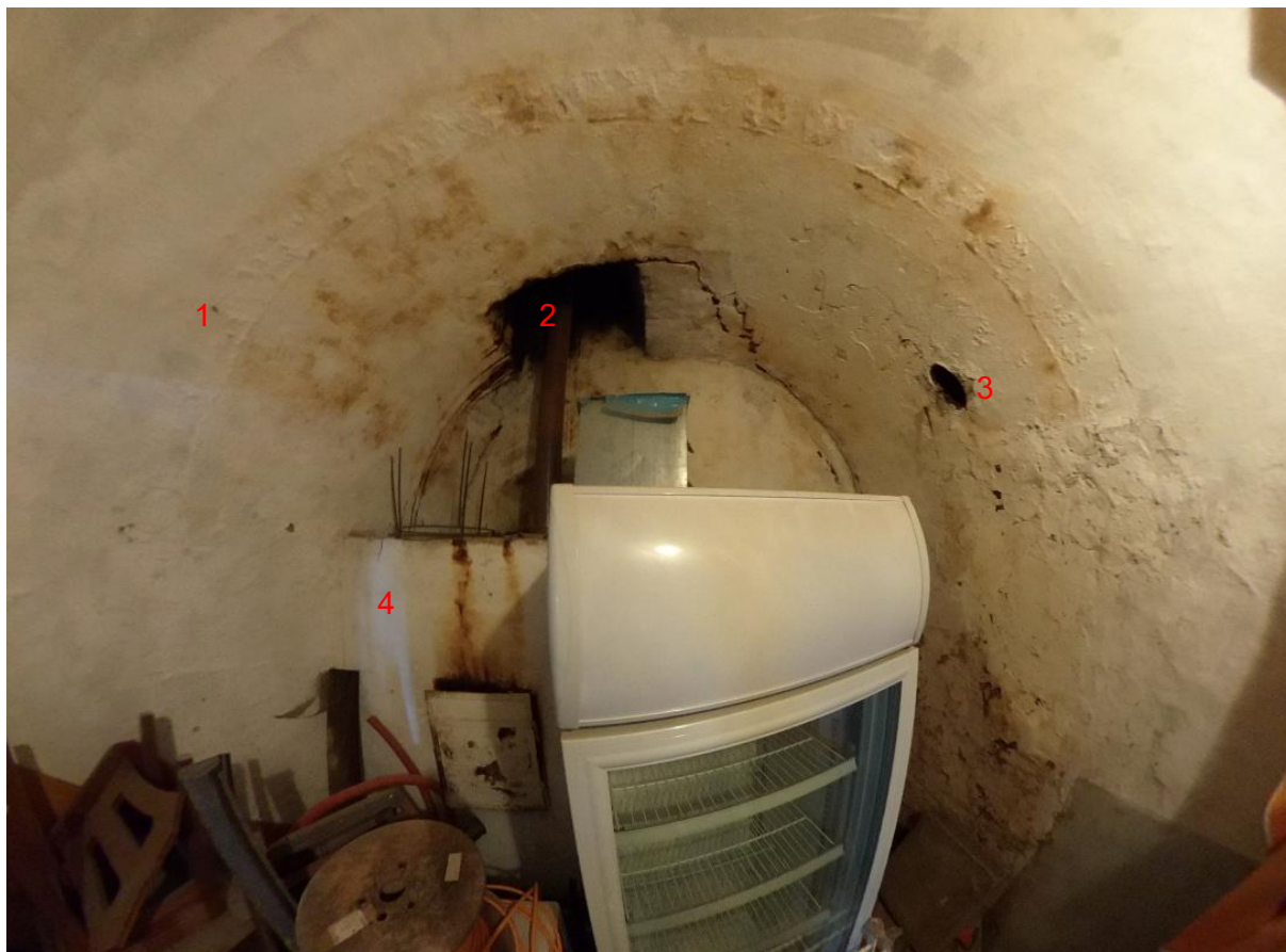
Obr. 98: Kuchyně 4: 1 - otisk přičky dělicí kuchyni na část dymnou a část čistou, 2 - ústí komína, 3 - otvor po komínové trubce, 4 - pec, 5 - výklenek, ze kterého byla obsluhovaná kamna v místnosti 106. Stav v r. 2019. Výřezy ze snímků sférické foto-kamery.
