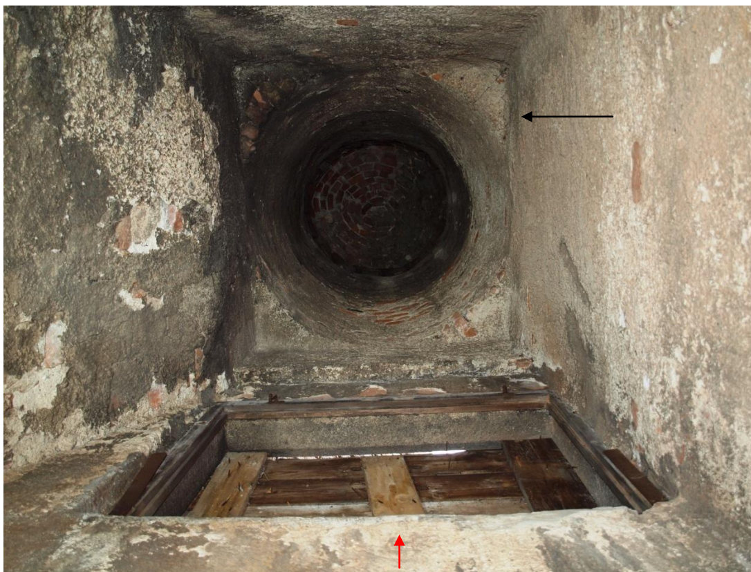
Obr. 12: Kuchyně 1A. Interiér dýmníkové části a nad ním svislé části komína kuchyně 1A. Červená šipka označuje ostění novodobého osvětlovacího otvoru. Černá šipka označuje jeden ze 4 pendentivů, které převádějí čtyřboký tvar komína na kruhový.
