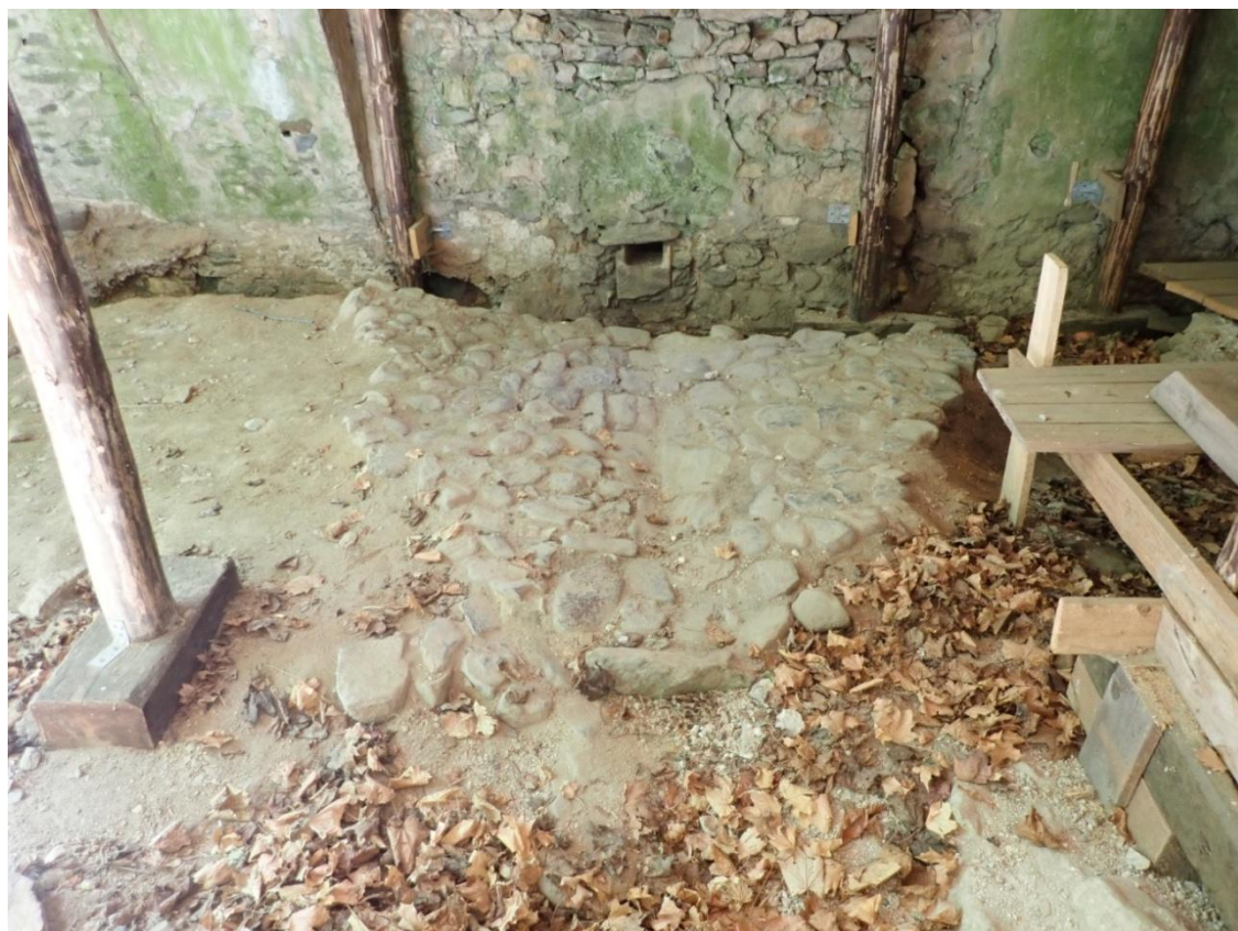
Obr. 28: Výlevka v severozápadní stěně a vyspádovaná dlažba, stav květen 2022
