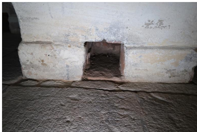
Obr. 29: Kuchyně I. Ústí šachtového topeniště (vlevo) a ústí topeniště ve sporáku (vpravo). Uvnitř je vidět cihlový základ sporáku.
