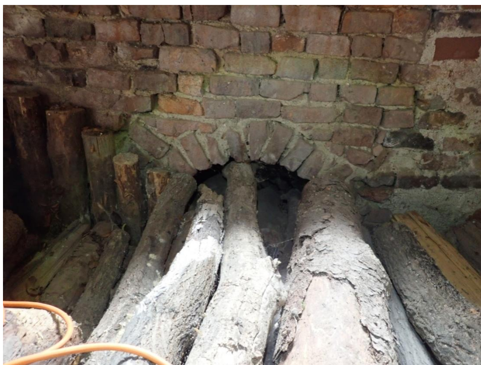
Obr. 25: Přípravna, záklenek otvoru pro výlevku ve zdi pod oknem do předhradí.
