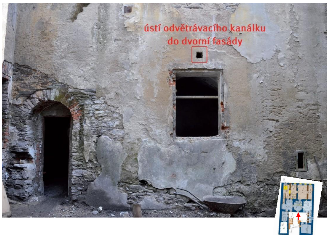
Obr. 7: Kuchyně 1, ústí odvětrávacího kanálku. Podle Zeman, Kratochvílová 2014.
