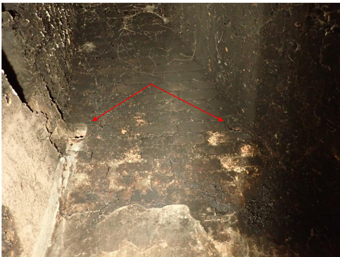
Obr. 90: Kuchyně 3. Otvory pro trámy v severní stěně.
