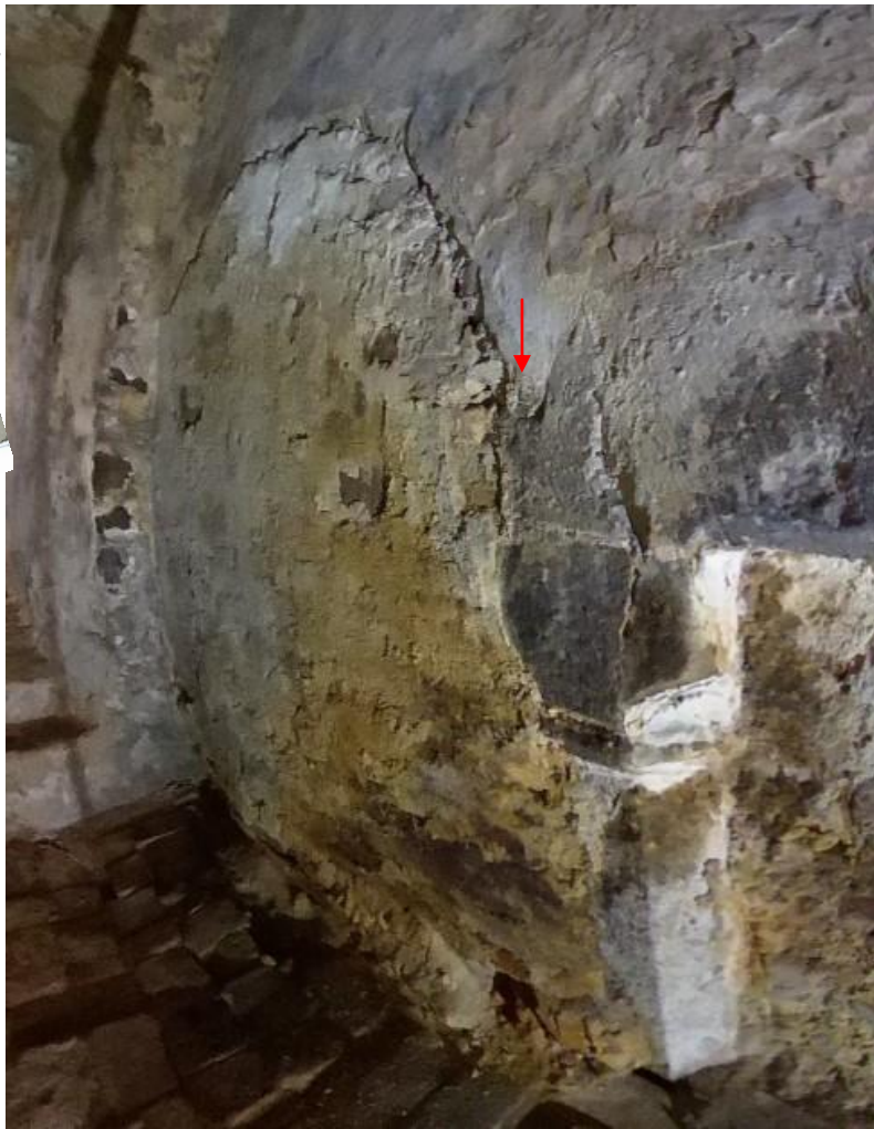
Obr. 18: Kuchyně 2. Vybouraný překlad ze vstupní strany DČK (mezi sloupy 1-6) použitý v mladší konstrukci.
