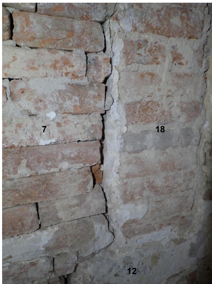
Obr. 61: Kuchyně 3. Omítka severní špalety staršího okna za zadržkou.
