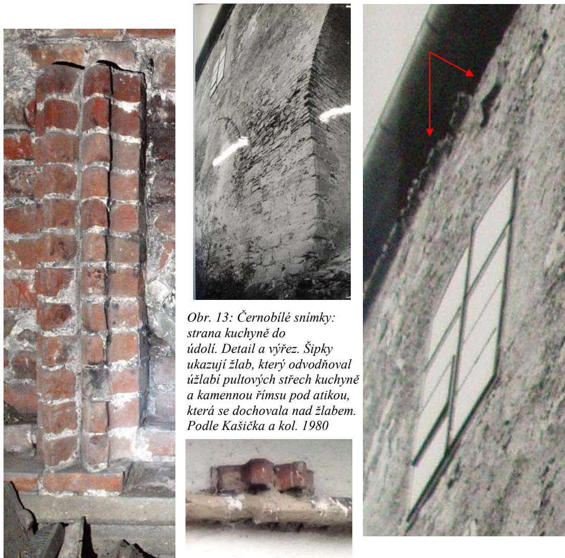
Obr. 14: Barevné snímky: Východní strana kuchyně. Kamenná římsa vystupující z fasády, nad ní část sloupku, snímek a výřez. Foto dochovaného sloupku na půdě.
