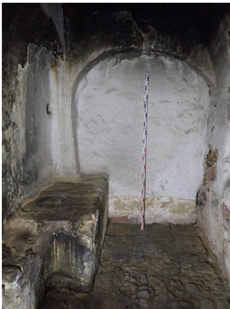
Obr. 78: Kuchyně 3. Pohled na severní stěnu kuchyně.
