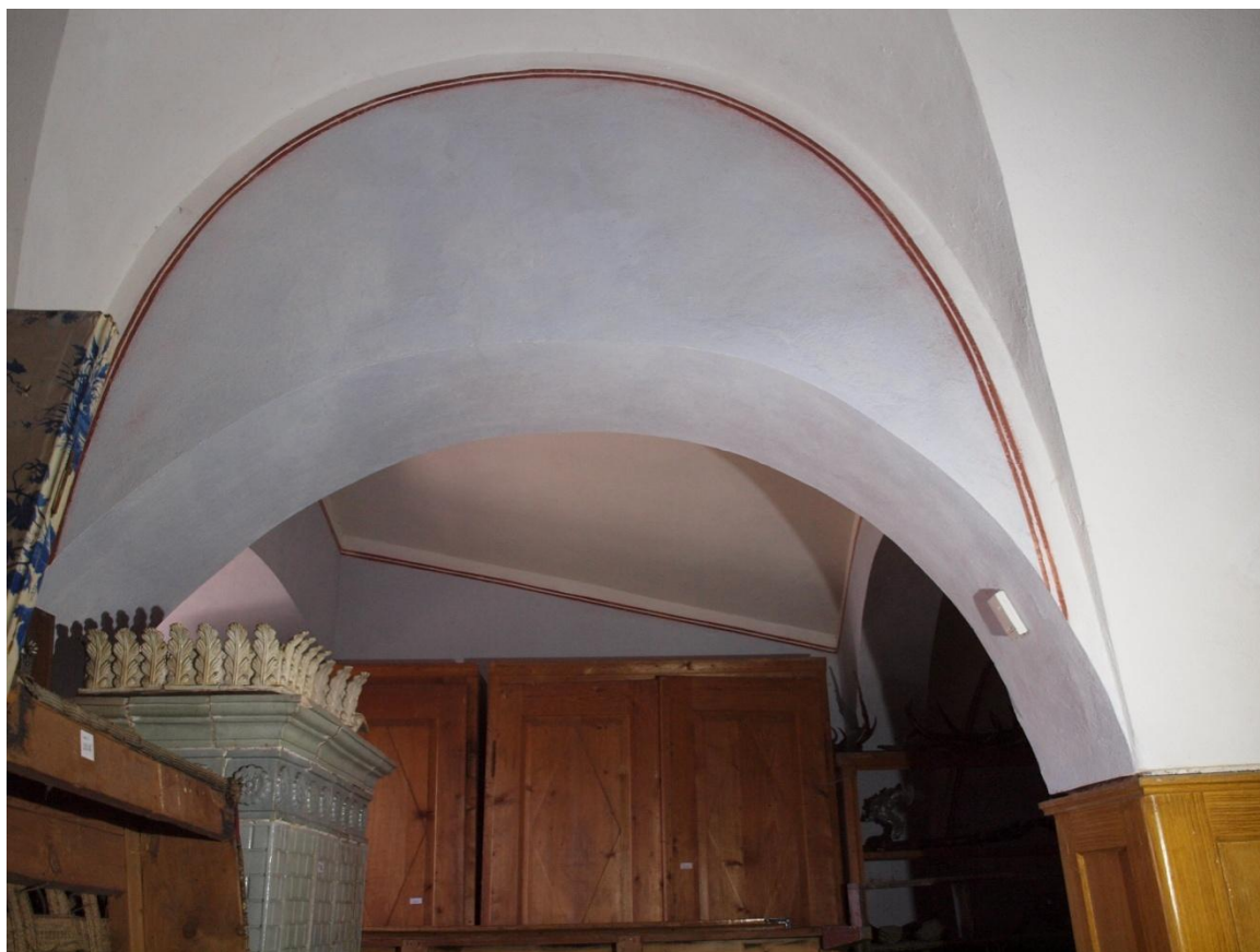
Obr. 2: Stoupající segmentová klenba
