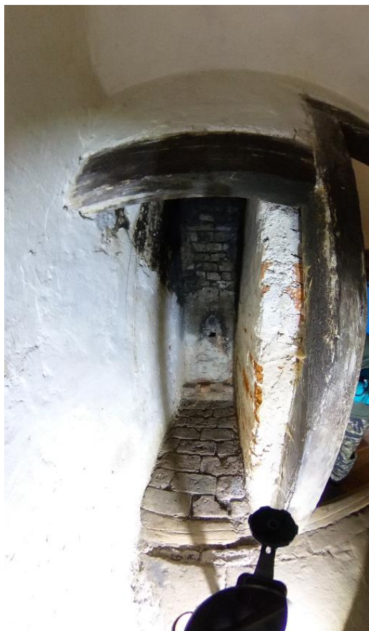
Obr. 19: Kuchyně 1. Příkládací prostor do kamen v místnosti č. 18. Výřez ze snímku sférické foto-kamery.
