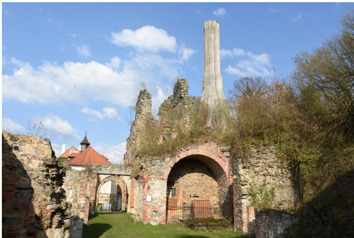
Obr. 20: Jihozápadní strana kuchyně, vstup do přípravný z nádvoří s obloukem mladší pavlače, která respektuje a zároveň i chrání dveře. Foto F. Kolář.
