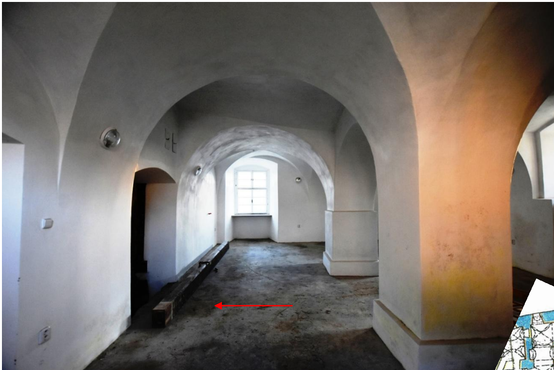
Obr. 7: Pohled do kuchyně. Šipka označuje komín. Foto F. Kolář.
