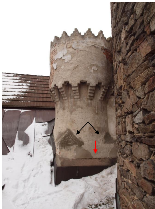
Obr. 7: Komín kuchyně 1A nad střechou paláce. Červená šipka označuje ostění osvětlovacího okna vloženého do DČK v době, kdy už byla kuchyně mimo provoz, černé šipky označují ruby pendentivů, které převádějí čtverhranný obvod DČK na kruhový. Nahoře na komíně ozdobná hlavice.
