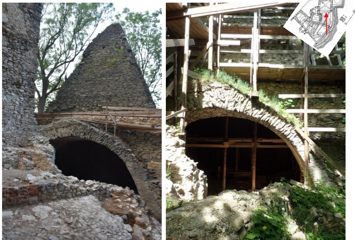
Obr. 4: Pohled na vstup do kuchyně, v popředí torzo valené klenby, vlevo stav 2018 (foto F. Kolář), vpravo stav 2022.
