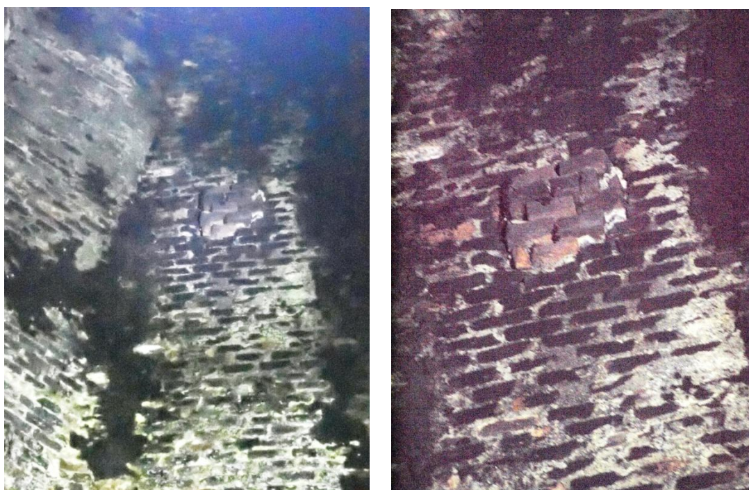
Obr. 35: Zazděný otvor v severozápadní stěně oktogonu
