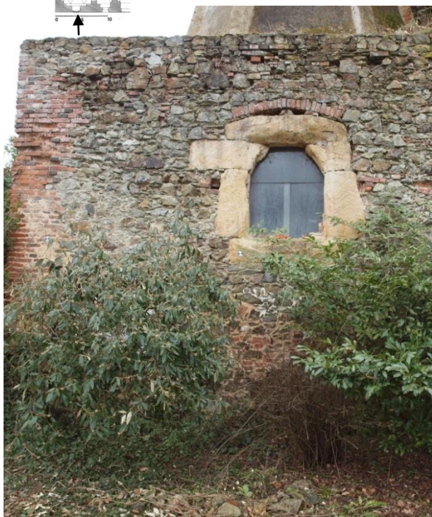
Obr. 12: Okna vedoucí do předhradí, vlevo u kuchyně, vpravo z přípravný. Šipka označuje záklenek nad, dnes již neexistující, výlevkou .
