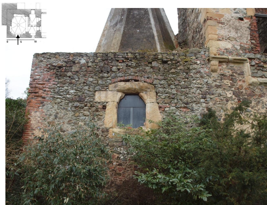
Obr. 7: Zakončení římsy na obytné budově pozdně gotického křídla a navazující zdivo kuchyně.
