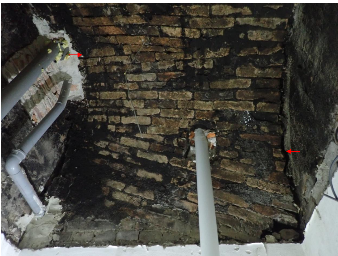
Obr. 125: Prostor napojený na komín 1. Západní strana klenby kuchyně, šipky označují vložené vyrovnávací řady cihel v klenbě.
