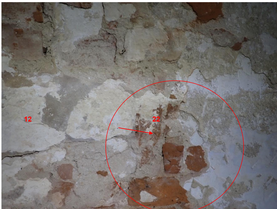
Obr. 65: Kuchyně 3. Úlomky cihel a cihla vedle pískovcového parapetu, označená cihla nastojato.
