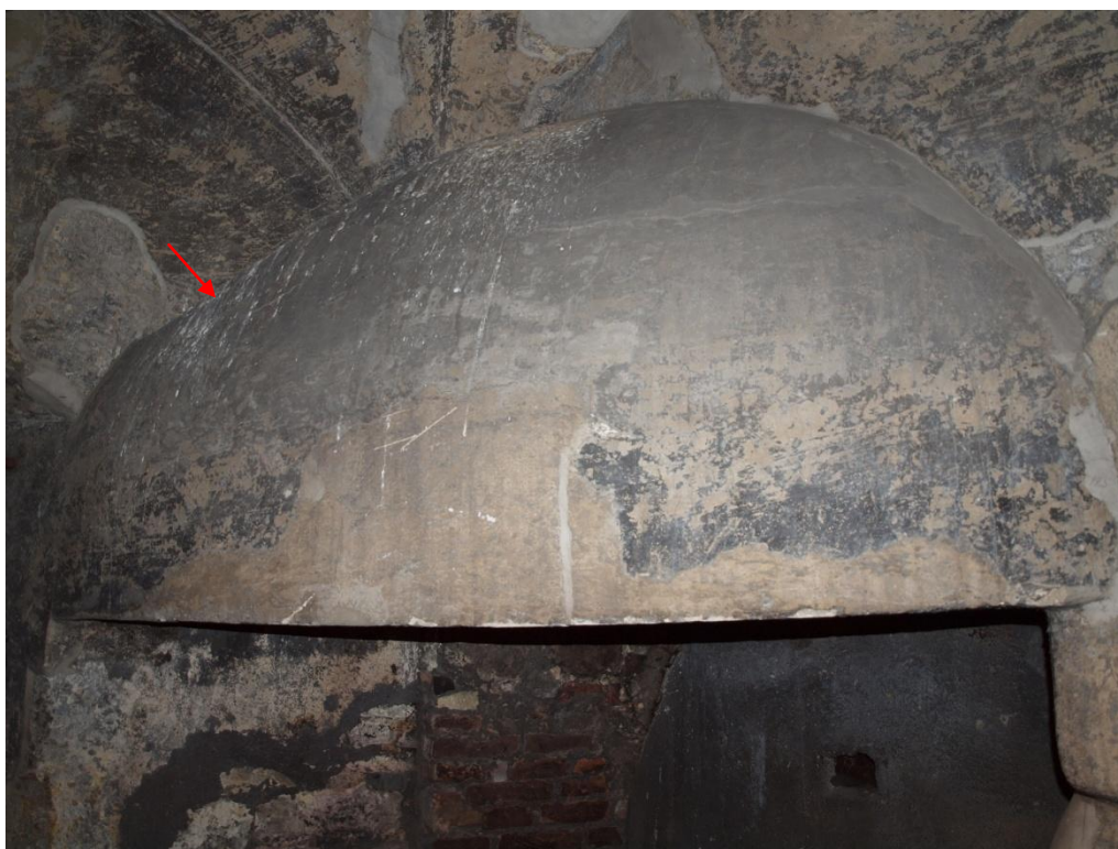
Obr. 13: NP3. Mladší dýmník. Šipka označuje místo, kde se dochoval náběh omítky po starším dýmníku
