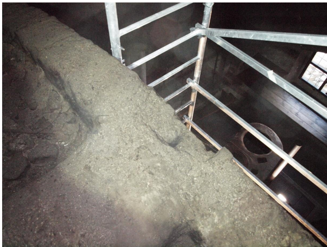
Obr. 29: Kuchyně 2. Vyšší ochoz nad vstupem, pas a jeho zpevňující zídka (?).
