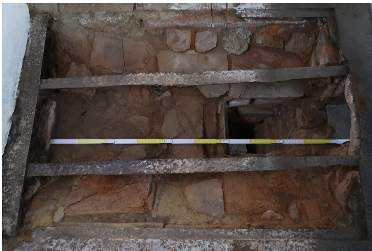
Obr. 30: Kuchyně I. Pohled do topeniště sporáku od jihu, novodobý kryt nahrazující původní pláty je sejmutý. Foto M. Biedermanová.
