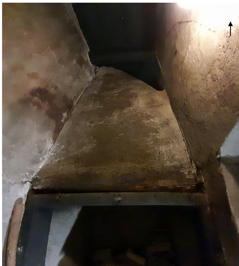
Obr. 105: Kuchyně 5. Pohled na DČK podepřenou trámem, pod ním dřevěný rám na uzavření topeniště.
