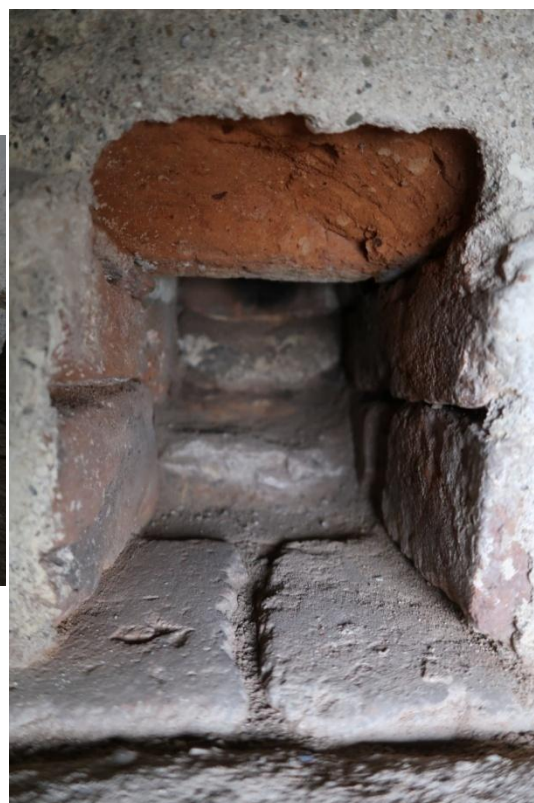
Obr. 29: Kuchyně I. Ústí šachtového topeniště (vlevo) a ústí topeniště ve sporáku (vpravo). Uvnitř je vidět cihlový základ sporáku.
