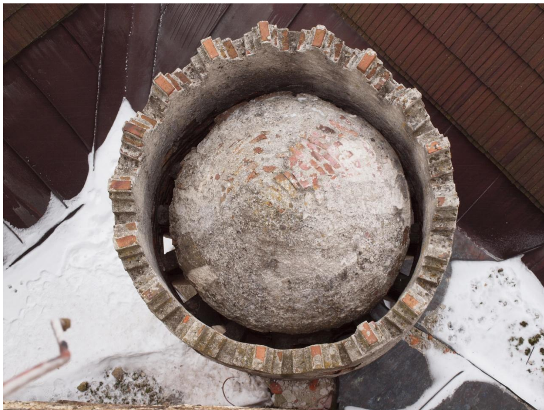
Obr. 9: Kuchyně IA, hlavice komínu, pohled z velké věže.
