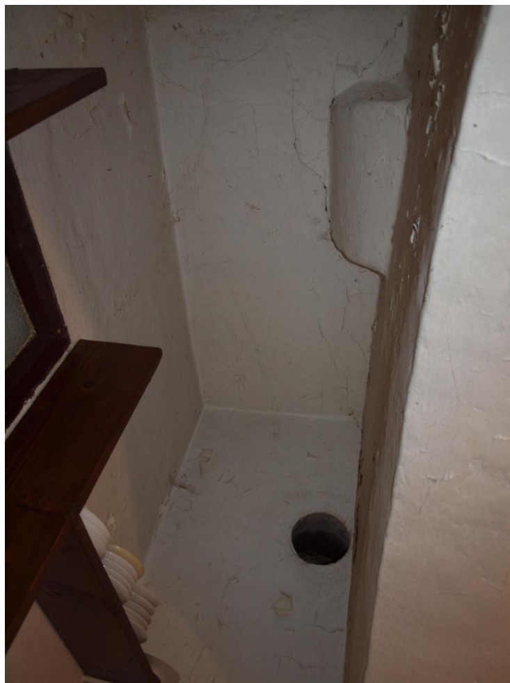
Obr. 9: Konzola podpirající pas v prostoru kuchyňky, která je součástí obchodu. Kuchyňka je vložena do prostoru vybouraného v hradbě
