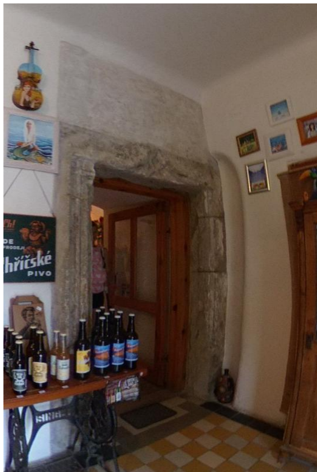
Obr. 12: Objevené zadržné podávací okno, které vedlo do dýmné části kuchyně.
