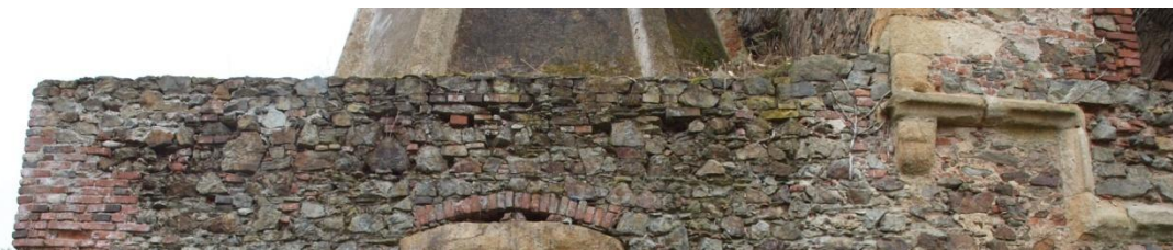
Obr. 9: Zakončení římsy na obytné budově pozdně gotického křídla a navazující zdivo kuchyně. Koruna zdiva byla opravená.
