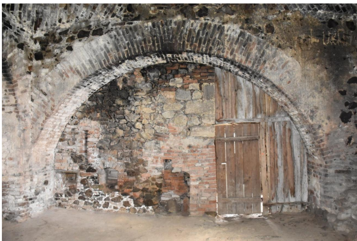
Obr. 31: Pas mezi kuchyní a přípravnou, za pasem mladší příčka s příkládacím otvorem pece. Foto F. Kolář.
