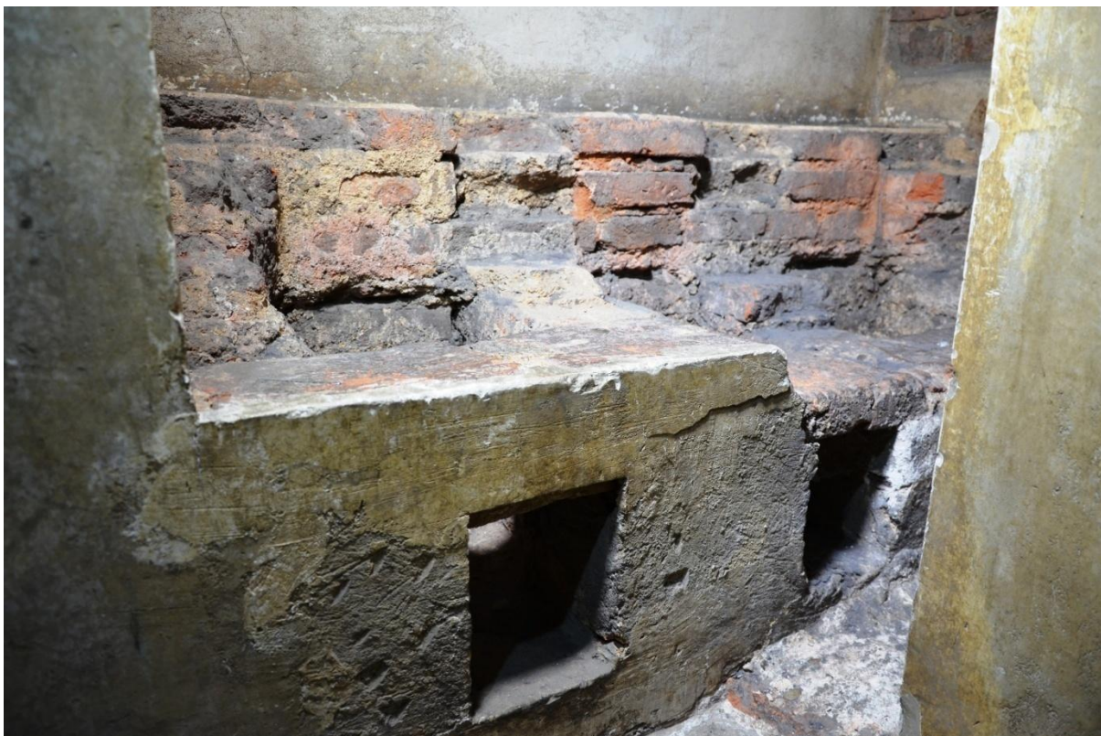
Obr. 30: NP4. Konstrukce niky s topeništěm a pozůstatky zazdivky niky. Pískovce z pravé strany krbu
