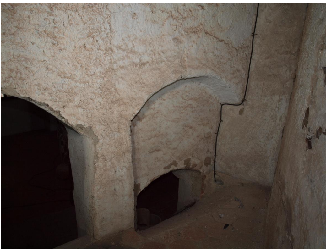
Obr. 5: Kuchyně 1A, propojení kuchyně 1A s kuchyní 1B.
