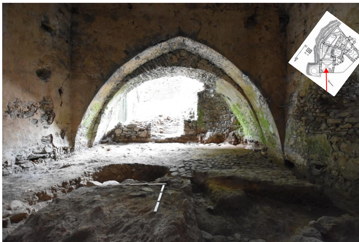
Obr. 5: Lomený pas v jihozápadní stěně kuchyně, za ním torzo valené klenby a mladší zdivo, foto F. Kolář 23/7 2018.
