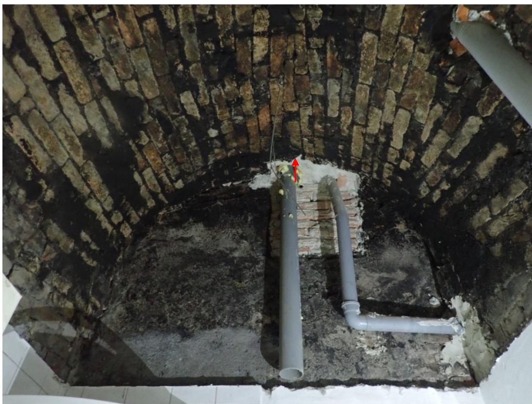
Obr. 124: Prostor napojený na komín 1. Jižní čelo klenby pod komínem se zazděnou nikou tvořící vstup do komína. Šipky označují vložené vyrovnávací řady cihel v klenbě.
