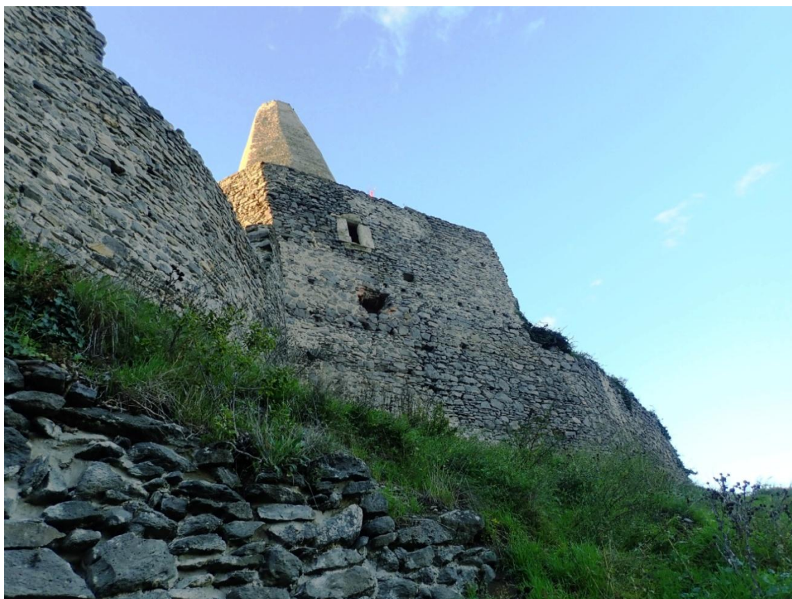
Obr. 16: Jižní stěna kuchyně ze svahu pod hradním jádrem.
