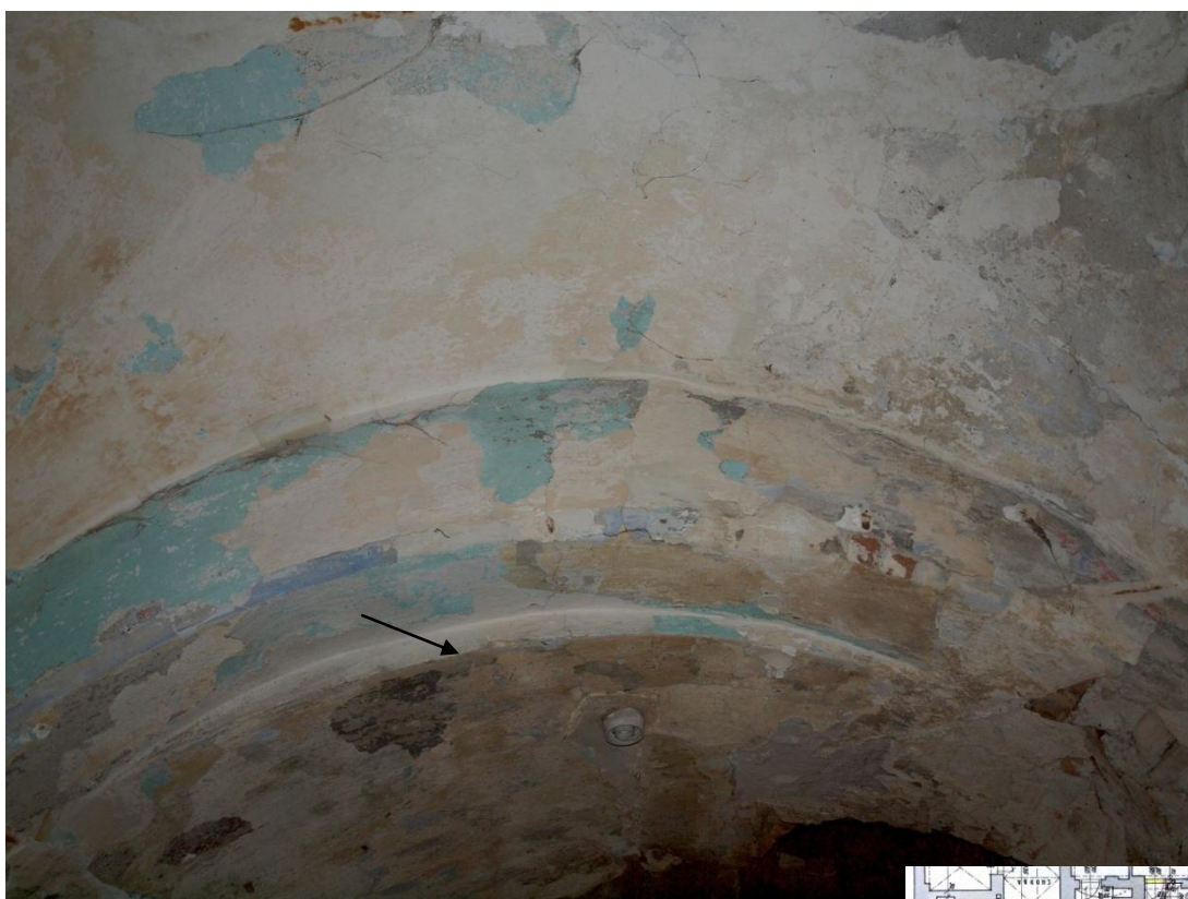
Obr. 3: Kuchyně I, pas oddělující čistou a dýmnou část kuchyně, šipka označuje mladší valenou klenbu přesahující pas.
