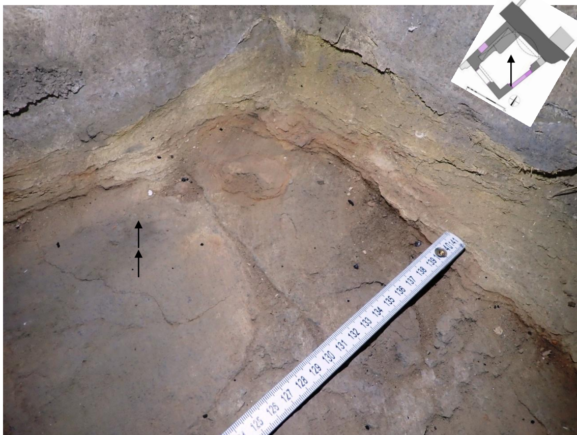
Obr. 75: Kuchyně 3. Podesta na vaření, detail.
