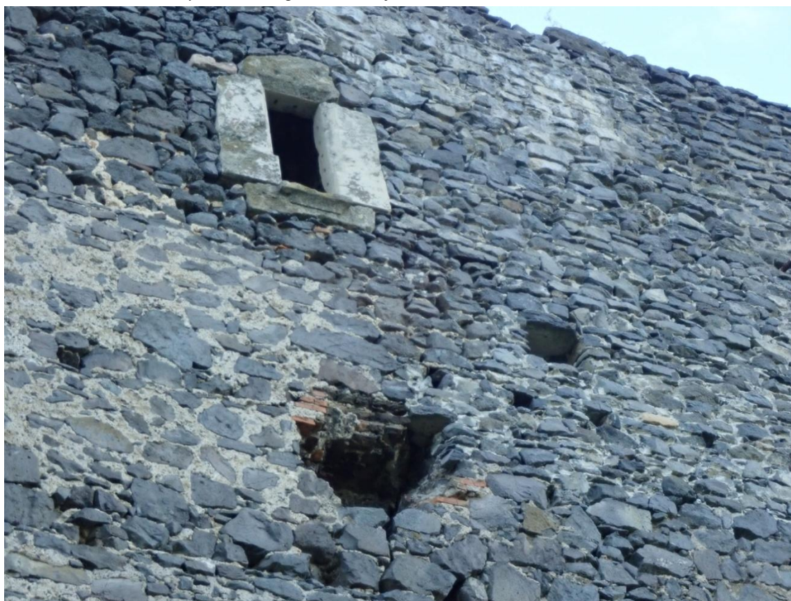
Obr. 17: Jižní stěna kuchyně ze svahu pod hradním jádrem, detail. Odshora okno, otvor po odlomeném žlábků výlevky, větrací okno sklepa.
