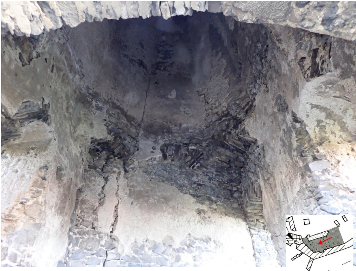
Obr. 18: Tropa v jihozápadním a severozápadním rohu kuchyně a pas mezi nimi.
