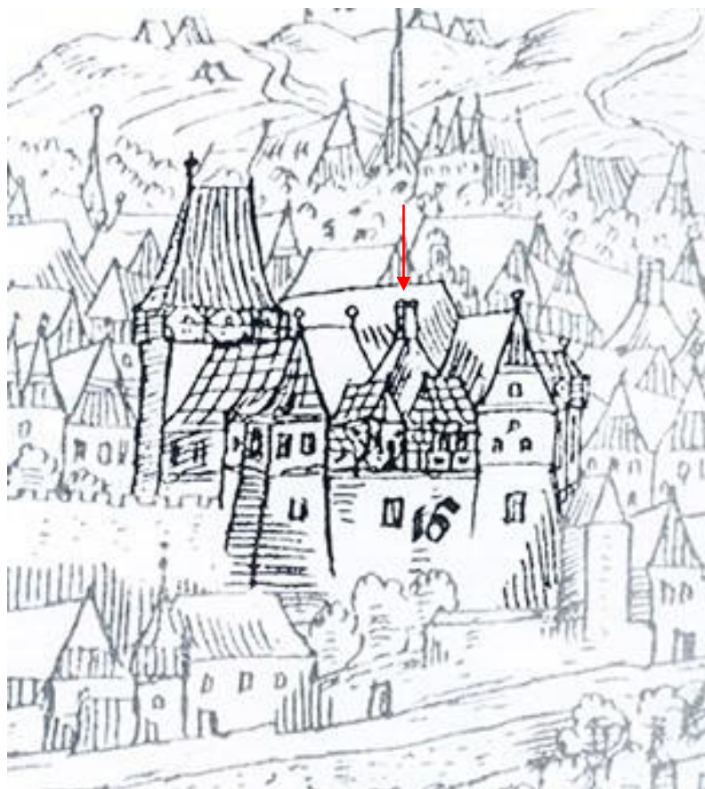
Obr. 17: Kutná Hora Hrádek. Výřez z veduty města J. Willenberga, kol. r. 1600. Černá šipka označuje dýmníkový komín kuchyně. Podle: Kutnohorsko - Vlastivědný sborník 10/08.
