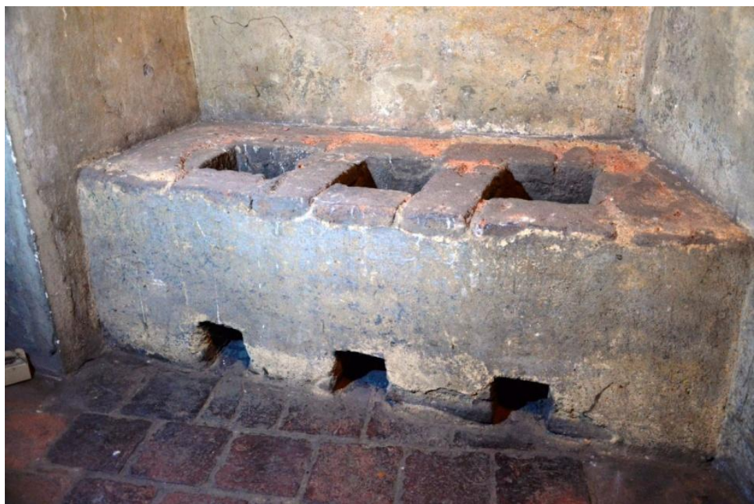
Obr. 6: Pražský hrad, 5. podlaží, šachtové topeniště.
