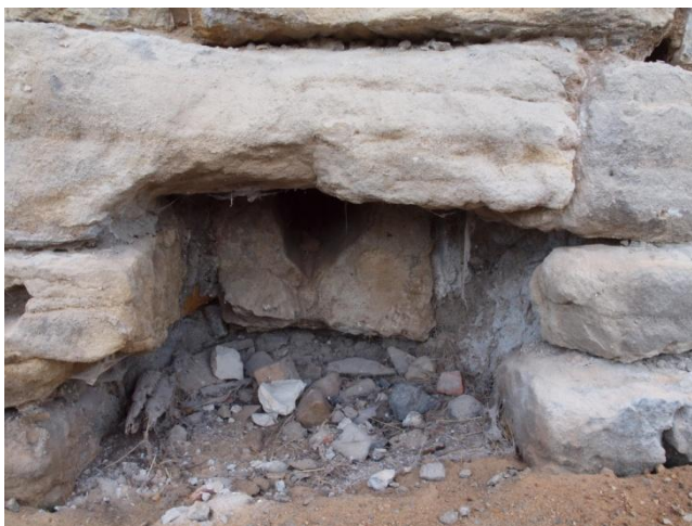
Obr. 27: Hrad Kost. Výlevka z kuchyně z 1/4 16. století, nasměrovaná do parkánu, zachovala se jen část ve zdivu.
