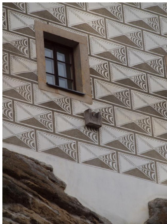
Obr. 28: Výlevka z 2/4 16. století vytesaná v bloku pískovce, umístěná pod oknem kuchyně v Biberštejském paláci na hradě Kost.
