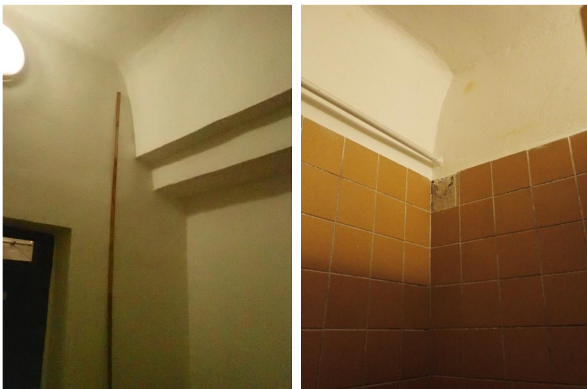
Obr. 45: Pardubice Zámecká čp. 18. NP2, místnosti 202, 203 mají plochý strop, pod ním jsou v místnosti 203 na stěně směrem k chodbě 207 náběhy na valenou klenbu. Náběhy na klenbu, které se dochovaly na stěně k chodbě, nejsou na protější stěně v místnosti 202 tj. na obvodové zdi domu. To ukazuje na existenci stoupané valené klenby.
