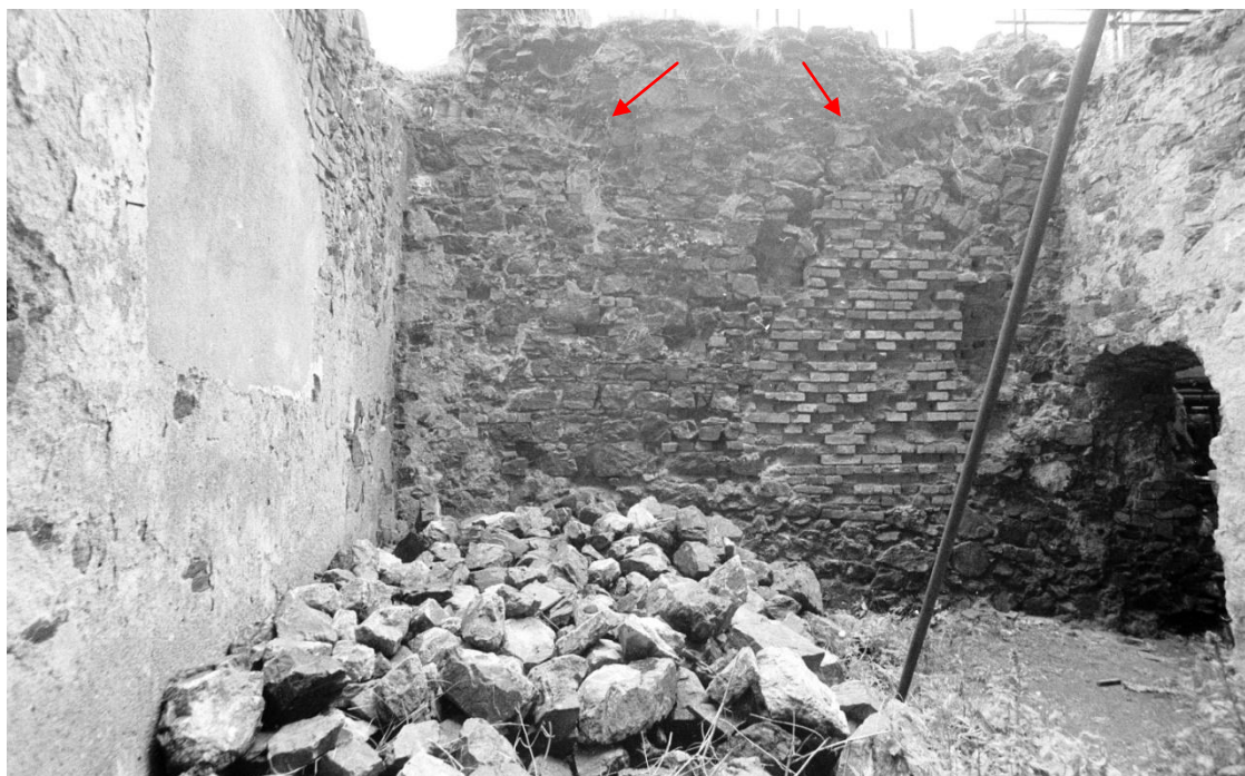
Obr. 6: Švihov, stěna kuchyně. Šipky označují pozůstatky cihlových trompů. Stav 1984.
