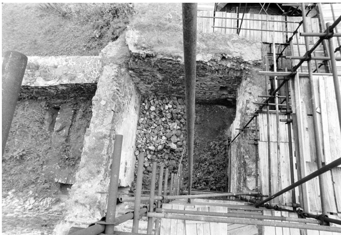
Obr. 9: Švihov, pohled do kuchyně z lešení. Stav 1984.
