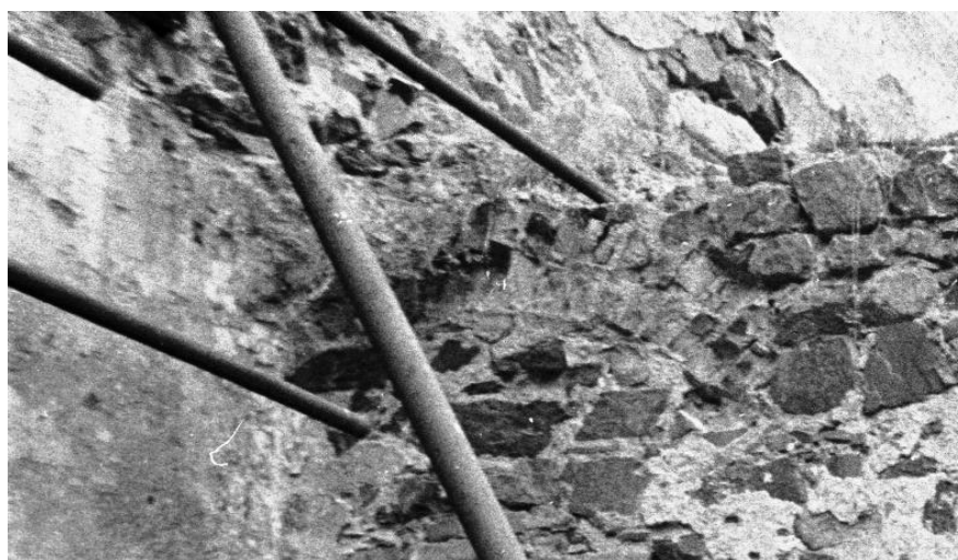
Obr. 6: Švihov, stěna kuchyně. Šipky označují pozůstatky cihlových trompů. Stav 1984.
