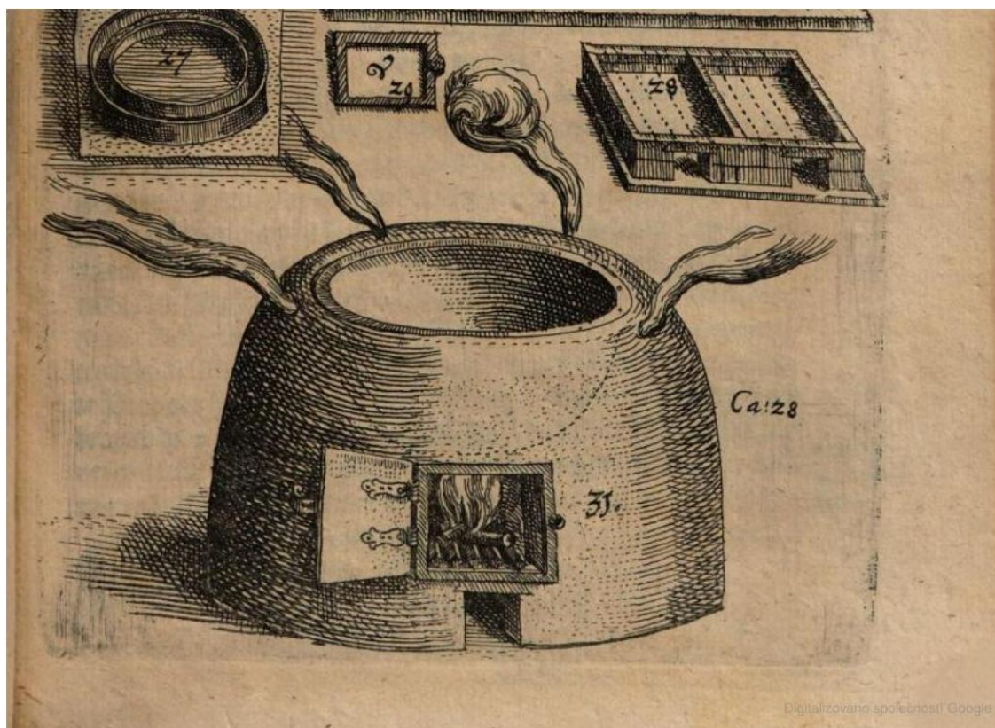
Obr. 15: Úsporná kamna pro velké kuchyně s uzavřeným topeništěm. Podle Kessler 1618, vyobrazení č. 31.
