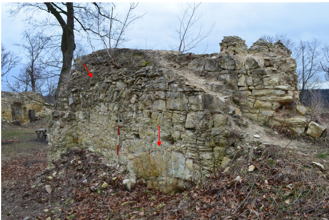
Obr. 4: Hrad Pravda, stěna kuchyně. Šipky označují pozůstatek trompu a vstup.
