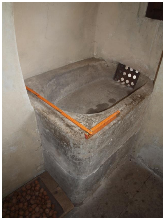
Obr. 28: Výlevka z 2/4 16. století vytesaná v bloku pískovce, umístěná pod oknem kuchyně v Biberštejském paláci na hradě Kost.
