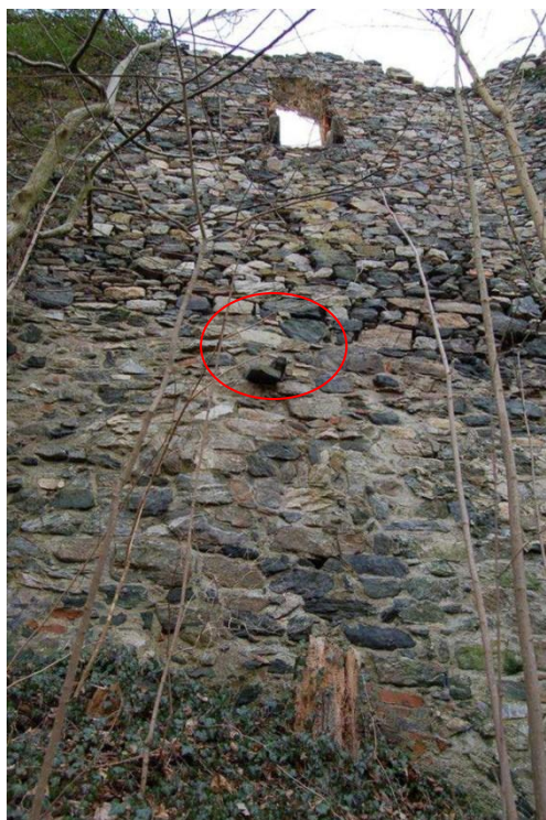
Obr. 26: Výlevka ze severní kuchyně hradu Weitenegg v Dolním Rakousku, 15. století, podle Geöninger, 2009, 79.
