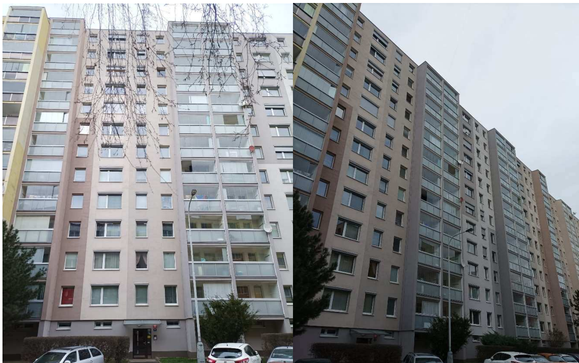
obr. 44 – bytový dům pro případovou studii měření ochlazování OV (panelový, 13.NP, Praha)
