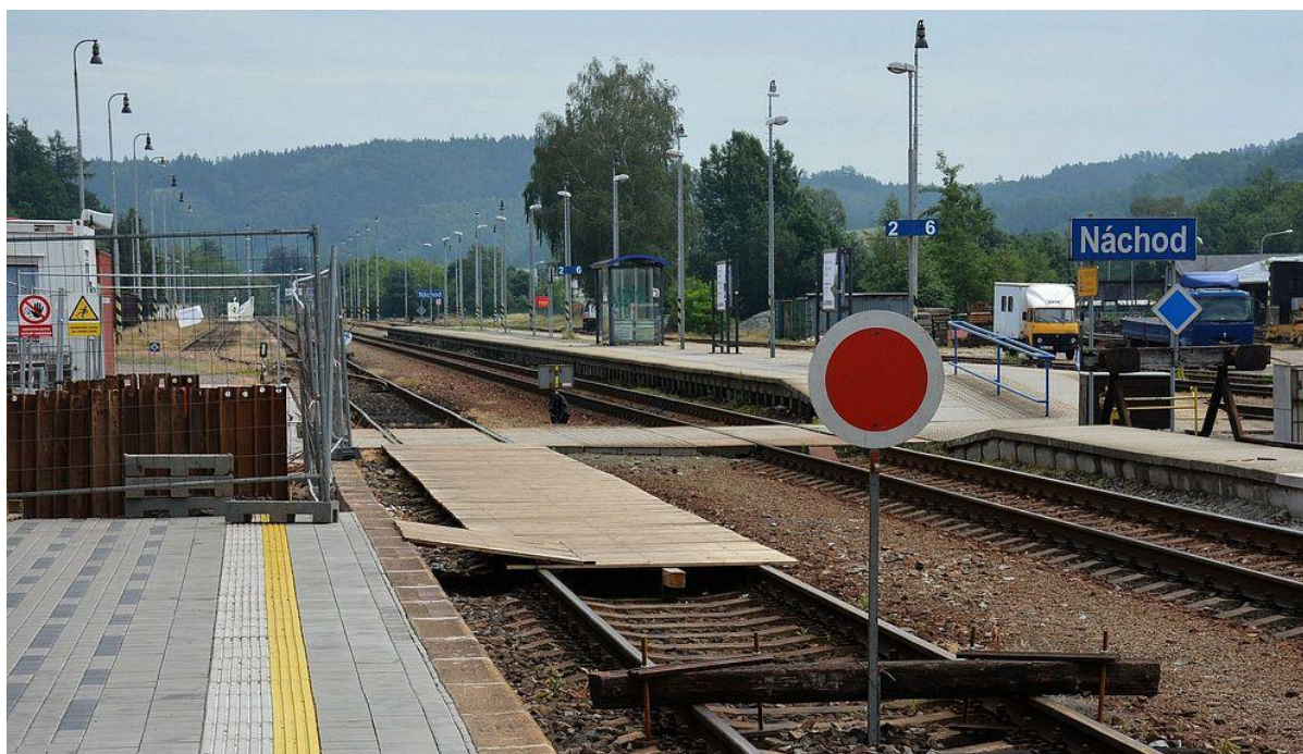
Obrázek 27: Ukázka provizorního přístupu na nástupiště v rámci stavby [34]
