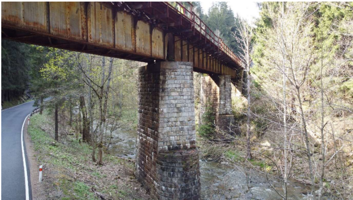
Figure 9.14: Bridge in km 4.256 Hanušovice – Staré Město pod Sněžníkem.
