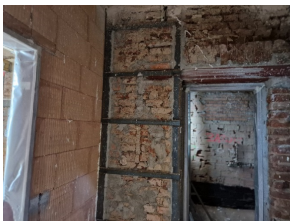
Foto č. 2: Zpevnění zděného pilíře ocelovou objímkou (autor: I. Šimůnek)
