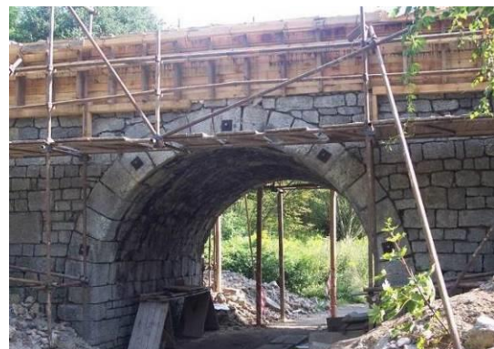
Obr. 91, 92. Praha – Hlubočepy, 19. století, realizace vrtů v klenbě pro příčná táhla, klenba s táhly.
