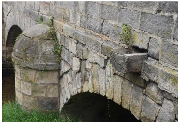
Obr. 115, 116. Zákupy, trhlinami narušený pilíř mostu a odtržené vysouvající se poprsní zdi nad klenbou.
