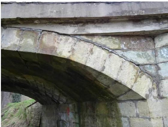
Obr. 109, 110. Městská Habrová, poruchy s trhlinami podél klenby.
