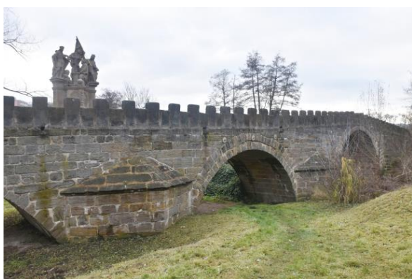
Obr. 49. Děčín, 1564-1569. Návodní strana. Předsazené zhlaví
