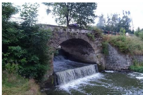
Obr. 13. Jezdovice – hrázní most u Jezdovického rybníku.
