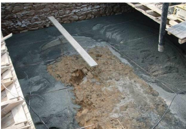
Obr. 101. Kouřim, 2. pol. 19. stol., realizace výplně z lehkého betonu nad klenbou.
