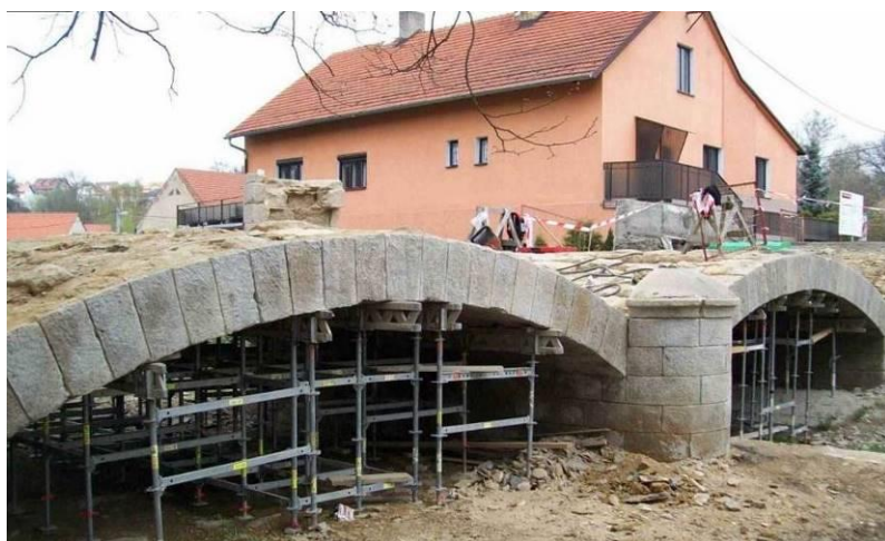
Obr. 95. Libeň, 1855, rekonstrukce kleneb mostu.
