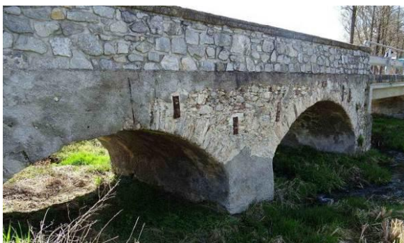
Obr. 93. Žichovice, 1. pol. 17. století, klenba s osazenými příčnými táhly.
