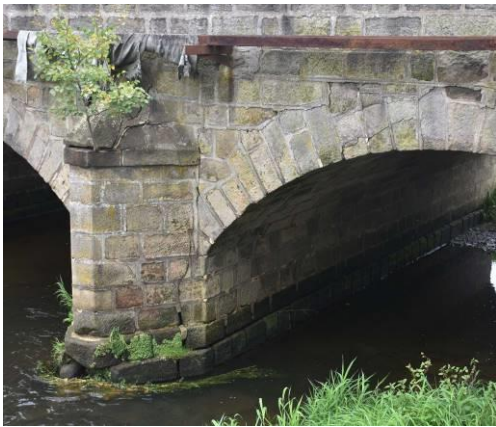
Obr. 115, 116. Zákupy, trhlinami narušený pilíř mostu a odtržené vysouvající se poprsní zdi nad klenbou.
