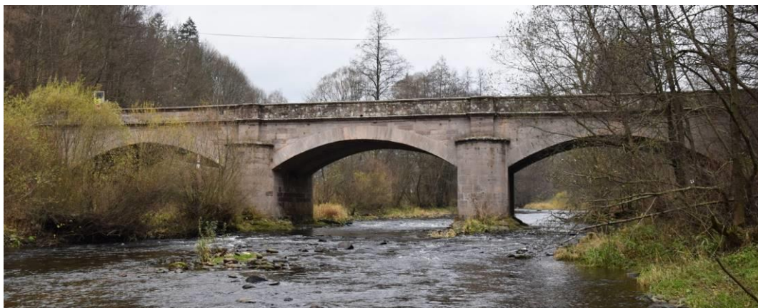
Obr. 105. Poniklá, pohled na most od jihu.
