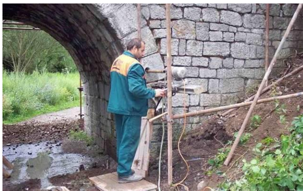
Obr. 91, 92. Praha – Hlubočepy, 19. století, realizace vrtů v klenbě pro příčná táhla, klenba s táhly.
