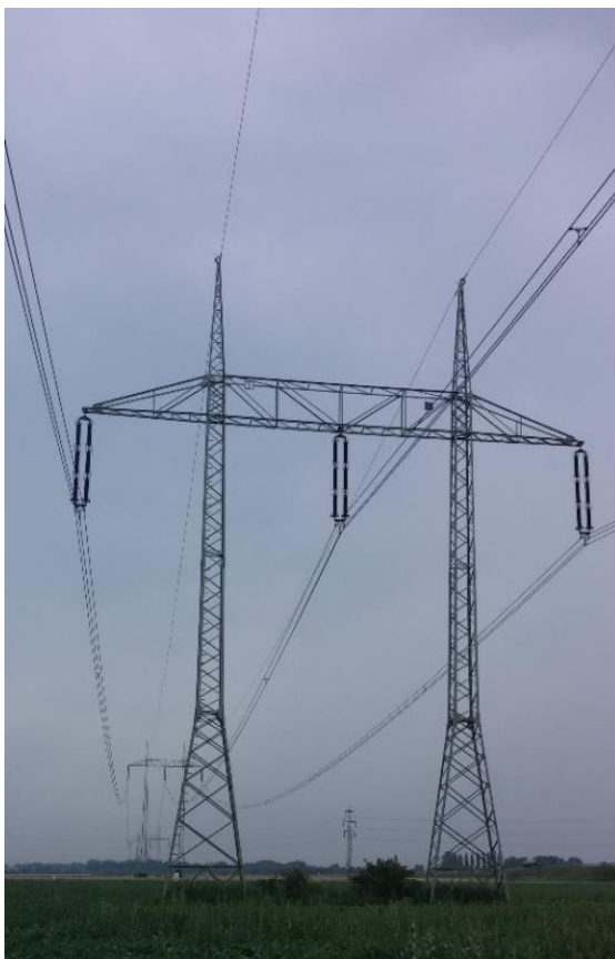
Obrázek 2.3: Konstrukce tvaru Portál
