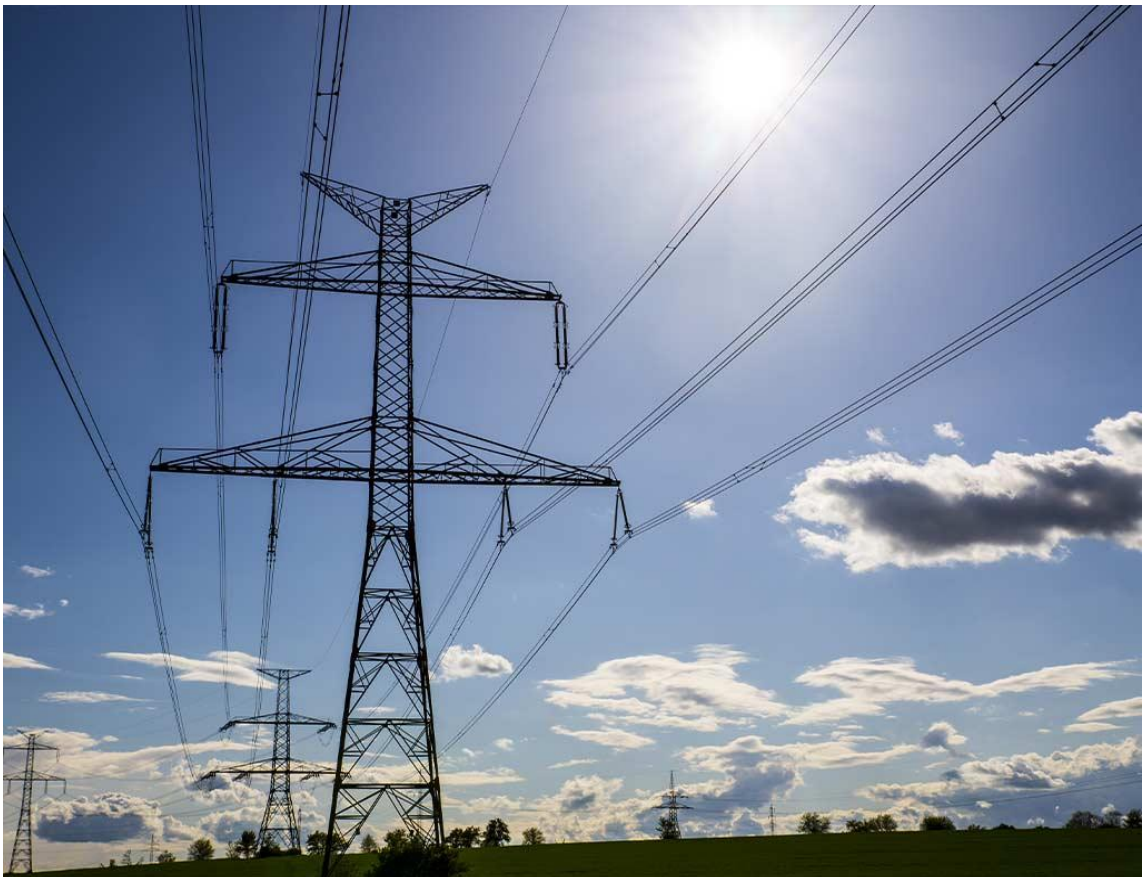
Obrázek 2.6: Konstrukce tvaru Dunaj
