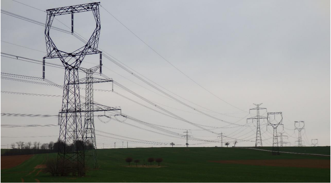
Obrázek 2.5: Konstrukce tvaru Delta
