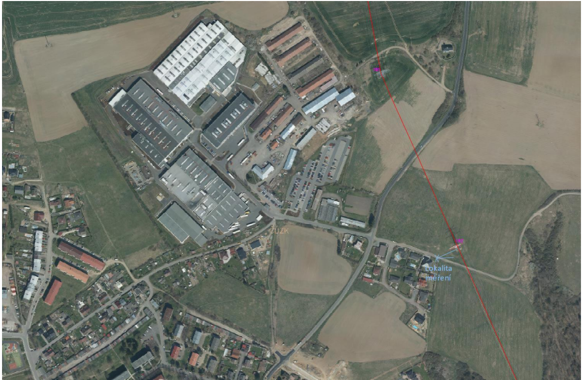
Obrázek 5.9: Lokalita měření hluku na vedení V490/491 – mezi stožáry č. 192 a č. 193 [24]
