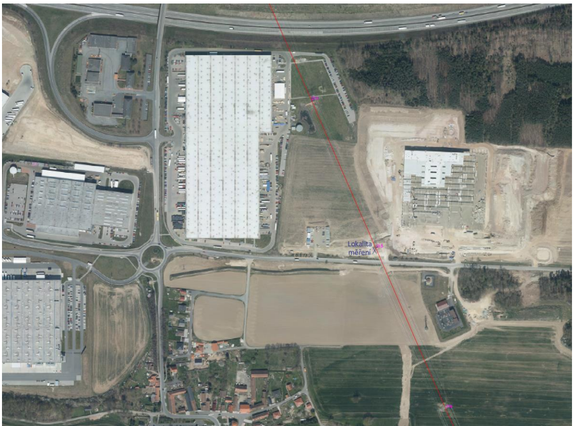
Obrázek 5.10: Lokalita měření hluku na vedení V490/491 – mezi stožáry č. 215 a č. 216 [24]
