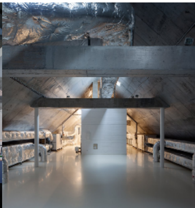
Obrázek 19 Půdní prostor s technickým zázemím
