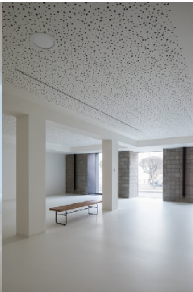
Obrázek 15 Galerie s perforovaným podhledem
