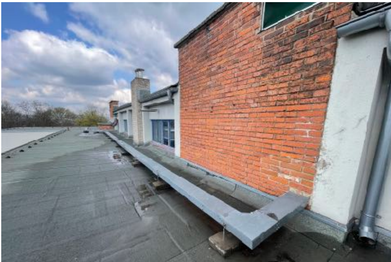
Obrázek 25 Pohled z Tyršovy ulice na rozvod chladicí jednotky DIODU
