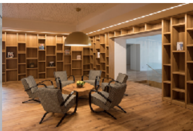
Obrázek 13 Kavárna s instalačním lemem podhledu
