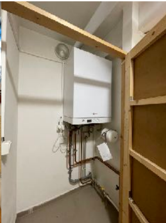
Obrázek 38 Plynový kondenzační kotel VIESSMANN Vitodens 11-W 26 kW s integrovaným zásobníkem 46l
