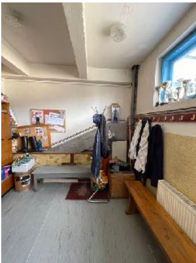
Obrázek 43 Rozvody otopné soustavy v kanceláři 2.NP (velké tepelné ztráty)
