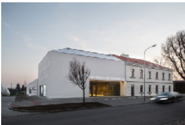
Obrázek 4 Městská hala Modřice a bývalá Sokolovna Modřice
