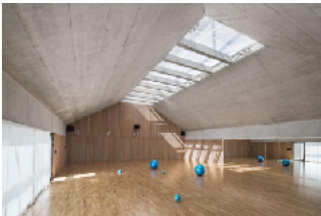
Obrázek 6 Vyústění vzduchotechniky v obkladu štítových zdí
