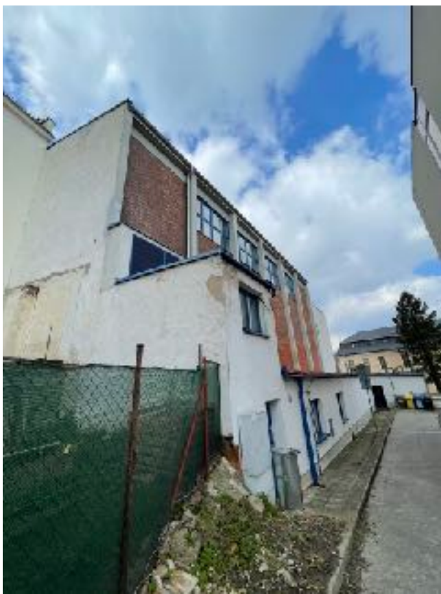
Obrázek 27 Pohled na zadní severovýchodní části objektu a stávající vyústění VZT DIOD
