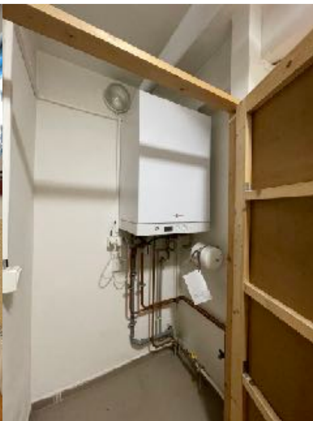
Obrázek 44 Plynový kondenzační kotel VISSMANN Vitodens 11-W 26 kW s integrovaným zásobníkem 46l
