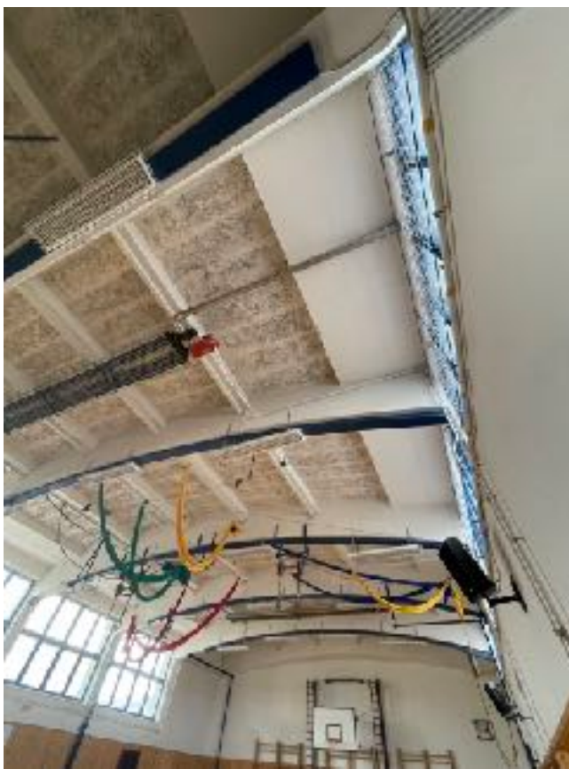
Obrázek 39 Pohled na stropní konstrukci a stávající plynové záříče
