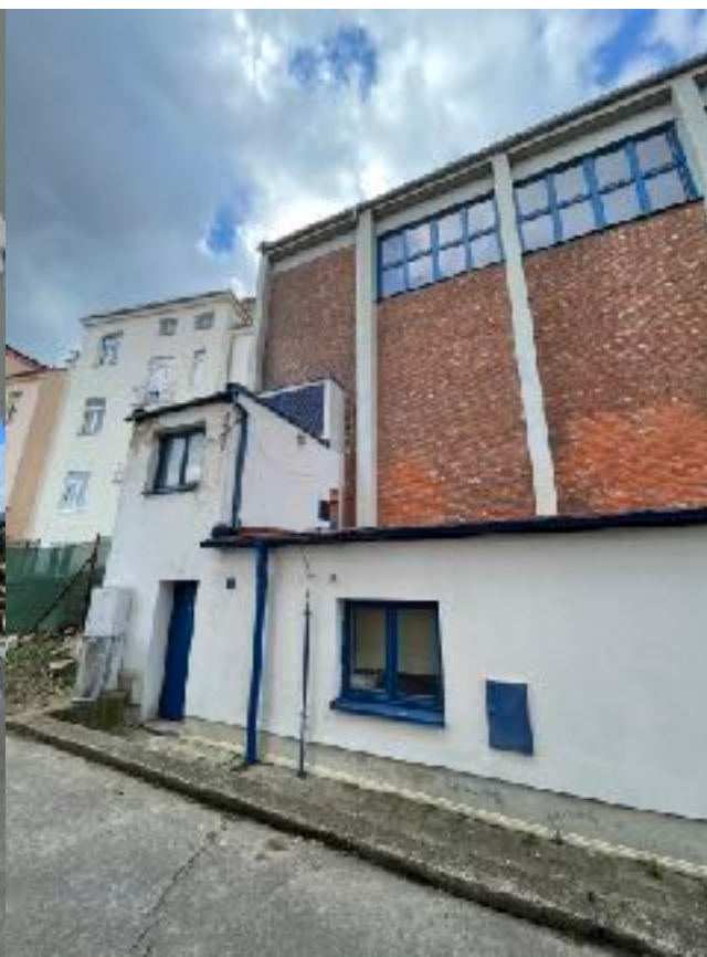
Obrázek 28 Pohled na zadní severovýchodní části objektu a stávající vyústění VZT DIOD
