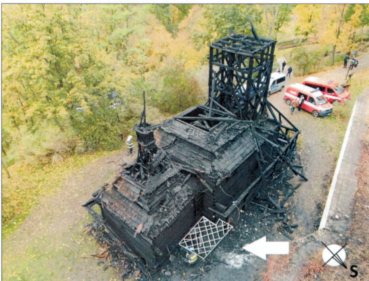
Obr. 4 – bíle vyšrafovaná zóna kriminalistického ohniska na ploše cca 2 x 1 metr z vnější severní strany kostela
