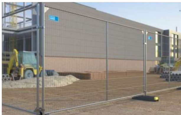
Obrázek 9 - Staveništní oplocení typ 2 [11]
