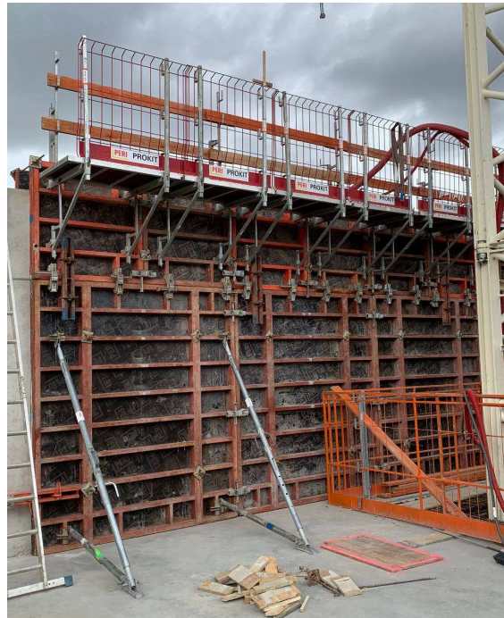
Obrázek 22 – Bednicí dílec s pracovní lávkou, vlastní zdroj
