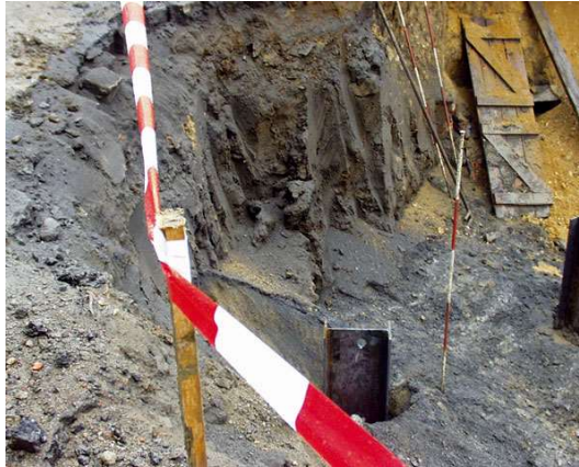
Obrázek 16 – Zábradlí pro výkopové práce [14]
