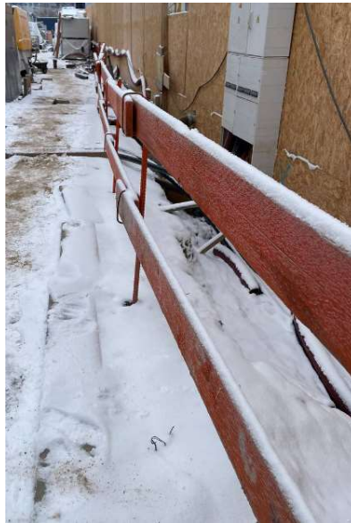
Obrázek 18 - Zábradlí ohraničující výkop – roxorový sloupek s prkny, vlastní zdroj
