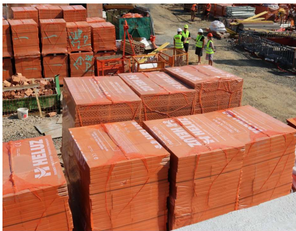
Obrázek 32 - Uskladnění cihelných bloků na staveništi [26]
