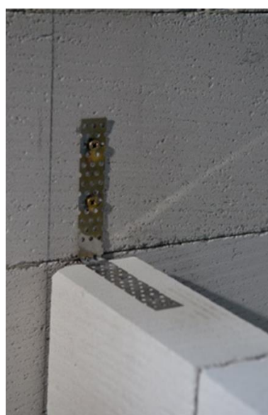
Obrázek 9 – Napojení příčky [22]
