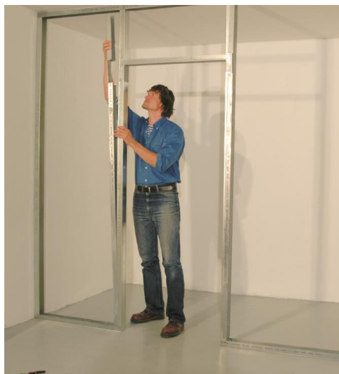
Obrázek 2 Vytvoření skříňových profilů (rigips.cz)
