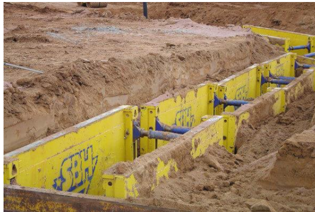
Obrázek 26 Pažení výkopu (rexter.cz)
