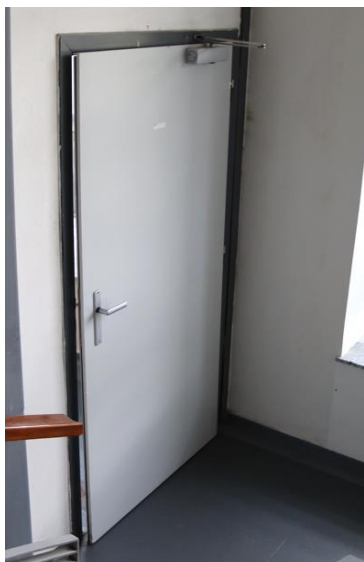
obr. 68 – Stav kouřotěsné dveřní sestavy v 1.NP
