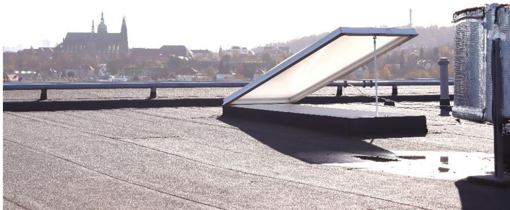
obr. 50 – Otevřený samočinně otevíratelný světlík při simulaci požární situace
