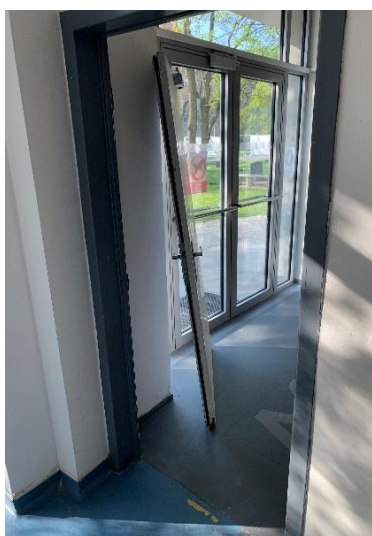
obr. 32 - Stav dveřního otvoru před utěsněním v 1. PP
