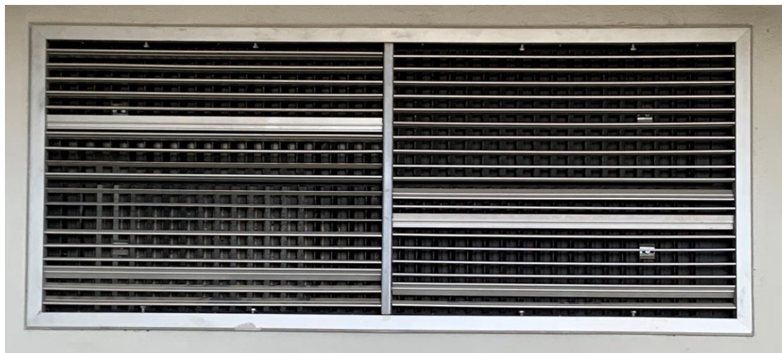
obr. 115 – Použitá fotografie vyústky z 10. NP pro přepočet šířek pomocí měřítka
