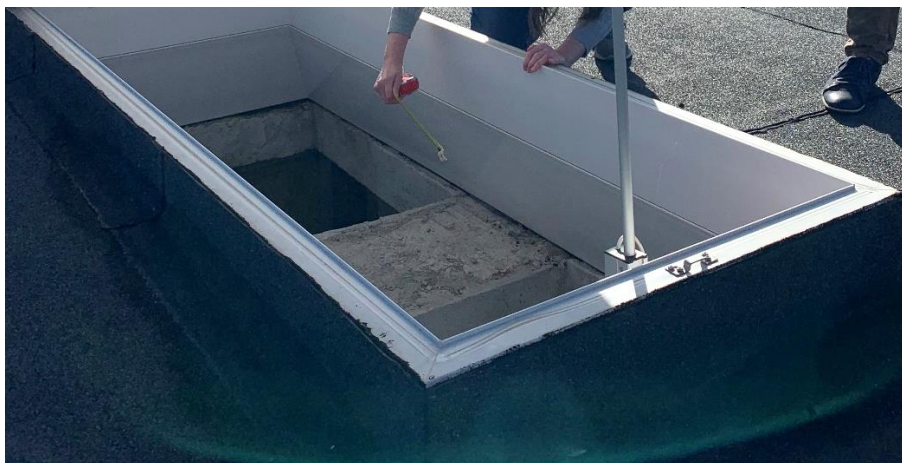
obr. 52 – ŽB průvlak situovaný pod samočinně otevíratelným světlíkem
