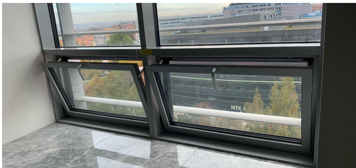
obr. 86 – Stav okenních křidel při běžném provozu
