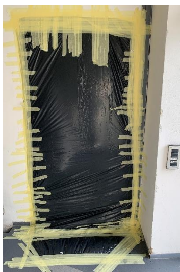
obr. 33 - Průběh utěsnění dveřního otvoru v 1. PP
