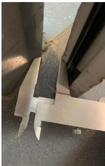
obr. 69 - Průběh měření netěsností na kouřotěsné dveřní sestavě v 1. NP
