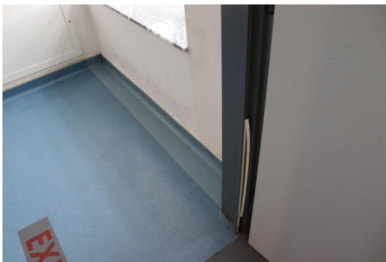
obr. 83 – Stav zpěňující kouřotěsné pásky
