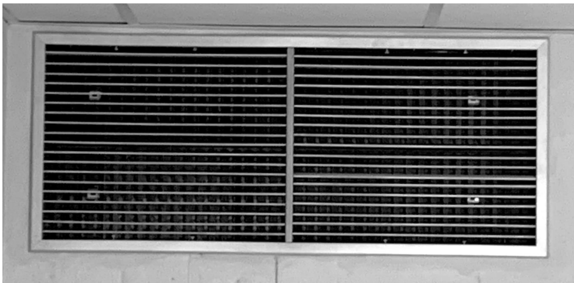
obr. 99 – Fotografie stěnové mřížové vyústky ve 13. NP
