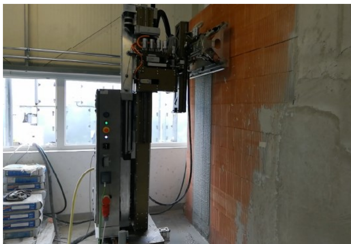
Obr. č. 38 – Nanášení malty pomocí robota "Omítkář"
