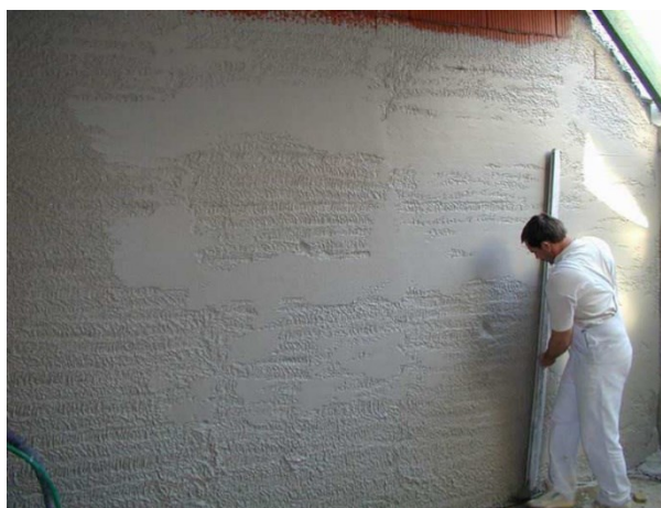
Obr. č. 21 – Hrubé srovnání omítky pomocí 2 m latě
