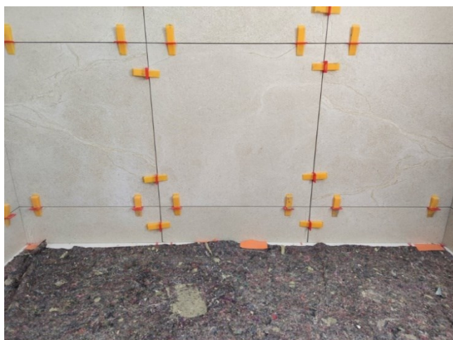
Obr. č. 27 – Obkladové dlaždice připevněné sponami
