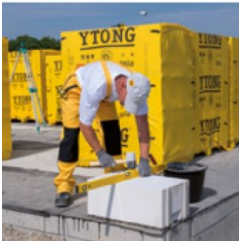
Obr. č. 15 – Osazení prvního rohu
