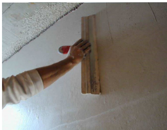
Obr. č. 24 – Finální úprava omítky pomocí ocelového hladítka
