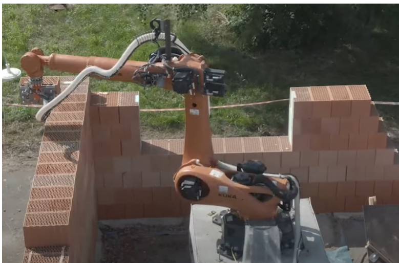
Obr. č. 32 – Proces zdění pomocí zdícího robota
