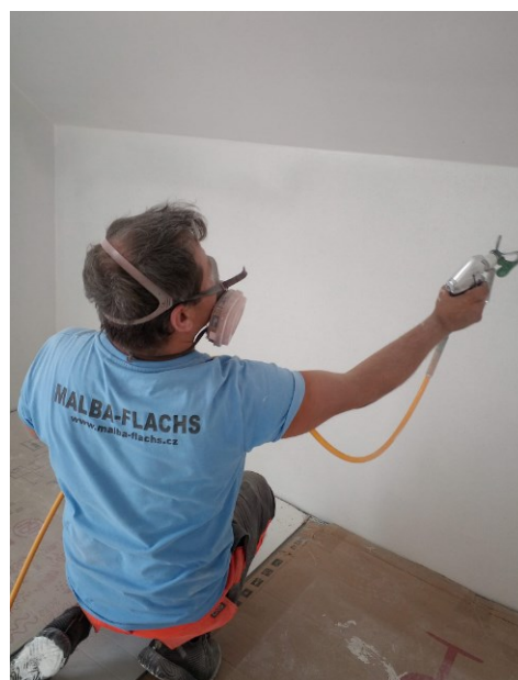
Obr. č. 26 – Strojní provádění maleb
