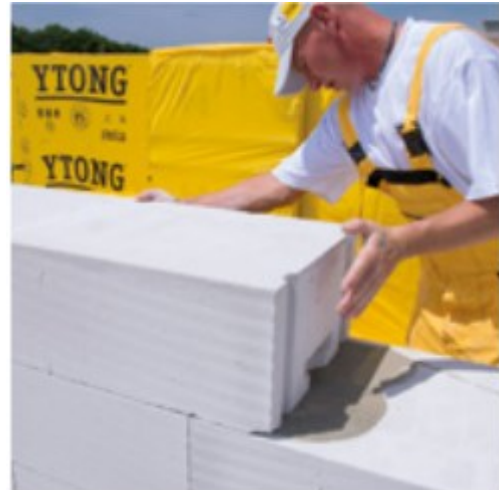
Obr. č. 17 – Kontrola správné vazby
