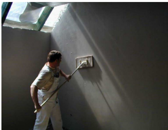
Obr. č. 23 – Hlazení pomocí filcového hladítka
