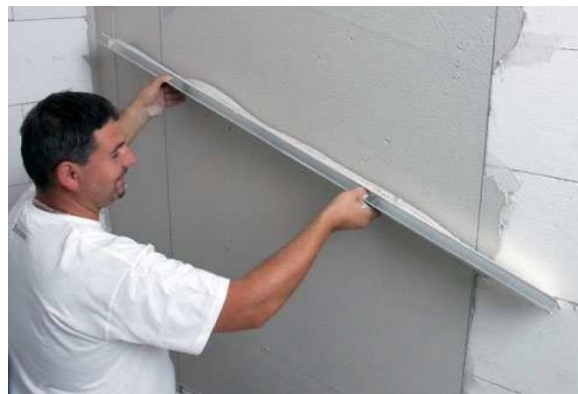
Obr. č. 20 – Strhávání omítky
