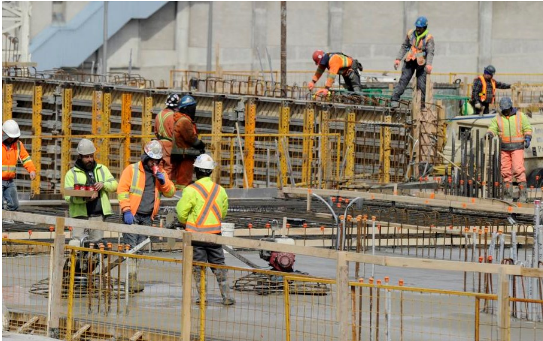
Obr. č. 1 – Stavební výroba
