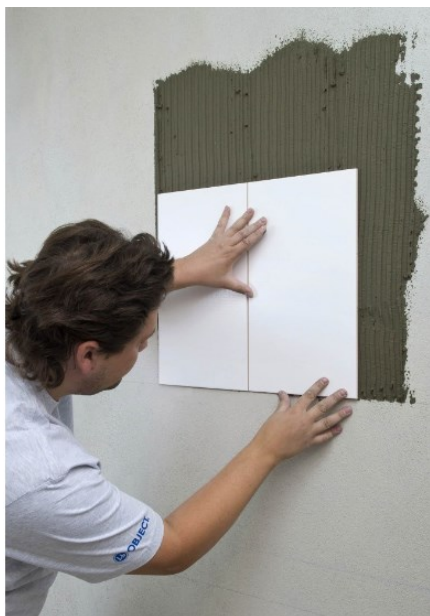
Obr. č. 28 – Proces obkládání metodou floating
