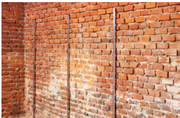
Obr. č. 19 – Osazení omítníků
