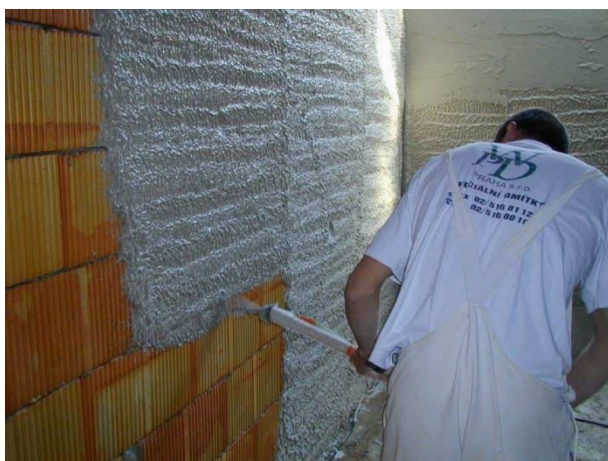
Obr. č. 22 – Nanášení omítky pomocí omítací pistole
