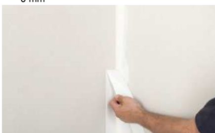
8. Odstraňte přebytečný pásek
