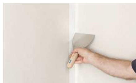
6. Zatmelte spáru
