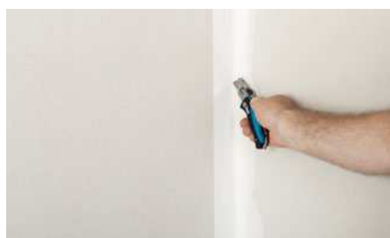
7. Po zaschnutí a přebroušení v rohu odřízněte zbytek pásky Trenn-Fix
