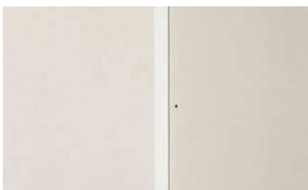
5. Sádrové desky upevněte ve vzdálenosti cca 5 mm
