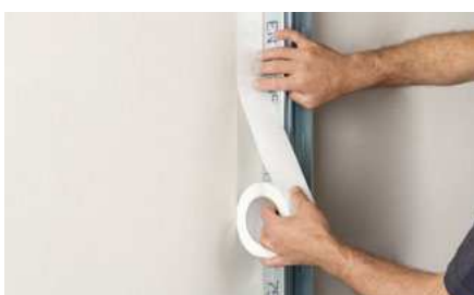
2. Nalepte Trenn-Fix vedle profilu
