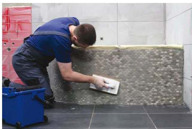
Spárování mozaiky by mělo být vykonávané krouživými pohyby.
