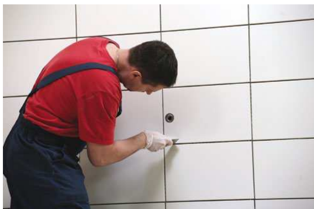
Vyčištění spár a okrajů od zbytků lepidla.
