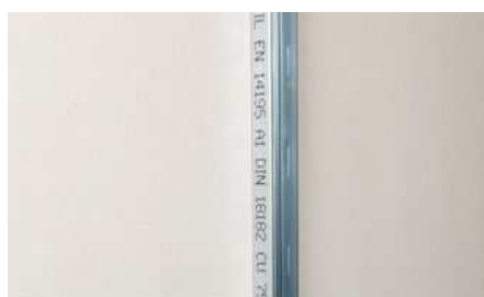
1. Upevněte profil na navazující konstrukci
