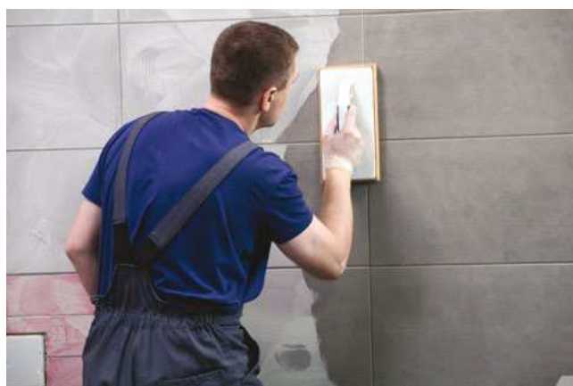
Doba schnutí se pohybuje v rozmezí od 5 do 30 minut.
