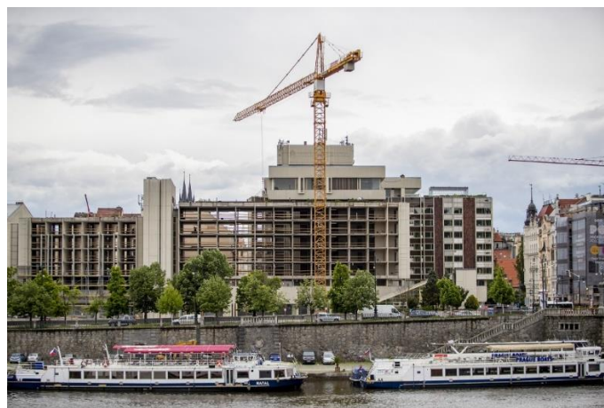
Obr. 31 – Búracie práce na fasáde [68]
