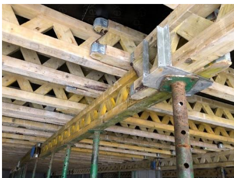
Obr. 17 – Nosníky uložené na hlaviciach [20]
