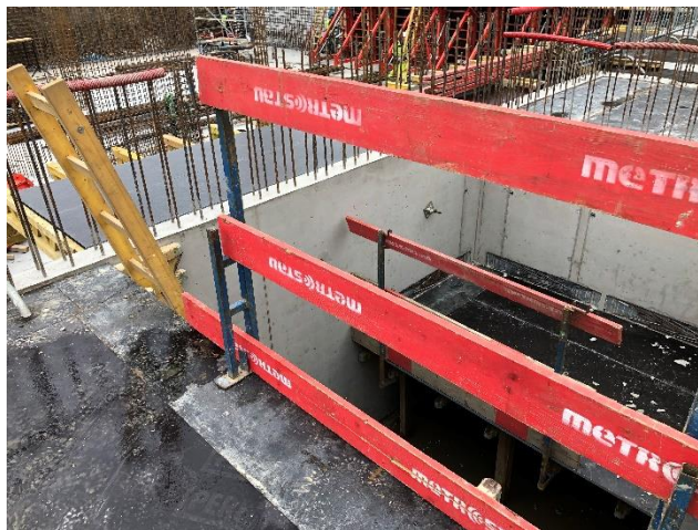
Obr. 18 – Výstup na stropnú dosku [20]
