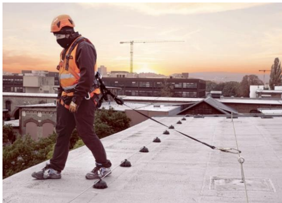
Obr. 19 – Horizontálny záchytný systém ROOFIX [49]
