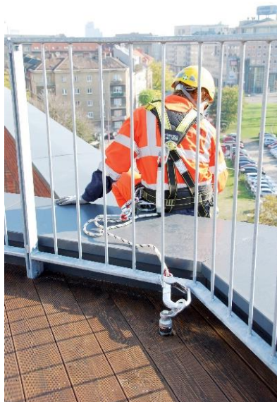
Obr. 24 – Kotviaci bod pri práci na streche/balkóne [59]
