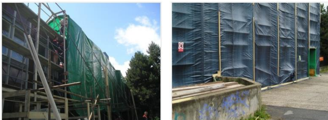
Obr. 27 – Montáž vonkajšej časti kontrolovaného pásma; Vonkajšia plachta pri vytvorení podtlaku [65]
