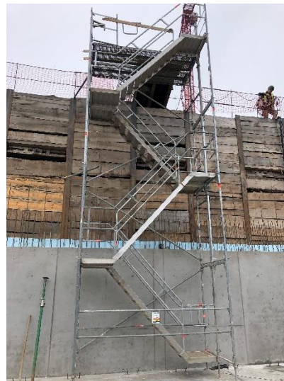
Obr. 10 – Ukážka vstupu do stavebnej jamy (lešenie – veža) [20]
