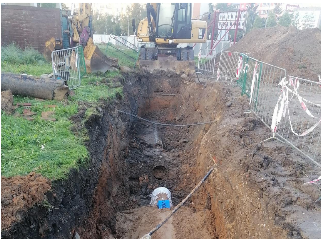
Obrázek 9; Překládání vodovodního řadu v původní trase; vlastní zpracování
