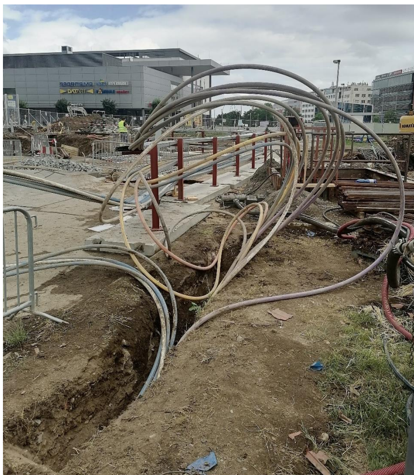
Obrázek 14; IS - optické kabely v chráničkách bylo nutné dočasně přeložit a ochránit při zachování jejich funkčnosti; vlastní zpracování
