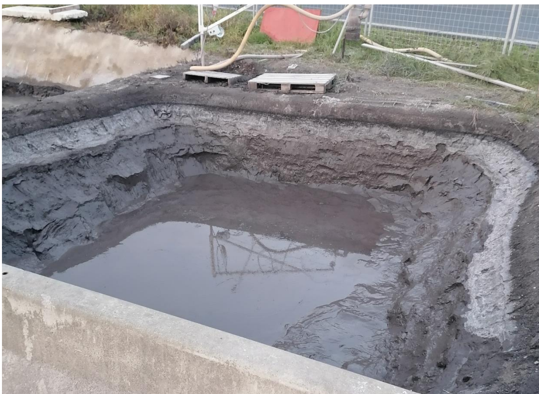
Obrázek 18; odpad z usazovacích nádrží na balastní vody, který po ztrátě vody zásadně zmenší svůj objem a je následně odvezen ze staveniště; vlastní zpracování
