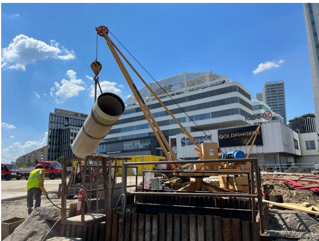
Obrázek 1; Spouštění trouby (DN800 - sklolaminát) provizorní přeložky kanalizační stoky do šachty; vlastní zpracování
