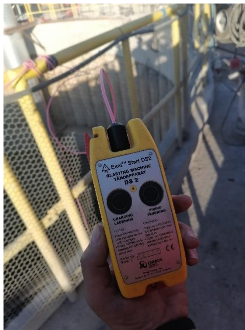
Obrázek 24; zařízení k odpalu připravené trhaviny na čelbě; vlastní zpracování
