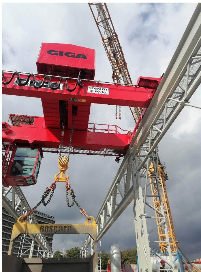
Obrázek 17; portálový jeřáb jako náhrada původně plánovaného věžového jeřábu na staveništi PAD1 Pankrác; vlastní zpracování
