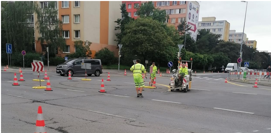
Obrázek 19; dočasná úprava dopravních podmínek provizorním značením; vlastní zpracování
