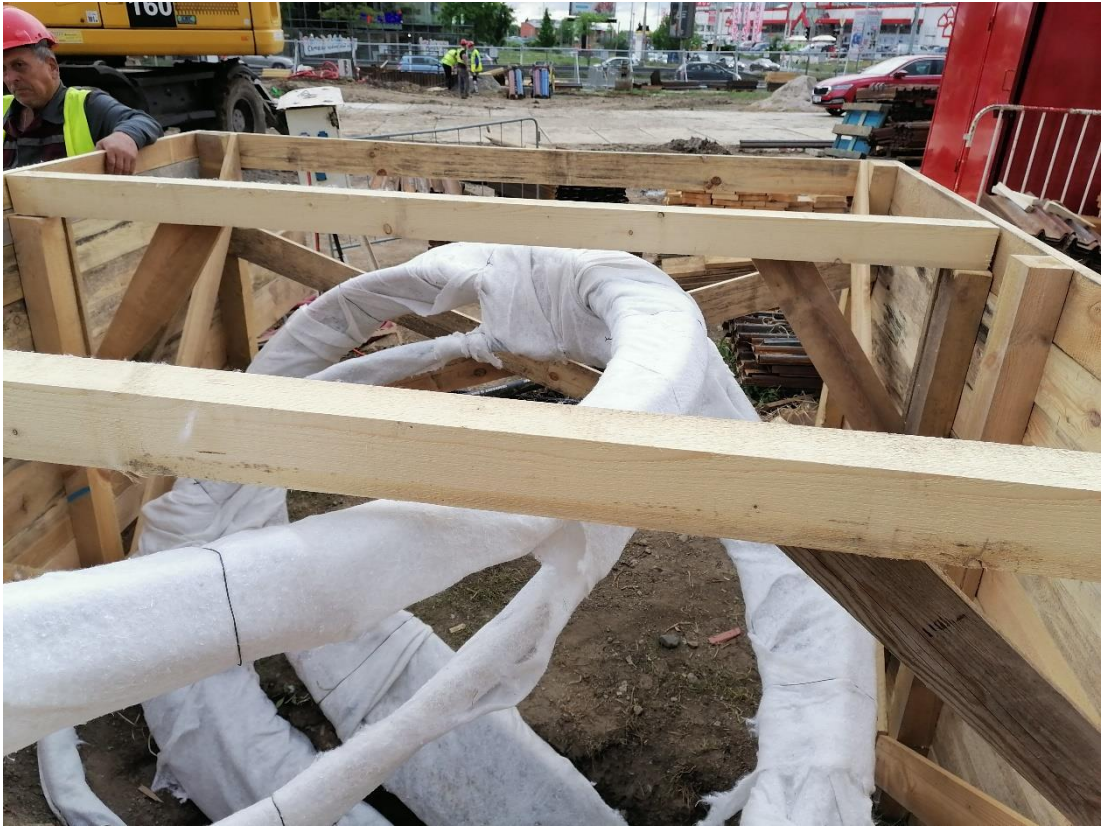
Obrázek 2; výroba vlastních ochranných konstrukcí IS
