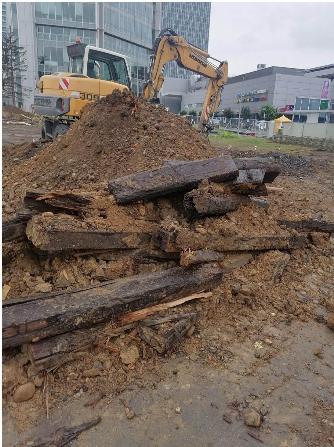
Obrázek 6; pozůstatky staré záporové stěny, ponechané pod zemí
