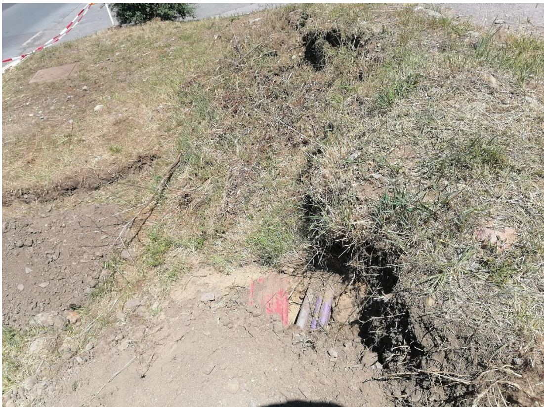
Obrázek 4; nedostatečné krytí IS
