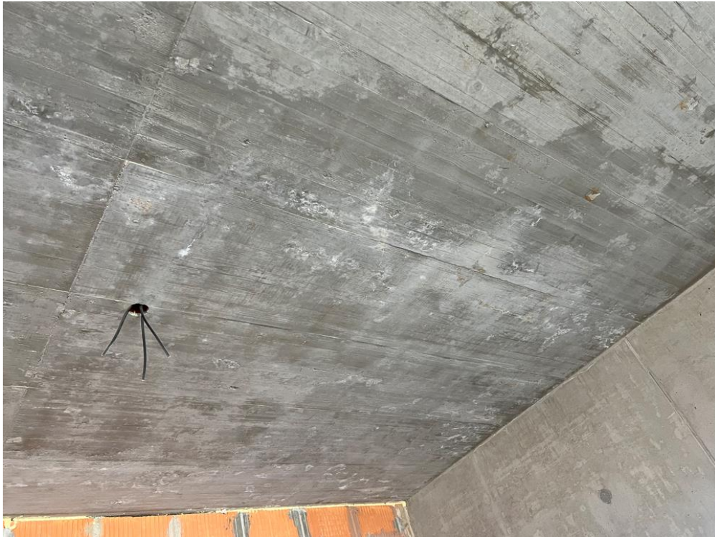
Obr. 7 – finální vzhled pohledového betonu po broušení a položení hydroizolace
