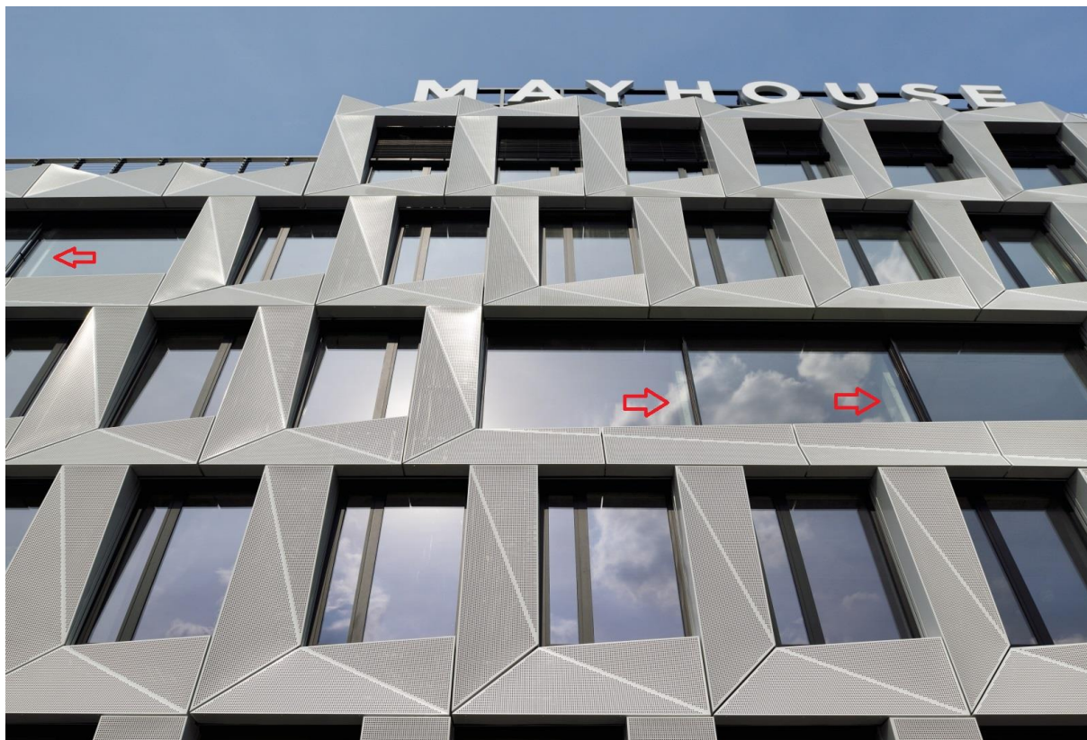
Obrázek 28 – Pohled na fasádu řešeného detailu
