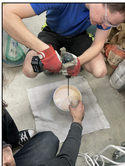
Obrázek 70: Aktivace dvousložkového silikonu
