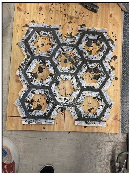
Obrázek 66: Vybetonovaná dřevěná forma prototypu č. 1
