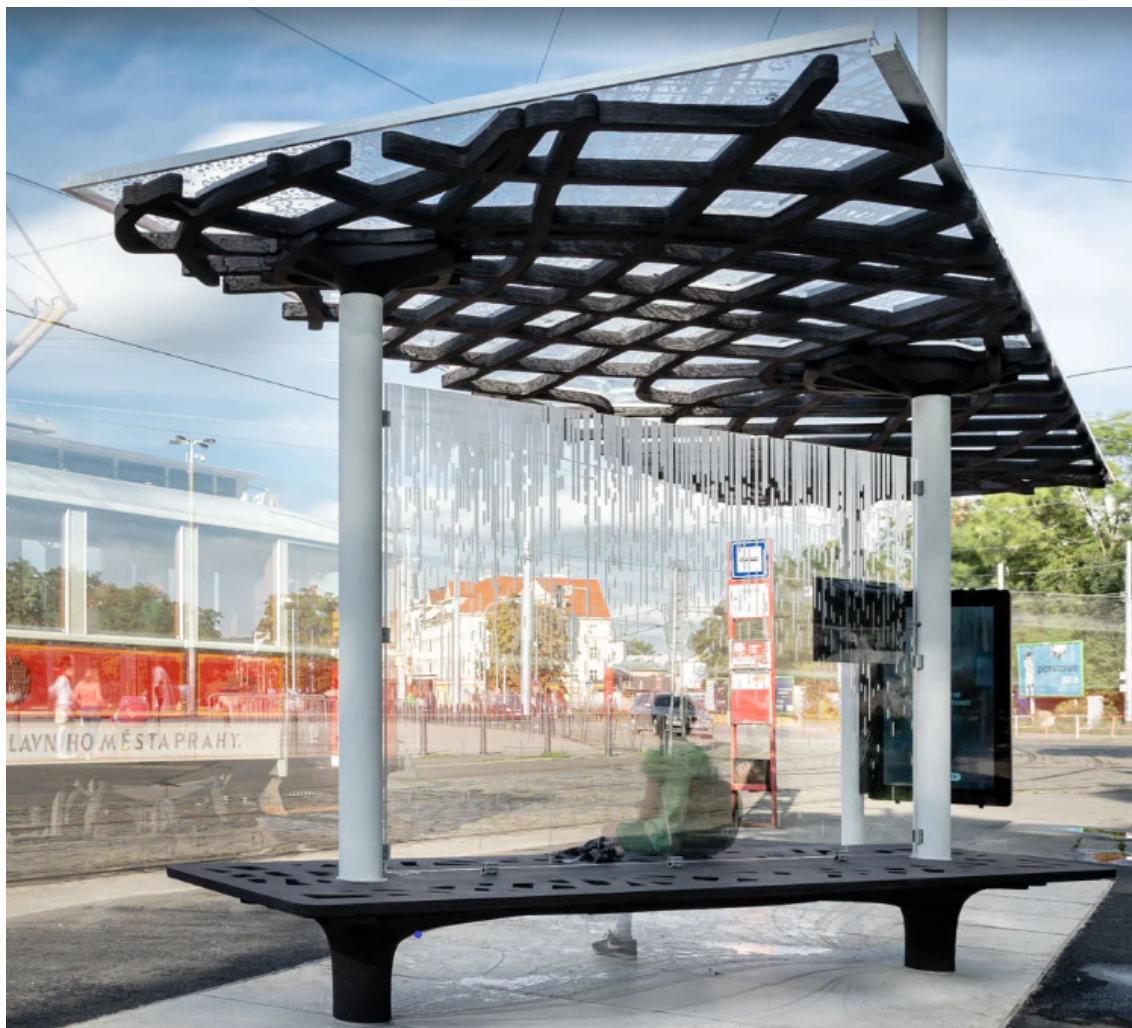
Obrázek 3.8: Tramvajová zastávka využívající 3D tisku betonu k vytvoření žebér dle trajektorií hlavních ohybových momentů [24]
