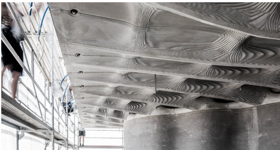
Obrázek 3.10: Topologicky optimalizovaná, prefabrikovaná stropní deska vyrobená s využitím 3D tištěného bednění. [28]
