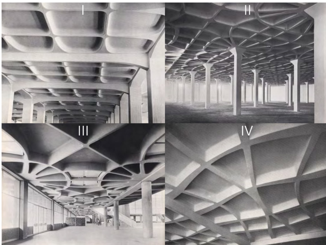
Obrázek 3.5: Žebrové konstrukce navržené Pierem Luigim Nervim [20]
