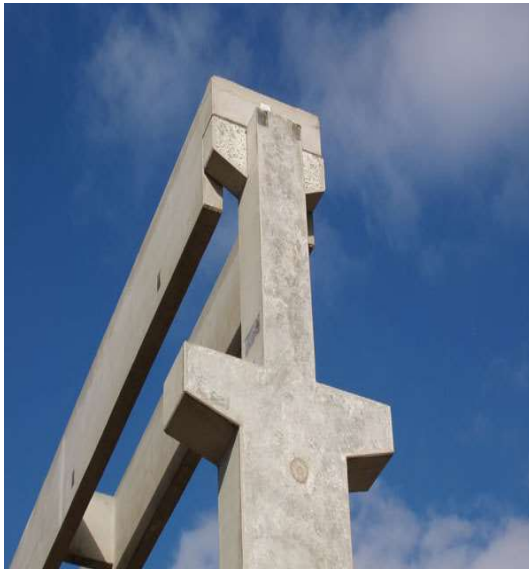
Obr. 1: ŽB sloupy s konzolkami pro jeřábové dráhy [15]
