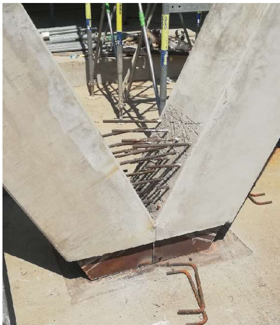
Obr. 13: Realizace prefabrikovaných sloupů pomocí ocelové botky
