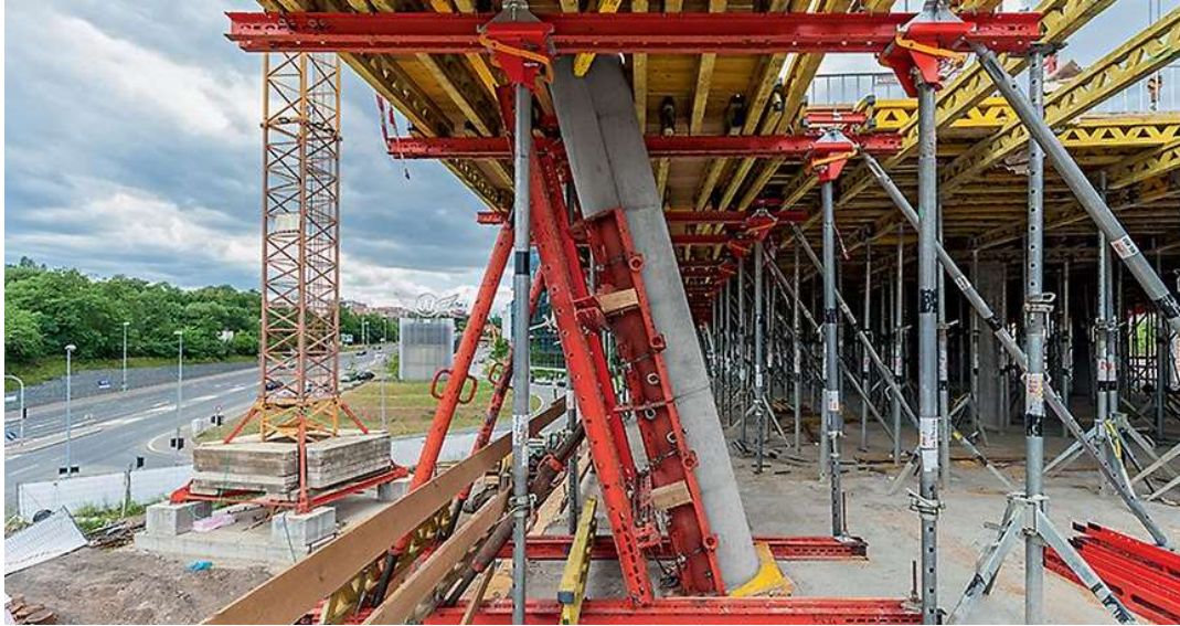
Obr. 9: Pata šikmého sloupu [27]
