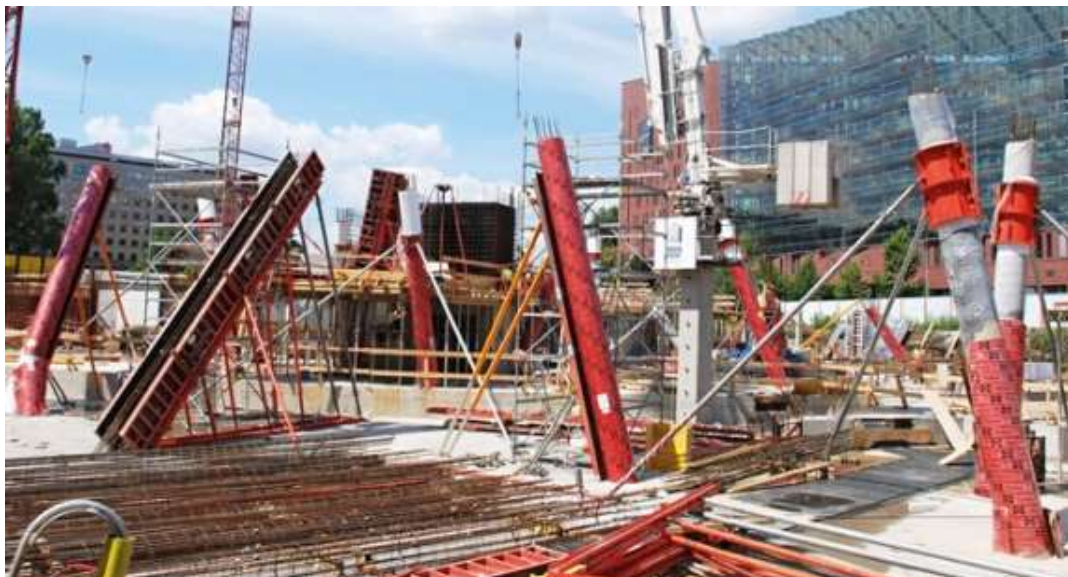
Obr. 8: Bednění šikmých sloupů [27]
