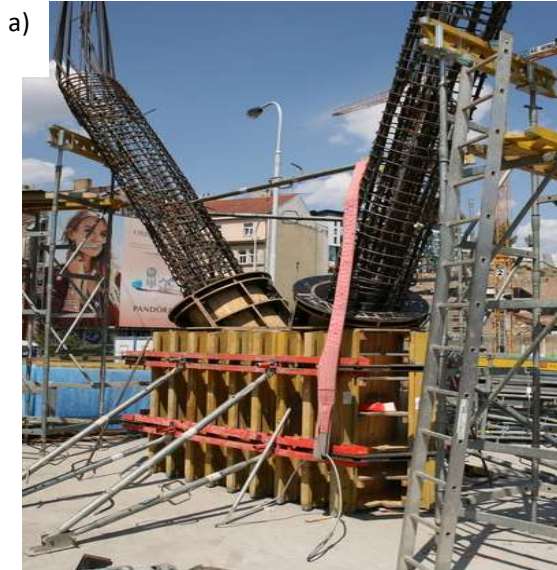
Obr. 10: Bednění 1. traktu atypických sloupů – a) pohled na bednění s přesahující výztuží; b) výkres bednicích forem [27]
