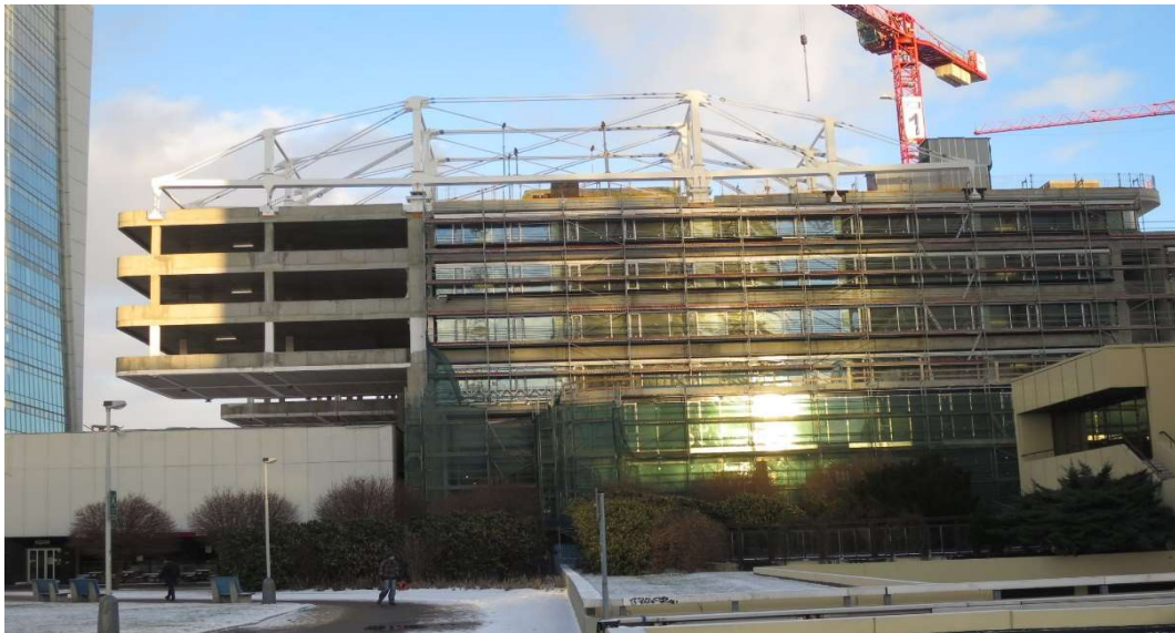
Obr. 3: Zavěšená konstrukce – Trimaran (Praha) [18]
