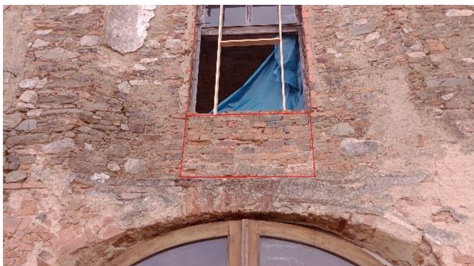
Obrázek 29: Dozděný parapet
