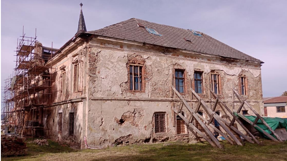
Obrázek 3: Východní pohled na objekt
