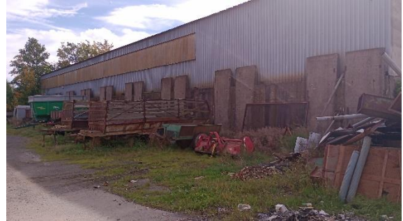
Obrázek 44: Stávající pažící stěna
