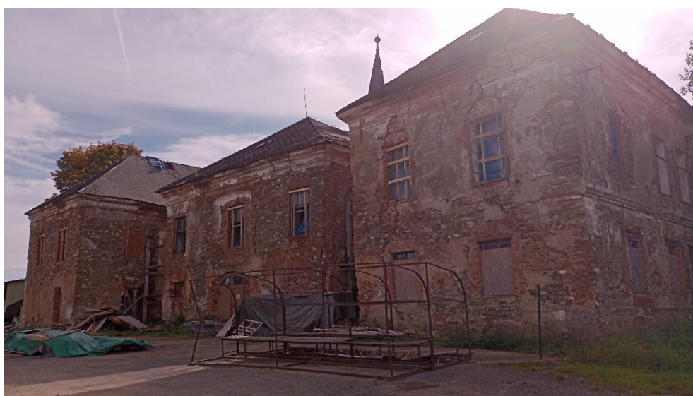
Obrázek 2: Severní pohled na objekt
