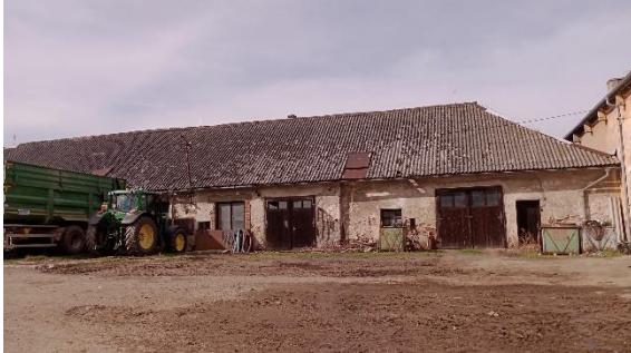
Obrázek 43: Historická hospodářská budova
