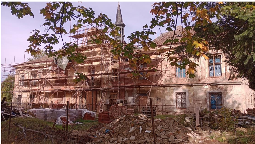
Obrázek 1: Jižní pohled na objekt
