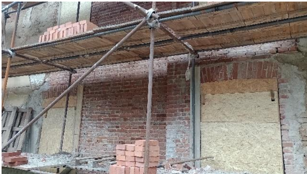
Obrázek 32: Dozděná zřícená stěna
