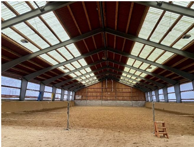
jezdecká hala, prosvětlení vlnitými polykarbonátovými deskami
