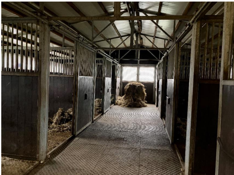
vnitřní stáje, lehká ocelová konstrukce
