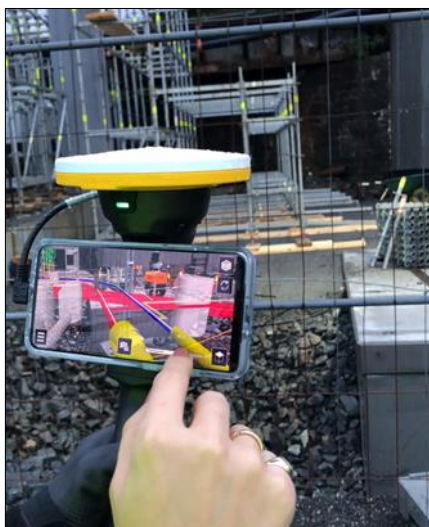
Obrázek 8.15: Použití Trimble SiteVision na staveništi v Bybanen BT4 [46]
