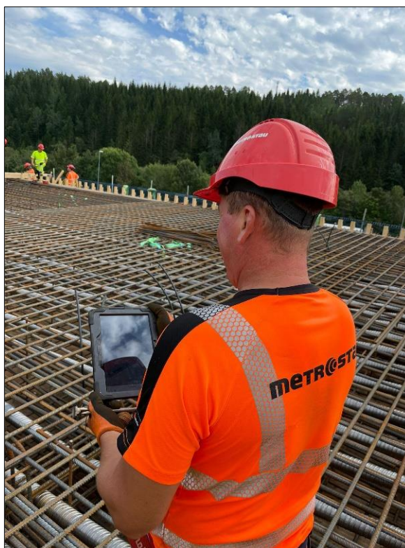
Obrázek 9.11: Prohlížení modelu v nástroji Trimble Connect na stavbě [53]
