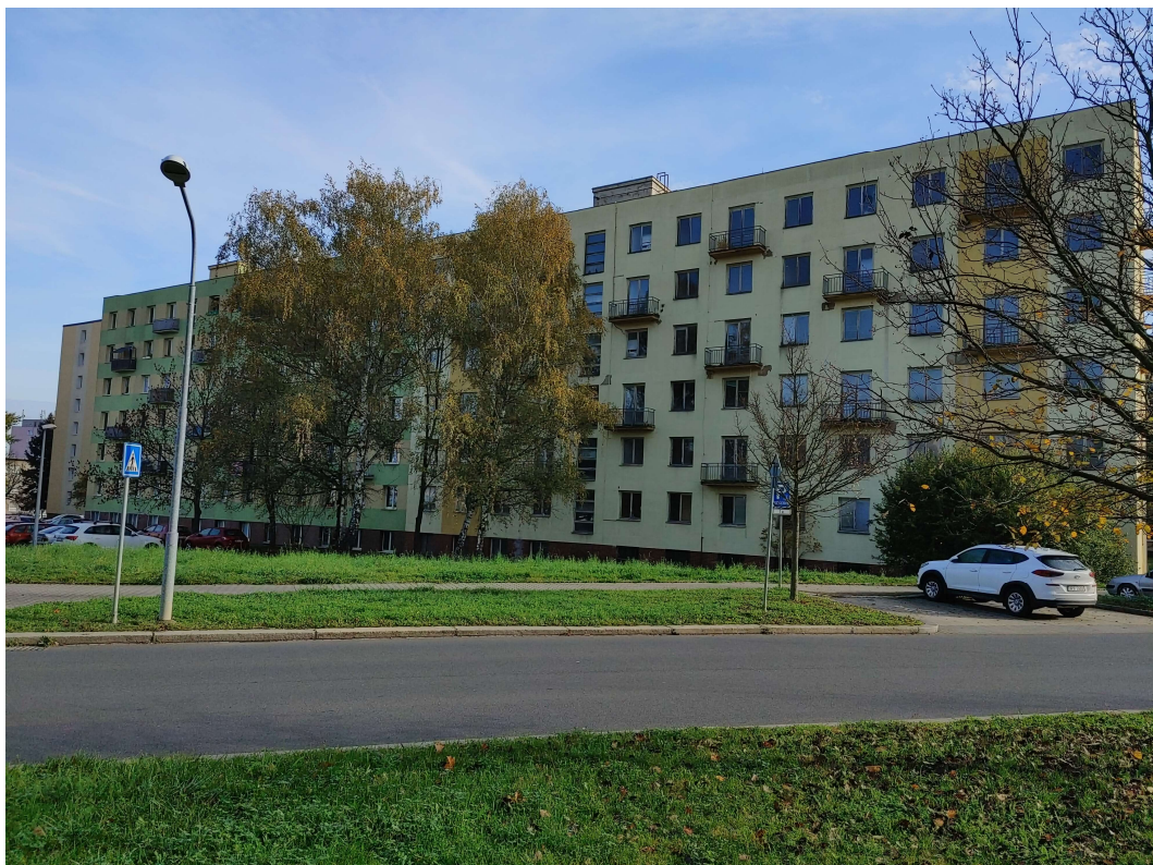
Obrázek 1: Starší panelová soustava T03B, sídliště Plzeň - Bory (foto: autor)
