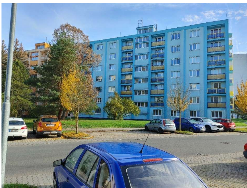
Obrázek 2: Panelová soustava PS61, sídliště Plzeň - Bory (foto: autor)
