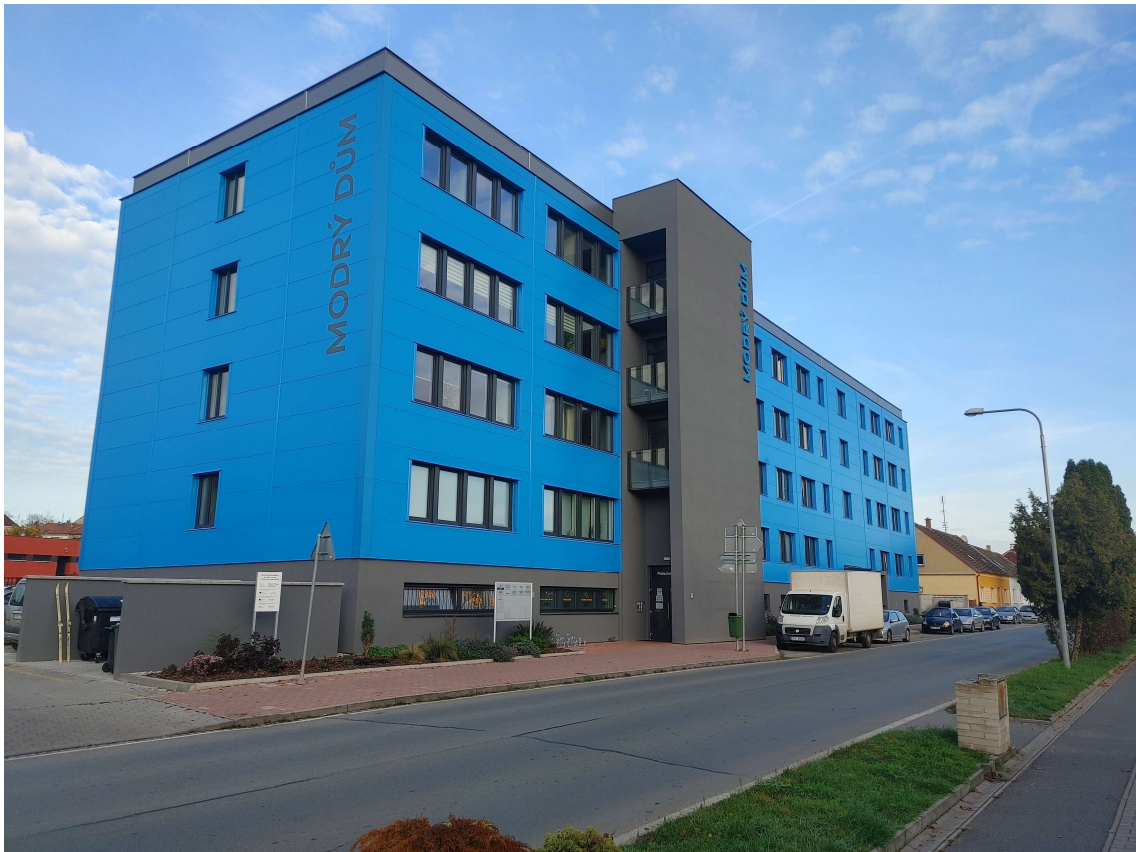
Obrázek 5: Nově zrekonstruovaný montovaný skelet MS69, Přeštice (foto: autor)
