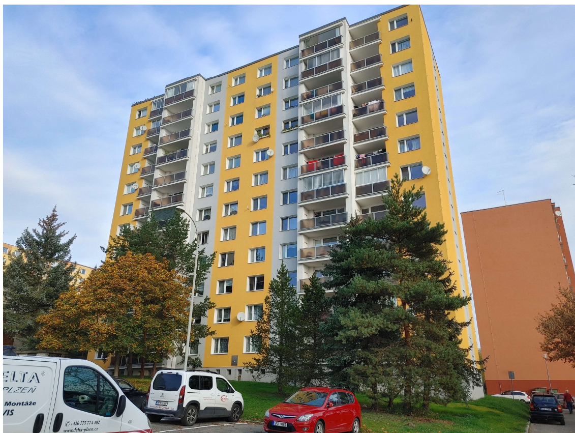
Obrázek 10: Posuzovaný objekt panelové soustavy PS69/2A, objekt 37 podle plánu výstavby z roku 1979, sídliště Plzeň Bolevec (foto: autor)
