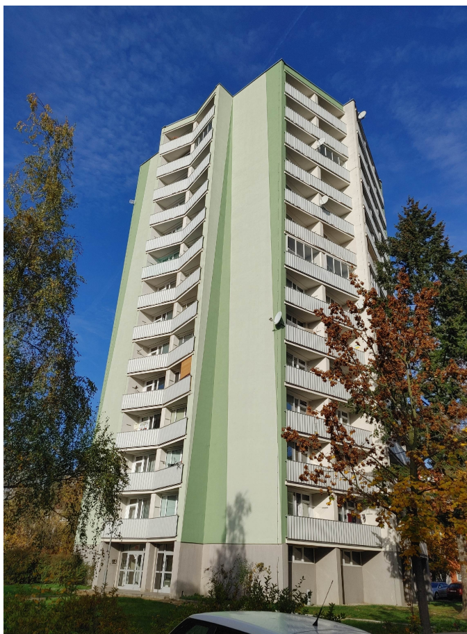
Obrázek 7: Výškový objekt PS69 se 14-ti NP, sídliště Plzeň Bory (foto: autor)
