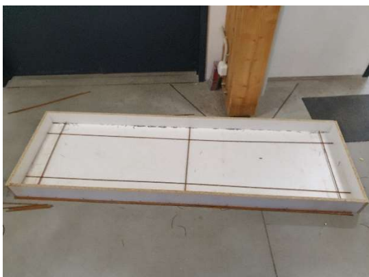
Obr. 31 – Foto připravené horní výztuže
