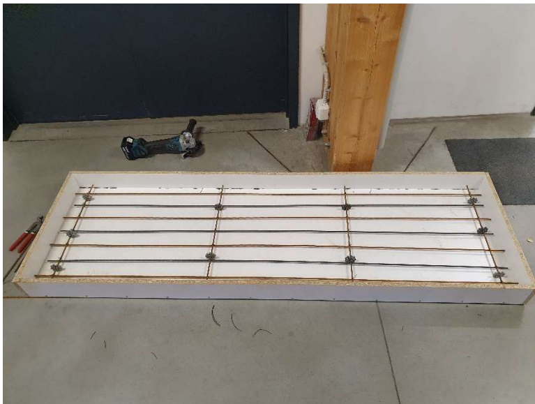
Obr. 29 – Foto připravené spodní výztuže pro druhý panel po ohnutí čedičové výztuže
