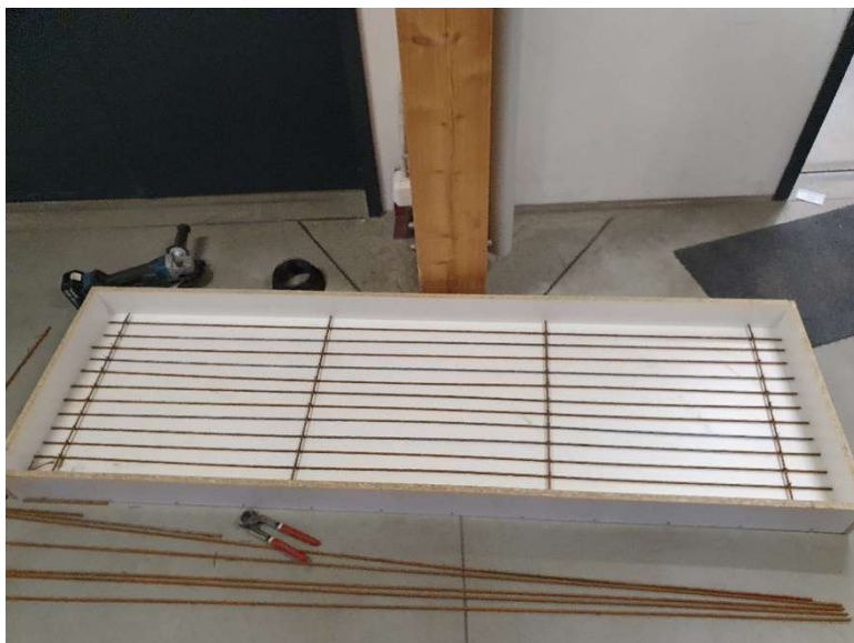
Obr. 27 – Foto připravené spodní výztuže pro první panel s čistě ocelovou výztuží
