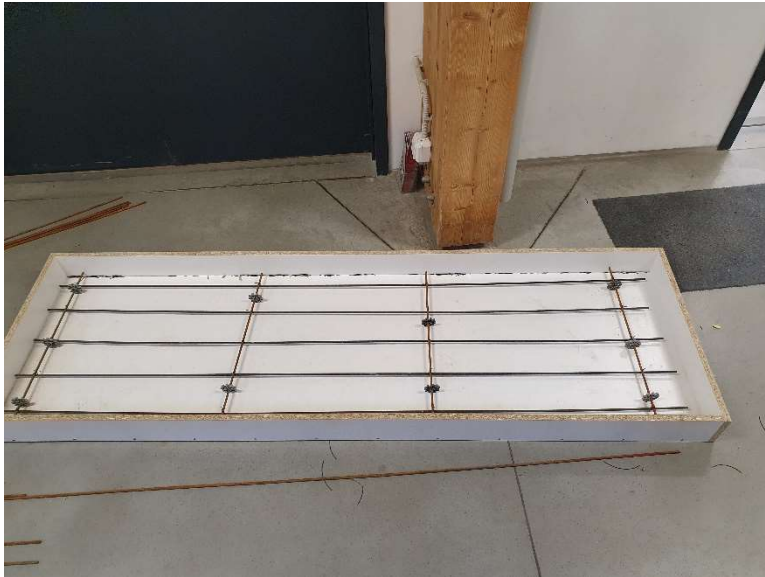
Obr. 30 – Foto připravené spodní výztuže pro třetí panel s čistě čedičovou výztuží
