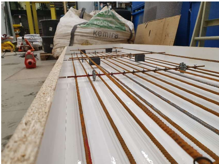
Obr. 32 – Foto s naolejovaným bedněním a připravenou svázanou výztuží
