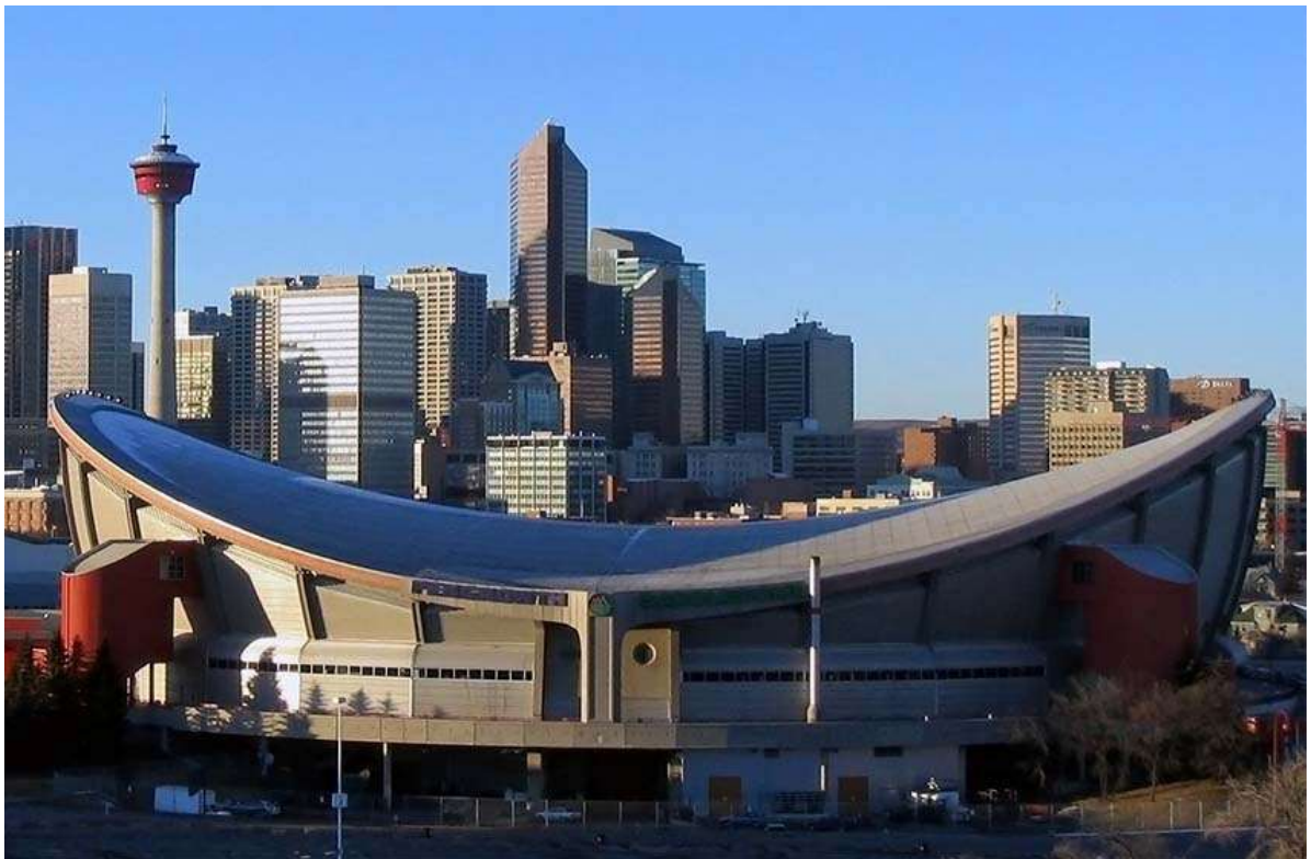
Obr. 31: Membránová konstrukce z prefabrikovaných prvků [38]
