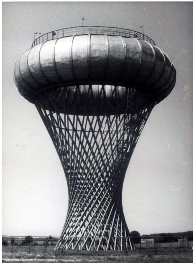
Obr. 29: Věž s expanzní nádrží na vodu tvaru anuloidu [36]
