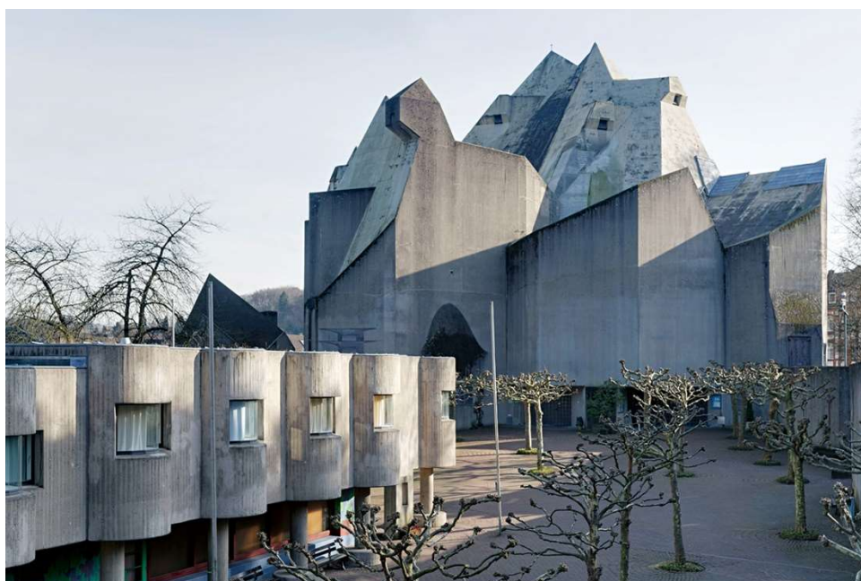
Obr. 14: Budova kostela s přiléhajícím ubytováním a křížovou cestou [24]
