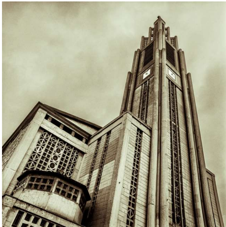
Obr. 8: Betonová věž se zvonící [19]
