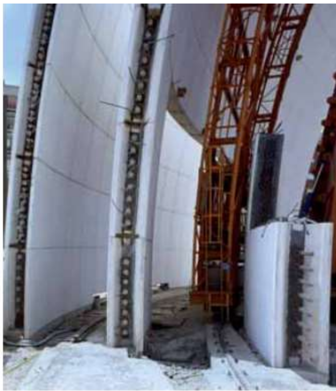
Obr. 19: Spínání segmentové konstrukce pomocí ocelových lan [30]
