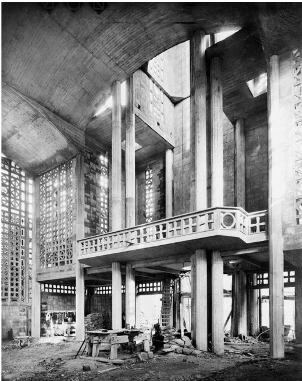
Obr. 11: Nosná konstrukce věže a nenosné betonové tvárnice [20]
