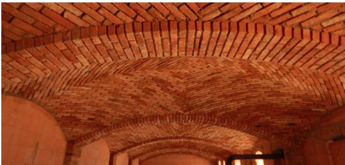
Obr. 23: Zděná klenba typu česká placka [33]
