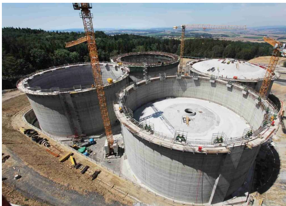
Obr. 30: Předpjaté betonové nádrže [37]
