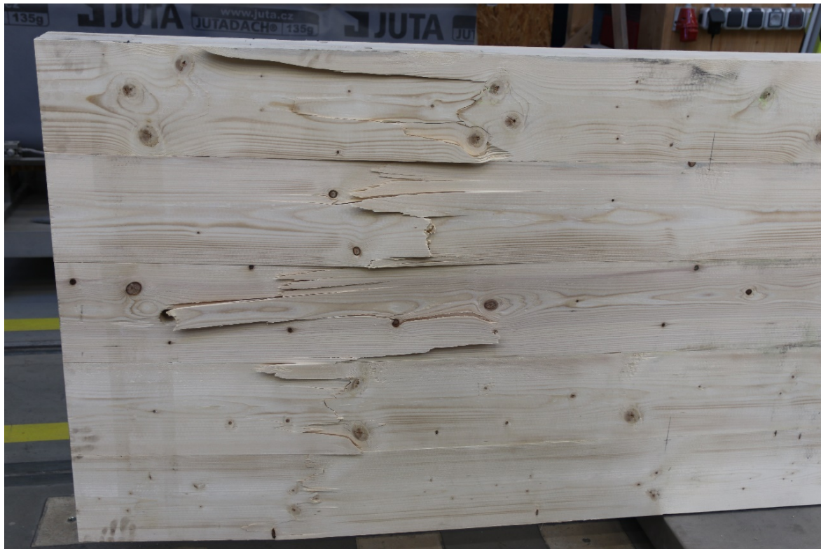
Obrázek 26: Ukázka porušení pětivrstvého panelu
