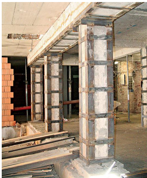
Obrázok 4.3.8 – Sanácia železobetónového skeletu
