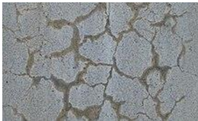
Obrázok 4.3.4 – Alkalicko-kremičitá reakcia
